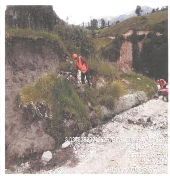
Foto02 : Limpieza de derrumbes
