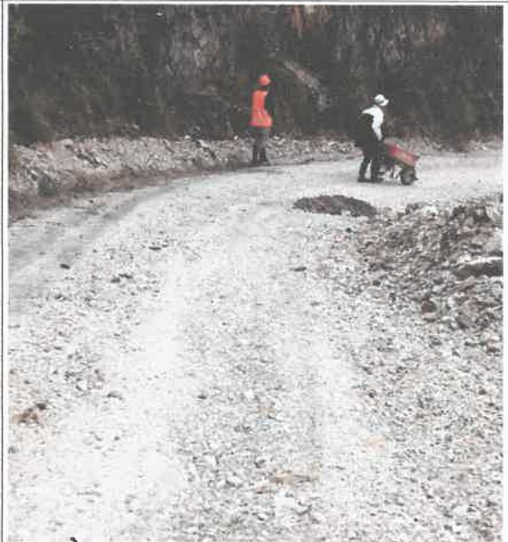
Foto 04 : CONSERVACION DE CALZADA
