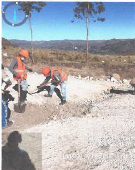
Foto 03 : LIMPIEZA DE PASE DE AGUA
