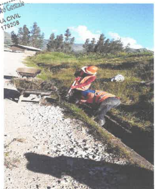
Foto04 : Limpieza de cunetas
