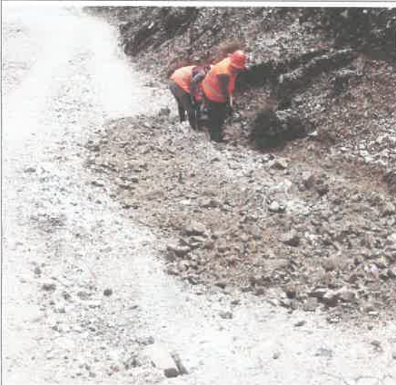
Foto 01 : LIMPIEZA DE OBRAS DE DRENAJE
