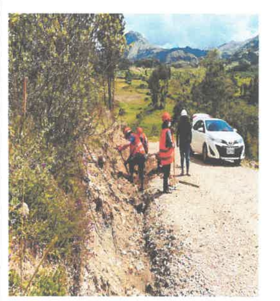
Foto04 : Limpieza de cunetas
