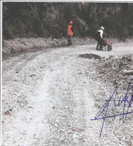
Foto04 : CONSERVACION DE CALZADA
