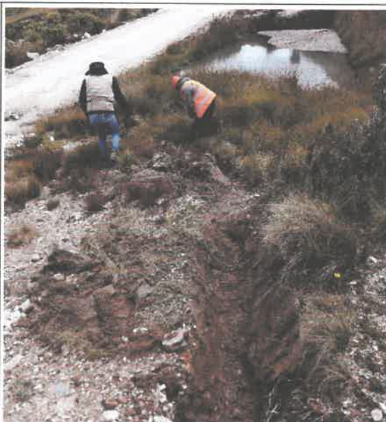
Foto02 : LIPIEZA DE OBRAS DE DRENAJE
