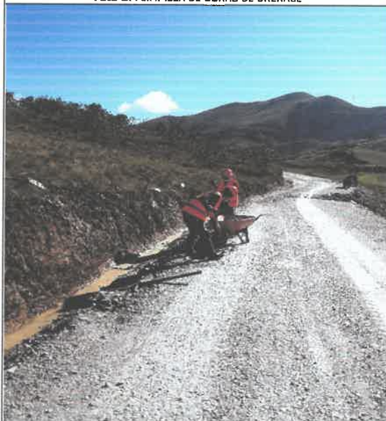
Foto 03 : LIMPIEZA DE OBRAS DE DRENAJE
