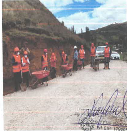
Foto02 : Verificación DE Limpieza de Cunetas
