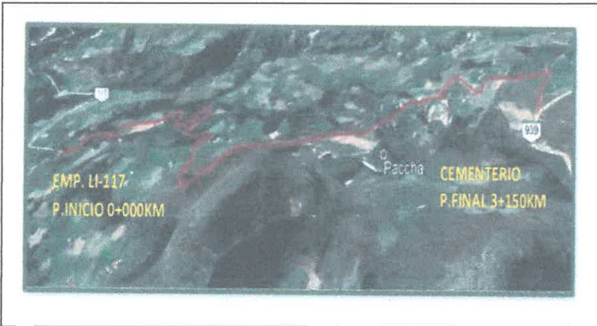
Foto N°01: Camino Vecinal a intervenir
