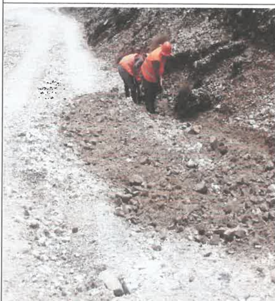
Foto 01 : LIMPIEZA DE OBRAS DE DRENAJE
