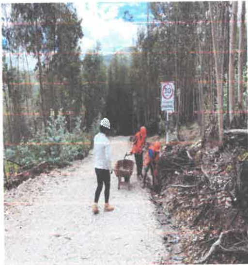
Foto 03 : Perfilado de superficie sin aporte de material
