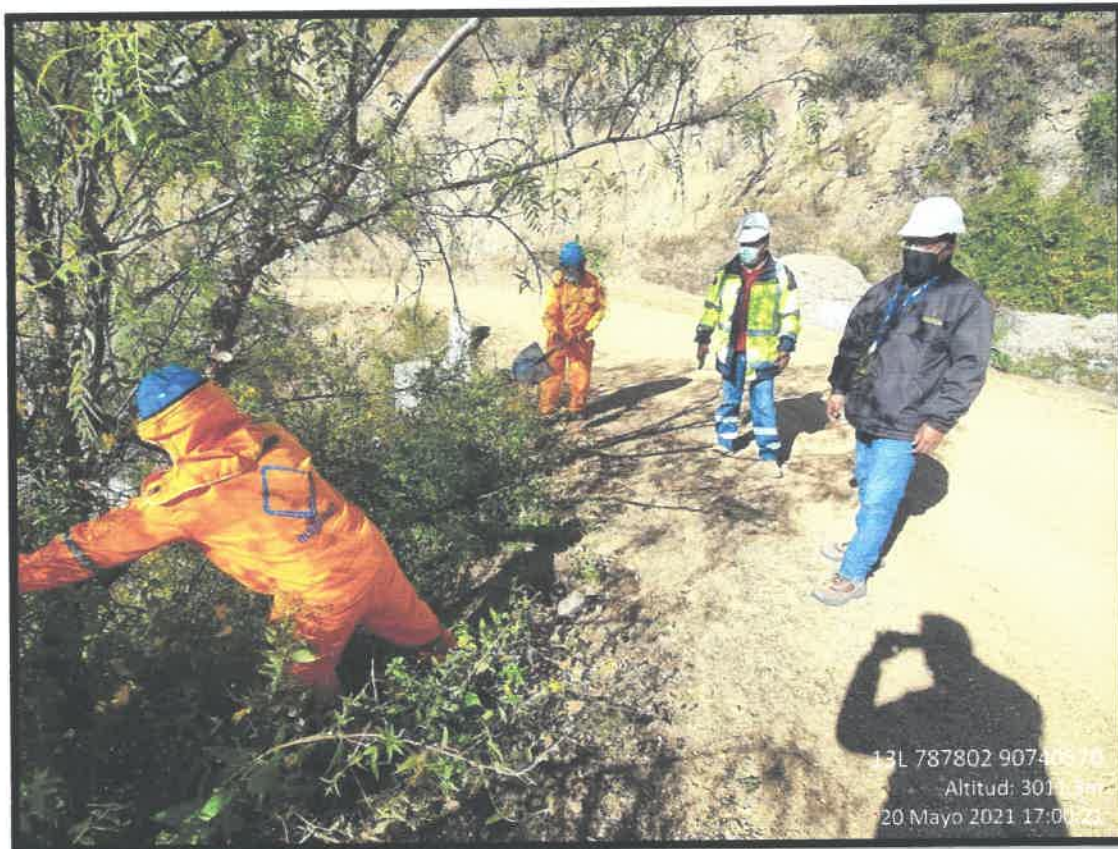
TRABAJOS DE DESBROCE EN PRESENCIA DEL ING. RESIDENTE
