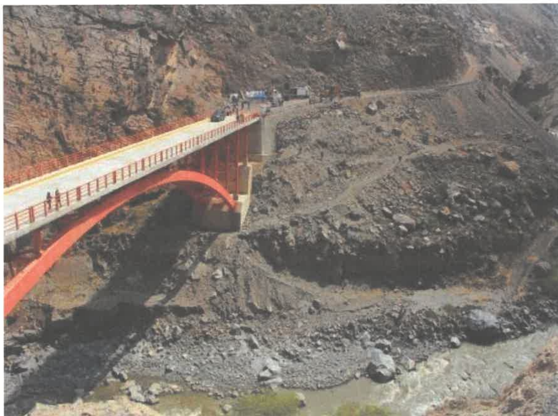
Foto N°02: PROGRESIVA 58+000 PUENTE HUANDA
