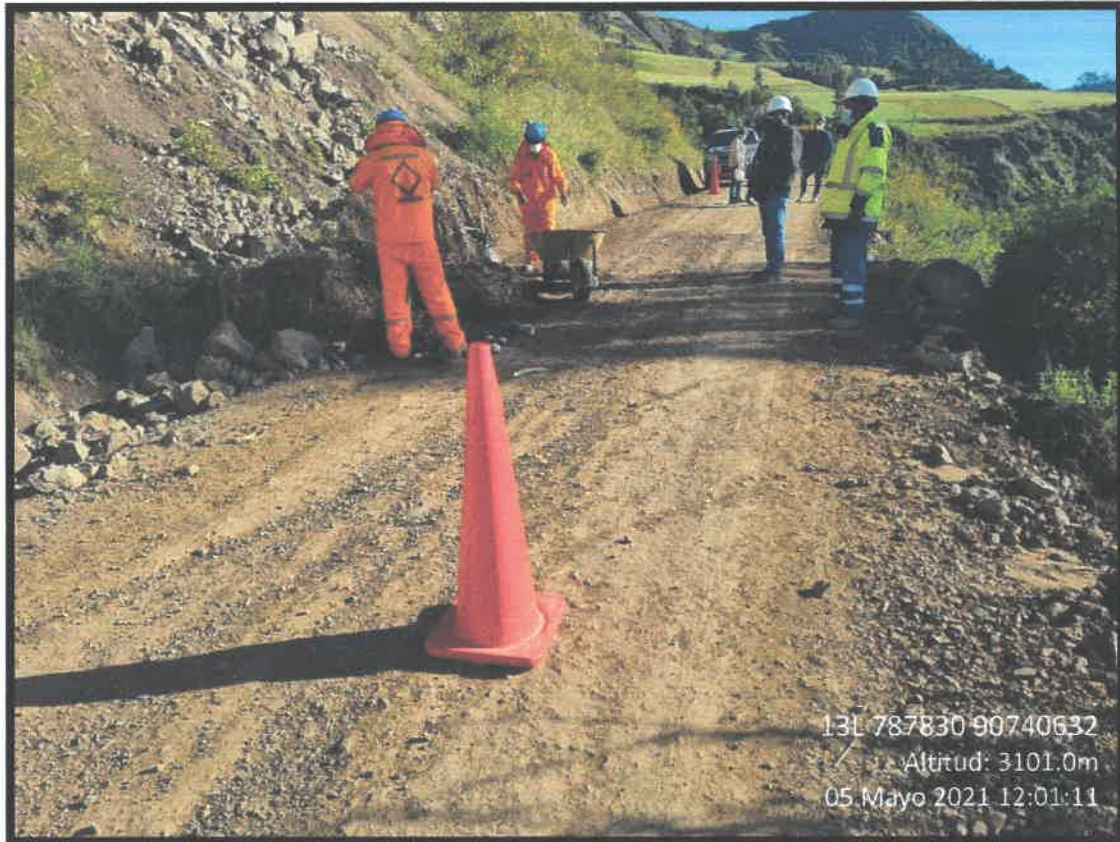
EL MONITOREO DE LOS TRABAJOS DE REMOCION DE DERRUMBES Y LIMPIEZA DE CUNETAS
