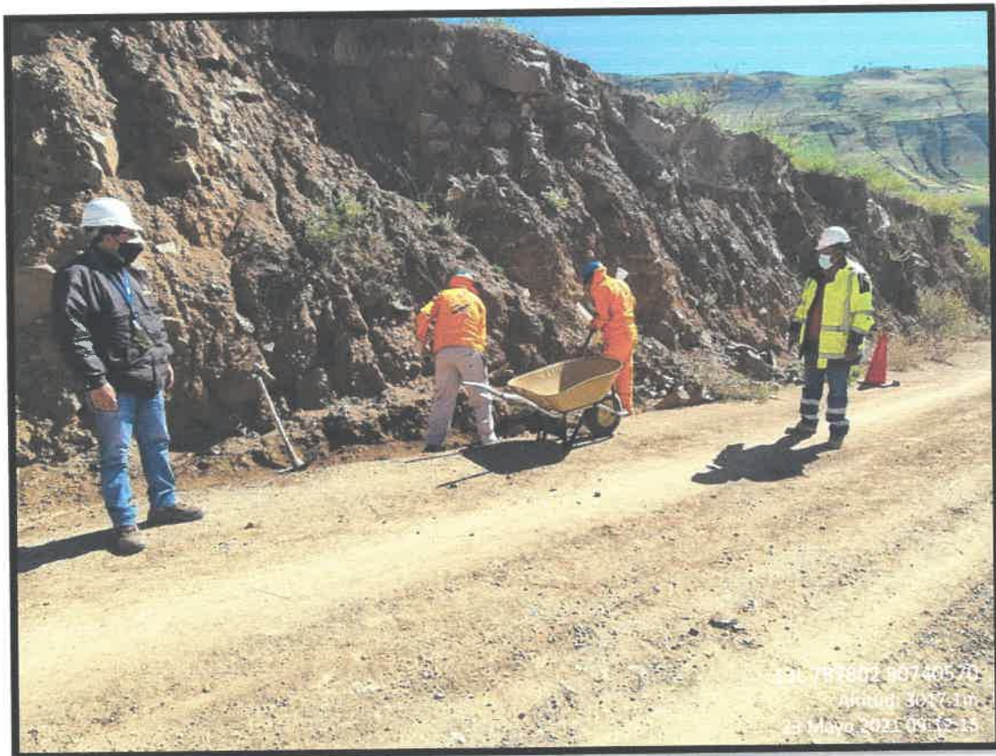
TRABAJOS DE REMOCION DE DERRUMBES Y LIMPIEZA DE CUNETAS
