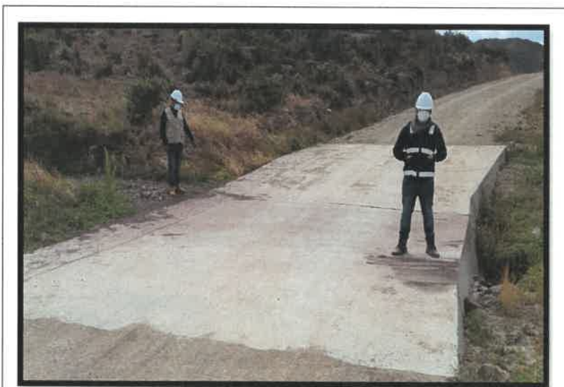
FIG 10. LIMPIEZA DE BADEM (17L 8.385922E 78.22362N) ALT. 3206.32M FECHA: 20/05/2021 ING. INSPECTOR Y RESIDENTE VERIFICANDO LOS TRABAJOS DE LIMPIEZA DE BADEM
