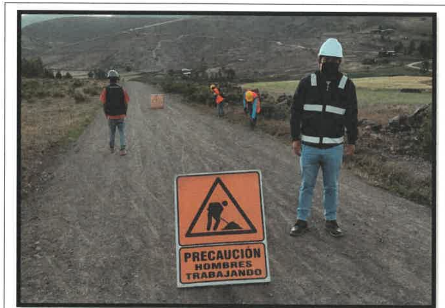
FIG 12. INSPECTOR VERIFICANDO QUE SE COLOQUE LAS SEÑALES DE ADVERTENCIA ANTES TRABAJOS DE LIMPIEZA DE CALZADA FECHA: 01/05/2021 SEÑAL PREVENTIVA ANTE LIMPIEZA DE CUNETAS
