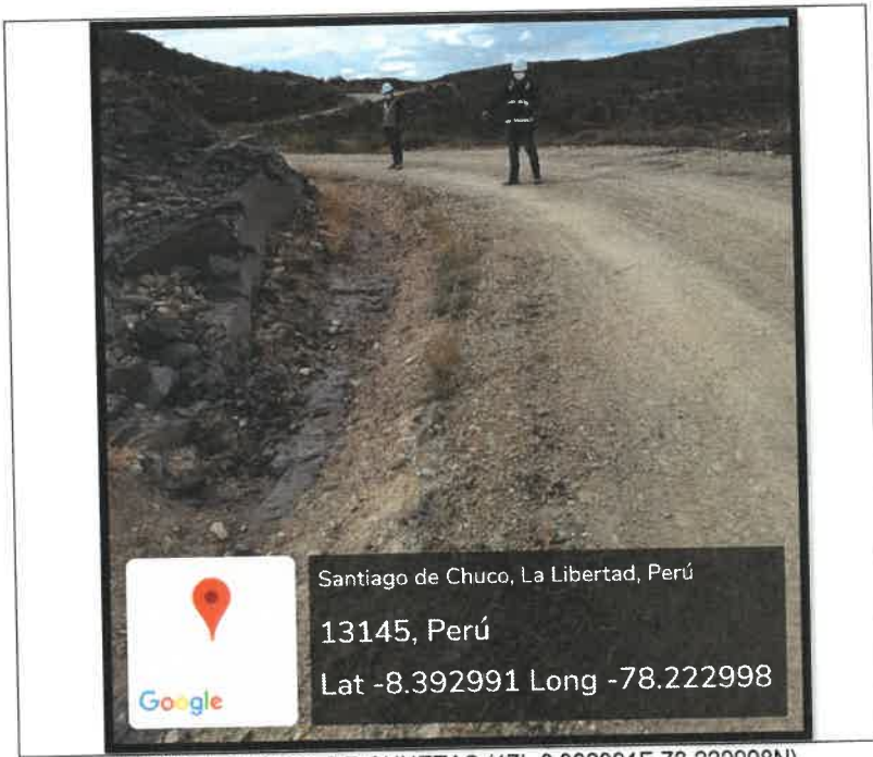
FIG 06. LIMPIEZA DE CUNETAS (17L 8.392991E 78.222998N) ALT. 3312.00M FECHA: 22/05/2021 ING. INSPECTOR Y RESIDENTE VERIFICANDO LOS TRABAJOS
