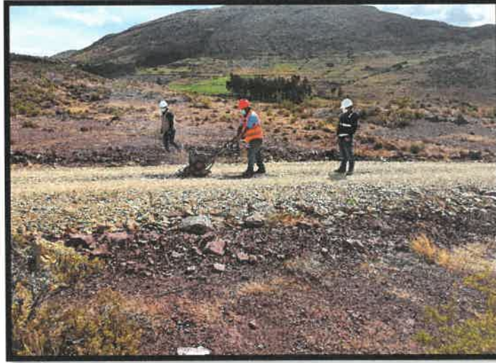
FIG. 03 COLOCACION DE MATERIAL PARA BACHEO (17L 8.383477E 78.224169N) ALT. 3941.00M FECHA: 08/05/2021 ING. INSPECTOR Y RESIDENTE VERIFICANDO LO TRABAJOS
