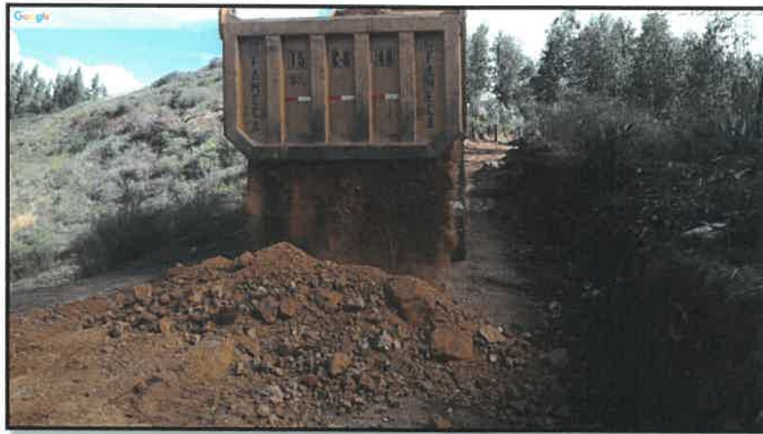
COLOCACIÓN DE MATERIAL GRANULAR KM 4+800
