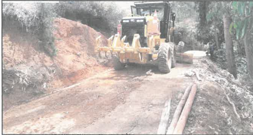
Foto N°11: Se verifican trabajos de reconformación de cunetas en el KM 2+560
