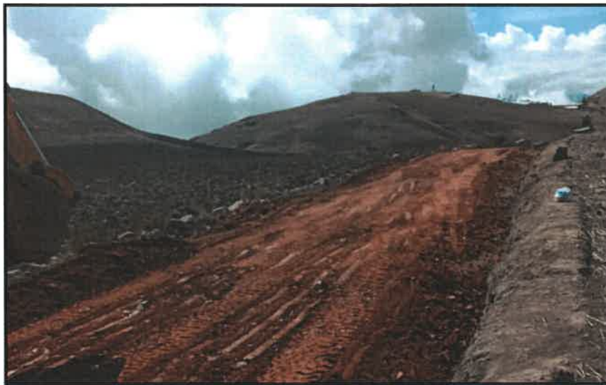
EXTENDIDO DE MATERIAL GRANULAR - KM 4+200
