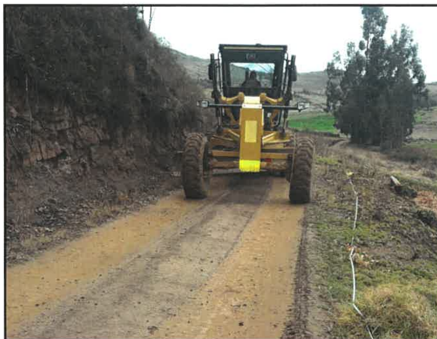
CONFORMACIÓN DE MATERIAL GRANULAR - KM 0+600
