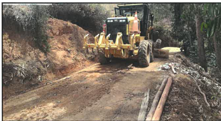
RECONFORMACIÓN DE CUNETAS KM 2+560
