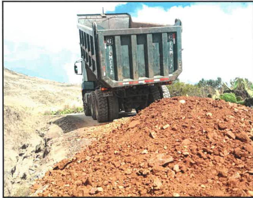
COLOCACIÓN DE MATERIAL GRANULAR - KM 3+300
