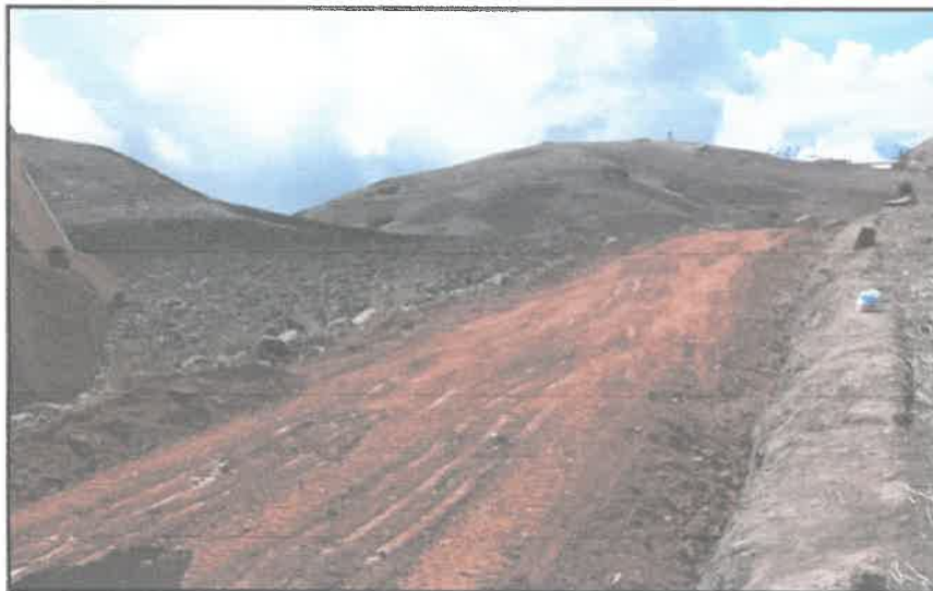
Foto N°13: Se verifican trabajos de extensión de material granular en el KM 4+420
