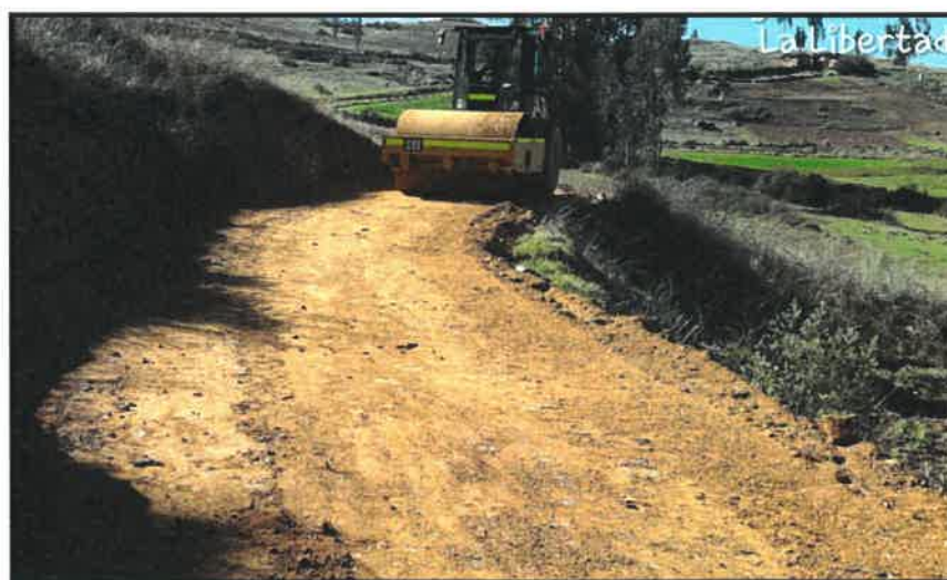
COMPACTACIÓN DE LA VÍA - KM 0+800
