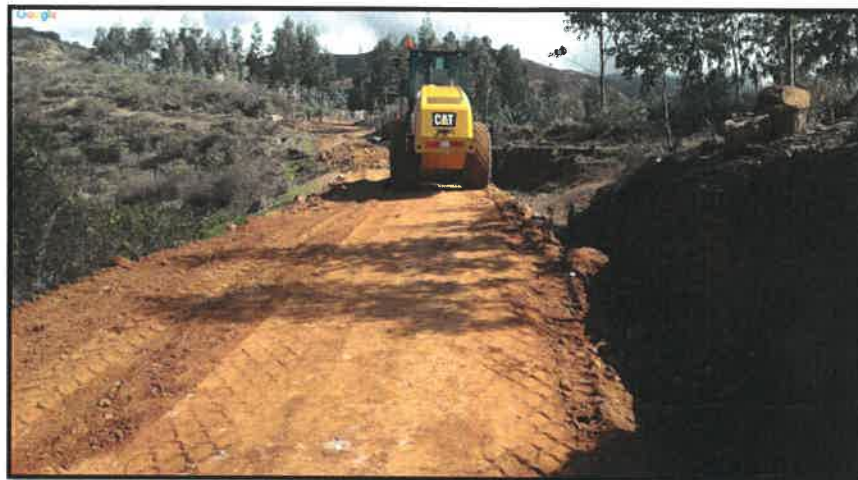
COMPACTACIÓN DE MATERIAL GRANULAR - KM 5+200
