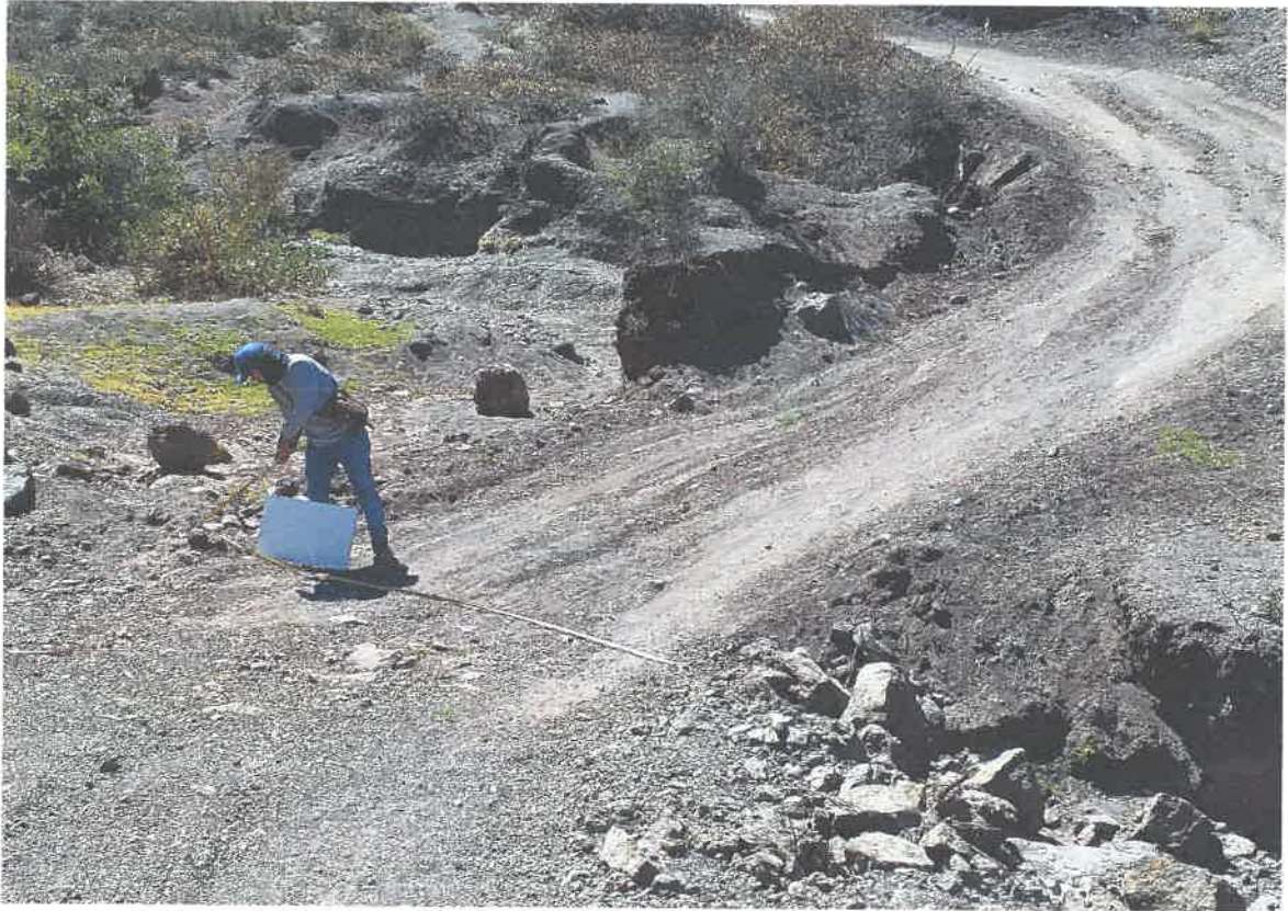
Foto N°02: PROGRESIVA 14+350 EMPALME RED VIAL VECINAL LI 122
