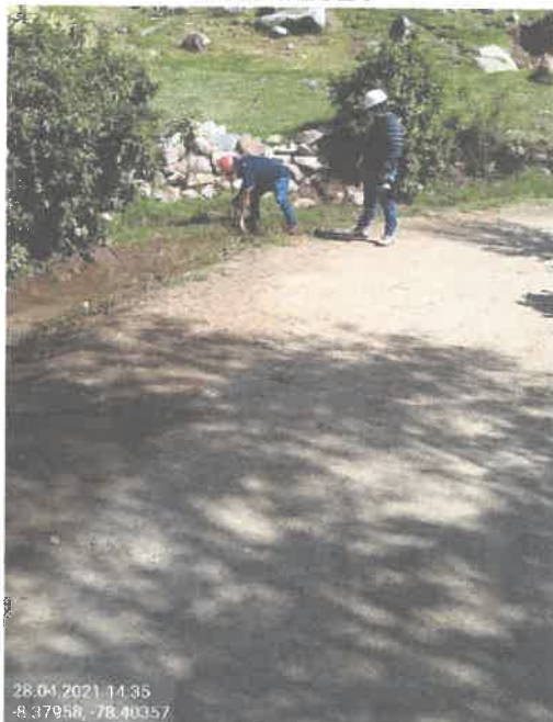
FOTOGRAFIA N° 3. VERIFICACION DE TRABAJOS DE LIMPIEZA DE CUNETAS SECTOR OYON(COORDENADAS N 9072794 E785948) FECHA 28/04/2021
