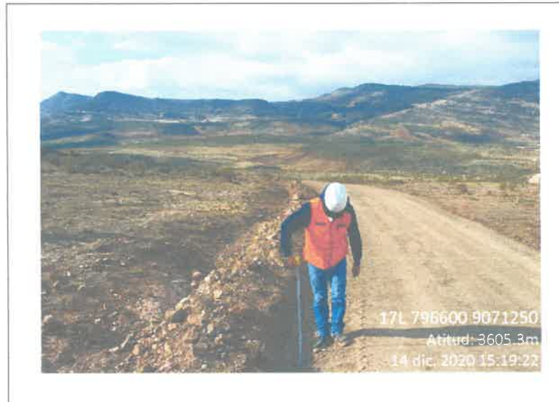
Fig. 17 Reconformación de cunetas (17L 788179E 9071009N) Alt. 3569.0m
