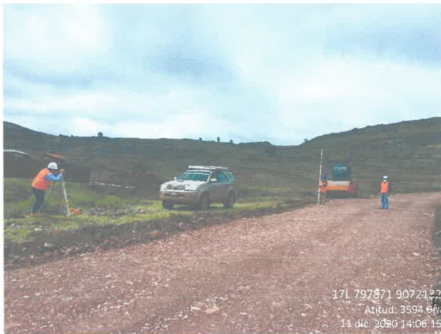
Fig. 08 Control y nivelación de plataforma terminada (17L 797871E 9072132N) Alt. 3594.00m
