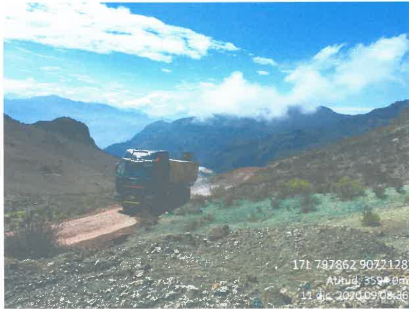
Fig. 07 Riego de tramo a intervenir (17L 797862E 9072128N) Alt. 3594.00m
