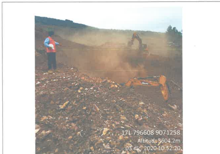
Fig. 03 Extracción, Apilamiento de material granular (17L 796608E 9071258N) Alt. 3604.2m
