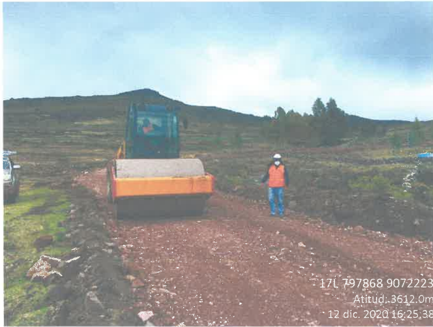
Fig. 09 Compactación de superficie intervenida (17L 797868E 9072223N) Alt. 3612.00m
