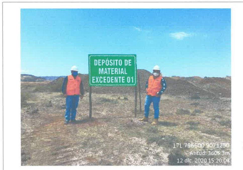
Fig. 16 Eliminación de material excedente (17L 796600E 9071250N) Alt. 3605.3m
