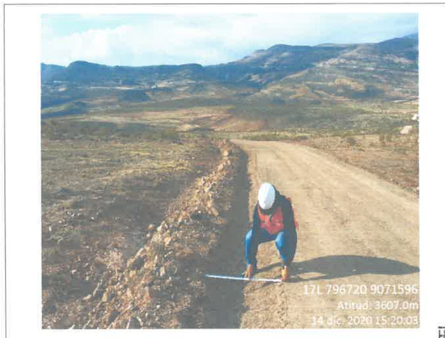
Fig. 18 Reconformación de cunetas (17L 796720E 9071596N) Alt. 3607.0m
