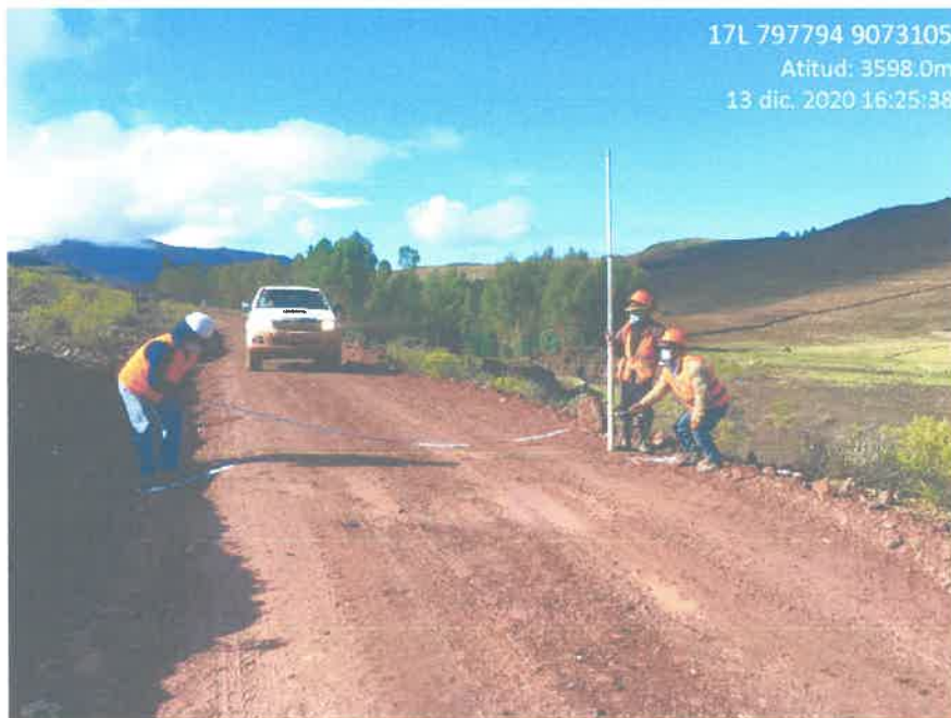
Fig. 10 Control de superficie intervenida (17L 797794E 9073105N) Alt. 3598.00m
