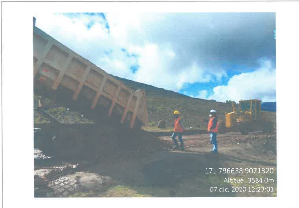
Fig. 05 Colocación de material granular (17L 796638E 9071320N) Alt. 3584.00m
