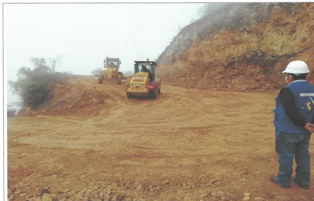
Verificación de los trabajos, compactación de la plataforma en el, km 13+150 junto al Ing. Residente. 9091973N 814959E
