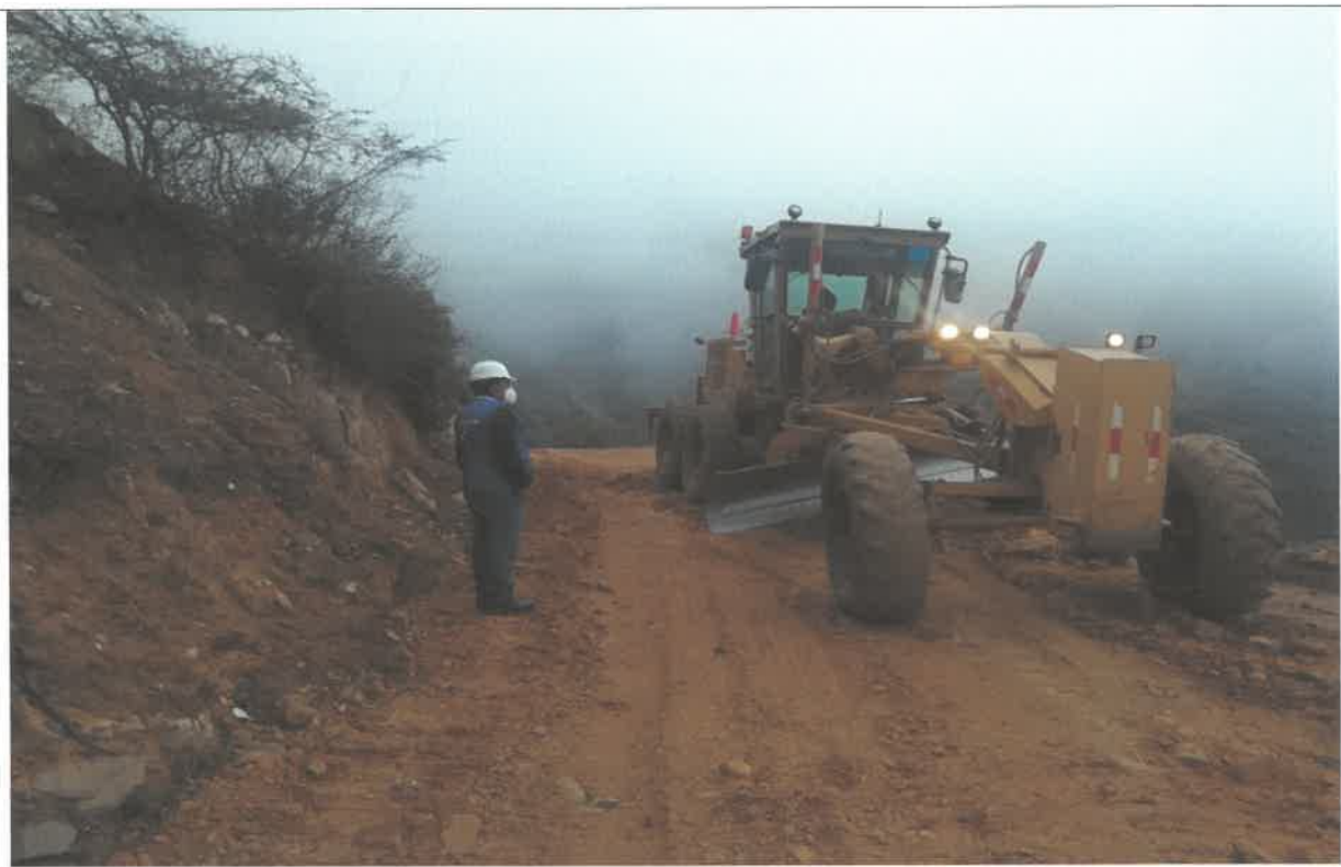
Verificación del proceso constructivo, colocación de capa nivelante e=0.05m, Km 16+000, 9090500N 814920E
