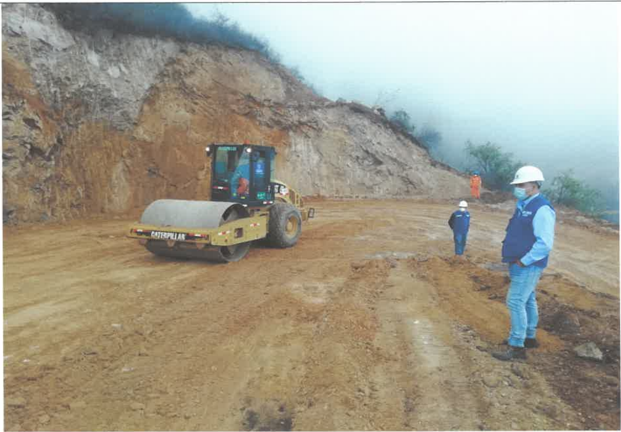
Proceso constructivo, Compactación de la plataforma en el, km 10+100 junto al Ing. Residente. 9093228N 814355E
