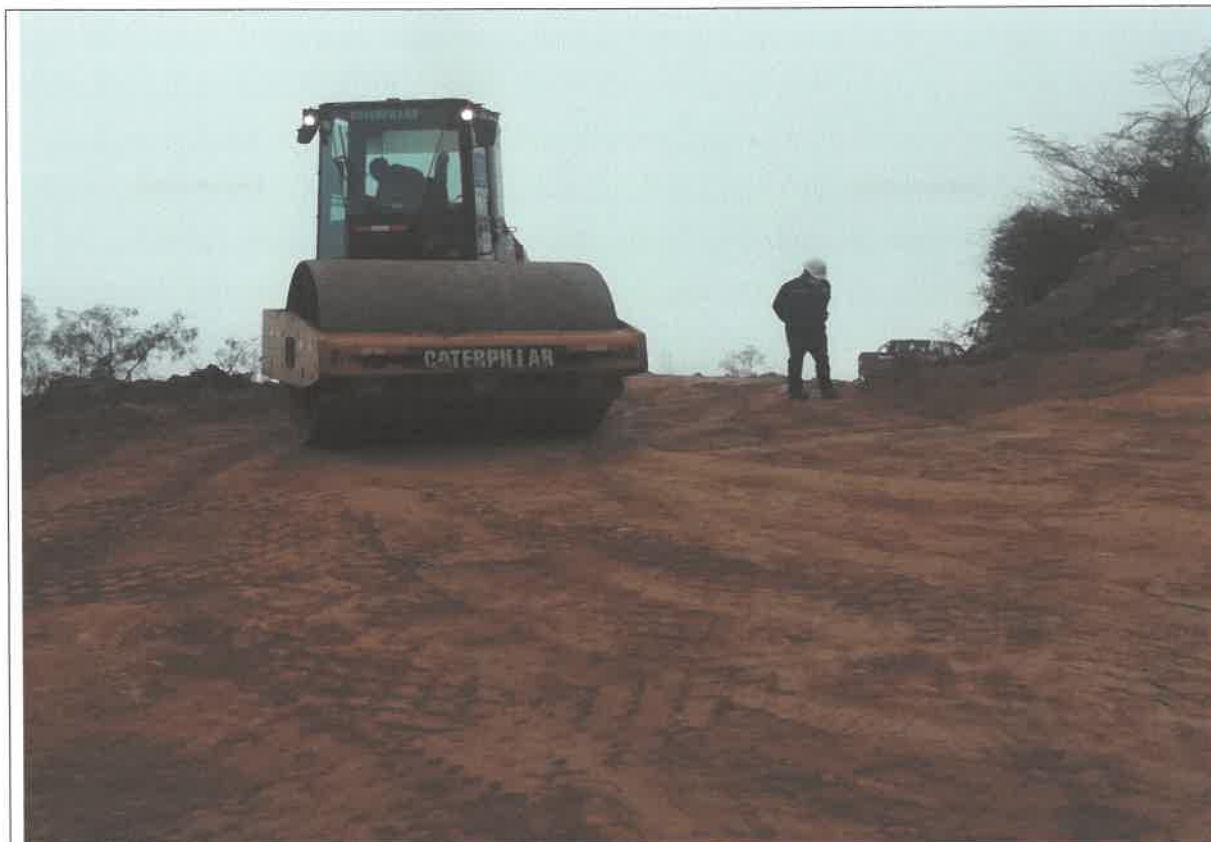
Proceso constructivo, Compactación de la plataforma en el, km 09+850 junto al Ing. Residente. 9093180N 814214E
