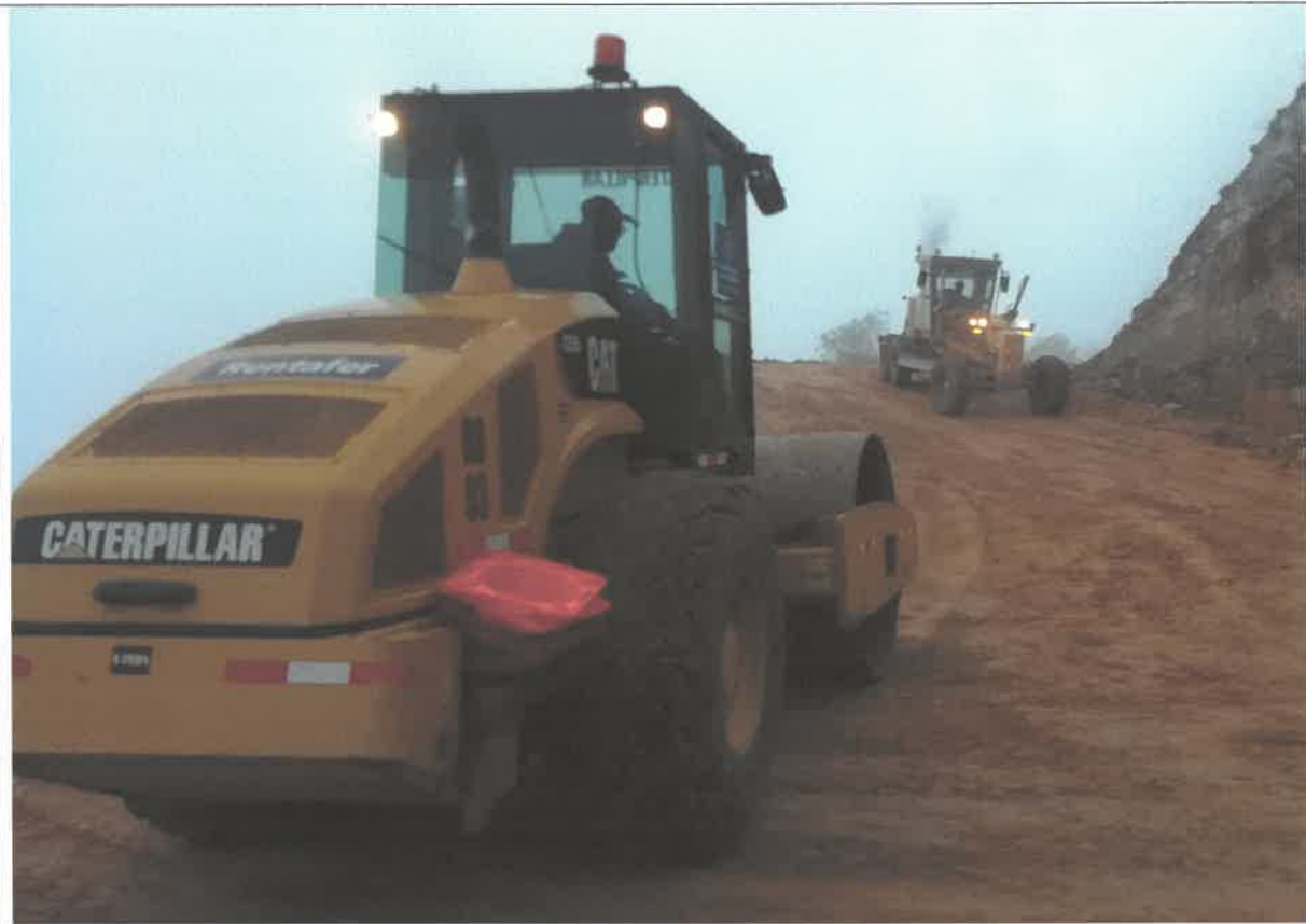
Proceso constructivo, Compactación de la plataforma en el, km 08+200 junto al Ing. Residente. 90942000N 814152E
