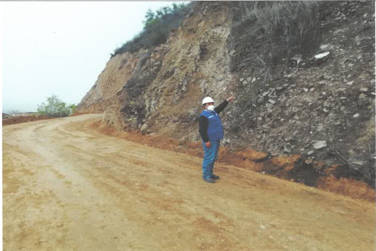
Verificación de los trabajos realizados en la progresiva, km 15+850 9090636N 814968E
