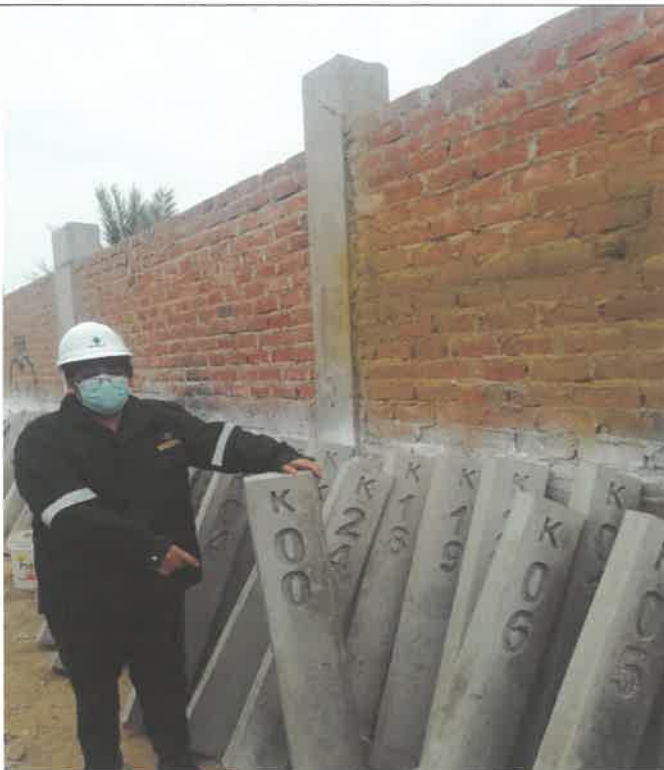
Verificación de la fabricación de los Hitos kilométricos en el almacén de producción, para la colocación de los mismos en la vía referente al paquete 11, Hito Km 0+000
