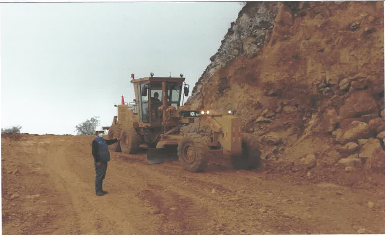
Verificación del proceso constructivo, colocación de capa nivelante e=0.05m, Km 13+250, 9091906N 814885E
