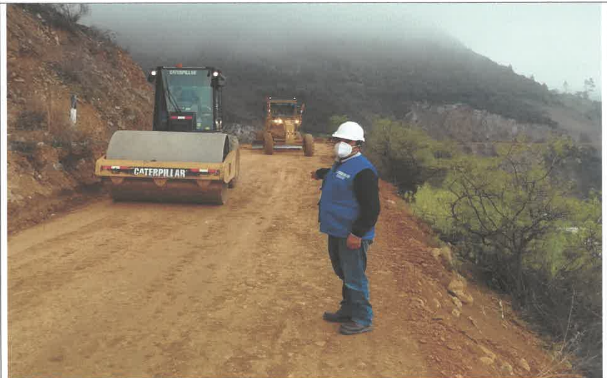
Inicio del proceso constructivo, Compactación de la plataforma en el, km 13+500 junto al Ing. Residente. 9091796N 814663E
