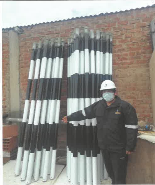
Verificación de la fabricación de los postes metálicos, en el almacén de producción, para la colocación de los mismos, en la vía referente al paquete 11
