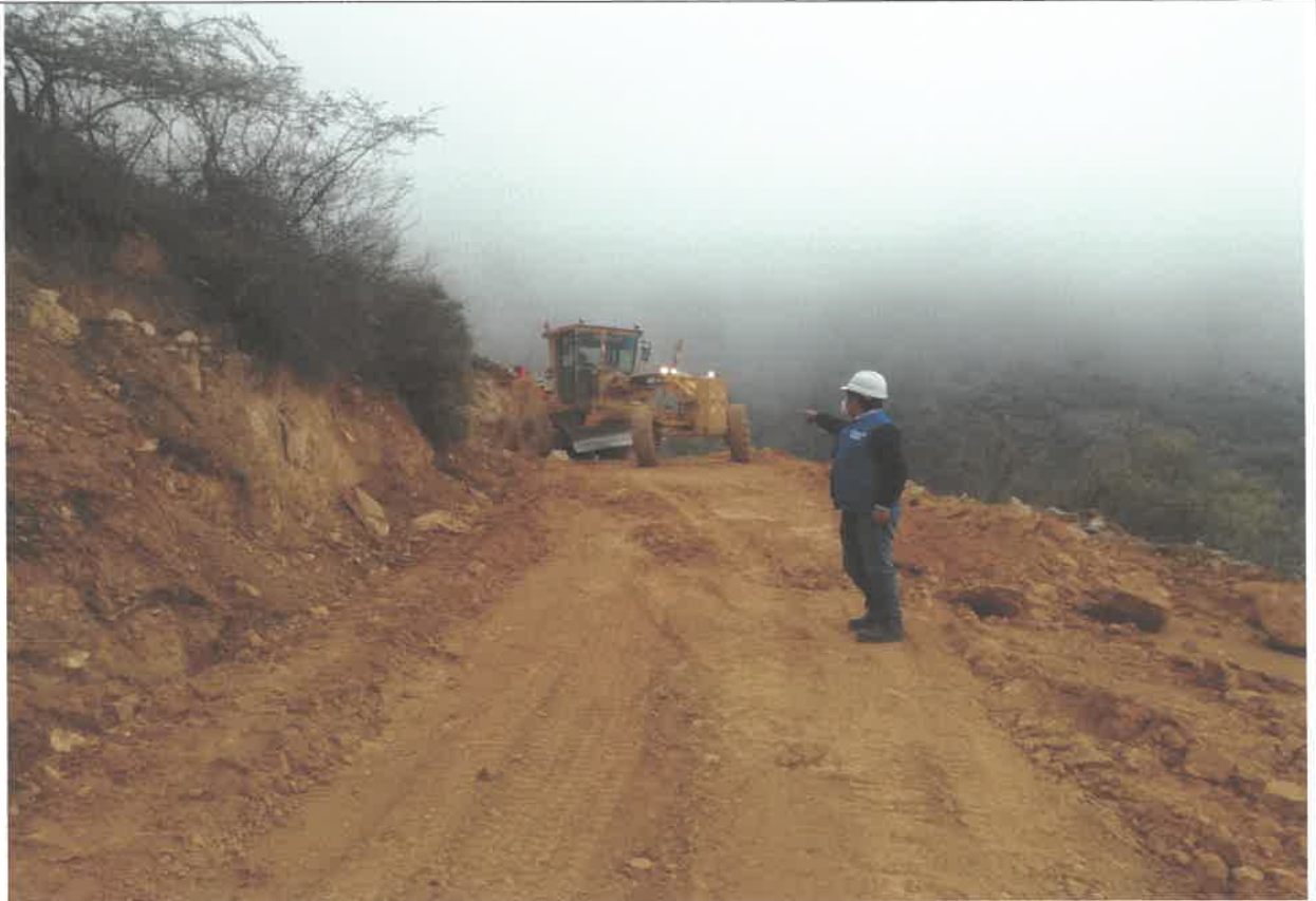
Verificación de los trabajos realizados, referente a la colocación de material granular km 08+500, a cargo del Ing. Residente. 9093933N 814276E
