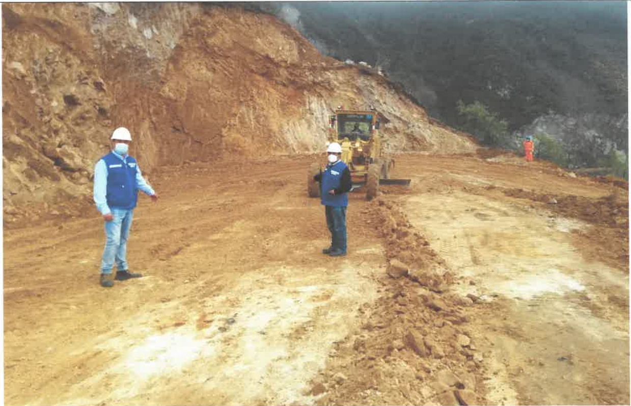
Inicio del proceso constructivo colocación de material granular de cantera e=0.15m, km 15+500, em presencia de Ing Residente. 9090951N 814911E
