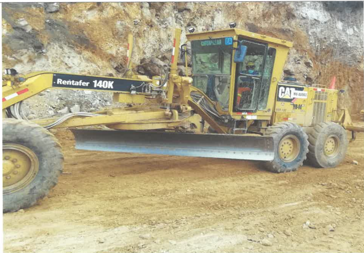
Verificación del proceso constructivo, colocación de capa nivelante e=0.05m, Km 13+050, 9092047N 815027E
