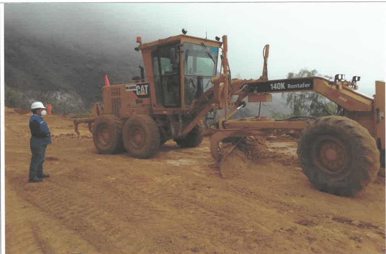
Esparcido de material granular de cantera e=0.15m, km 12+250, junto al Ing. Residente. 9092660N 814917E
