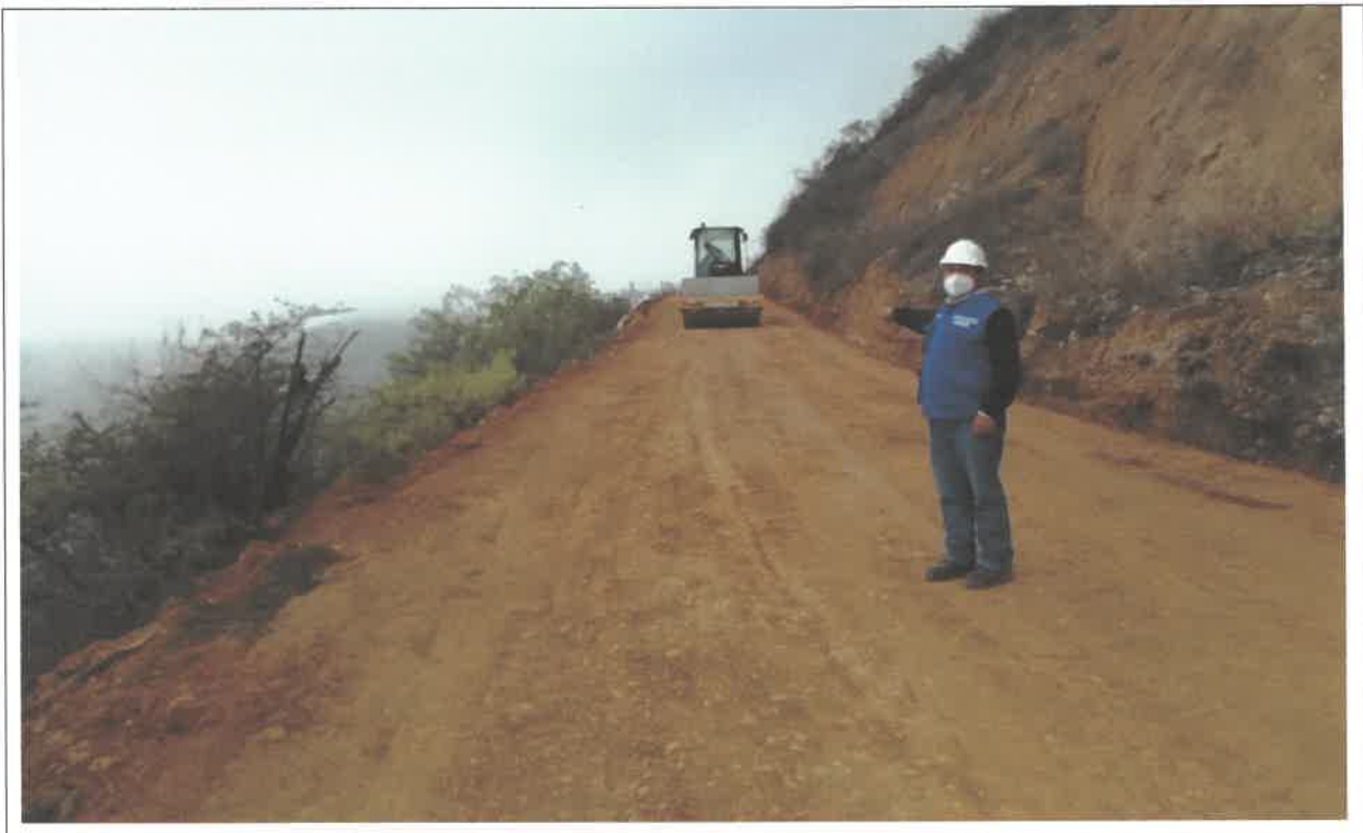
Proceso constructivo, Compactación de la plataforma en el, km 12+500 junto al Ing. Residente. 9092462N 815068E
