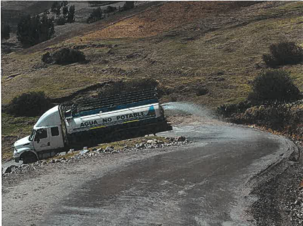
Se observa el camión cisterna regando la capa de material granular de cantera.
