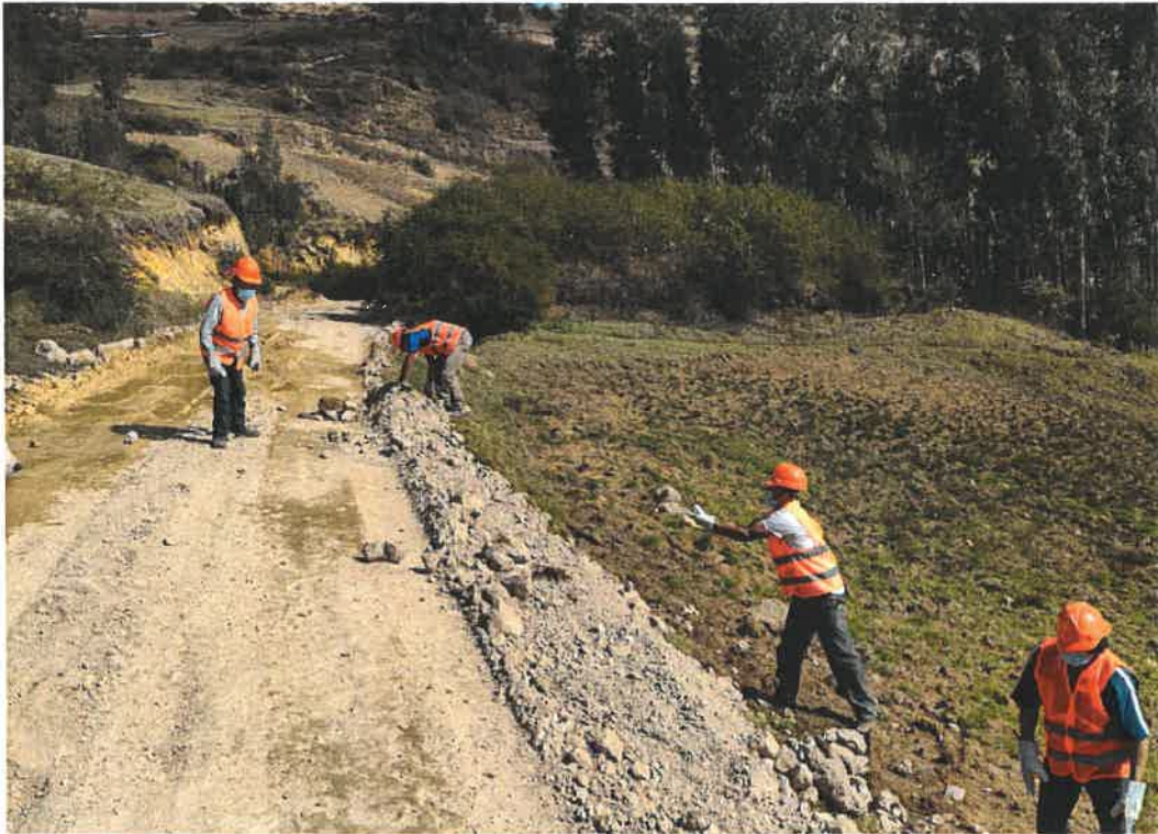
Se observa la limpieza luego de la conformación de cunetas.
