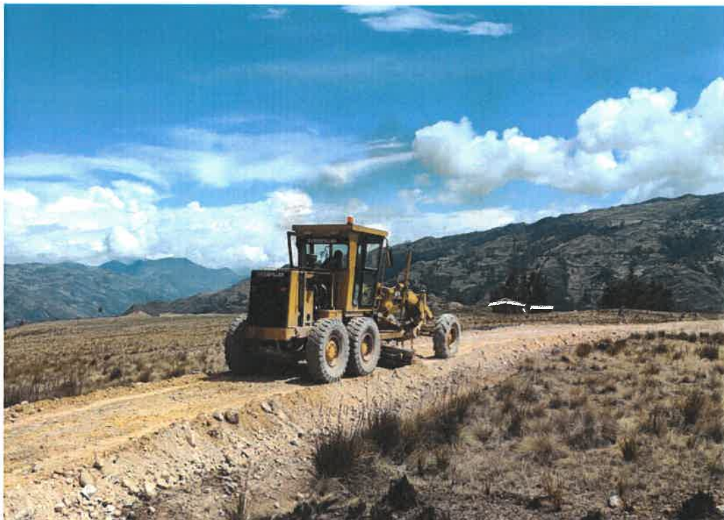
Se observa la nivelación de material granular de cantera.
