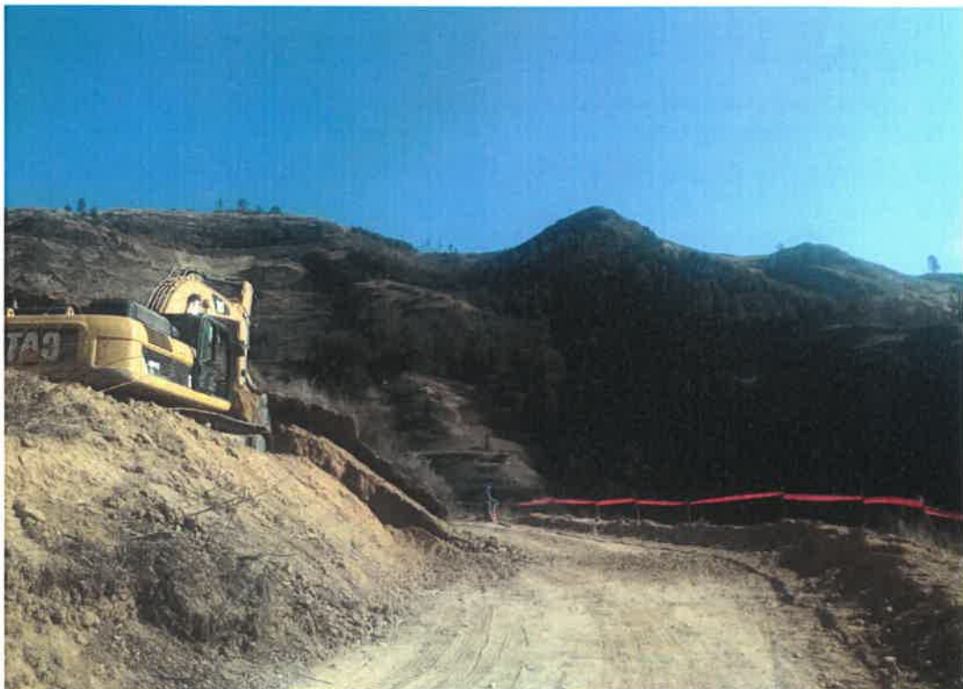
Se observa la señalización en zonas de trabajo.
