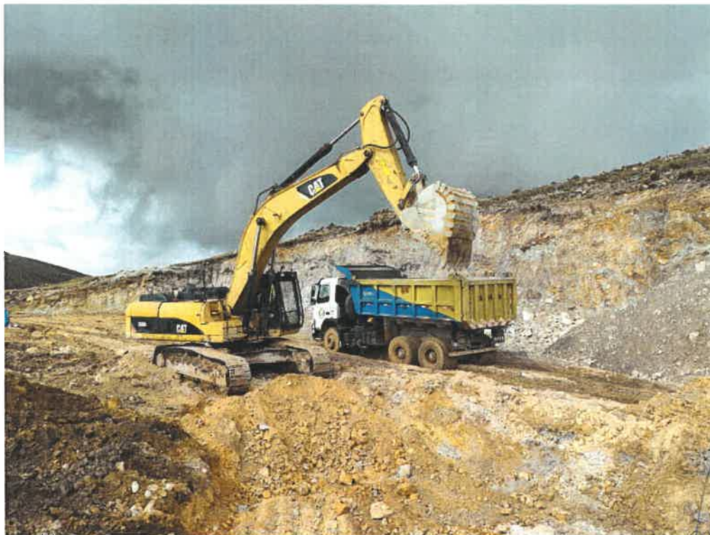
Se observa el trabajo de maquinaria en cantera.
