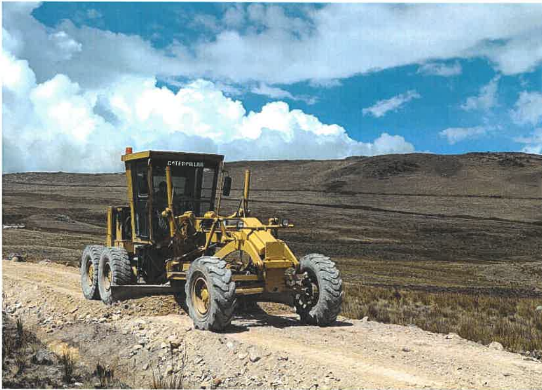
Se observa el extendido de material granular de cantera.
