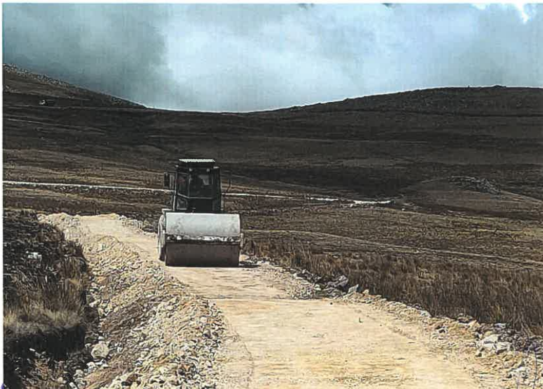
Se observa el compactado del material granular de cantera
