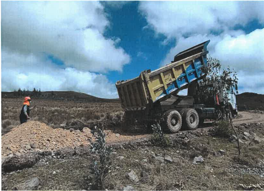
Se observa el transporte de material de cantera hacia la zona de trabajo.
