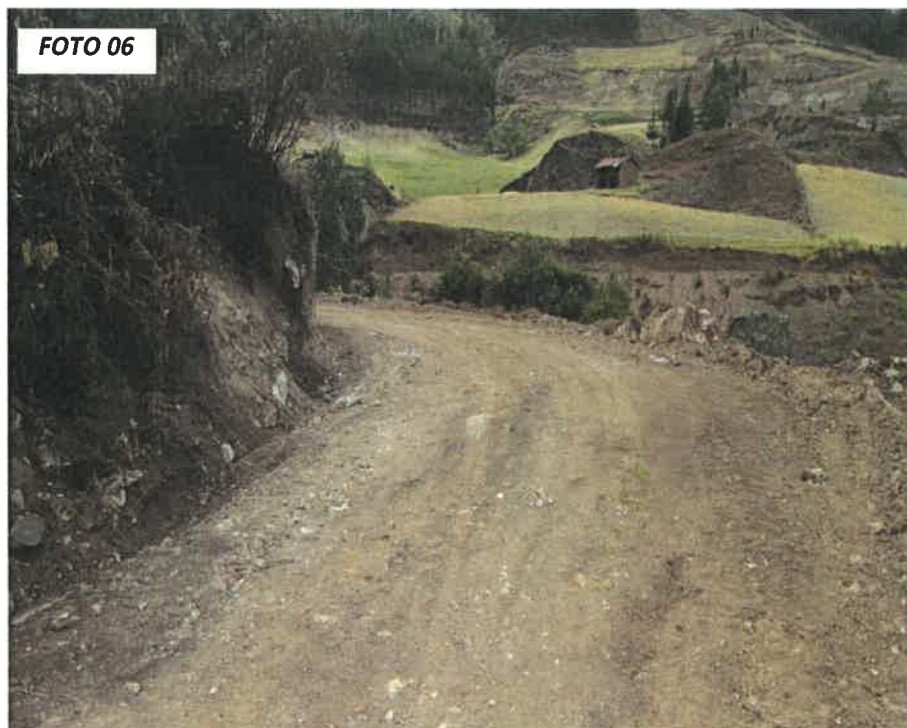
FOTO 06: SE OBSERVA LOS TRABAJOS EN LA CAPA NIVELANTE
