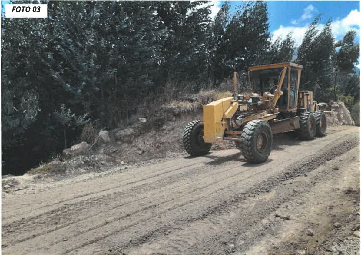
FOTO 03: SE OBSERVA LOS TRABAJOS EN MATERIAL GRANULAR, TRAMO: CONACHUGO-SANTO DOMINGO
