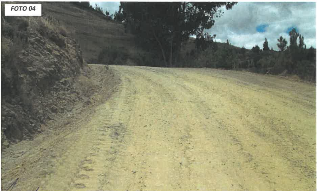
FOTO 04: SE LA CONFORMACION DE CUNETAS
