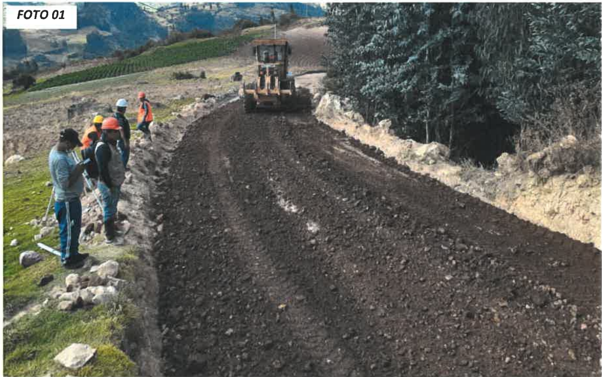
FOTO 01: SE OBSERVA LOS TRABAJOS EN LA CAPA NIVELANTE, TRAMO: CONACHUGO-SANTO DOMINGO
