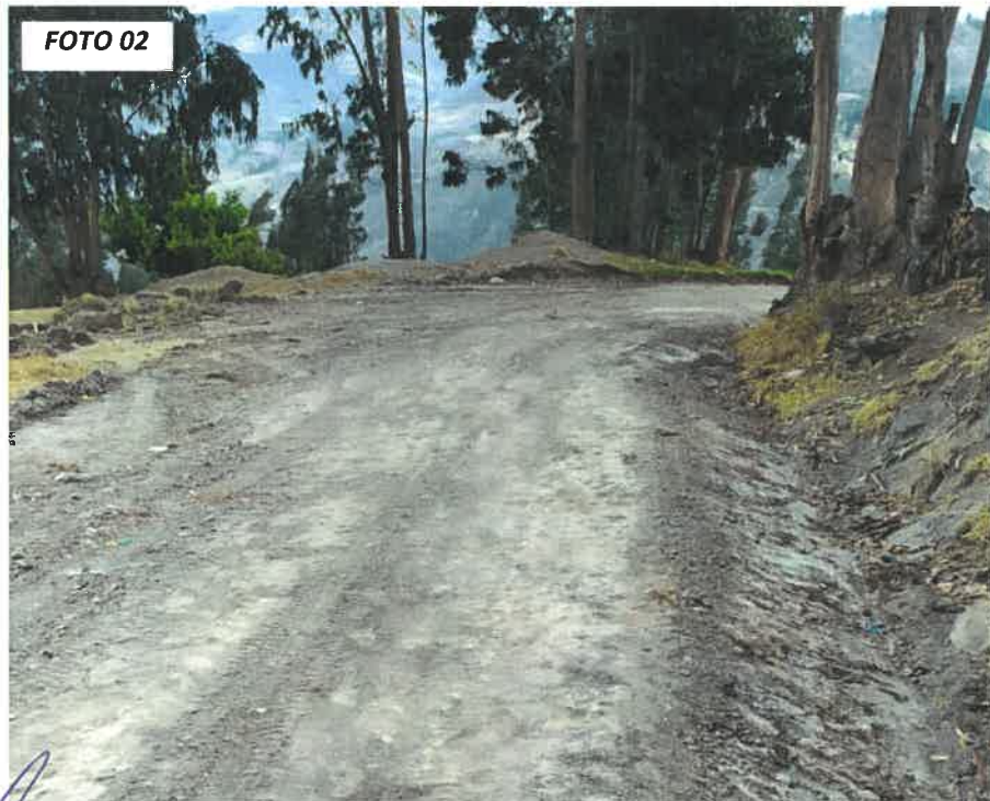
FOTO 02: SE OBSERVA LOS TRABAJOS EN LA CAPA NIVELANTE
