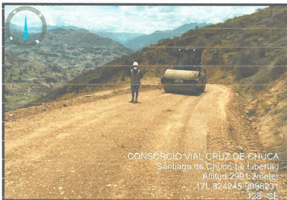
Foto N°03: Compactación de Ptaforma.
