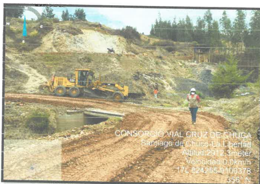
Foto N°8: Conformación de cunetas con motoniveladora.
