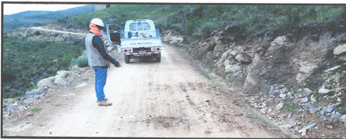
IMAGEN 03: Verficacion de bacheos realizados.
