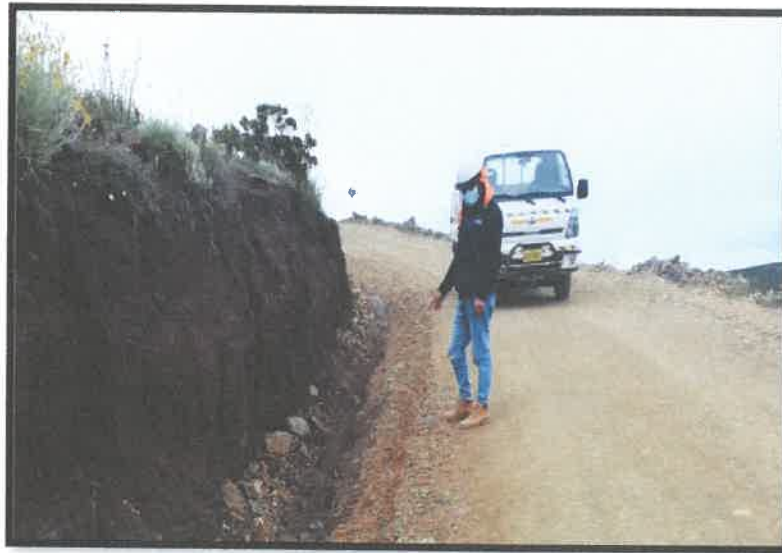
IMAGEN 01: Verificacion de Limpieza de Cunetas y calzada
