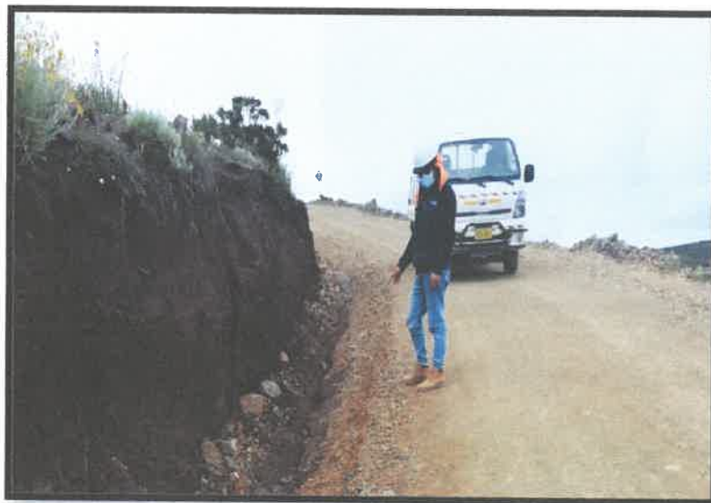
IMAGEN 01: Verificacion de Limpieza de Cunetas y calzada
