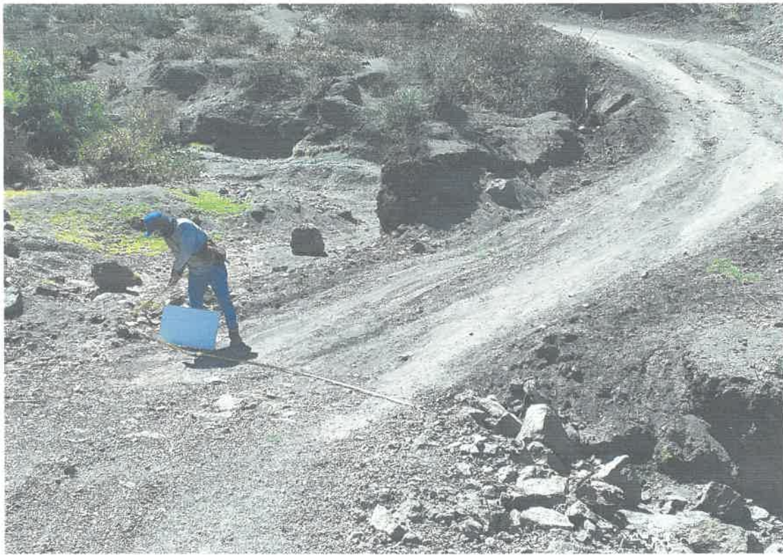
Foto N°02: PROGRESIVA 8+800 EMPALME RED VIAL VECINAL LI 122
