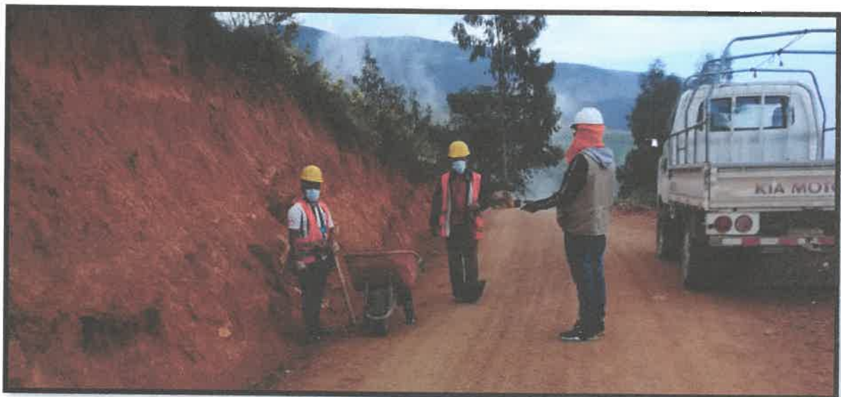
IMAGEN 02: Explicacion de Actividad ha realizarse por parte del Ing Inspector
