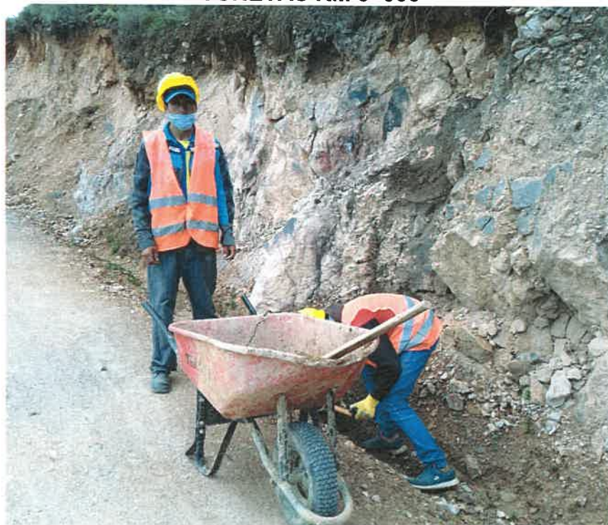
FOTOGRAFIA N° 3. VERIFICACION DE TRABAJOS DE LIMPIEZA DE CUNETAS KM 3+500
