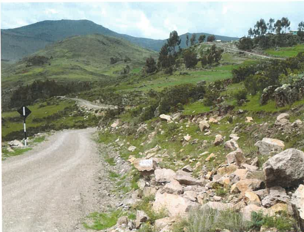
FOTOGRAFIA N° 02. IDENTIFICACION DE CUNETAS CON MATERIAL ACUMULADO, CON LA NECESIDAD DE LIMPIEZA.
