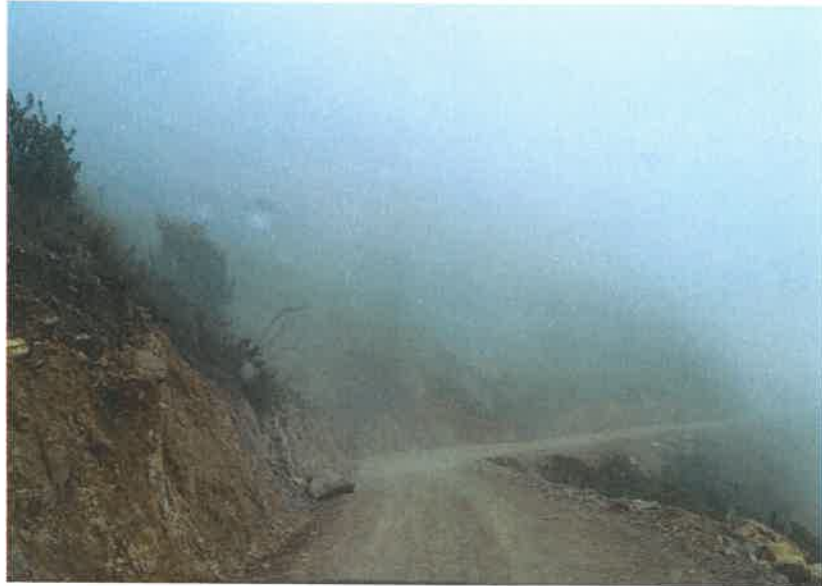
FOTOGRAFIA N° 5. IDENTIFICACION DE ZONA DE LIMPIEZA DE DERRUMBES
