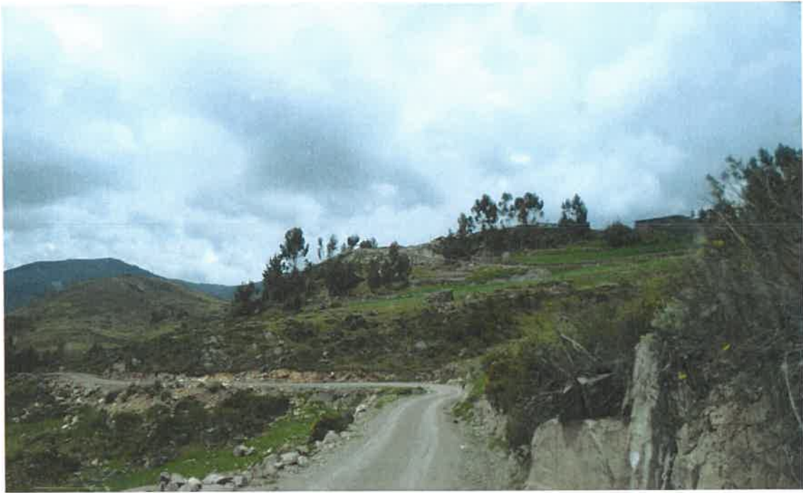
FOTOGRAFIA N° 02. IDENTIFICACION DE CUNETAS CON MATERIAL ACUMULADO, CON LA NECESIDAD DE LIMPIEZA.
