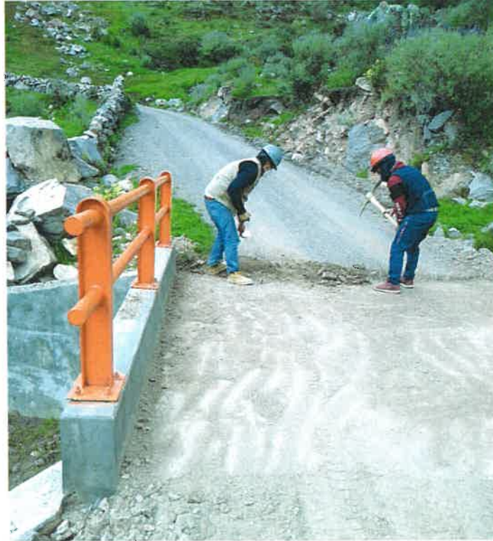
FOTOGRAFIA N° 05. EJECUCION DE TRABAJOS DE LIMPIEZA DE PONTON.
