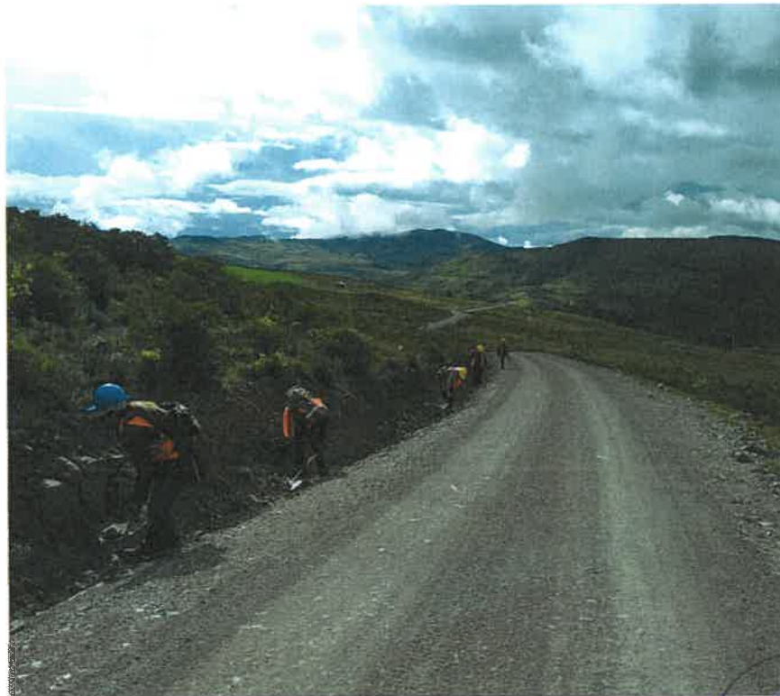
FOTOGRAFIA N° 06. VERIFICACION DE TRABAJOS DE LIMPIEZA DE CUNETAS POR PARTE DEL INSPECTOR
