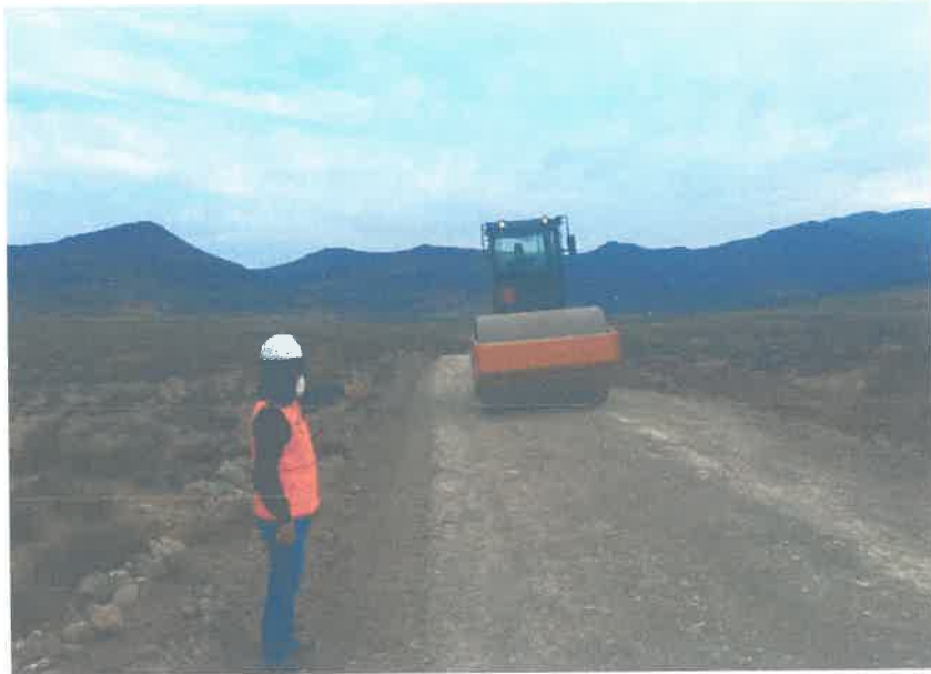
Fig. 07 Compactación de superficie intervenida (17L 795278E 9072587N) Alt. 3582.00m
