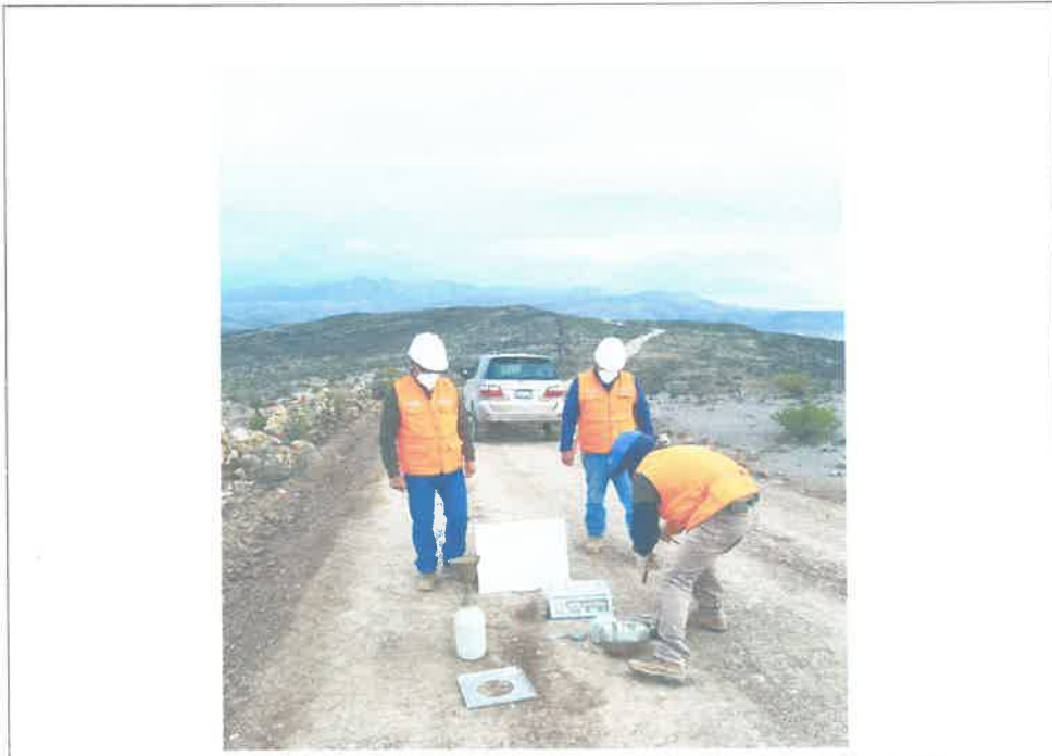
Fig. 11 Prueba de densidad de campo en tramo intervenido (17L 796280E 9073210N) Alt. 3486.00m
