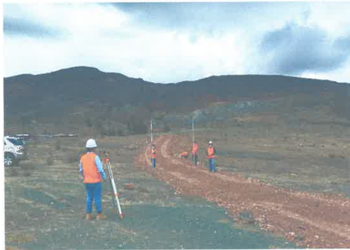
Fig. 04 Nivelación de material granular (17L 794887E 9073485N) Alt. 3498.00m
