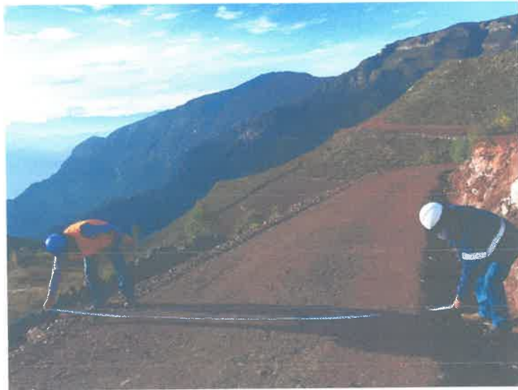
Fig. 08 Control de superficie intervenida (17L 794890E 9072228N) Alt. 3569.00m
