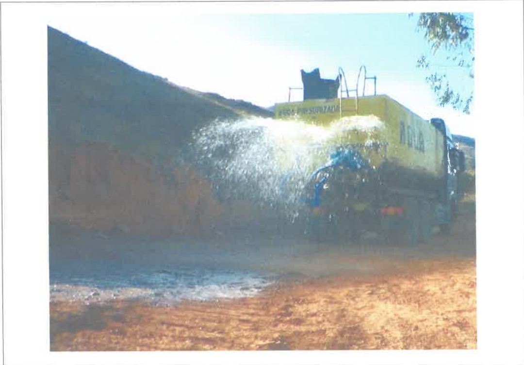
Fig. 05 Riego de tramo a intervenir (17L 795178E 9072485N) Alt. 3524.00m
