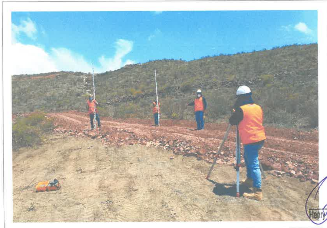
Fig. 06 Control y nivelación de plataforma terminada (17L 784791E 9072326N) Alt. 3573.00m
