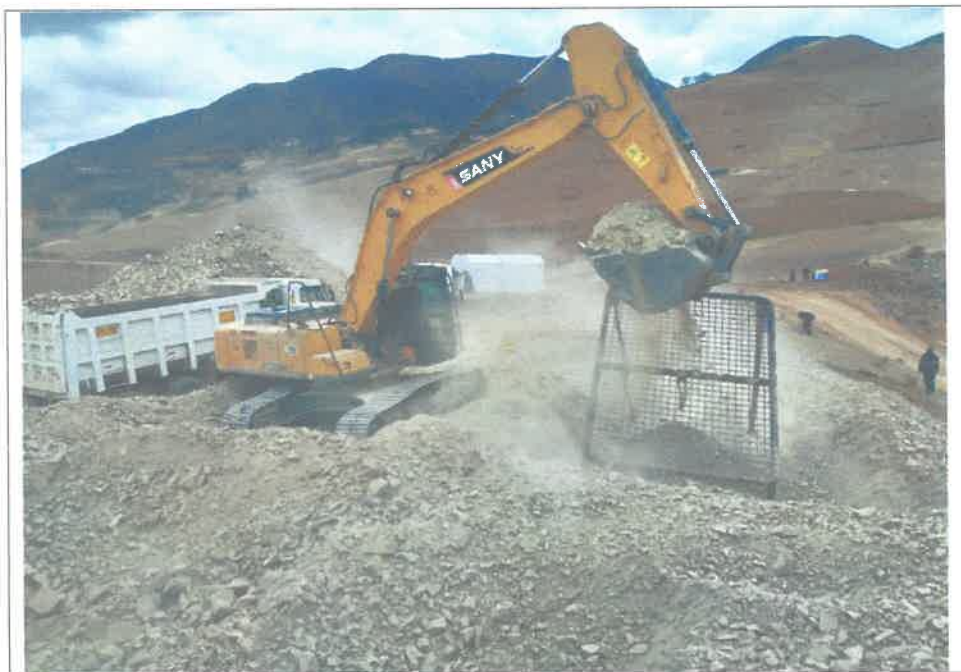
Fig. 12 Carguío y transporte de material granular (17L 794789E 9072327N) Alt. 3642.00m
