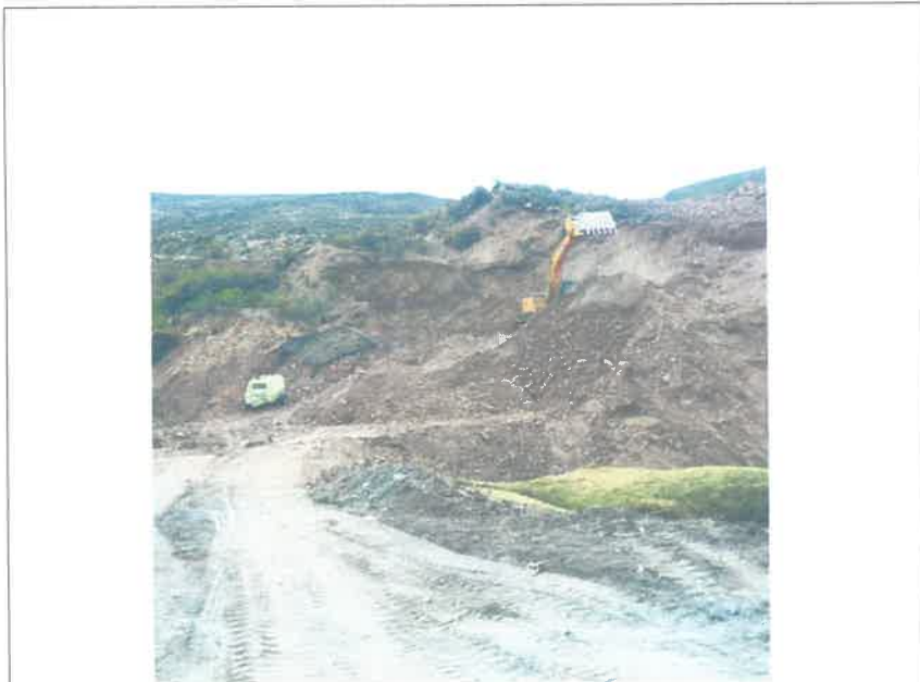
Fig. 01 Extracción, Apilamiento de material granular (17L 794789E 9072327N) Alt. 3572.00m
