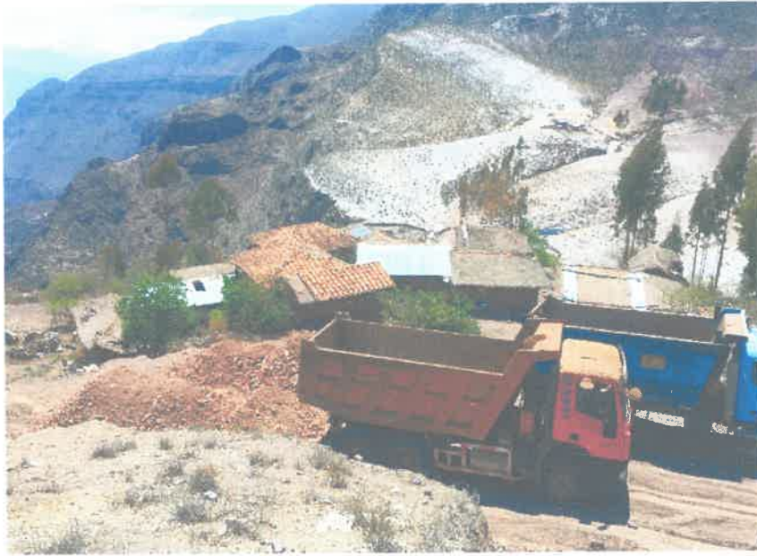
Fig. 03 Colocación de material granular (17L 792964E 9071521N) Alt. 3478.00m
