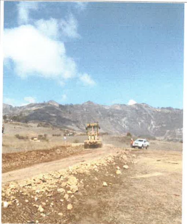
Verificación del proceso constructivo, colocación de capa nivelante e=0.05m, Km 13+500, 9082444N 806233E
