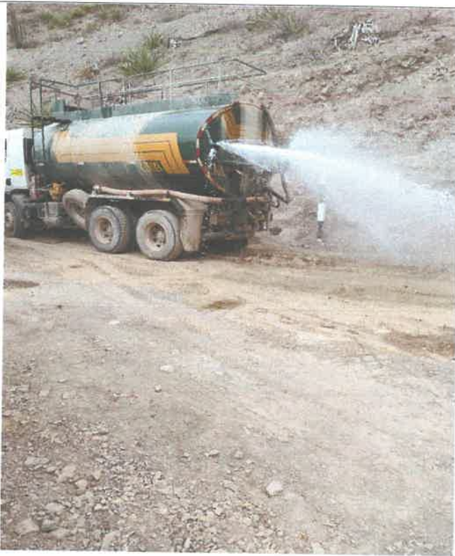
Inicio del proceso constructivo, Riego de la plataforma en el , km 57+000 9080301N 817387E
