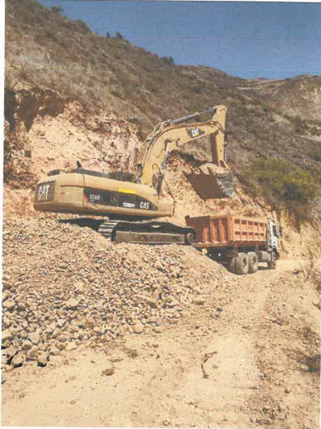
Verificación del proceso transporte de material granular, Km 21+150, 9074022N 802687E
