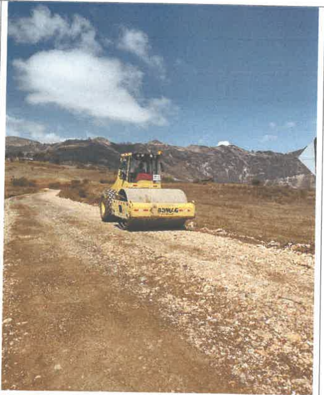
Proceso constructivo, Compactación en plataforma, km 24+500 9086367N 812788E
