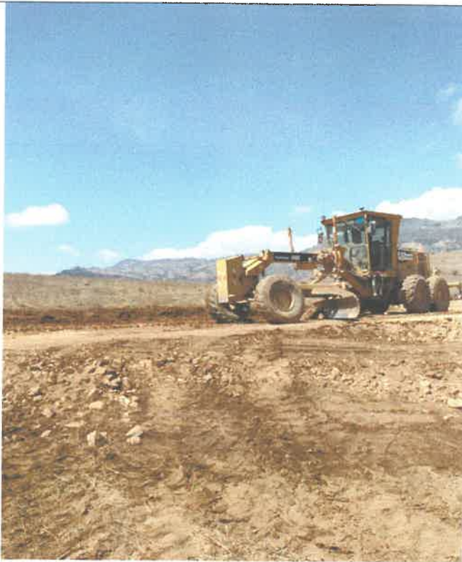
Verificación del proceso constructivo, colocación de capa nivelante e=0.05m, Km 14+250, 9091479N 815098E
