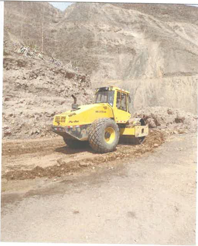
Proceso constructivo, Compactación en plataforma, km 56+500 9080017N 817023E
