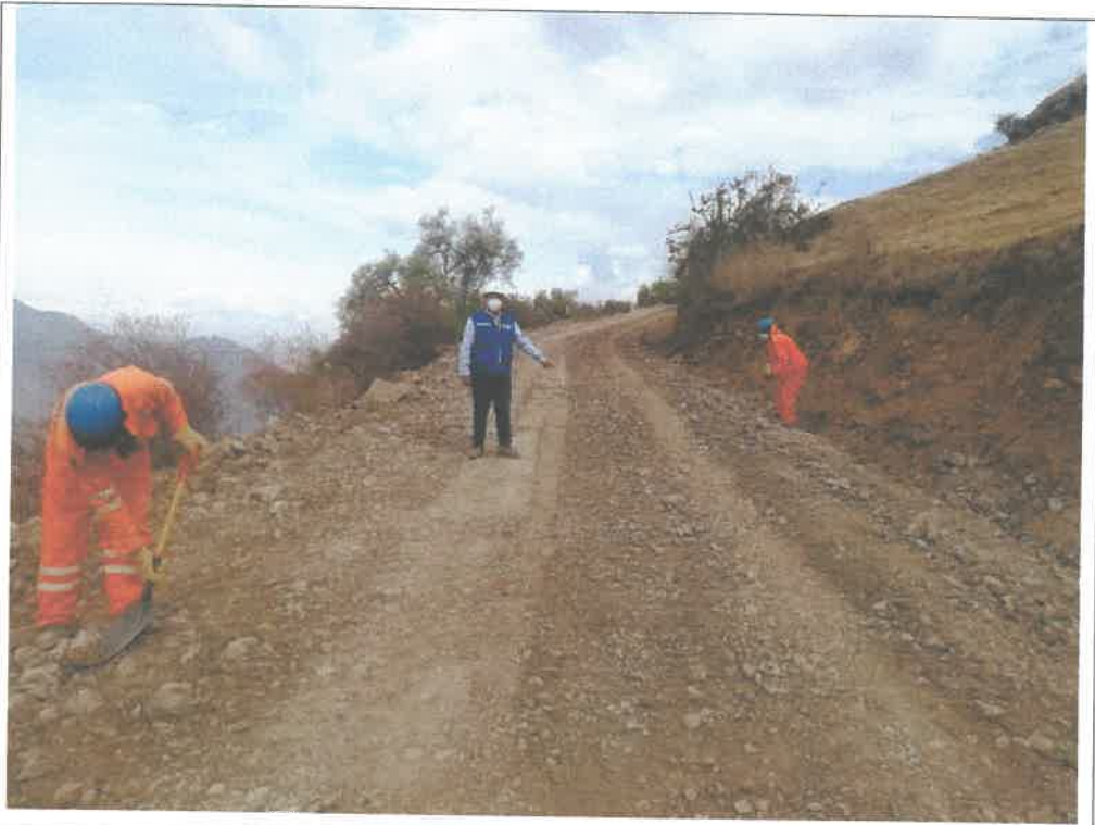
Verificación de los trabajos, referente al tramo 11, Km 19+000, junto con personal de labores. 9089140N 813685E
