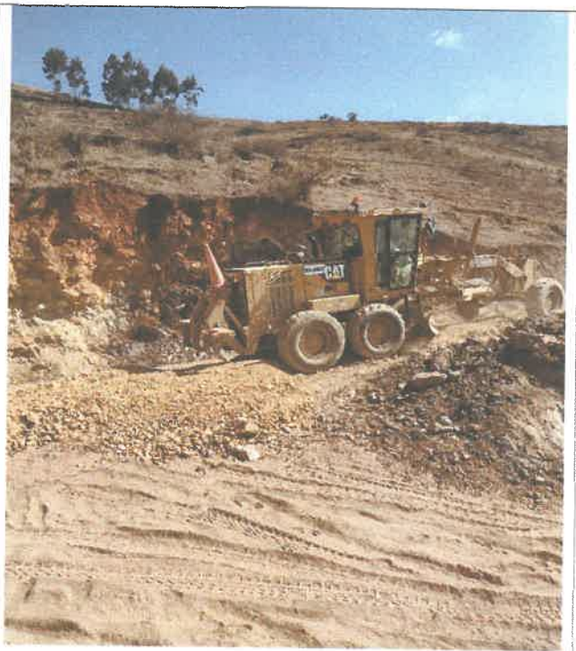
Colocación de material granular de cantera e=0.15m, km 19+250 9088986N 813503E
