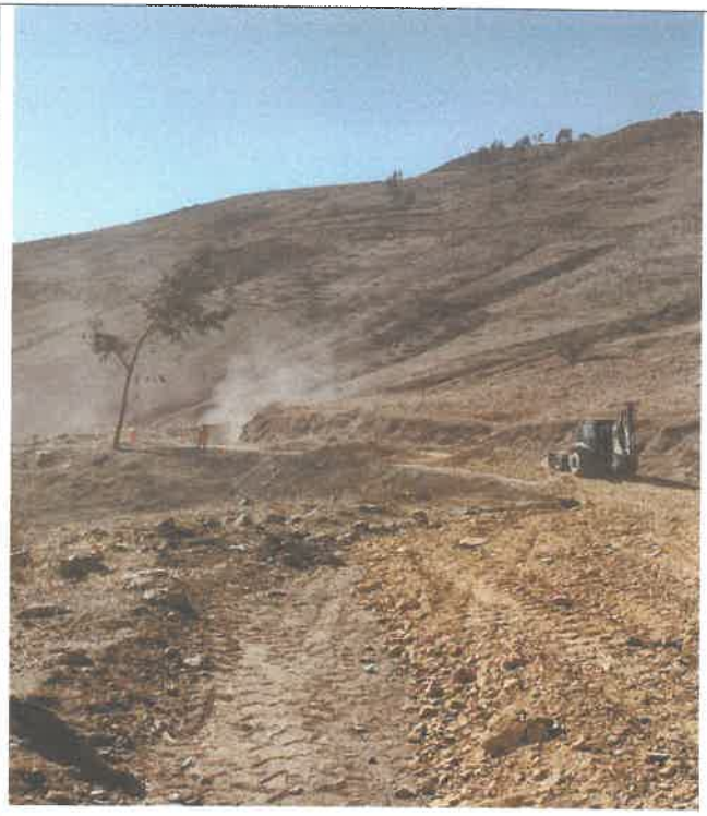
Proceso constructivo colocación de material granular de cantera e=0.15m, km 20+500 9088438N 813133E
