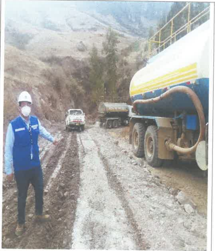
Inicio de proceso constructivo, Riego de la plataforma en el , km 23+000 9087369N 812568E
