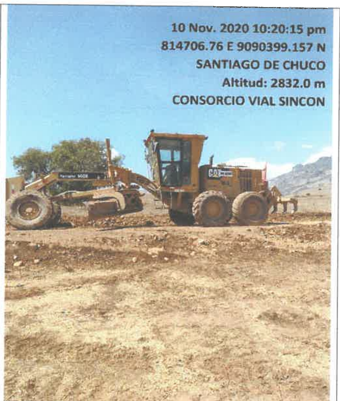
Verificación del proceso constructivo, colocación de capa nivelante e=0.05m, Km 16+000, 9090399N 81706E
