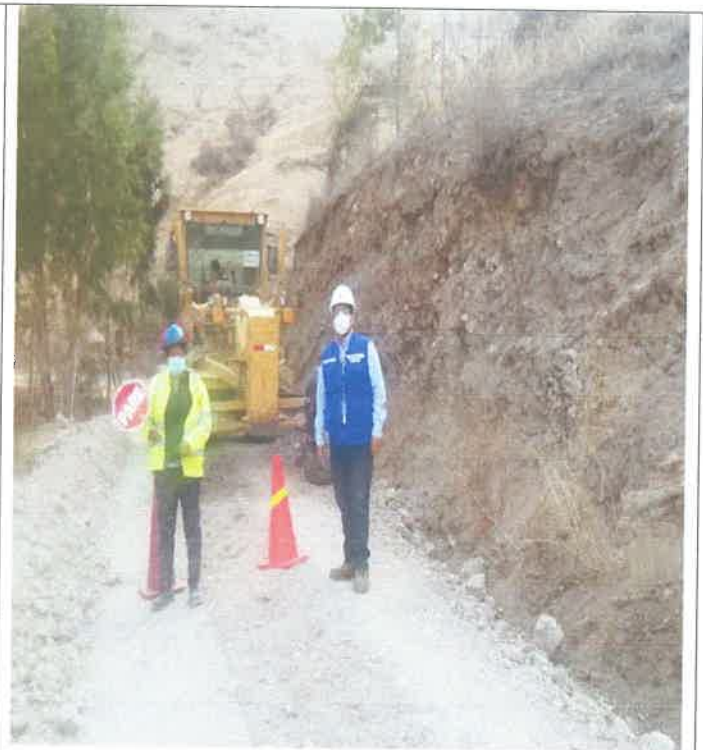
Verificación de los trabajos, referente al tramo 11, Km 22+000, junto con personal de labores. 9087742N 812598E
