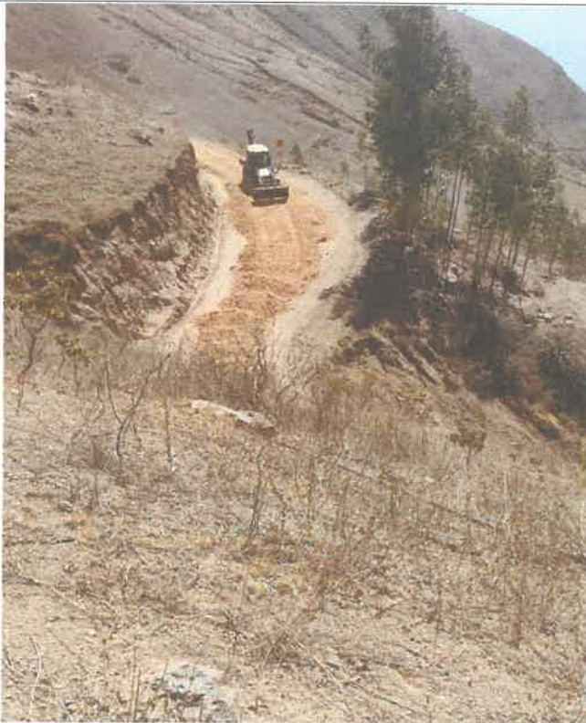
Proceso constructivo colocación de material granular de cantera e=0.15m, km 22+150 9070358N 803117E
