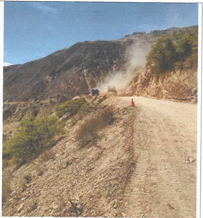
Verificación del proceso transporte de material granular, Km 23+000, 9074022N 802687E
