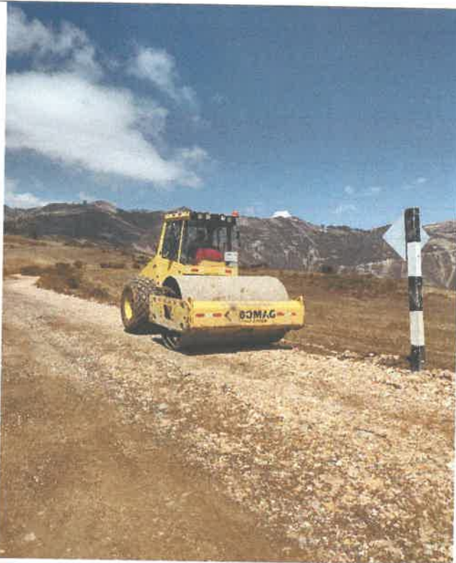
Proceso constructivo, Compactación en plataforma, km 23+200 9087309N 812471E
