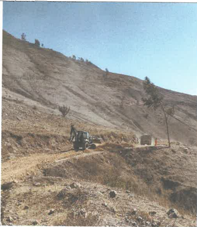
Verificación del proceso transporte de material granular, Km 24+150, 9074022N 802687E
