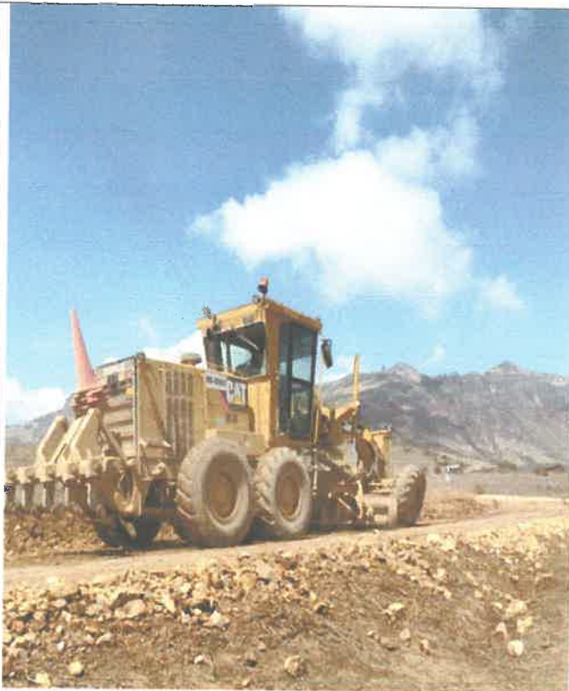
Verificación del proceso constructivo, colocación de capa nivelante e=0.05m, Km 12+000, 9074022N 802687E
