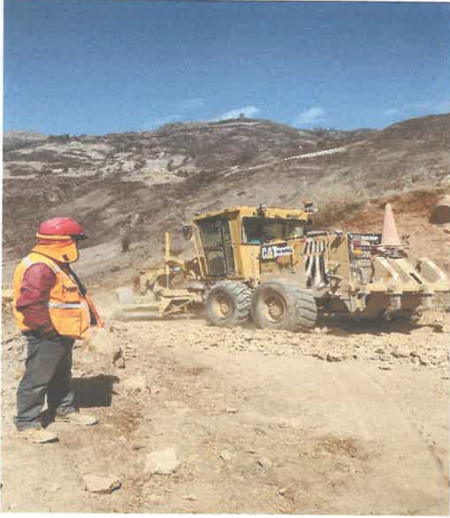
Proceso constructivo colocación de material granular de cantera e=0.15m, km 19+750 9070358N 803117E
