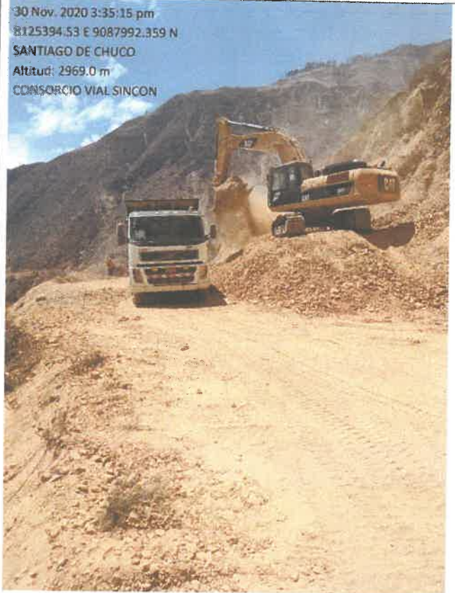
Carguío de material granular desde cantera Km 21+150 9087992N 8125394E
