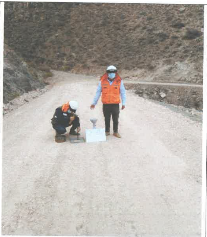
Verificación de la vía, referente al tramo 11, Km 23+000, junto con personal técnico encargado de los estudios de campo. 9087369N 812566E
