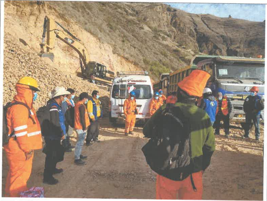
Charlas diarias, referente al tramo 11, Km 23+500 9087096N 812499E
