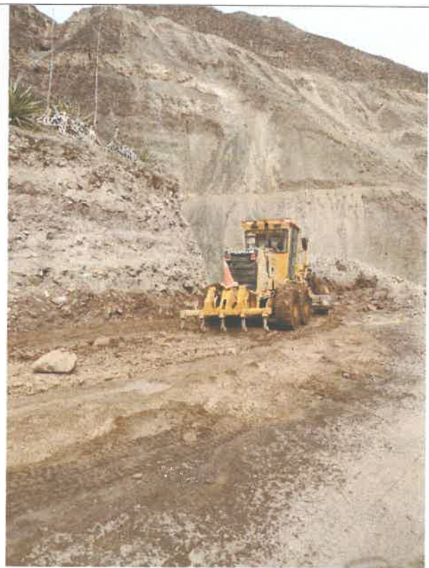
Escarificado de plataforma para el proceso constructivo colocación de material granular de cantera e=0.15m, km 23+500 9087721N 812520E
