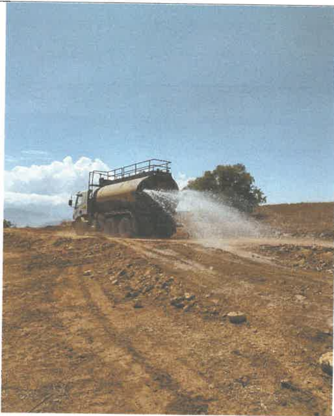
Proceso constructivo, Riego de la plataforma en el , km 24+500 9086367N 812788E
