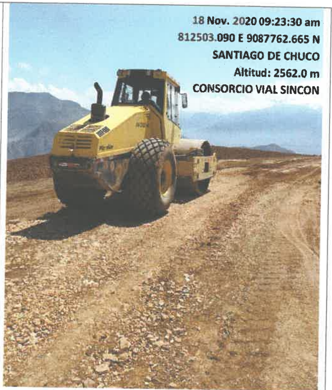
Proceso constructivo, Compactación en plataforma, km 22+100 9087762N 812503E
