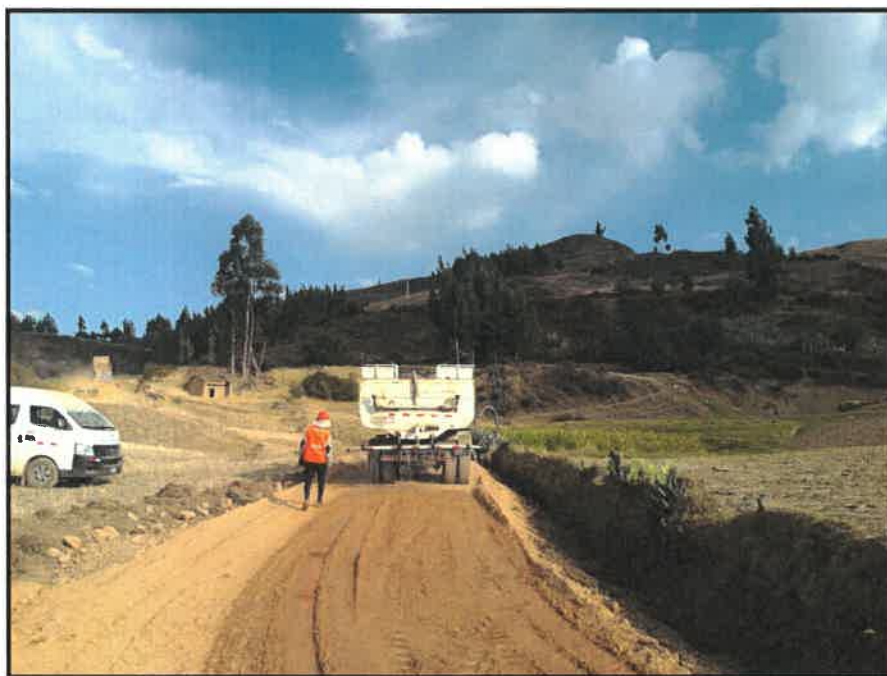
RIEGO DE VÍA - KM 1+400 (LEV. OBS.)
