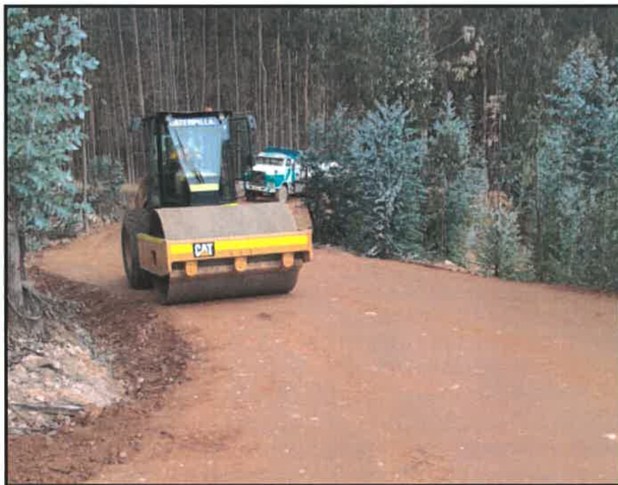
COMPACTADO DE VÍA KM 1+200
