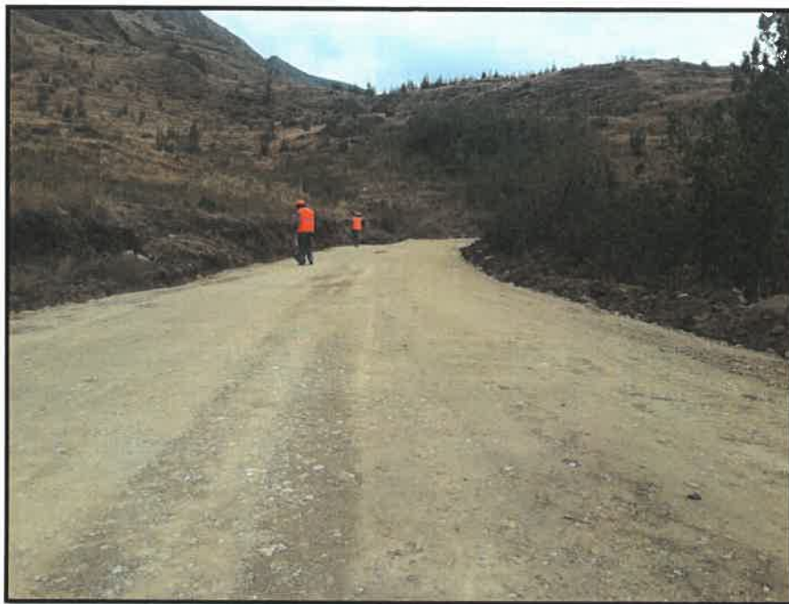
VIA COMPACTADA KM 4+200
