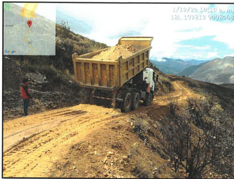
DESCARGA DE MATERIAL KM 5+260
