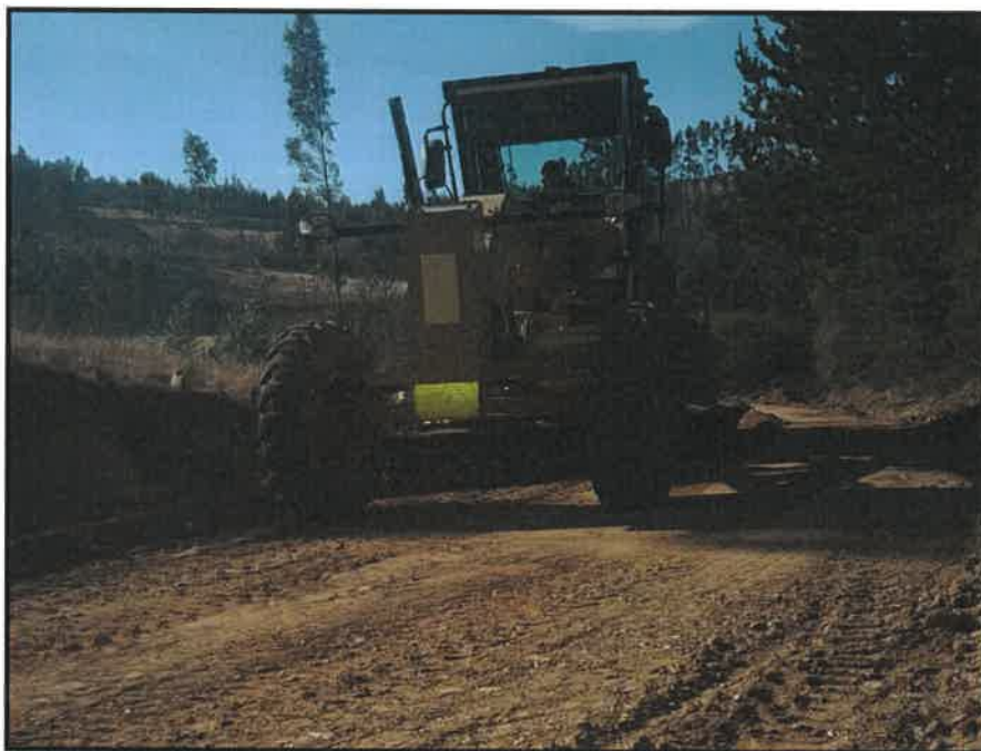
EXTENDIDO DE MATERIAL GRANULAR KM: 1+800
