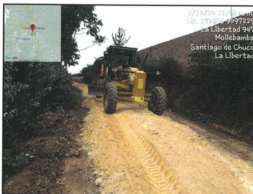
EXTENDIDO DE MATERIAL GRANULAR KM 5+200
