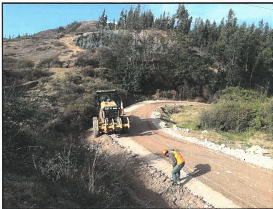
TRAMO LAS PIEDRAS KM: 3+300
