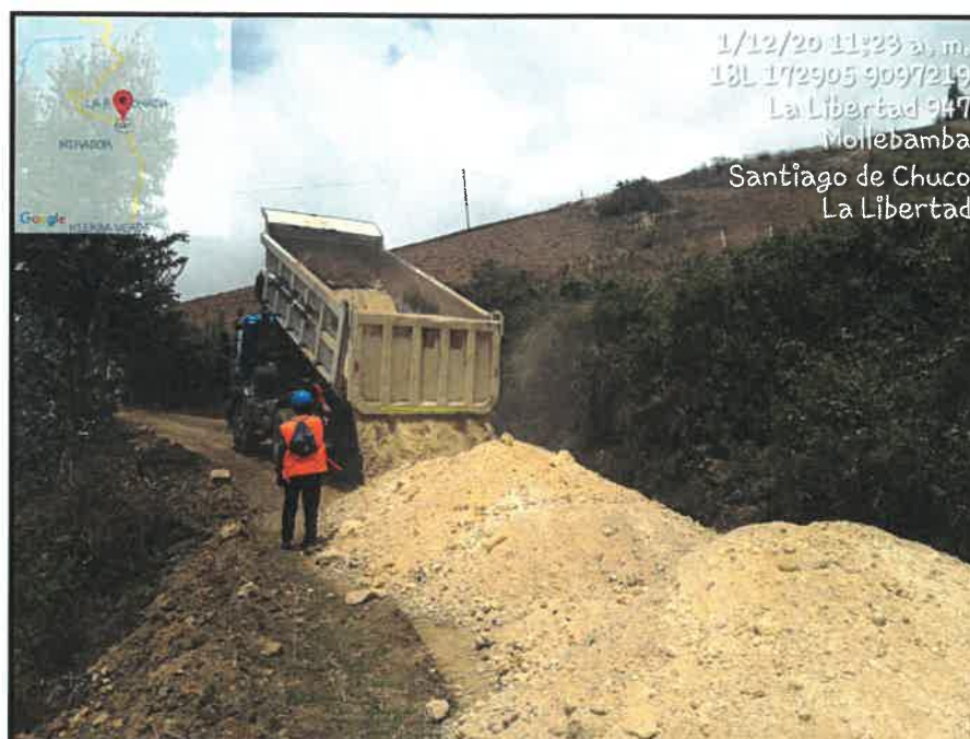
DESCARGA DE MATERIAL KM 2+000
