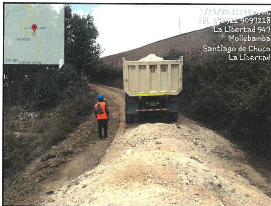
DESCARGA DE MATERIAL KM 7+100
