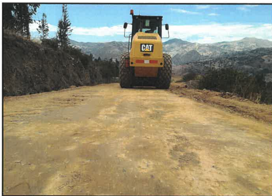
COMPACTADO DE VÍA - KM: 1+600 (LEV. OBS.)
