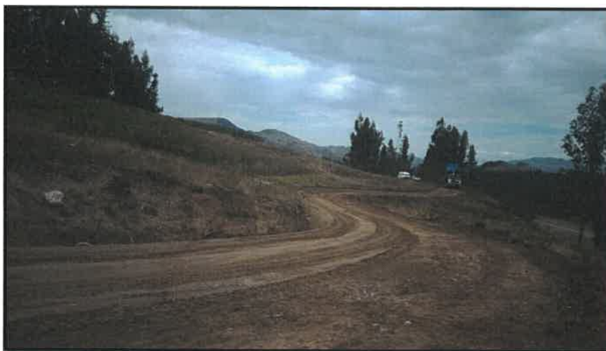
ACARREO Y DESCARGA DE MATERIAL - KM: 2+000
