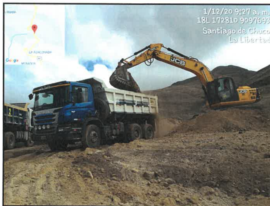
CARGUIO DE MATERIAL CANTERA KM 4+000
