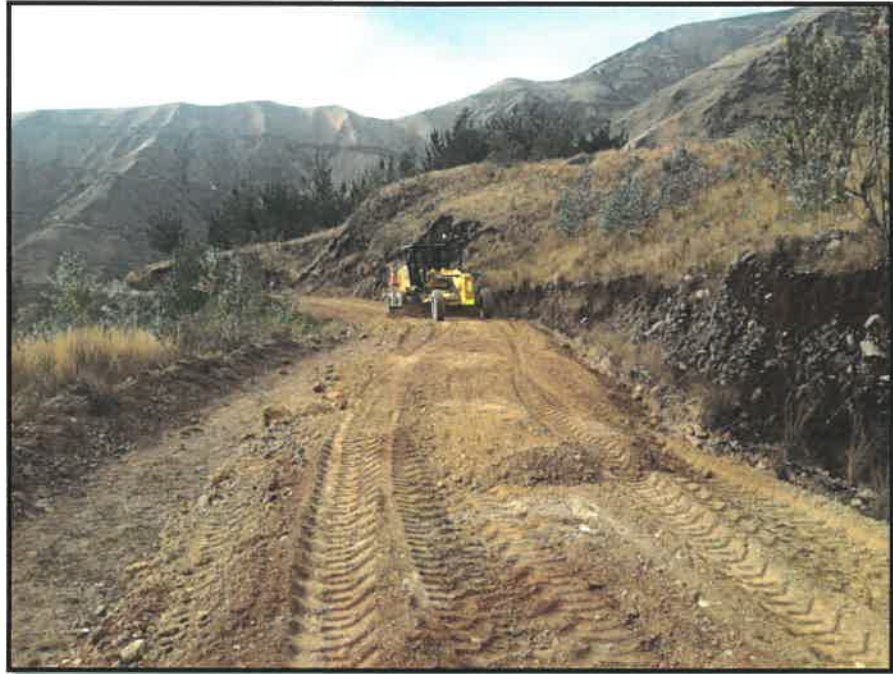
EXTENDIDO Y CONFORMADO DE MATERIAL GRANULAR E=0.15 M - KM: 6+800
