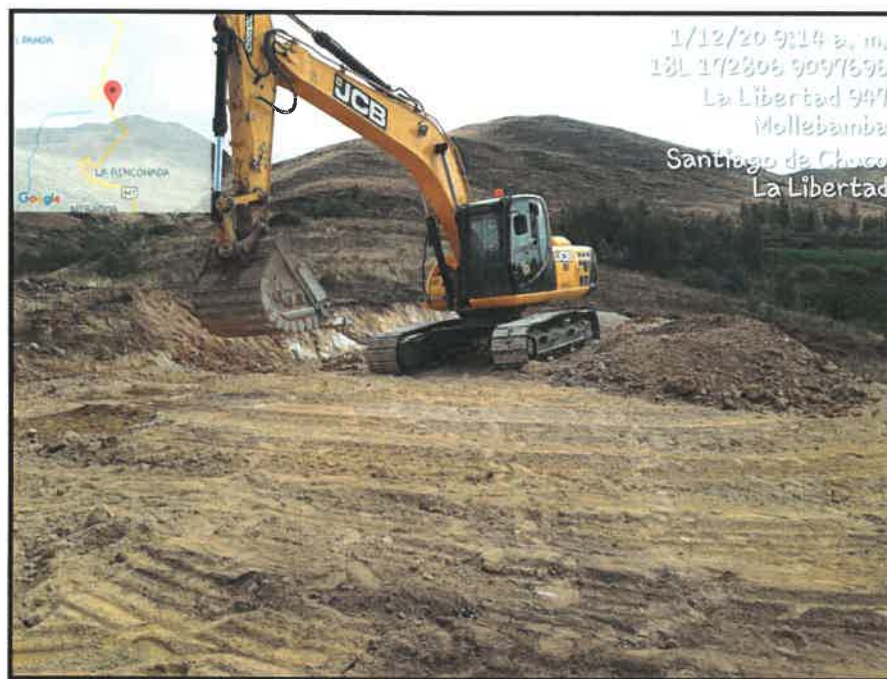
CORTE Y ACOPIO DE MATERIAL EN CANTERA KM 4+000
