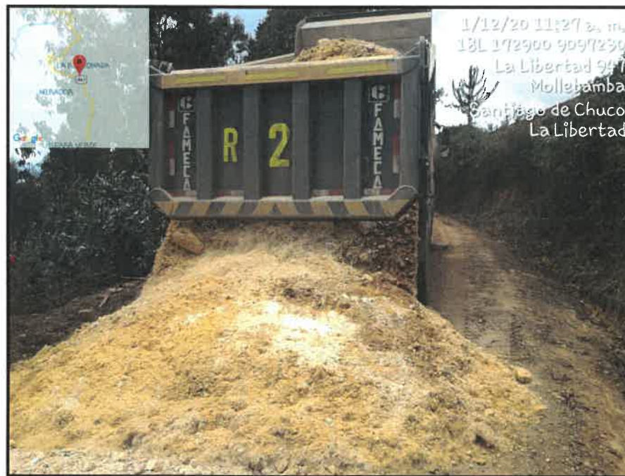
DESCARGA DE MATERIAL KM 3+100
