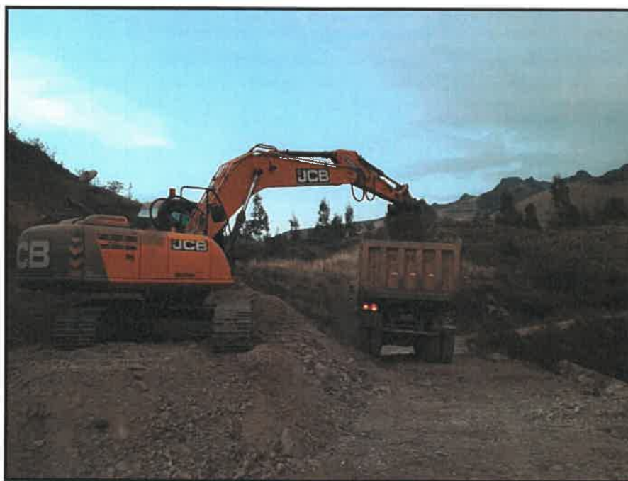
CARGUÍO DE MATERIAL GRANULAR
