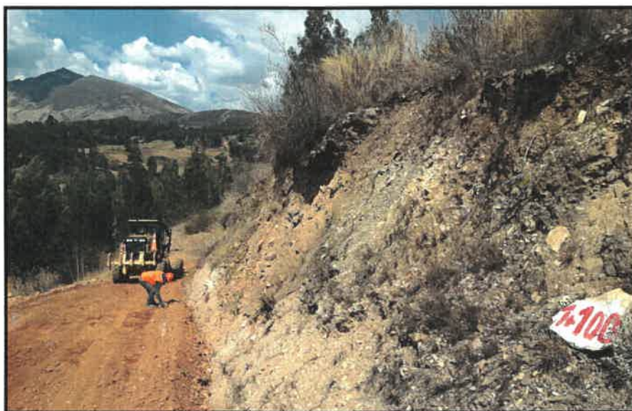
EXTENDIDO DE MATERIAL GRANULAR E=0.15 - KM 1+100 (LEV. OBS.)
