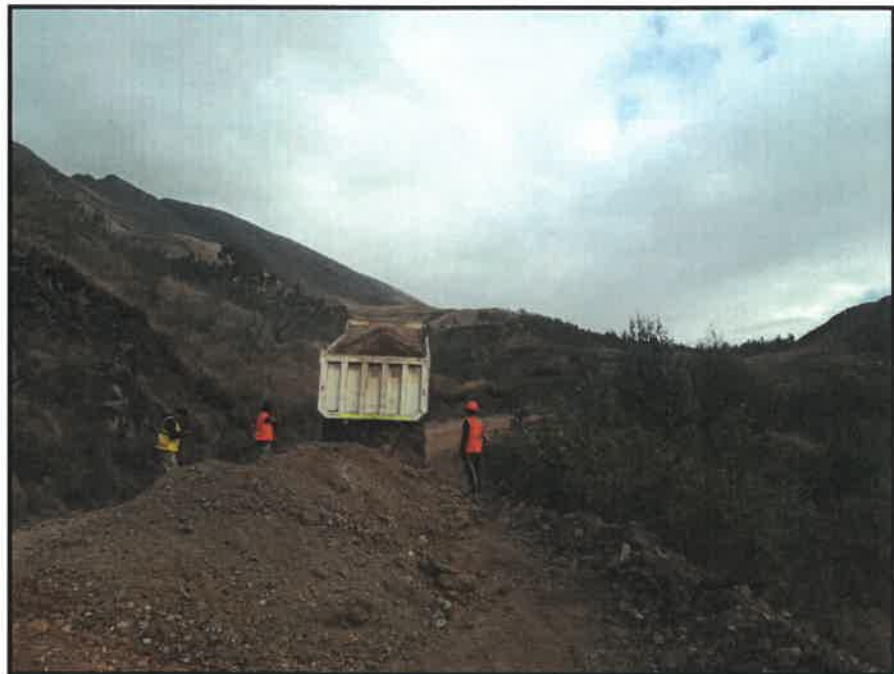
DESCARGA DE MATERIAL GRANULAR KM 5+200
