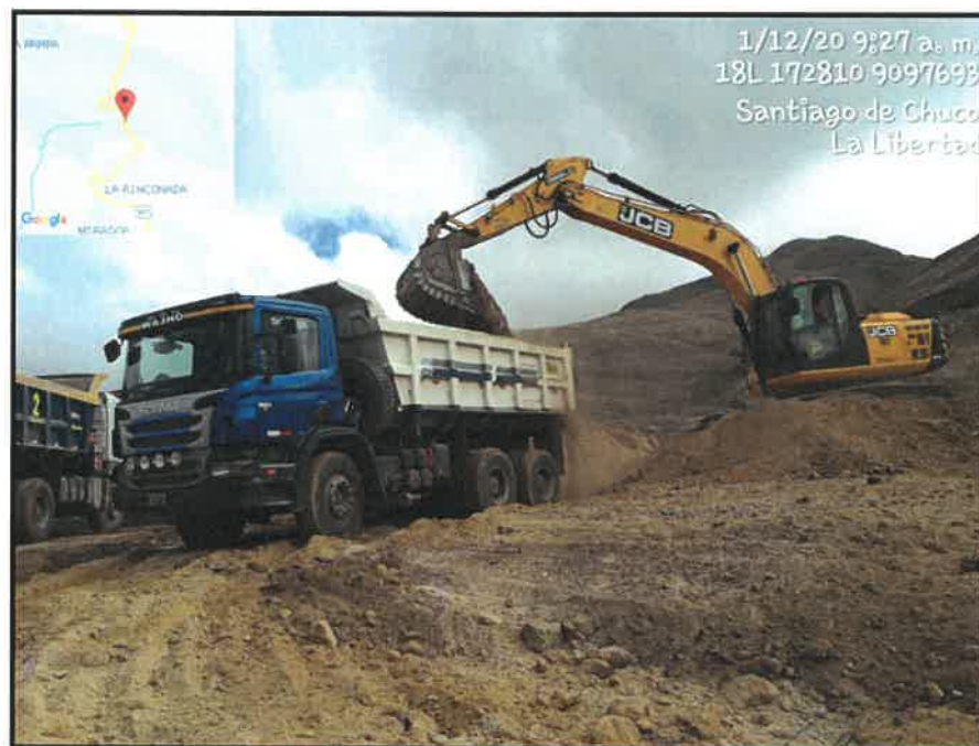
CARGUIO DE MATERIAL GRANULAR
