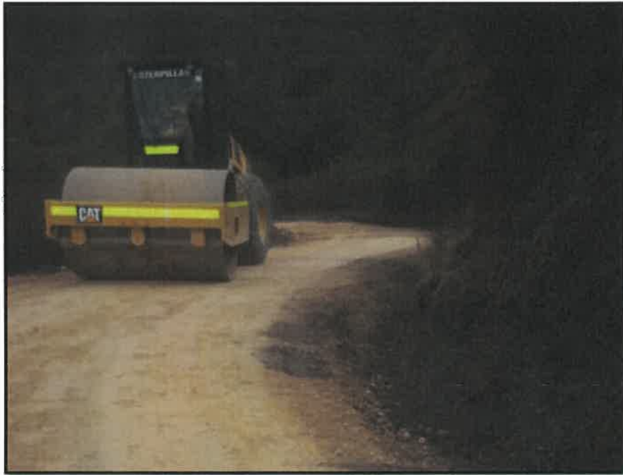
COMPACTADO DE VÍA - KM 0+600
