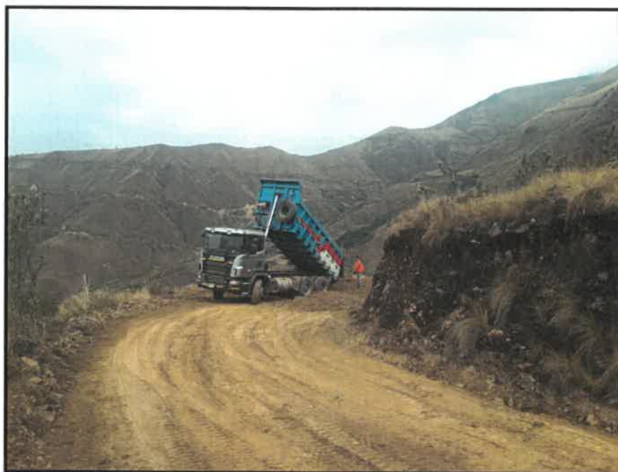
DESCARGA DE MATERIAL GRANULAR KM 7+100
