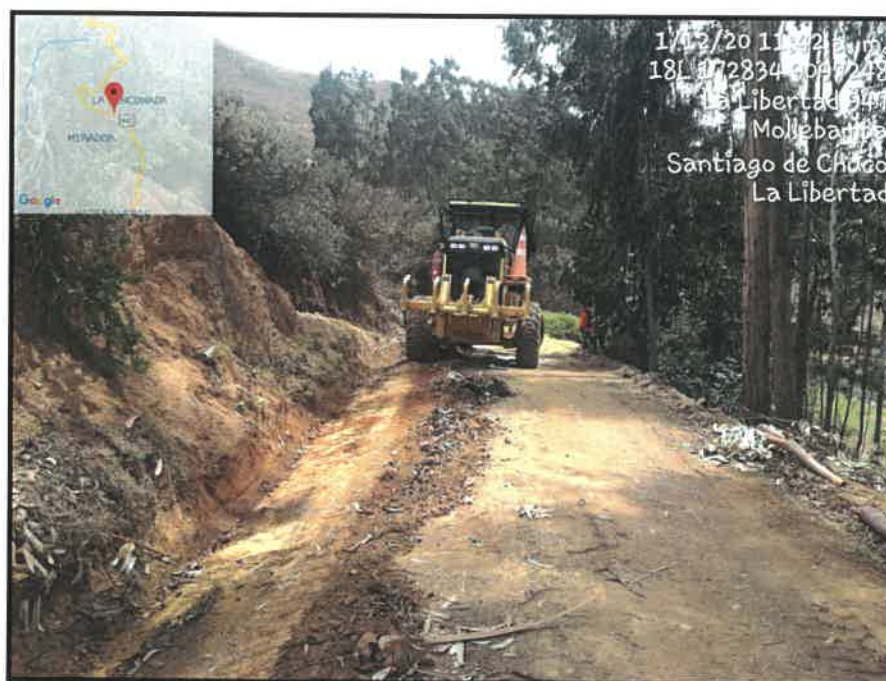
RECONFORMACIÓN DE CUNETAS KM 4+300
