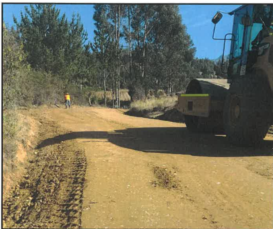
COMPACTADO DE VÍA KM 1+500
