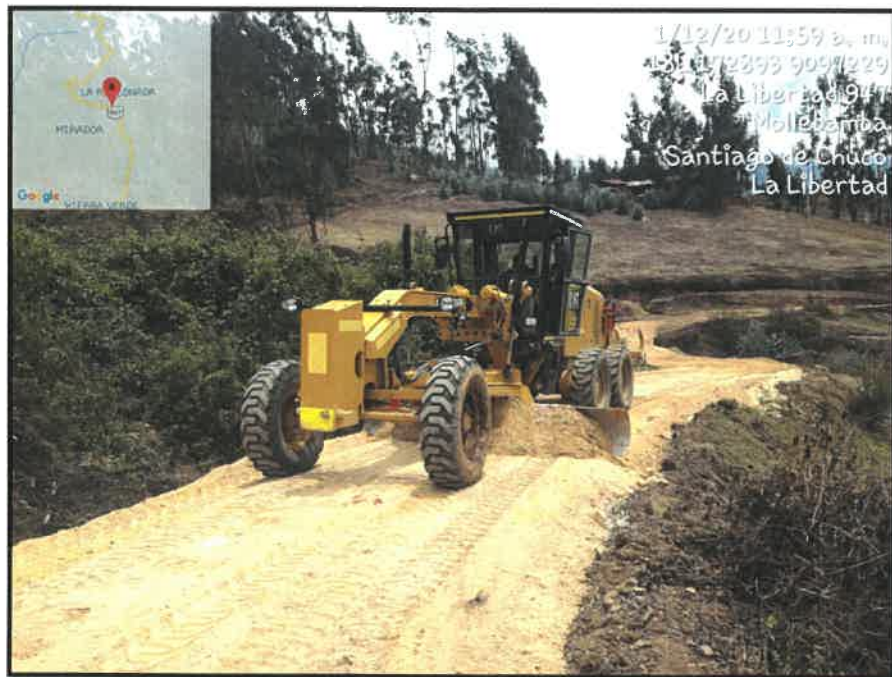
CONFORMACIÓN DE MATERIAL GRANULAR KM 3+400
