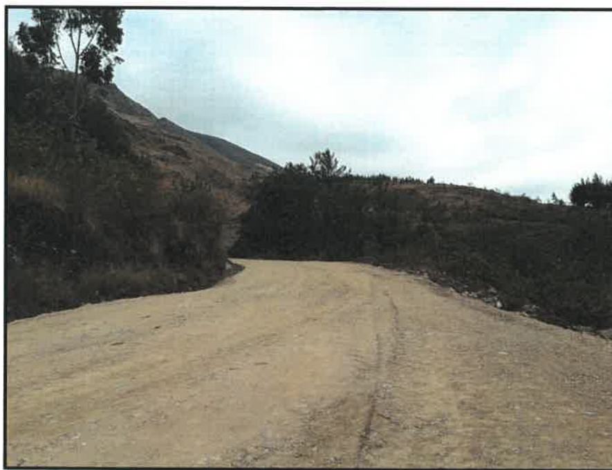
VIA COMPACTADA KM 2+100
