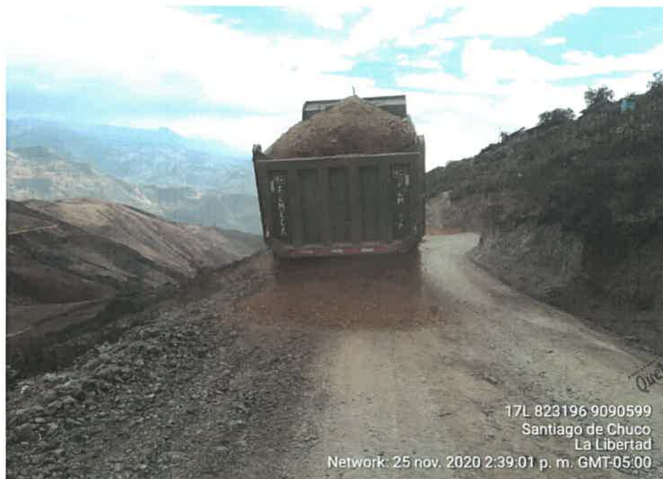
Foto N° 04: Se observan trabajos de transporte y descarga de material granular hasta 1 km
