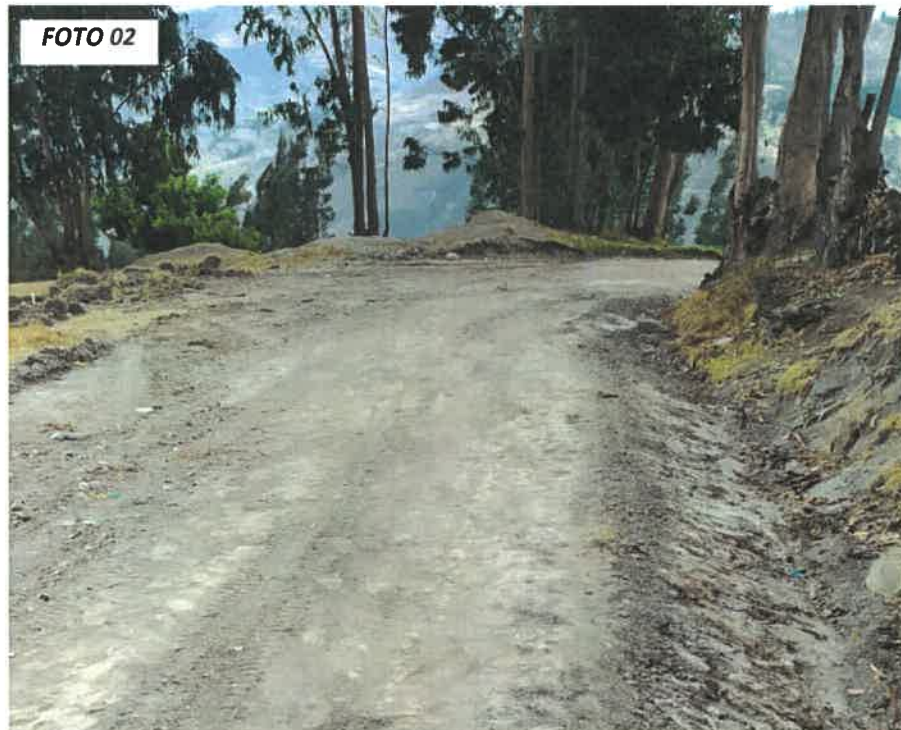
FOTO 02: SE OBSERVA LOS TRABAJOS EN LA CAPA NIVELANTE, KM 6+000-7+000
