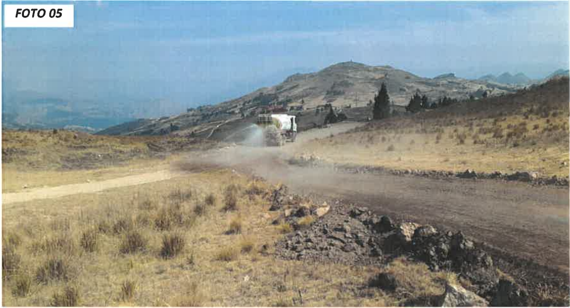
FOTO 05: RIEGO DE LA VIA PARA LOS TRABAJOS POSTERIORES
