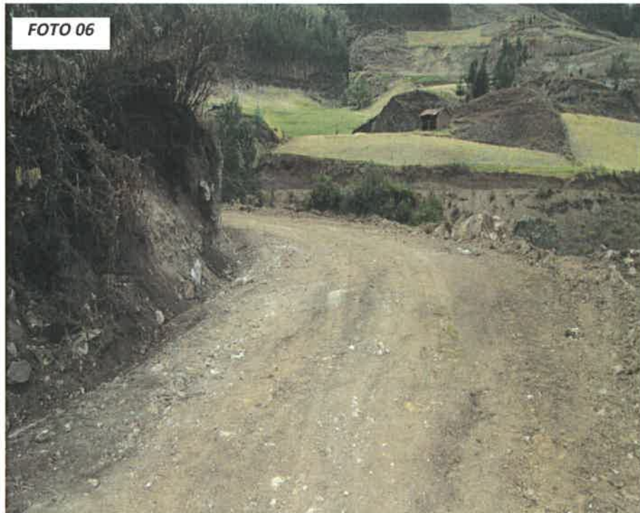
FOTO 06: FOTO 02: SE OBSERVA LOS TRABAJOS EN LA CAPA NIVELANTE, KM 7+000-8+000
