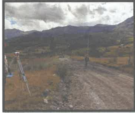
FOTO N°02 – NIVELACIÓN EN SUBRASANTE
