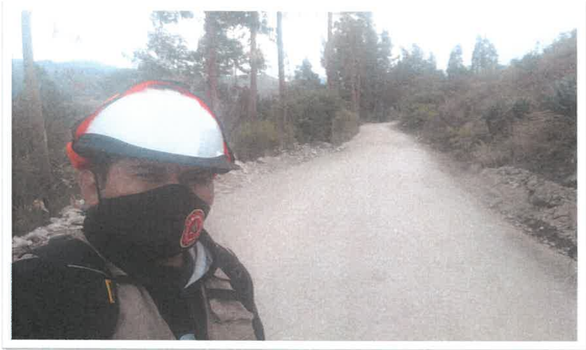
foto 07: verificación de compactado en base.
