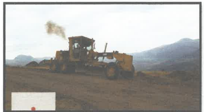
FOTO N° 12 – CONFORMACIÓN DE CUNETAS
