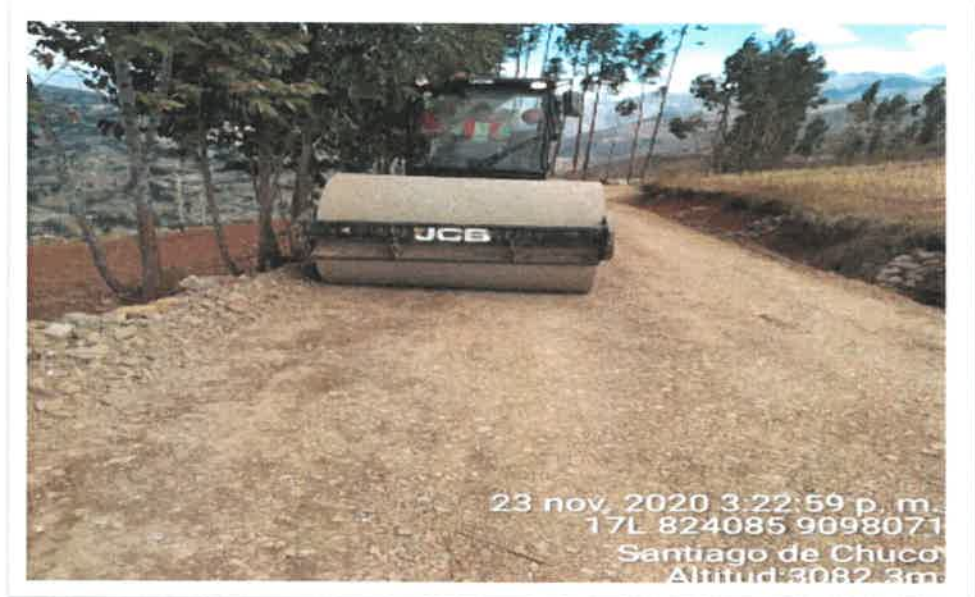
foto 05: nivelado y perfilado de rasante de vía.
