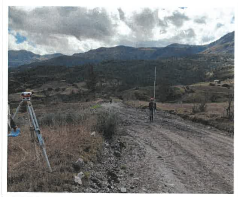
foto 02: nivelación de rasante de vía.
