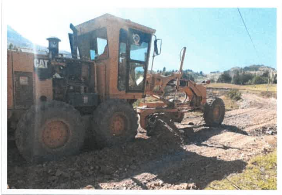
foto 04: material granular para base de vía.
