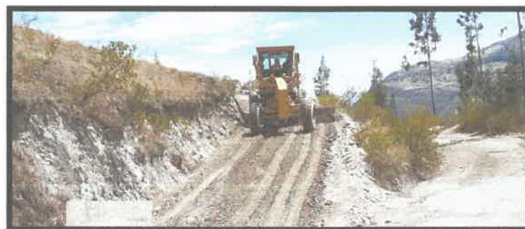
FOTO N° 07 – NIVELACIÓN Y PERFILADO DEL AFIRMADO
