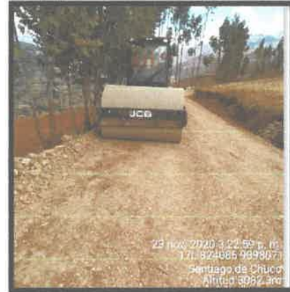
FOTO N° 05 – COMPACTACIÓN DEL AFIRMADO
