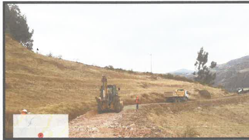
FOTO N° 03 – COLOCACIÓN DE MATERIAL DE AFIRMADO
