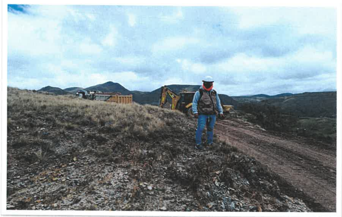
foto 01: inspección de trabajos en campo
