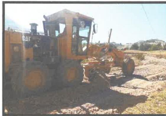
FOTO N° 06 – NIVELACIÓN DEL TERRENO
