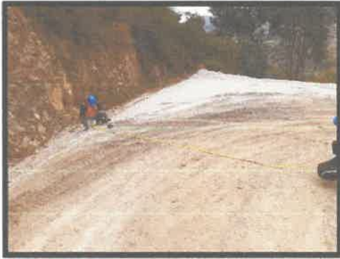
FOTO N°01 – ANCHOS DE VIA
