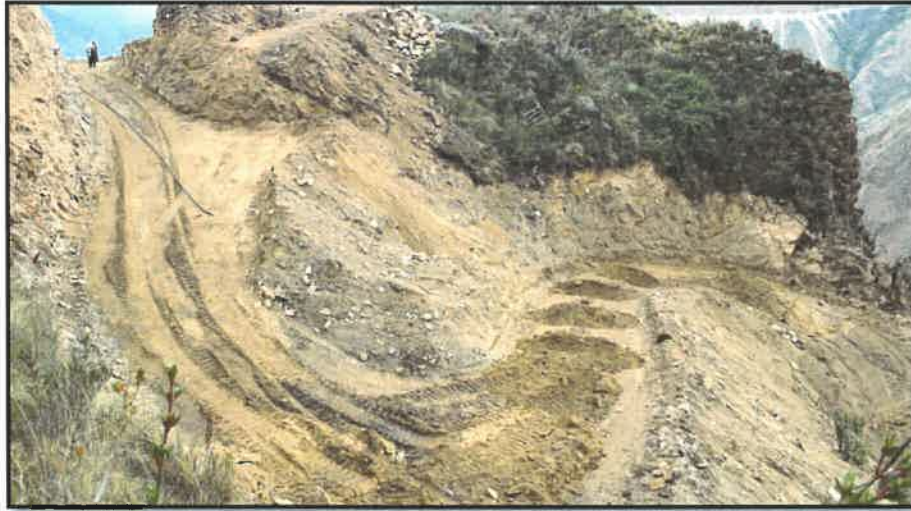
CONFORMACIÓN DE CAPA NIVELANTE – KM 9+100
