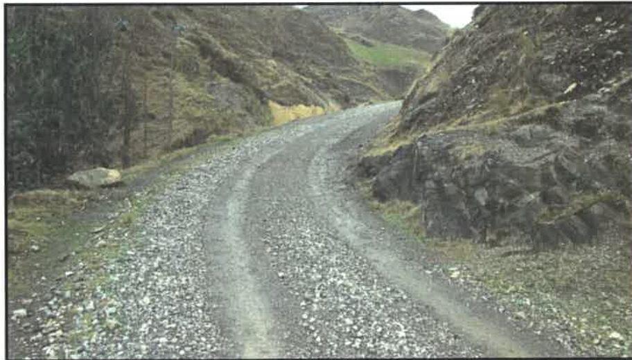
CAPA NIVELANTE KM 2+400
