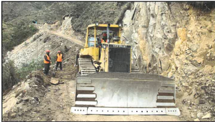
ELIMINACIÓN DE MATERIAL EXCEDENTE – KM 11+100
