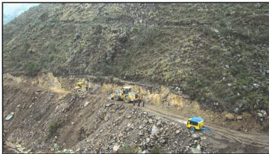
CAPA NIVELANTE – KM 9+800
