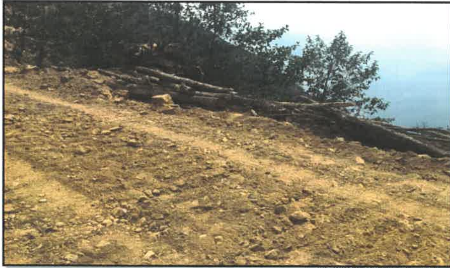
CAPA NIVELANTE KM 0+500
