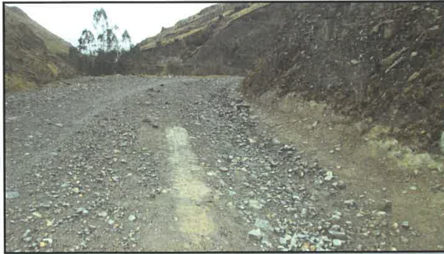
RECONFORMACIÓN DE CUNETAS KM 1+260
