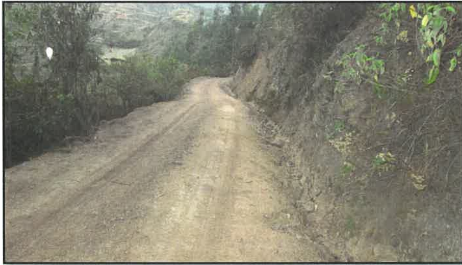
RECONFORMACIÓN DE CUENTAS Y CAPA NIVELANTE - KM 10+900
