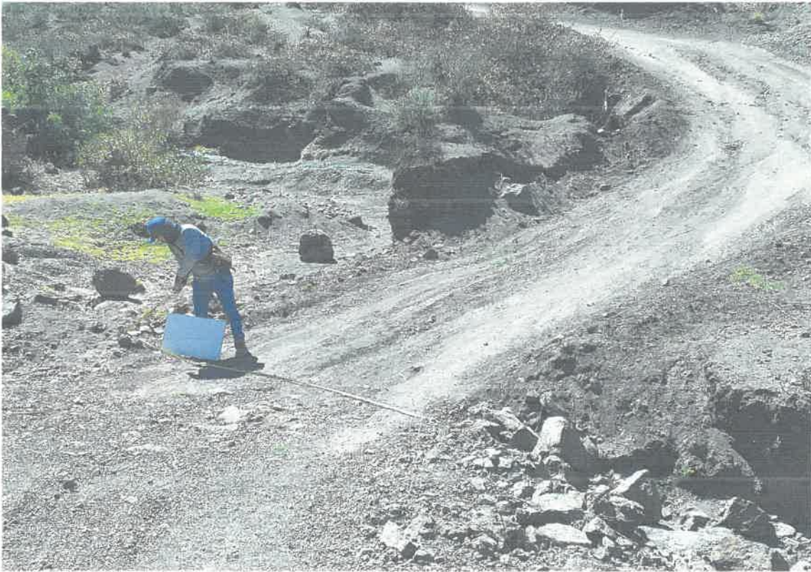
Foto N°02: PROGRESIVA 8+800 EMPALME RED VIAL VECINAL LI 122
