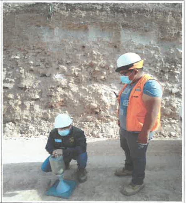
Realización de la prueba de campo junto al técnico encargado En la progresiva 35+250
