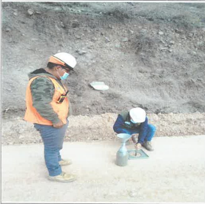
Realización de la prueba de campo junto al técnico encargado En la progresiva 40+000
