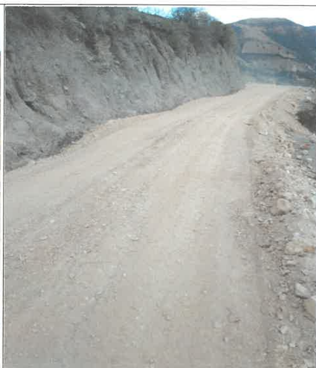
Verificación de la colocación del material granular e=0.15 m, Km 46+700 9082456N 8123457E
