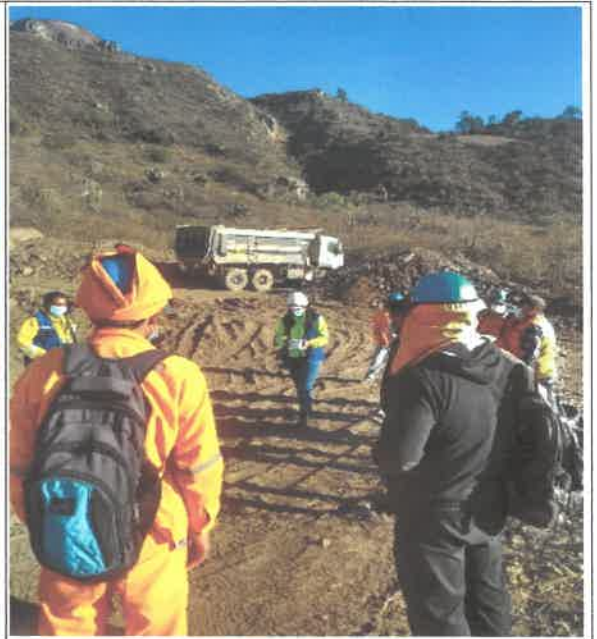
Charlas de Seguridad a cargo de la Ing. de Seguridad en el área de las labores 9085638N 812563E
