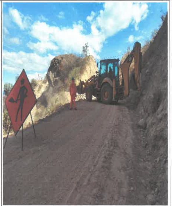
Maestro de obra inspeccionando los trabajos Debidamente uniformado con sus EPPs 9082351N 811234E
