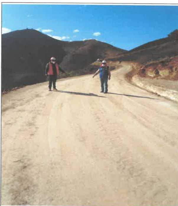
Verificación de la compactación de la plataforma, en el km 33+800 9081245N 813683E
