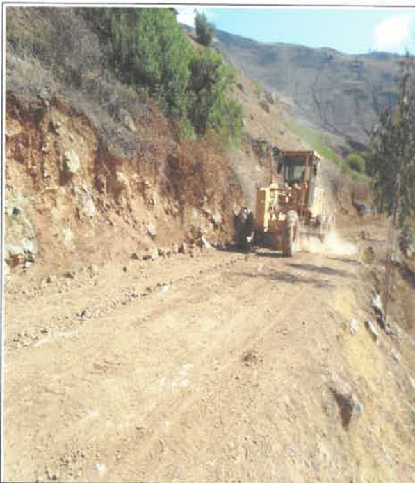
Limpieza de la plataforma en la localidad de Cancate, Casapamba en el km 27+400 9085743N 813832E
