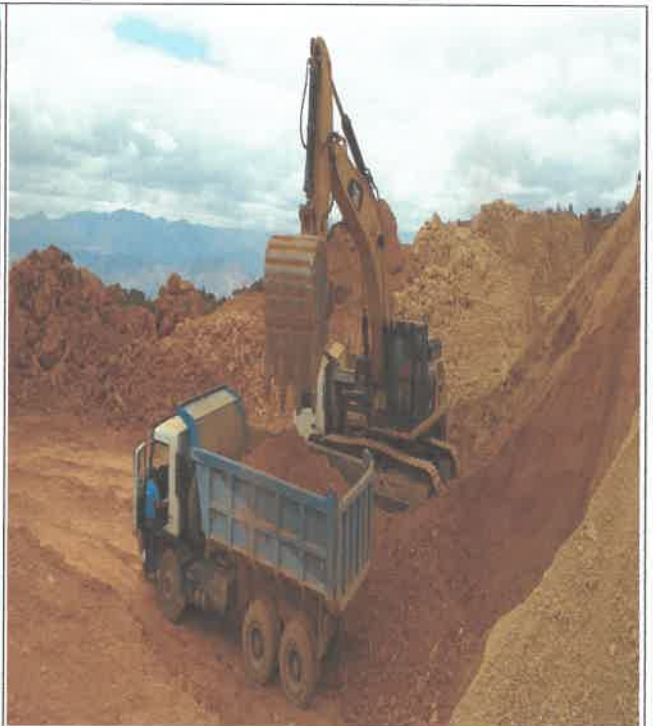
Extracción de material granular de cantera Km 37+900, entre las localidades de Shiracbal y Sincon 9082355N 816547E
