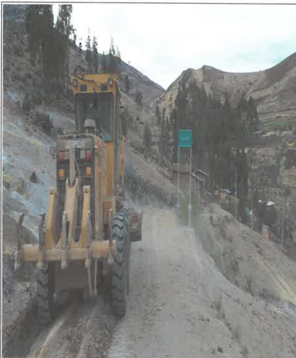
Limpieza de la plataforma en la localidad de Huamada, en el km 25+200 9082351N 811234E
