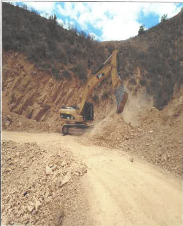
Apilamiento de material granular en Cantera Km 43+200, 9081233N 813493E
