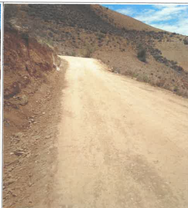
Verificación de la conformación de cunetas en el Km 36+500 9085638N 812563E
