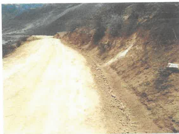
Plataforma terminada con capa de afirmado de 15 cm.
