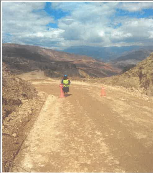
Ubicación de Vigía para inicio de las labores, usando conos de seguridad para detener el flujo vehicular 9083672N 811166E
