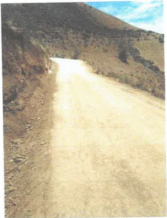
Plataforma terminada con capa de afirmado de 15 cm.
