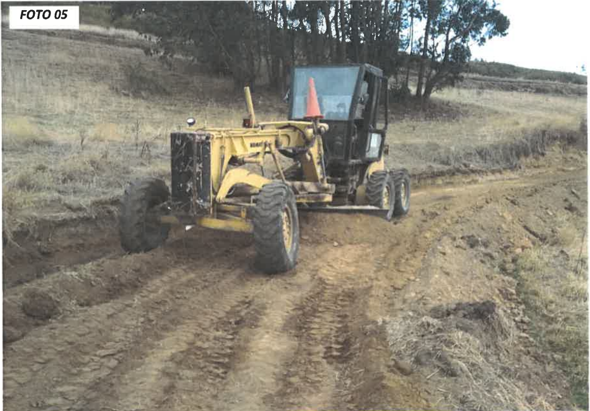
FOTO 05: SE OBSERVA LOS TRABAJOS DE RECONFORMACIÓN DE CUNETAS, TRAMO: CONACHUGO- SANTO DOMINGO
