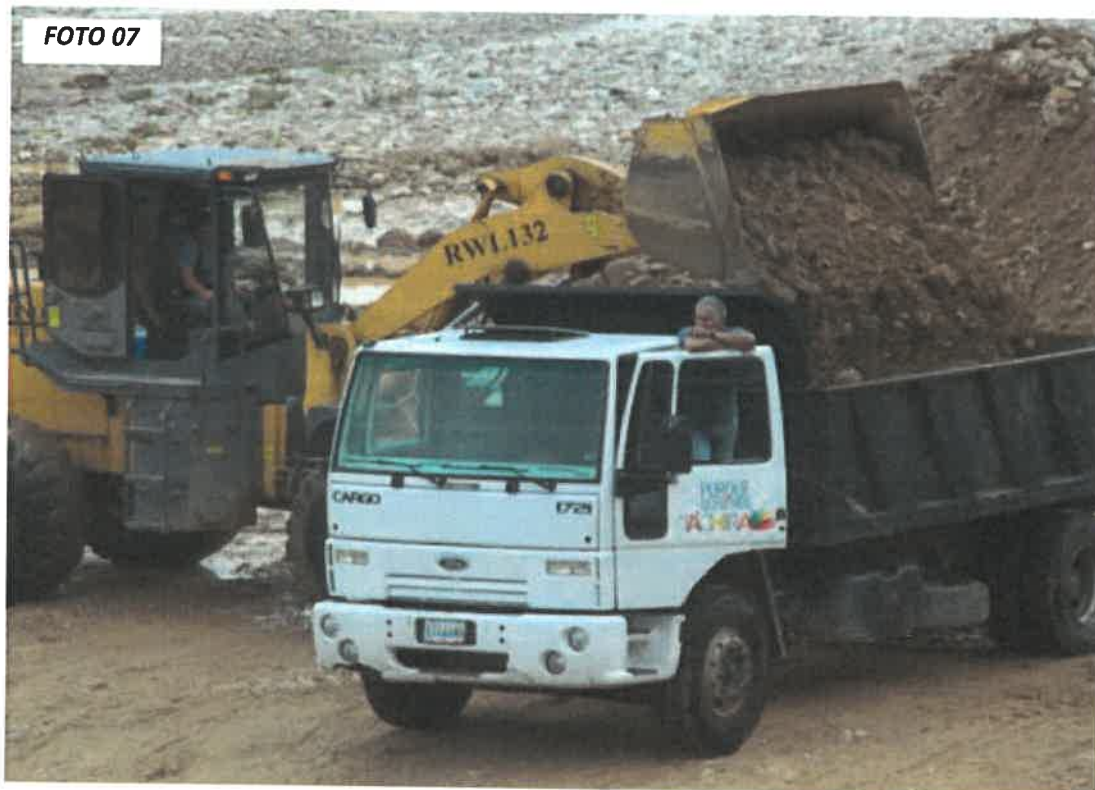
FOTO 07: SE OBSERVA LOS TRABAJOS DE TRANSPORTE DE MATERIAL GRANULAR Y EXCEDENTE, TRAMO: CONACHUGO- SANTO DOMINGO- CANDOGURAN
