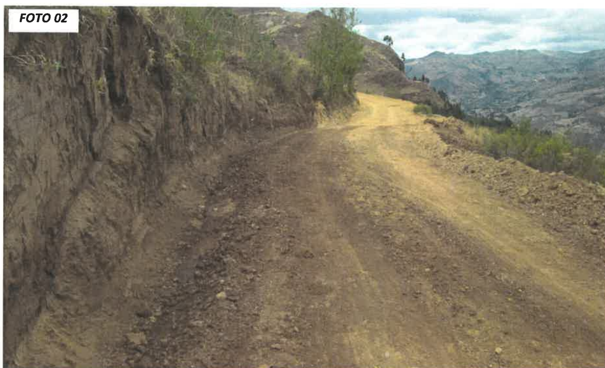
FOTO 02: SE OBSERVA LOS TRABAJOS EN LA CAPA NIVELANTE, TRAMO: CANDOGURAN
