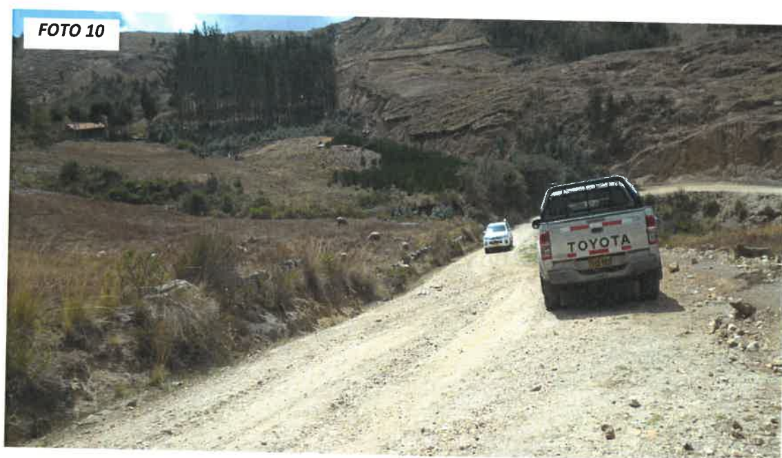
FOTO 10: SE OBSERVA EL DESPLAZAMIENTO PARA EL TRAMO: CONACHUGO- SANTO DOMINGO- CANDOGURAN
