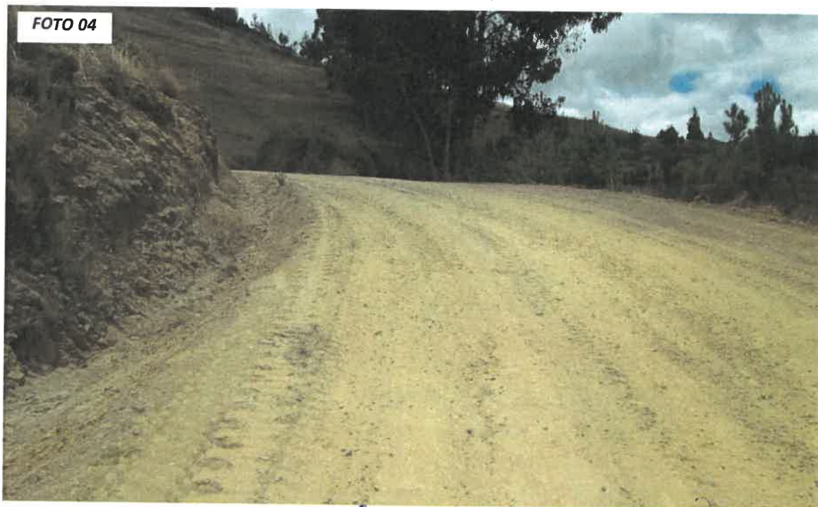
FOTO 04: SE OBSERVA LOS TRABAJOS MATERIAL GRANULAR, TRAMO: CANDOGURAN
