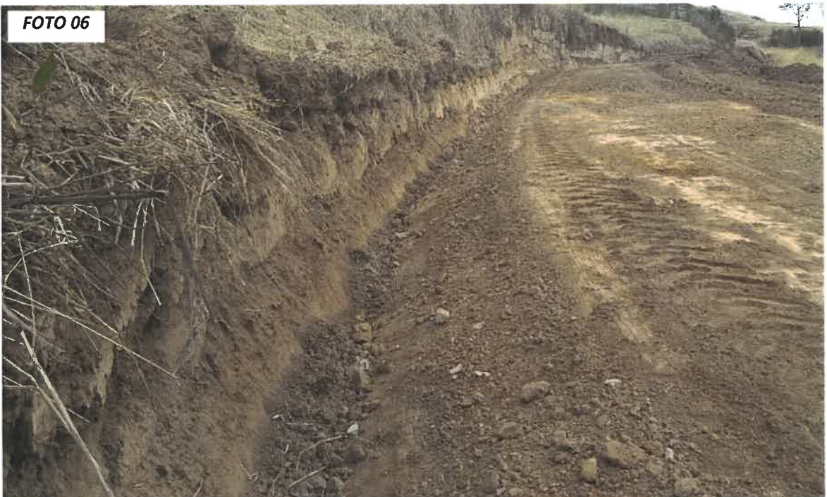
FOTO 06: SE OBSERVA LOS TRABAJOS DE RECONFORMACIÓN DE CUNETAS, TRAMO: CANDOGURAN
