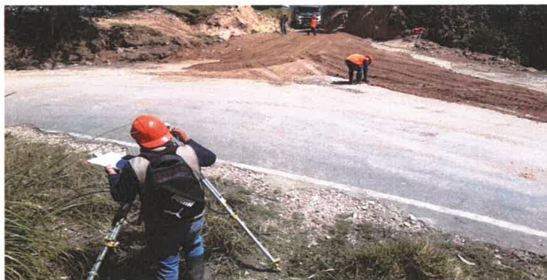
foto 02: nivelación de rasante de vía.
