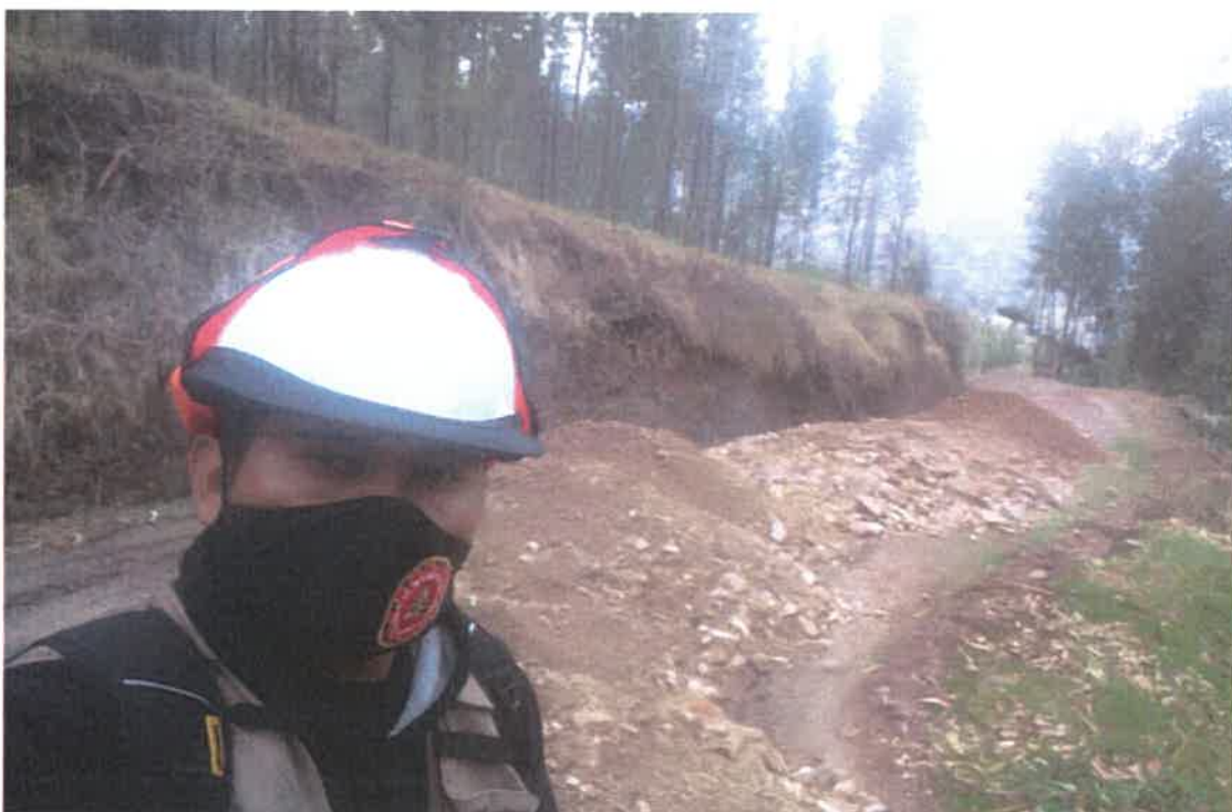
foto 04: material granular para base de vía.
