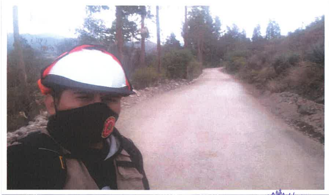
foto 07: verificación de compactado en base.
