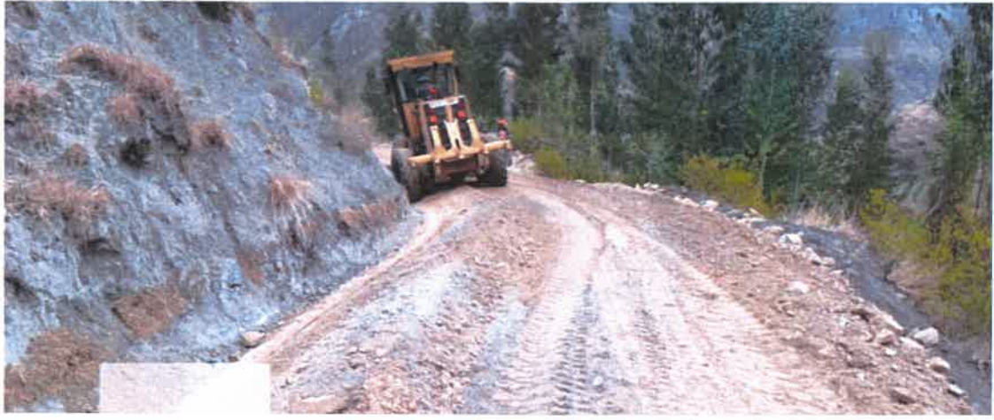
foto 05: nivelado y perfilado de rasante de vía.
