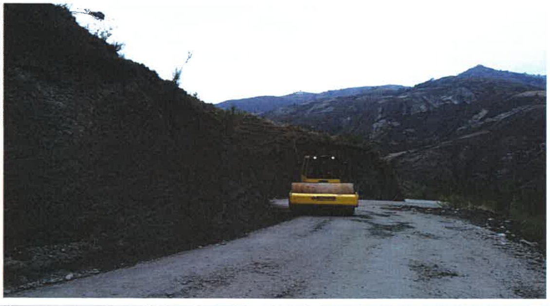
foto 06: compactado de base en vía.
