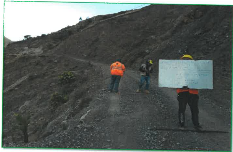
Foto N°03: Se verifica el trazo y replanteo en el Tramo: DV. CHAGAVARA-LA CHIRA-TUTUARCO
