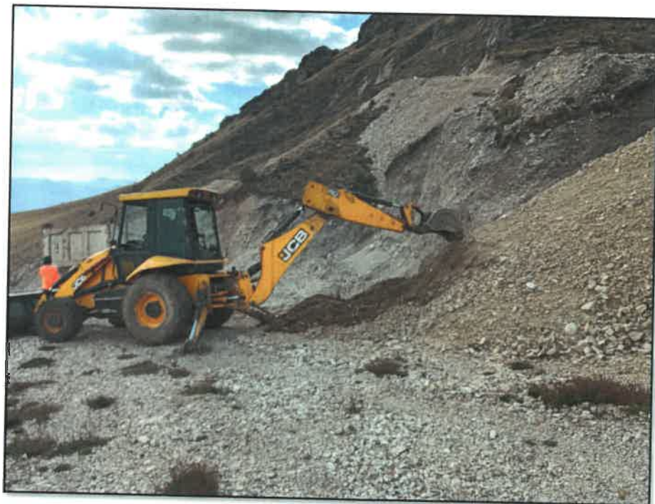
MOVILIZACIÓN DE MAQUINARIA TRAMO: SITABAMBA - UCHUCUBAMBA - QUINUAL
