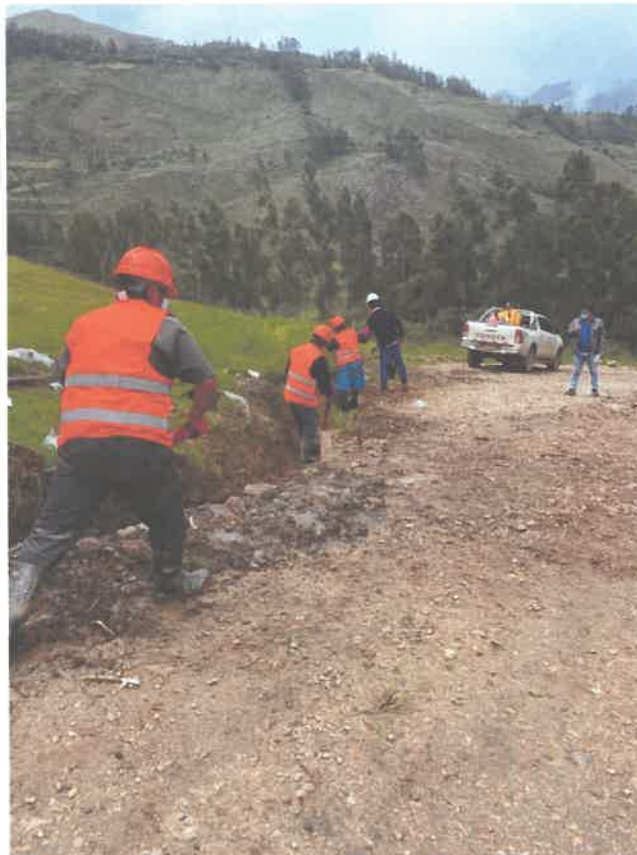
Fig. 01 LIMPIEZA DE OBRAS DE DRENAJE - Limpieza de cunetas
