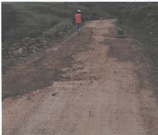
Fig. 01 CONSERVACION DE CALZADA
