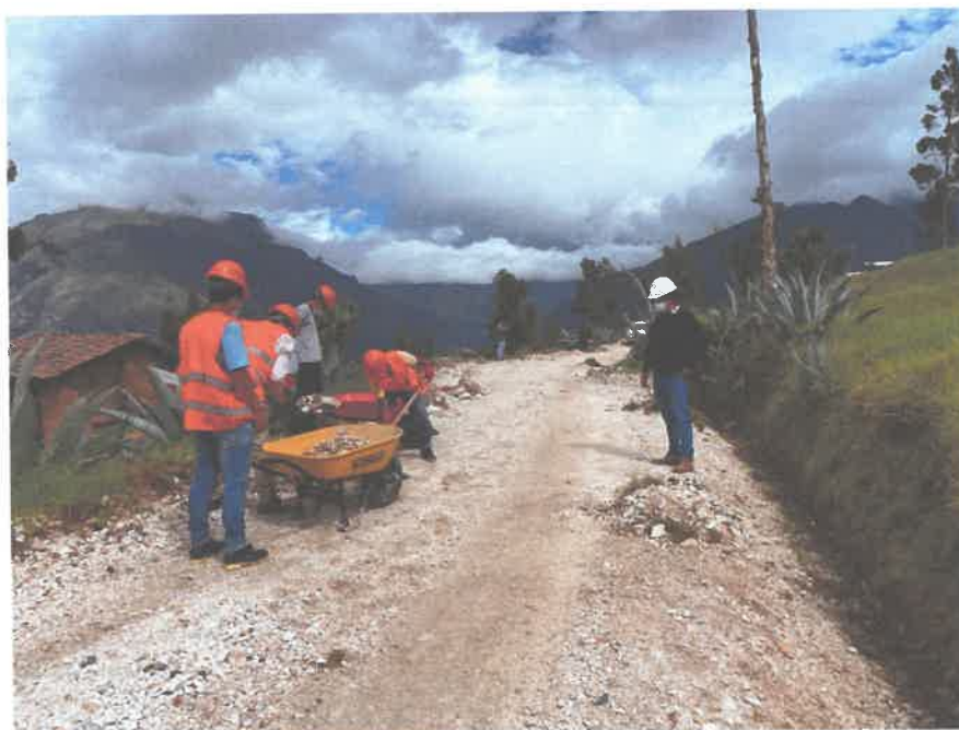
Fig. 03 CONSERVACION DE CALZADA
