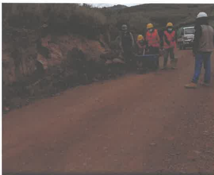
Fig. 02 LIMPIEZA DE OBRAS DE DRENAJE
