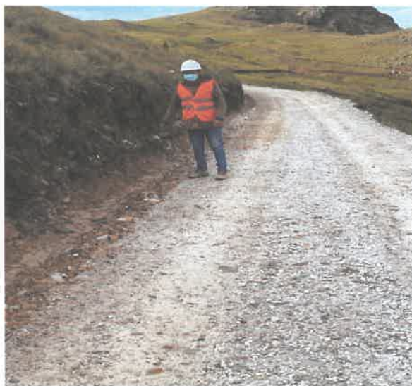
LIMPIEZA DE DRENAGE
