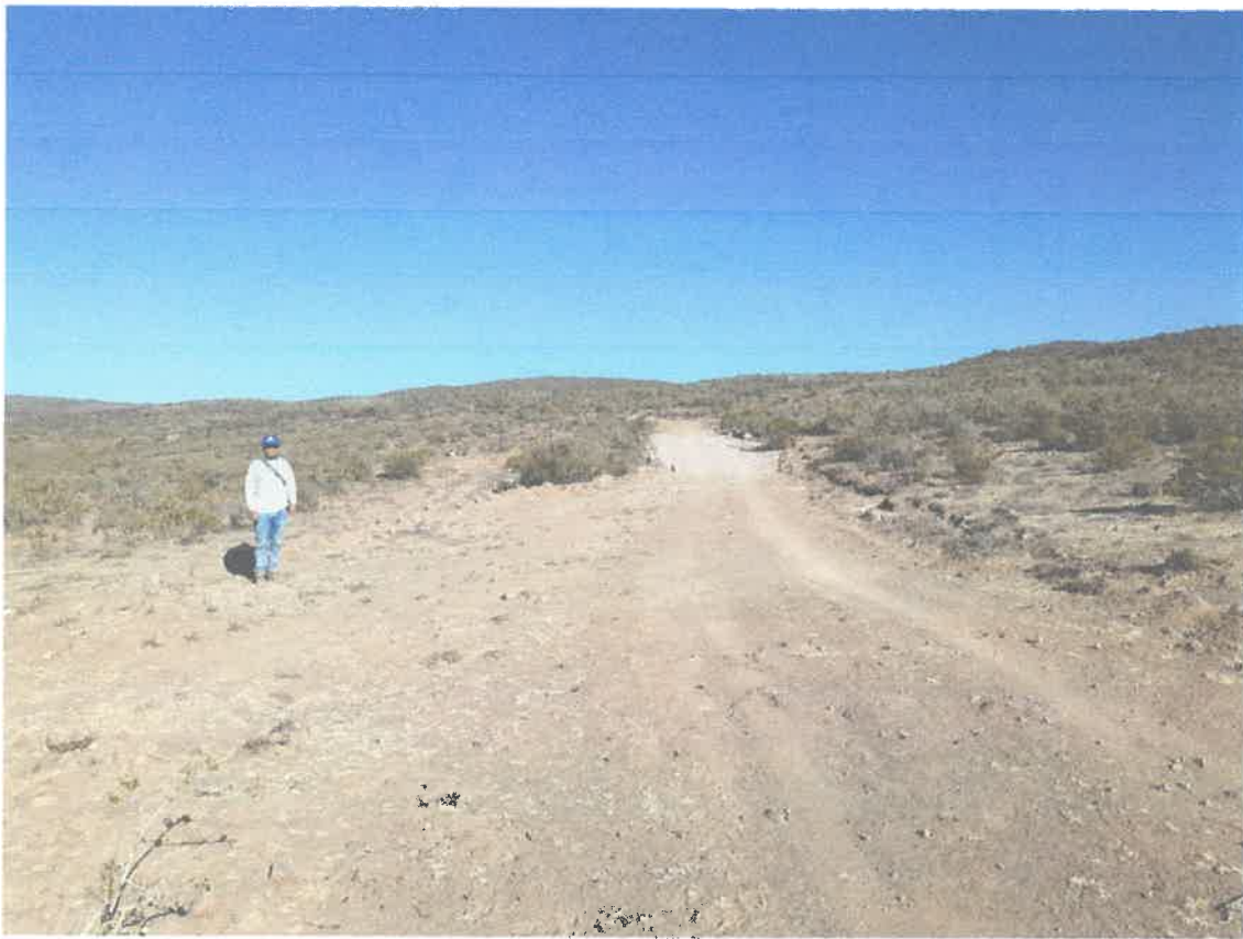
Foto N°02: PROGRESIVA 14+350 EMPALME RED VIAL VECINAL LI 122
