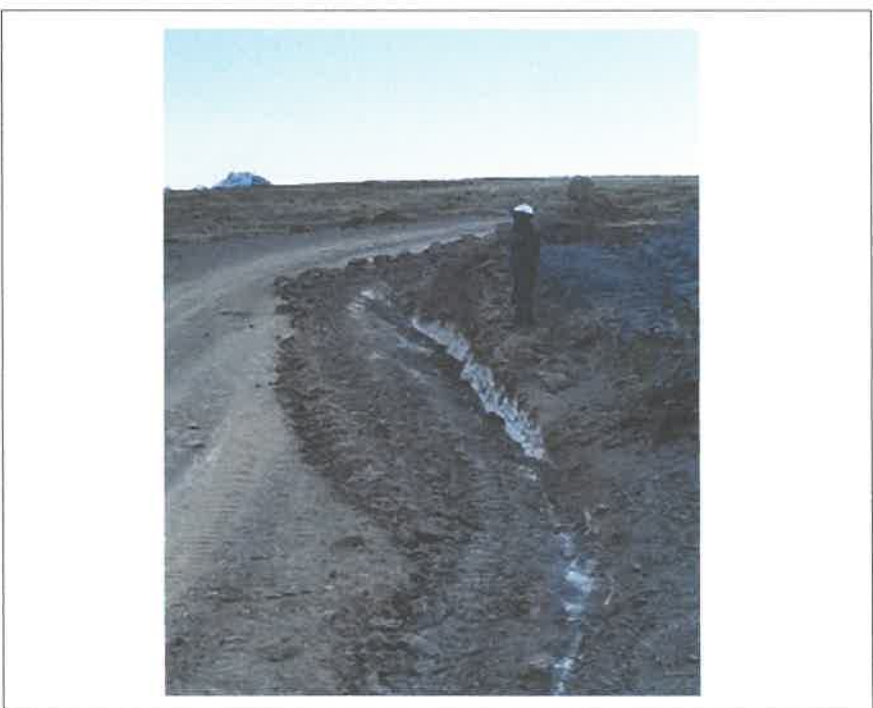
Fig. 17 Reconstrucción de cunetas (17L 788254E 9072468N) Alt. 3258.00m
