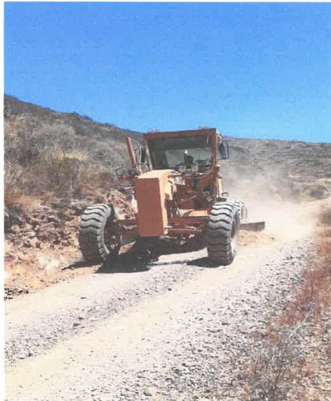
Fig. 06 Colocación de capa nivelante = 0.05m (17L 788274E 9075891N) Alt. 3268.00m
