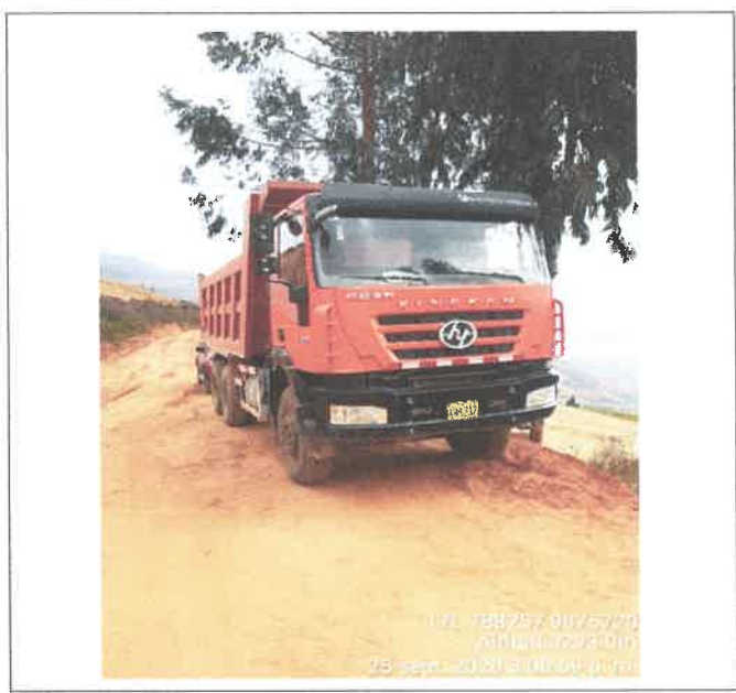
Fig. 15 Transporte de material granular (17L 788257E 9075720N) Alt. 3293.00m
