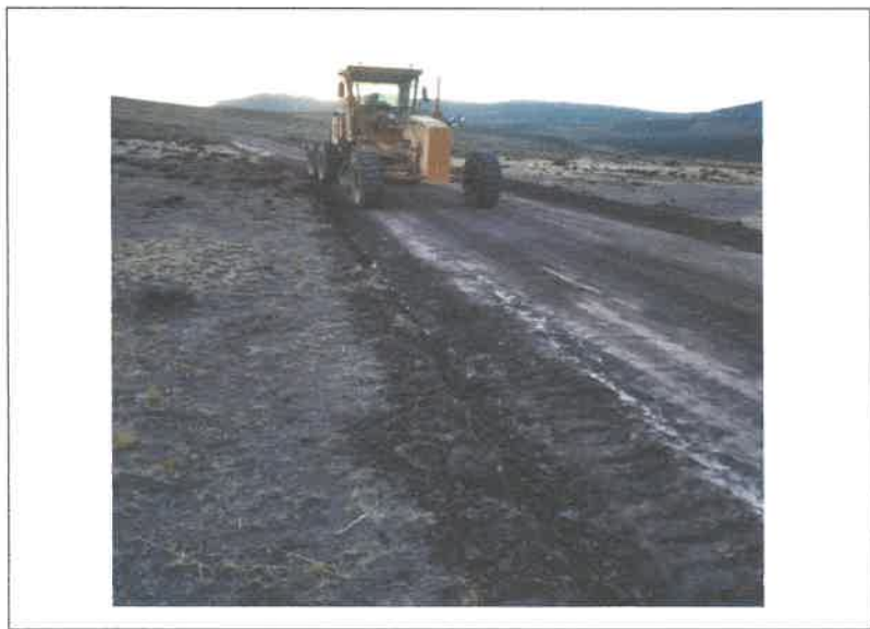
Fig. 16 Reconstrucción de cunetas (17L 787956E 9078114N) Alt. 3358.00m
