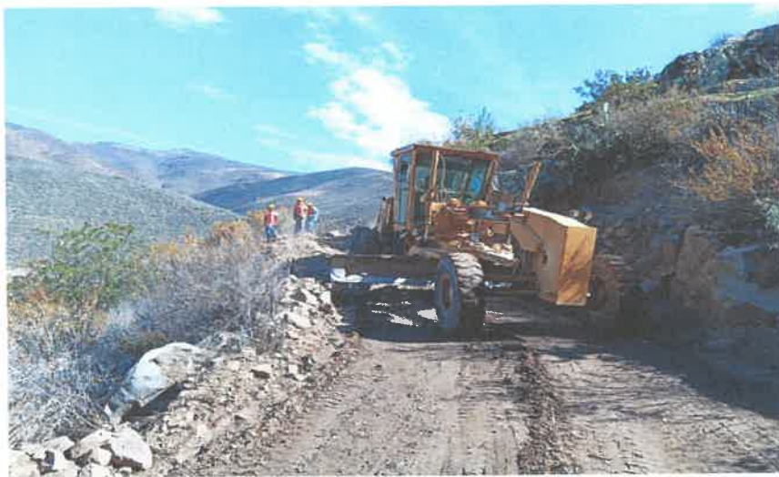
Fig. 10 Nivelación de material granular (17L 788272E 9076489N) Alt. 3386.00m
