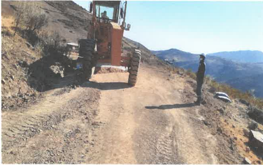
Fig. 05 Nivelación de capa nivelante (17L 788262E 9075680N) Alt. 3289.00m
