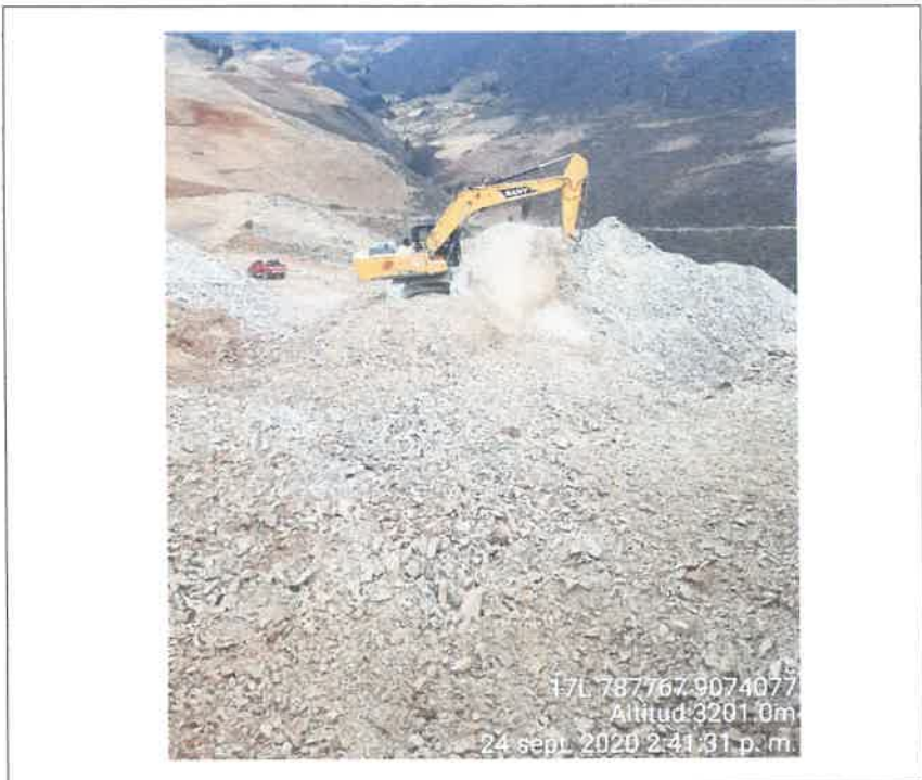
Fig. 07 Extracción, Apilamiento y Acarreo material granular (17L 787767E 9074077N) Alt. 3201.00m
