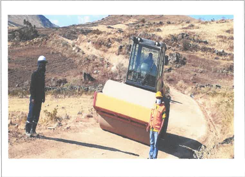
Fig. 13 Compactación de superficie intervenida (17L 7884782E 9078795N) Alt. 3821.00m
