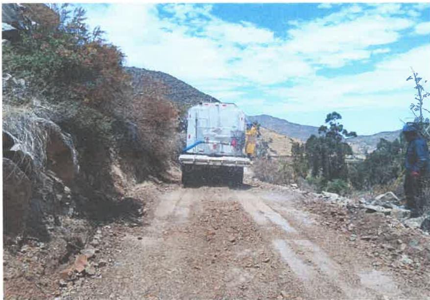
Fig. 12 Riego de tramo a intervenir (17L 788387E 9076784N) Alt. 3287.00m
