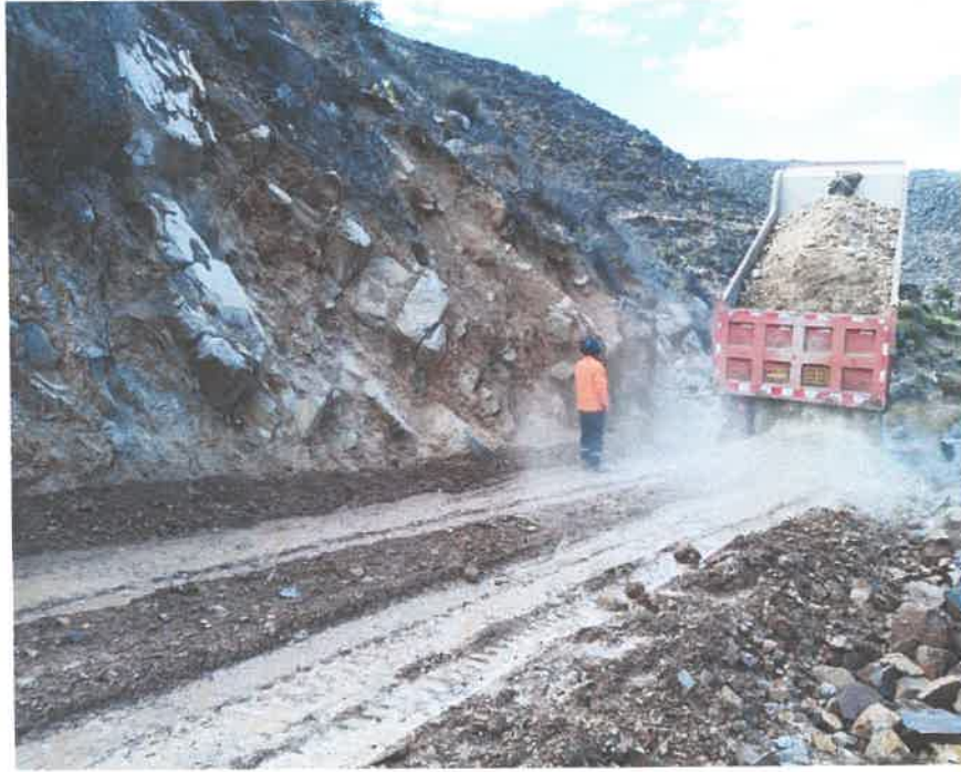
Fig. 09 Colocación de material granular (17L 787528E 9078524N) Alt. 3271.00m
