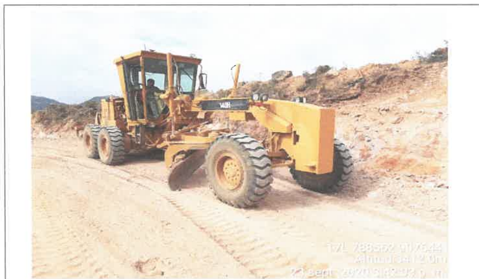
Fig. 04 Colocación de capa nivelante = 0.05m (17L 788262E 9076441N) Alt. 3412.0m
