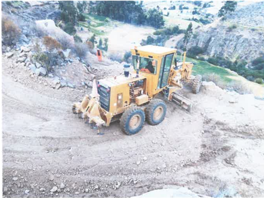
Fig. 11 Nivelación de material granular (17L 788287E 9076506N) Alt. 3385.00m
