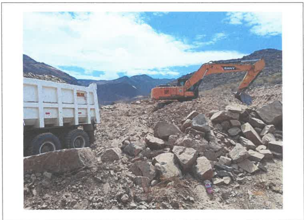
Fig. 14 Carguío y transporte de material granular (17L 787778E 9074061N) Alt. 3202.00m
