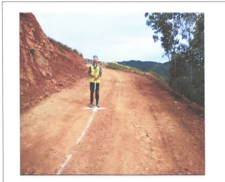
Fig .03 Trazo y replanteo de tramo (17L 788255E 9075717N) Alt. 3296.00m
