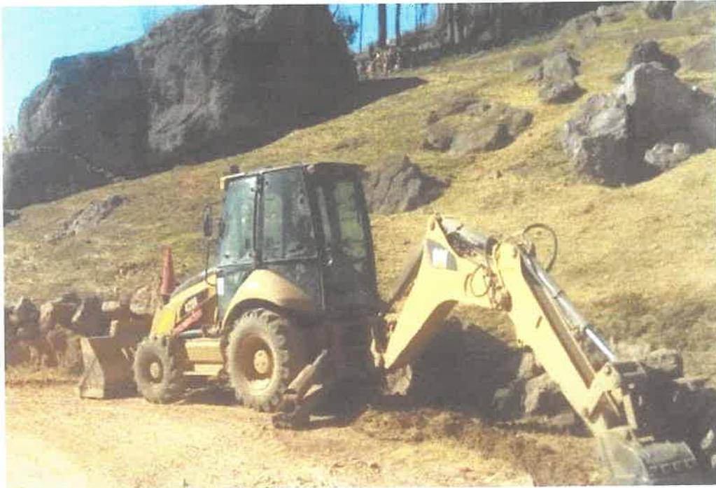
Limpieza de alcantarilla con retroexcavadora
