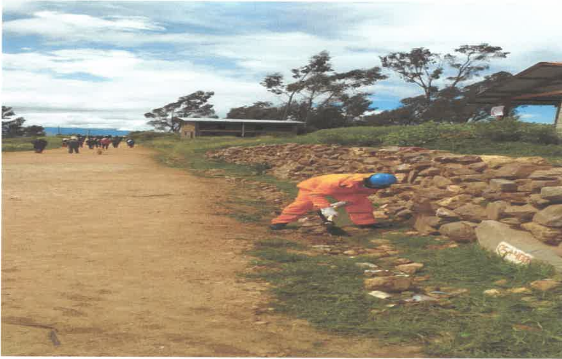
FOTO N° 3: SE OBSERVA LA ACTIVIDAD DE REPARACION DE MUROS SECOS
