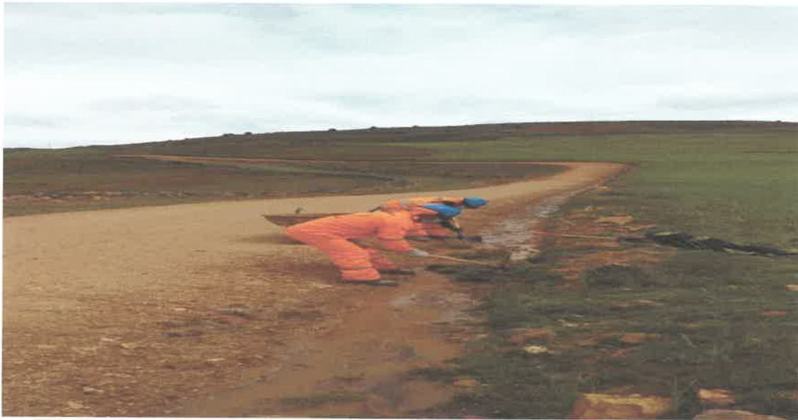
FOTO N°4: SE OBSERVA LA ACTIVIDAD DE LIMPIEZA DE CUNETAS
