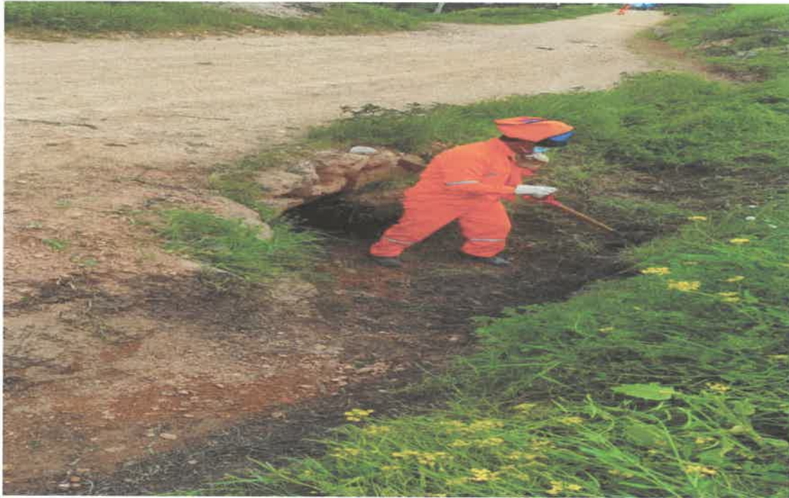
FOTO N° 1: SE OBSERVA LA ACTIVIDAD DE LIMPIEZA DE ALCANTARILLA
