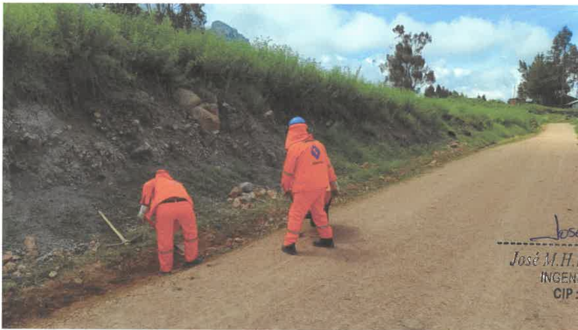
FOTO N° 2: SE OBSERVA LA ACTIVIDAD DE ROCE Y LIMPIEZA
