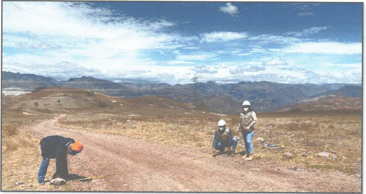
Foto N°05: Verificando el ancho de la vía.
