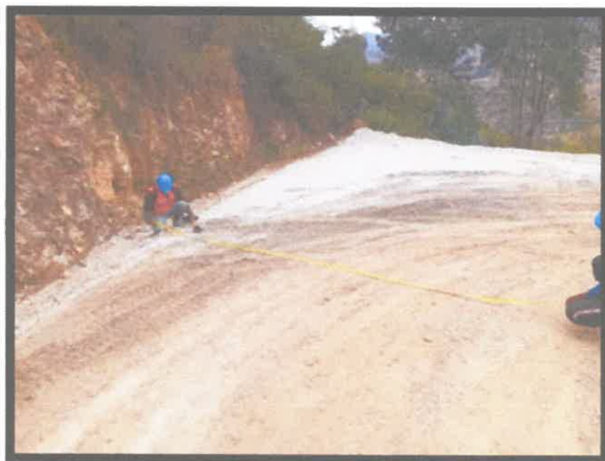
foto 05: verificación de ancho de vía existente y proyectada.
