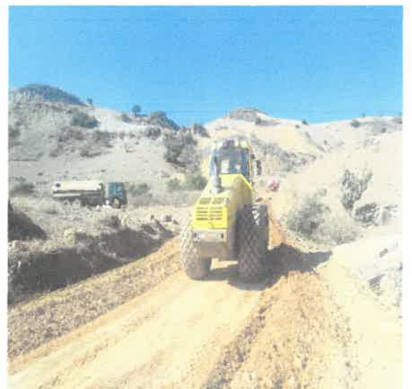
Trabajos de Colocación de afirmado y compactación
