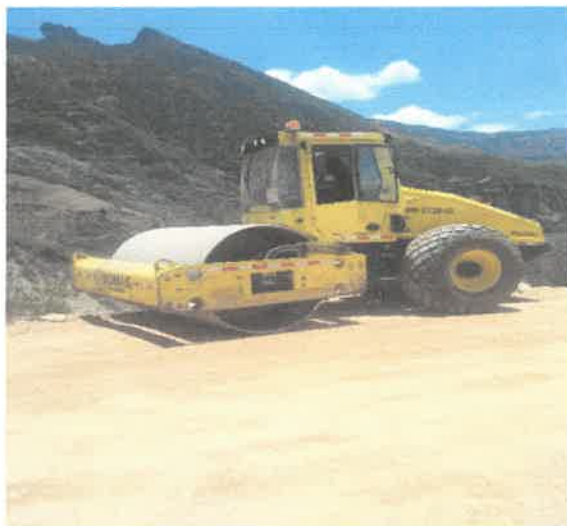
Compactación del tramo la Cauchalda- Nuevo Fortaleza.
