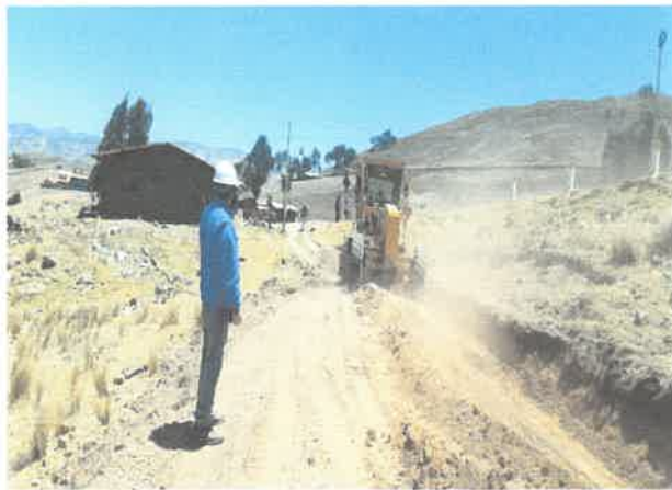
Trabajo de conformación de cunetas localidades de Cauchalda - Nuevo Fortaleza
