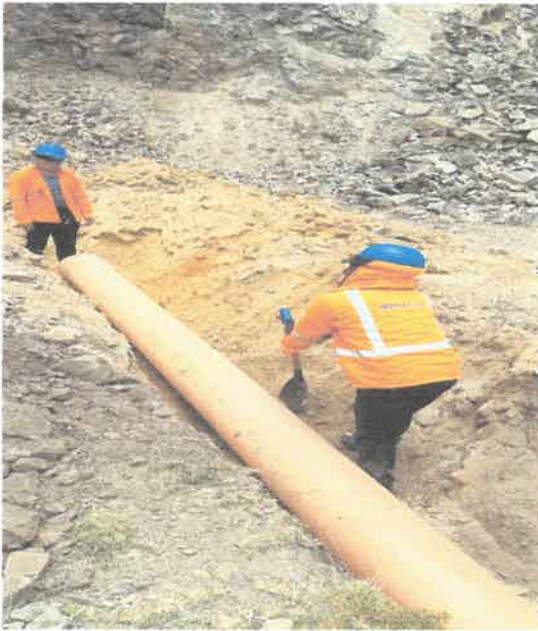
Colocación de tubería de pase de agua de 12".
