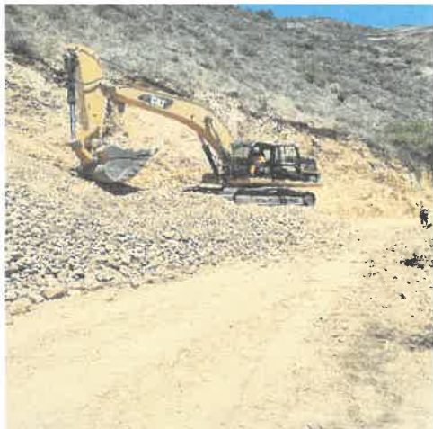
Trabajo de acumulación de material granulado de cantera
