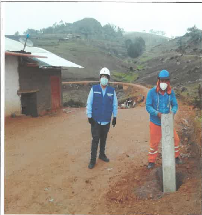
Inicio de la colocación de señalización Km 0+000, referente al tramo 14, cerca de la localidad de Puchaypampa. 9077336N 804085E
