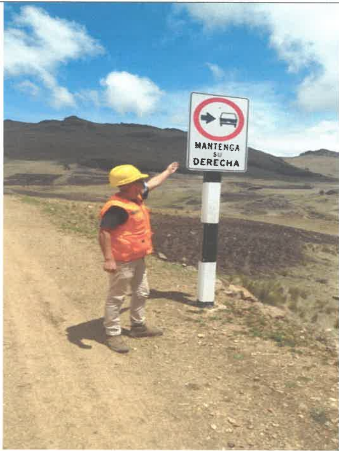
Verificación de las señales reglamentarias referente al paquete 14, Puchaypampa-Sogobara-Sincaz km 6+250 9095531N 816843E
