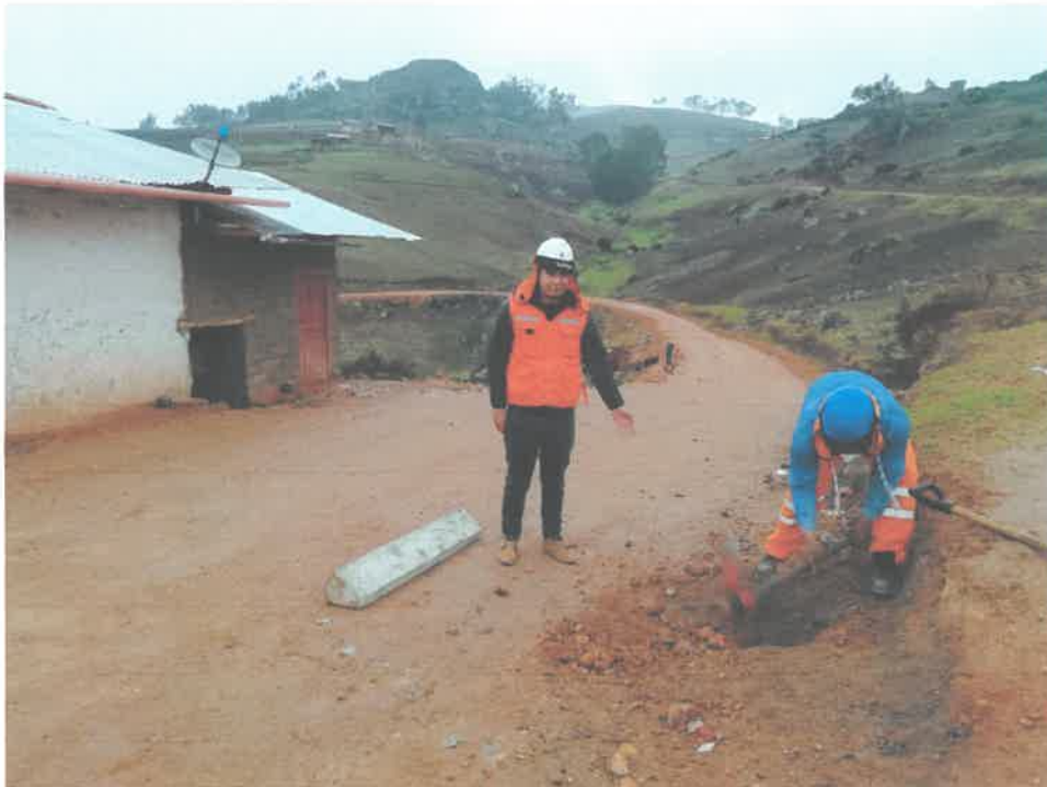
COLCOACION DE POSTE KILOMETRICO
