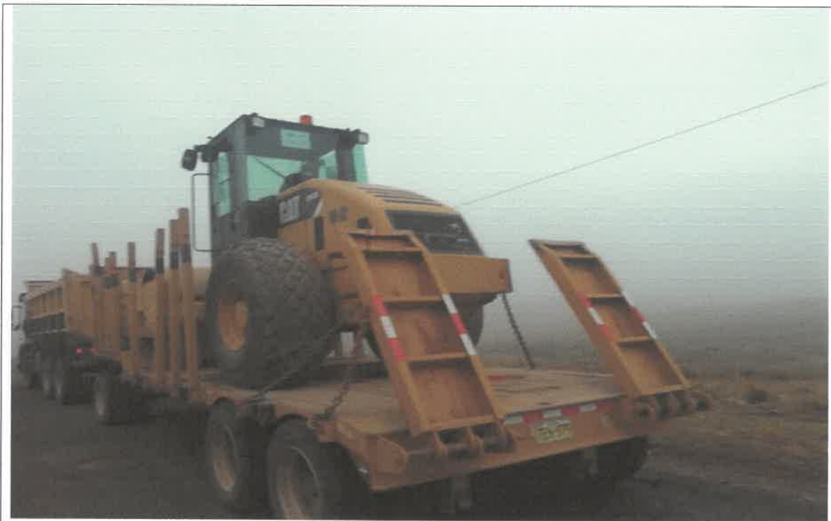
Movilización y desmovilización de equipo, referente al tramo 14, entre las localidades que une Sogobara y Sincaz, 9081704N 808652E
