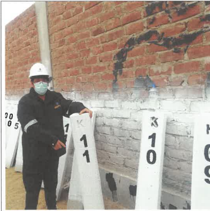
Verificación de la fabricación de los Hitos kilométricos en el almacén de producción, para la colocación de los mismos en la vía referente al paquete 14, Puchaypampa-Sogobara-Sincaz, Hito Km 11+000
