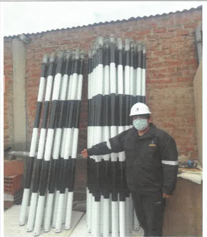
Verificación de la fabricación de los postes metálicos, en el almacén de producción, para la colocación de los mismos, en la vía referente al paquete 14, Puchaypampa-Sogobara-Sincaz.
