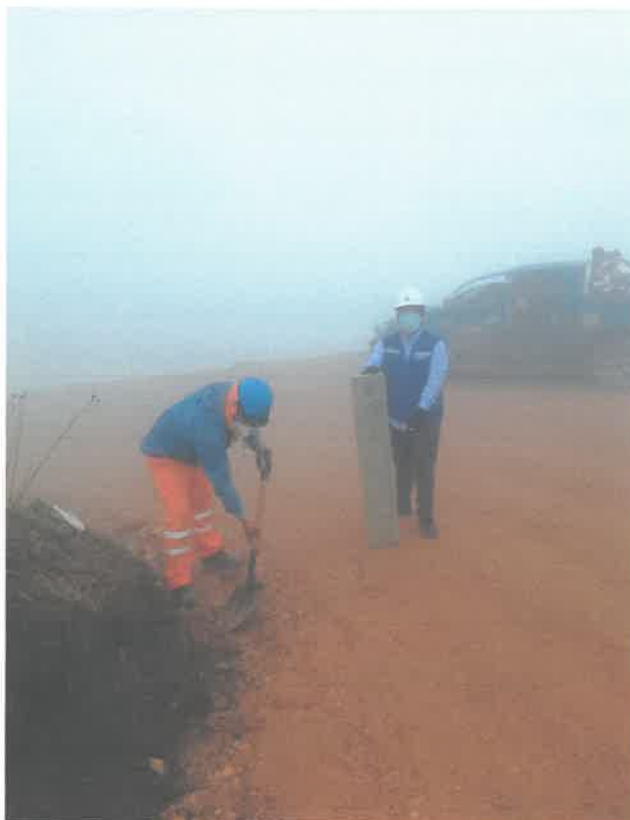
COLOCACION DE POSTES KILOMERICOS EN TRAMO PUCHAYPAMPA
