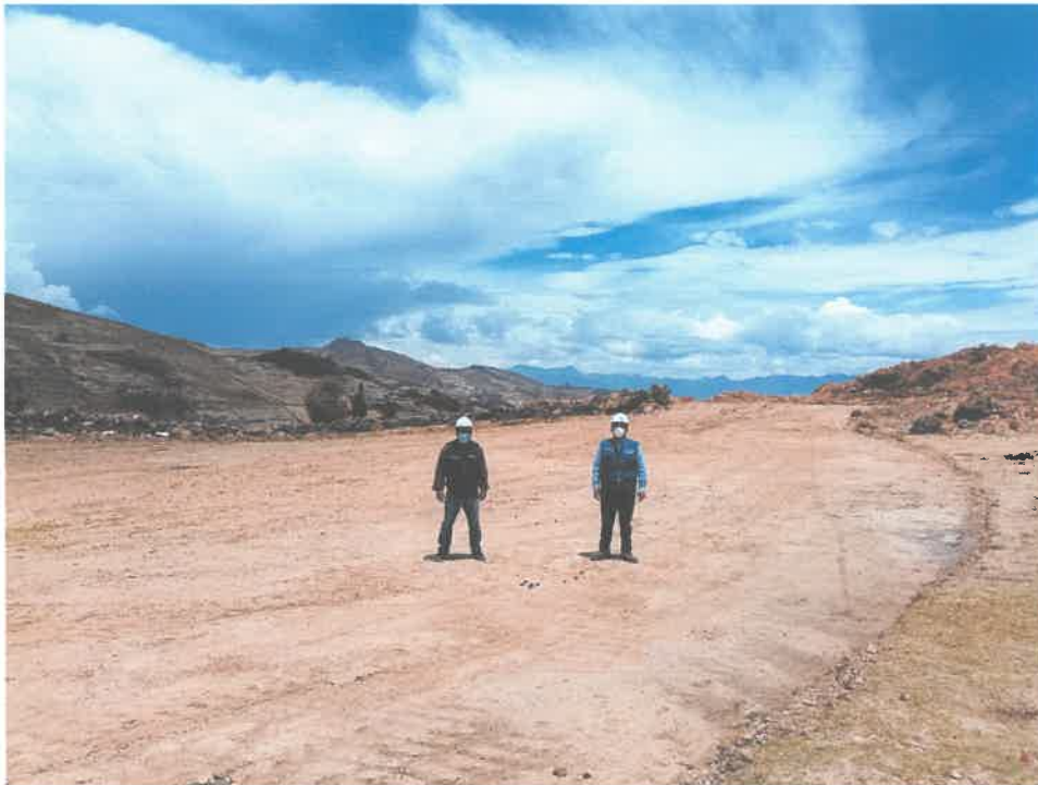
RECUPERACION DE AREAS OCUPADAS TRAMO SOGOBARA SINCAZ
