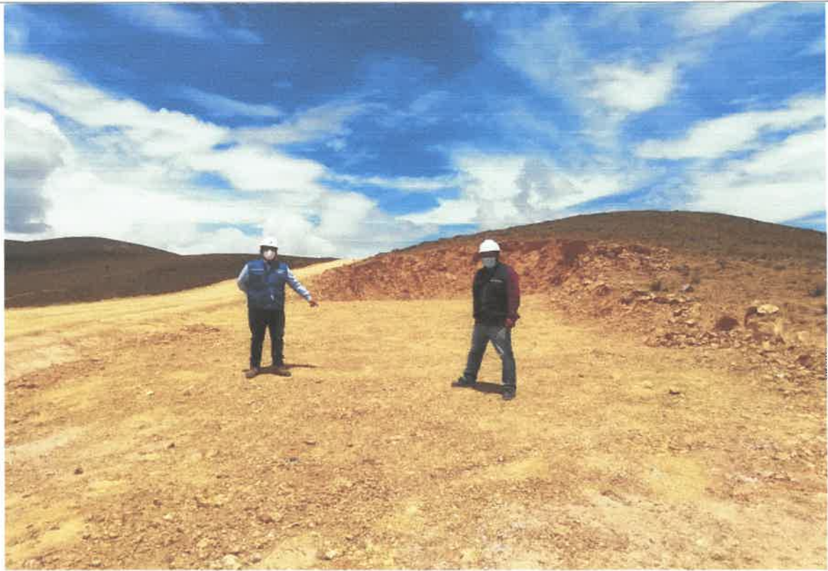
Recuperación Ambiental de áreas ocupadas, referente al tramo 14, cerca de la localidad de Sincaz km10+945, Junto al inspector del servicio. 9078844N 804973E
