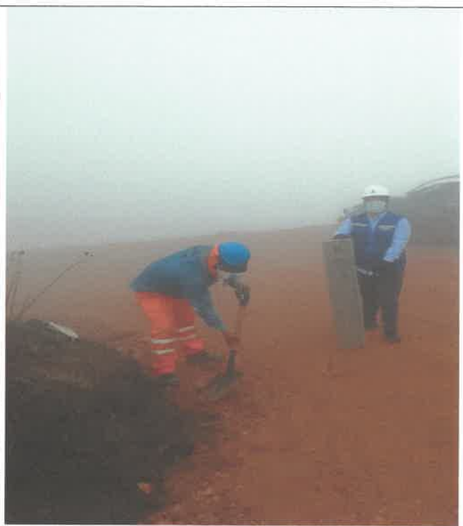
Inicio de la colocación de señalización Km 1+000, referente al tramo 14, cerca de la localidad de Puchaypampa. 9077336N 804085E
