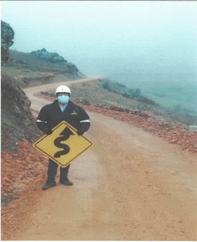
Inicio de la colocación de señalización preventiva Km 1+500, referente al tramo 14, cerca de la localidad de Puchaypampa. 9077869N 804128E
