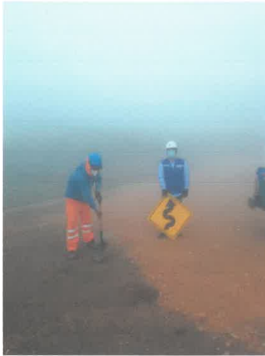
COLCOACION DE SEÑALES PREVENTIVAS
