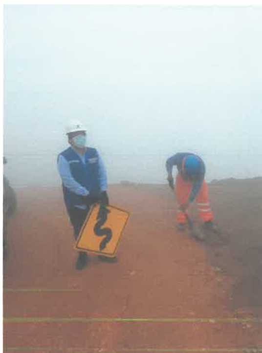
COLCOACION DE SEÑALES PREVENTIVAS
