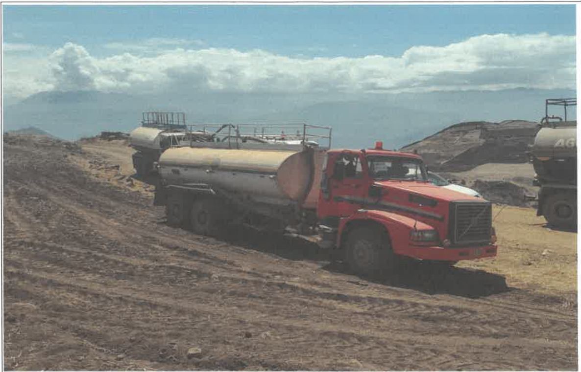
Inicio del proceso constructivo, Riego de la plataforma en el , km 5+750
