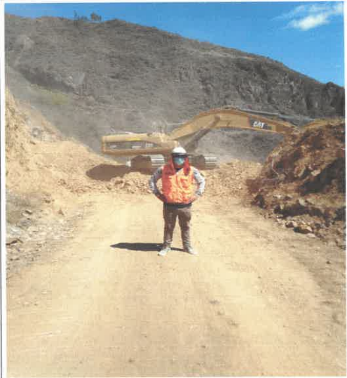
Verificación de los trabajos realizados en la progresiva, km 3+100 9073354N 810528E
