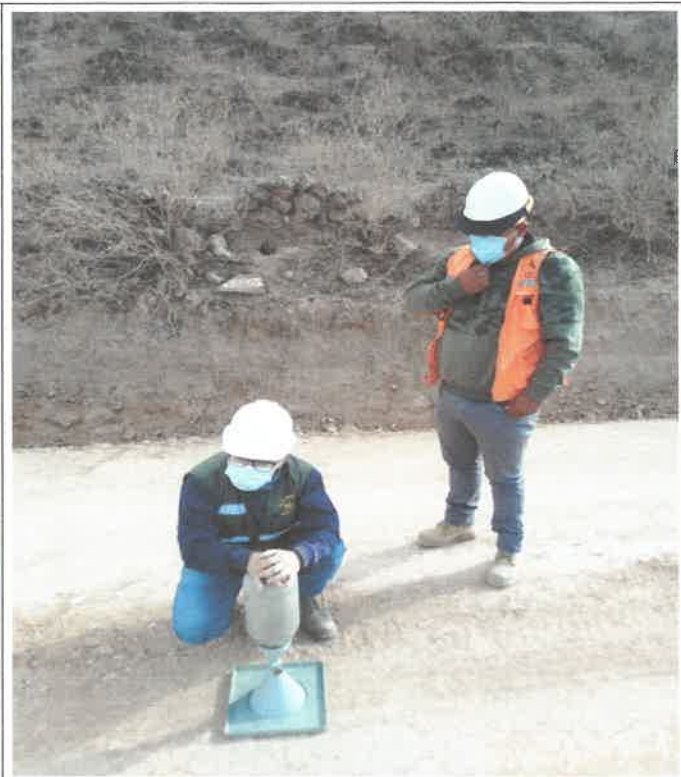
Verificación de la vía, referente al tramo 13, Km 5+500, junto con personal técnico encargado de los estudios de campo 9095589N 812685E
