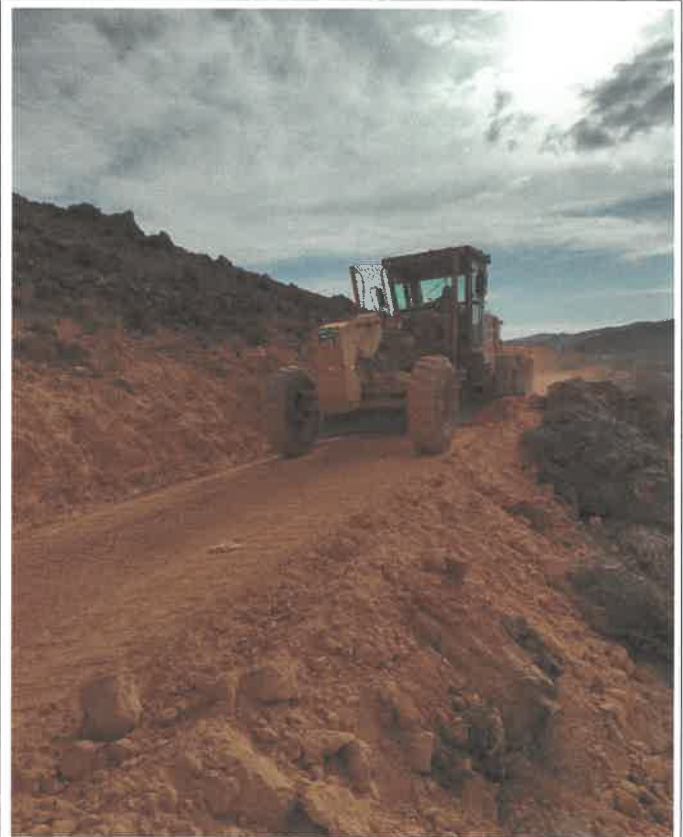
Verificación del proceso constructivo, colocación de capa nivelante e=0.05m, Km 5+600, 9086268N 806489E
