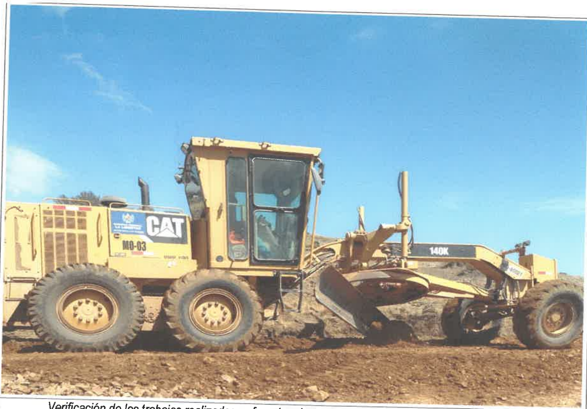
Verificación de los trabajos realizados, referente a la partida reconformación de cunetas km 8+500 9078794N 806325E
