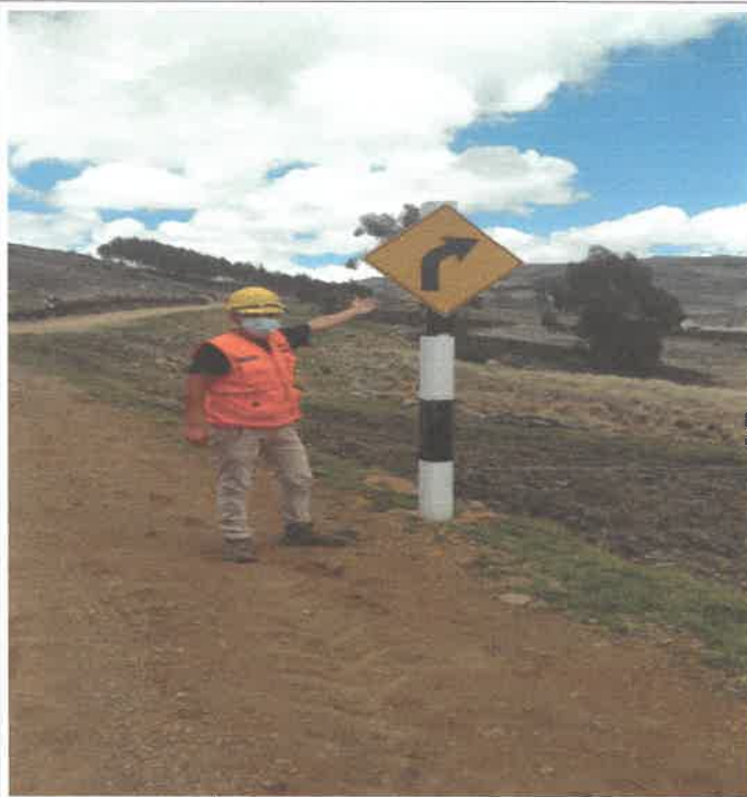
Verificación de los trabajos realizados en la plataforma, km 1+980, colocación de la señal preventiva 9073354N 810528E
