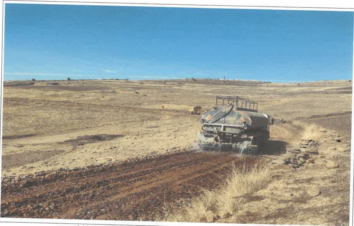
Inicio del proceso constructivo, Riego de la plataforma en el , km 10+800 9078794N 806325E
