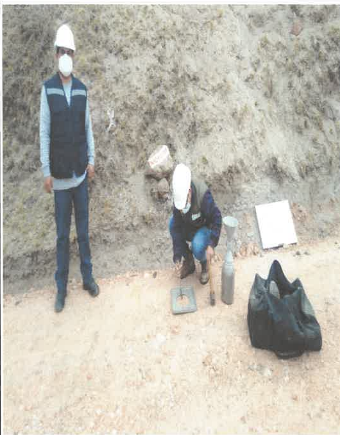
Verificación de la vía, referente al tramo 13, Km 1+000, junto con personal técnico encargado de los estudios de campo, e inspector. 9095624N 811236E
