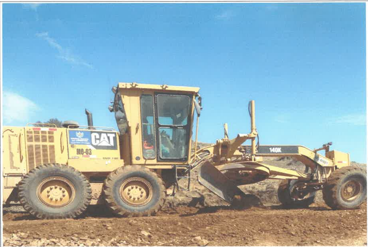
Verificación de los trabajos realizados, referente a la partida reconformación de cunetas km 8+500 9078794N 806325E
