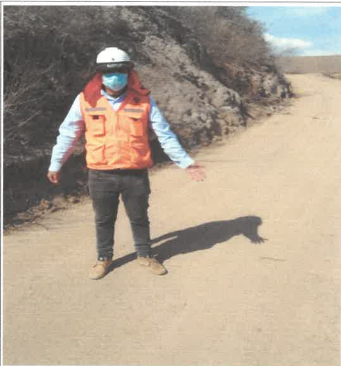
Verificación de los trabajos realizados en la plataforma, km 4+500, en presencia del Asistente de Residente. 9073354N 810528E
