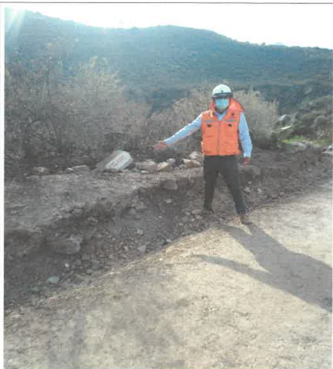
Verificación de los trabajos realizados en la progresiva, km 9+750 9073354N 810528E
