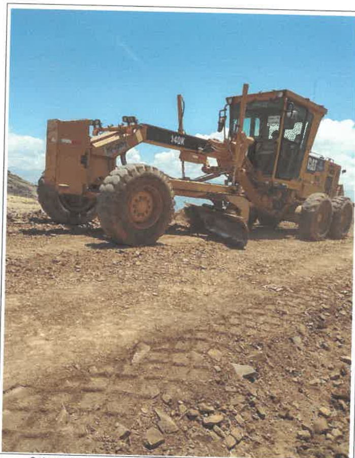
Colocación de material granular de cantera e=0.15m, km 9+900 90787658N 806987E
