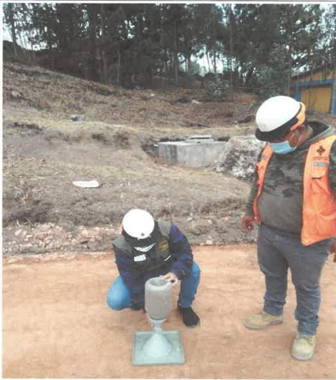
Verificación de la vía, referente al tramo 13, Km 2+500, junto con personal técnico encargado de los estudios de campo 9095589N 812685E
