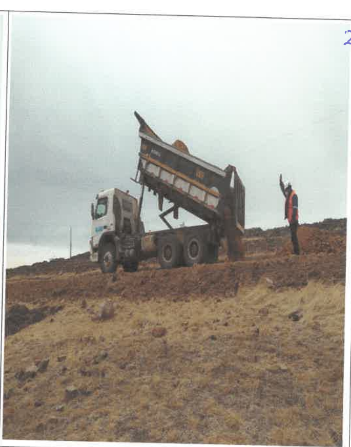
Colocación de material granular de cantera e=0.15m, km 8+550 9078794N 806325E
