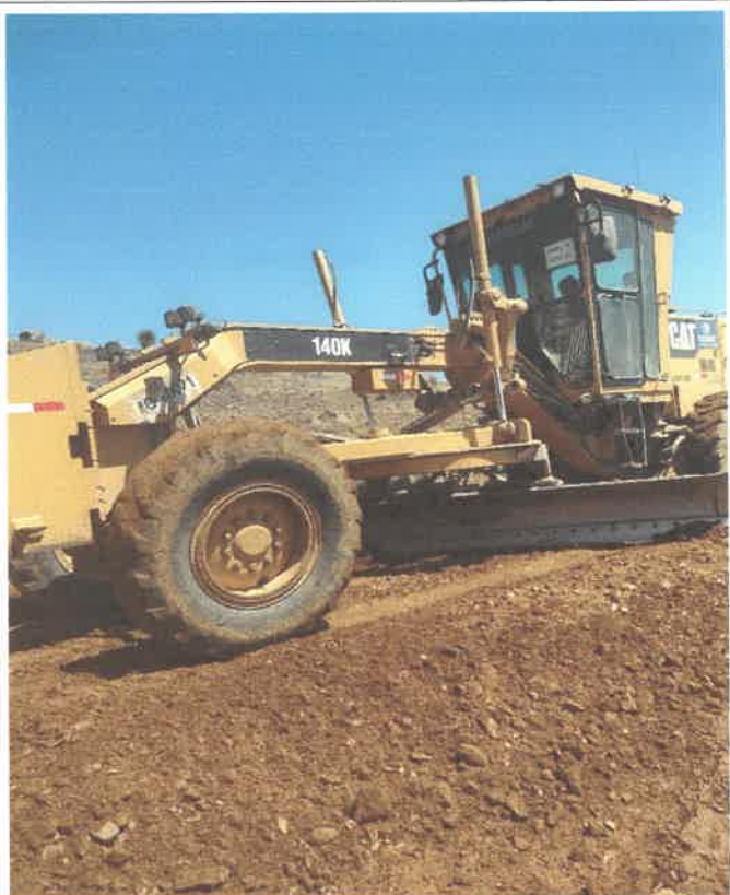
Verificación del proceso constructivo, colocación de capa nivelante e=0.05m, Km 3+700, 9086268N 806489E
