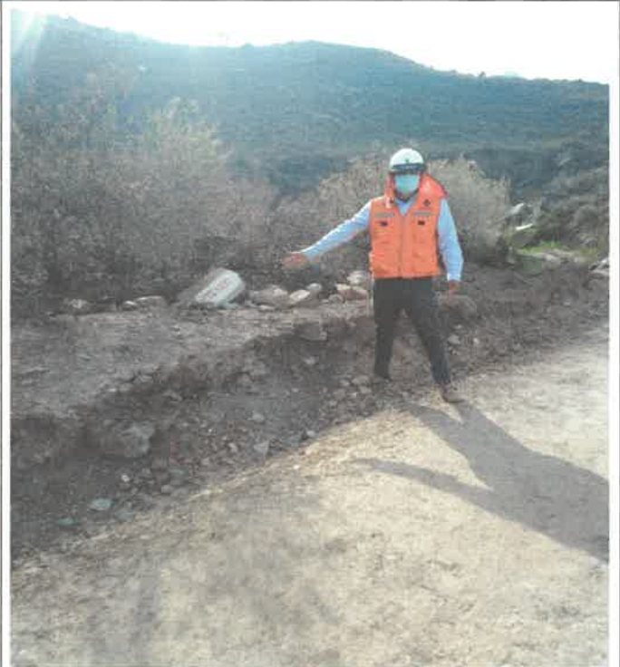
Verificación de los trabajos realizados en la progresiva, km 9+750 9073354N 810528E
