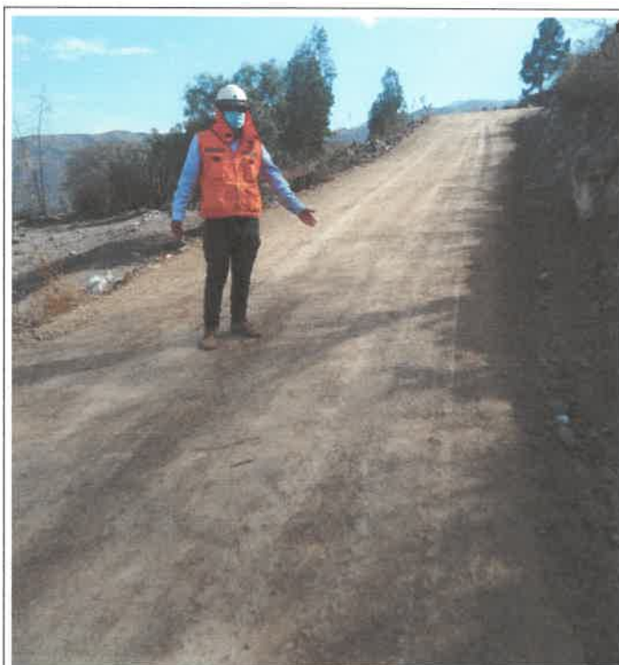
Verificación de los trabajos realizados en la plataforma, km 10+800, en presencia del Asistente de Residente. 9073354N 810528E
