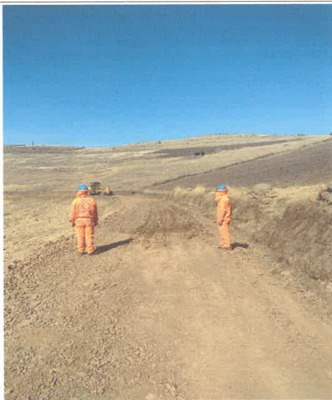
Verificación del proceso constructivo, colocación de capa nivelante e=0.05m, Km 3+500, 9086268N 806489E
