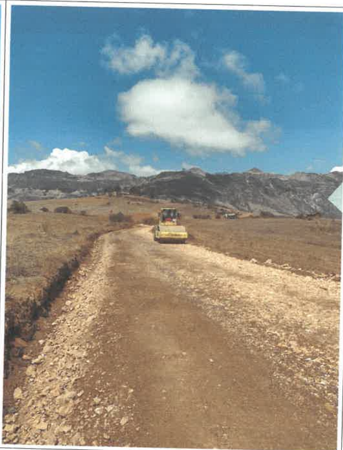
Inicio del proceso constructivo, Compactación de la plataforma en el, km 10++500, 9074558N 800229E
