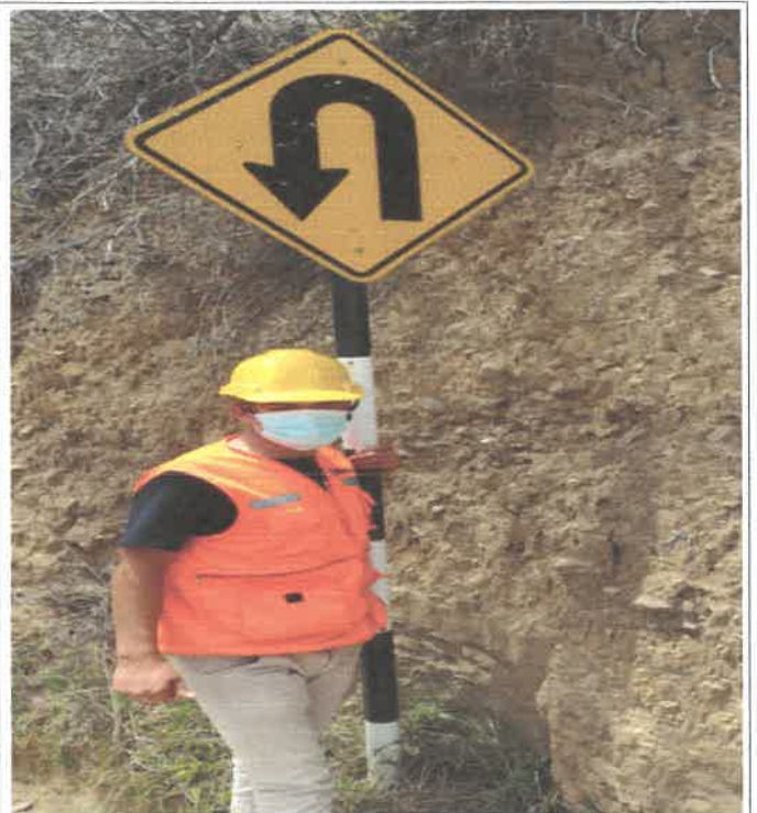
Verificación de los trabajos realizados en la progresiva, colocación de la señal preventiva km 1+030 9073354N 810528E
