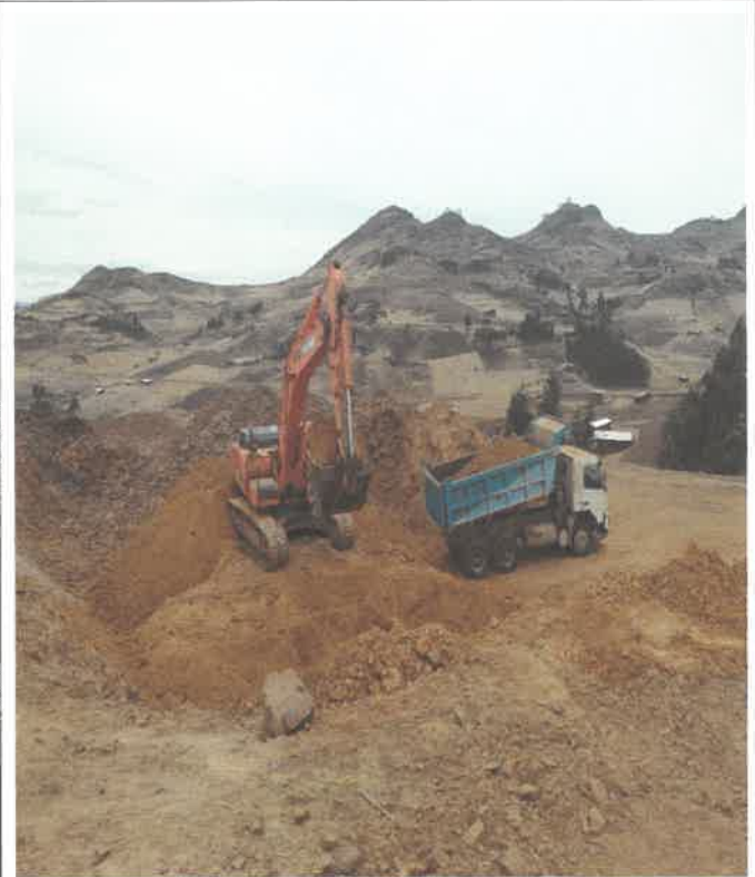
Transporte de material granular desde cantera Km 3+100, para la colocación en plataforma. 9086250N 806478E
