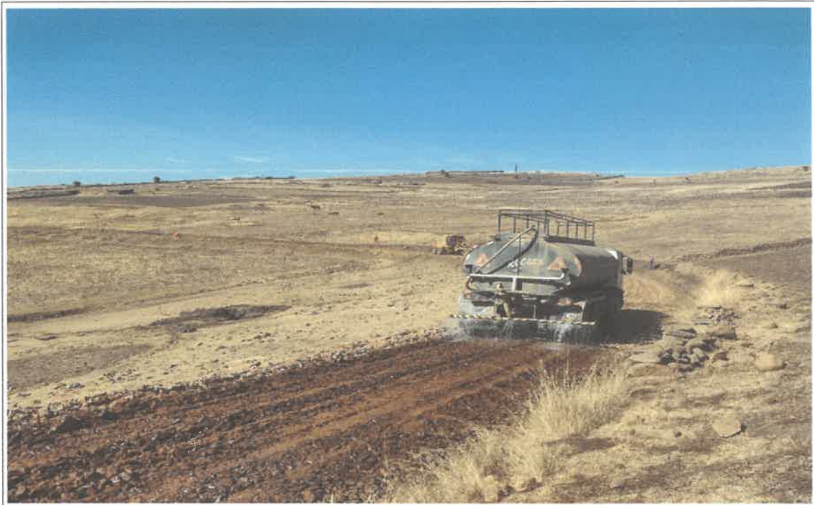
Inicio del proceso constructivo, Riego de la plataforma en el , km 10+800 9078794N 806325E
