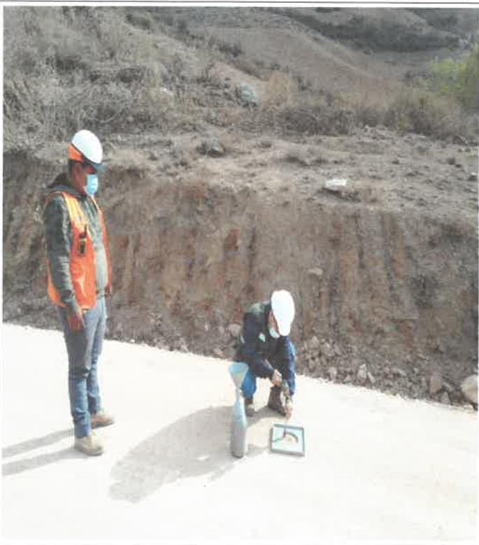
Verificación de la vía, referente al tramo 13, Km 4+000, junto con personal técnico encargado de los estudios de campo 9095589N 812685E
