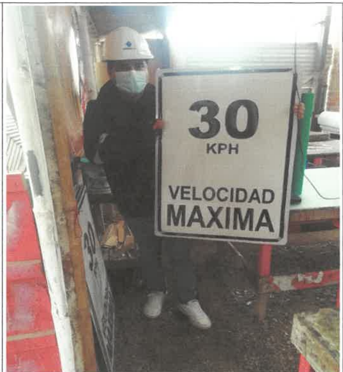
Verificación de la realización de las señales reglamentarias en el almacén de producción, para la colocación en la carretera del paquete 13
