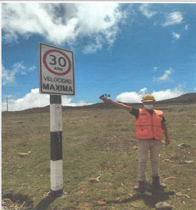
Verificación de los trabajos realizados en la plataforma, km 3+750, colocación de la señal reglamentaria. 9073354N 810528E
