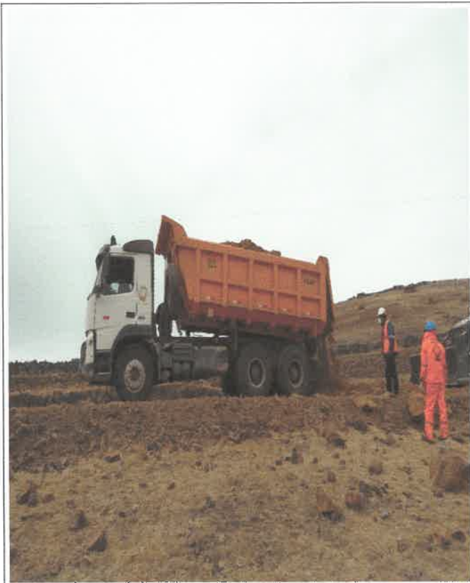
Inicio del proceso constructivo colocación de material granular de cantera e=0.15m, km 8+500, 9078794N 806325E
