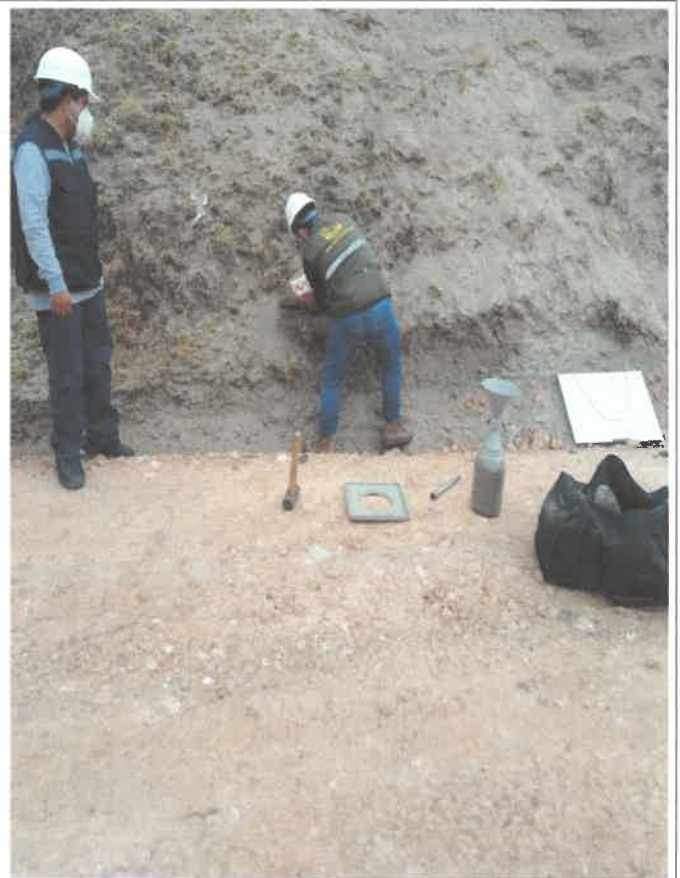
Verificación de la vía, referente al tramo 13, Km 1+500, junto con personal técnico encargado de los estudios de campo, e inspector. 9095589N 812685E
