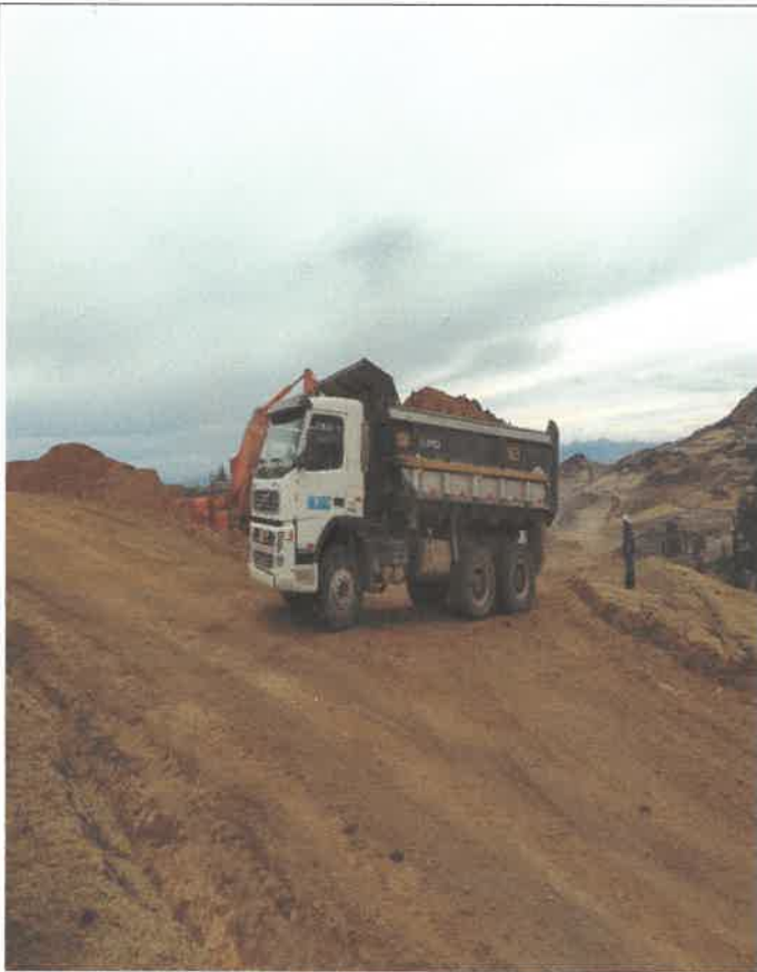
Transporte de material granular desde cantera Km 3+100 9086250N 806478E
