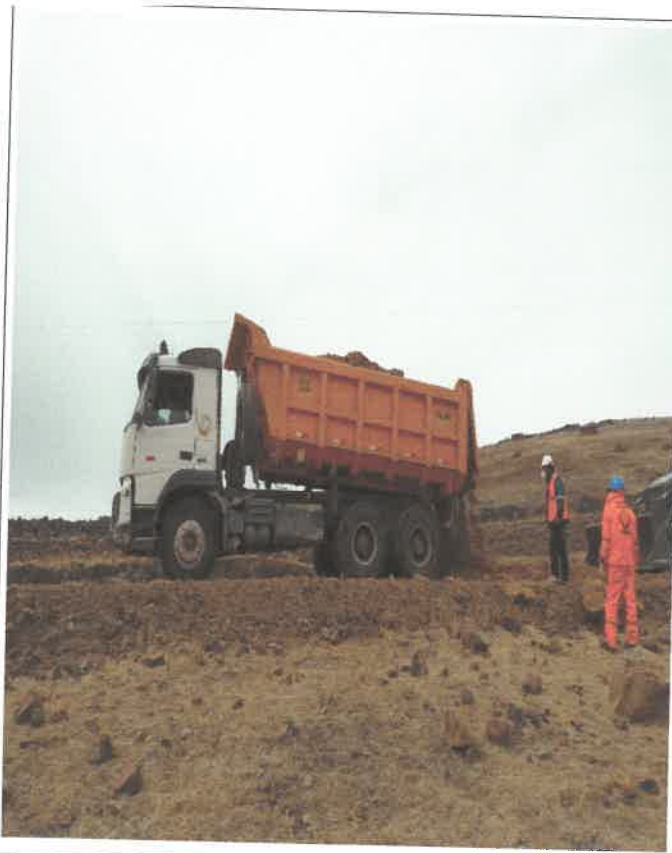
Inicio del proceso constructivo colocación de material granular de cantera e=0.15m, km 8+500, 9078794N 806325E
