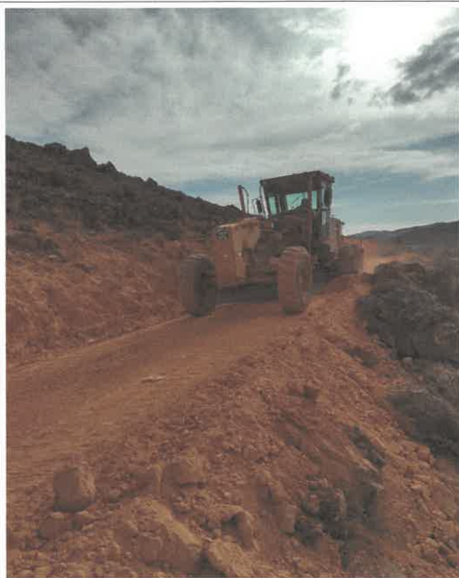
Verificación del proceso constructivo, colocación de capa nivelante e=0.05m, Km 5+600, 9086268N 806489E
