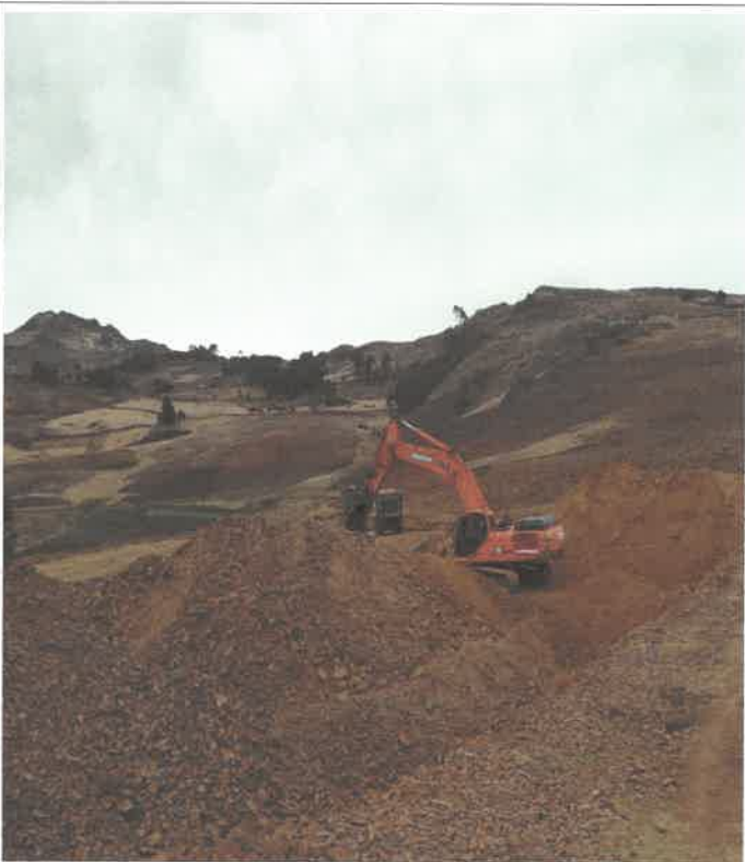
Apilamiento de material granular desde cantera Km 3+100 9086250N 806478E
