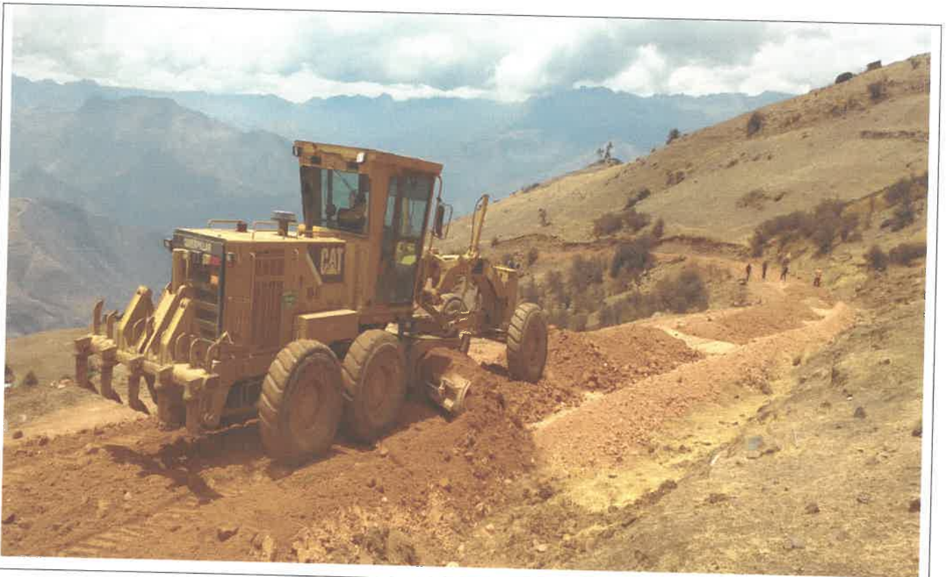
Colocación de material granular de cantera e=0.15m, km 3+500 9079874N 806324E
