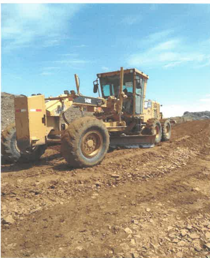
Verificación del proceso constructivo, colocación de capa nivelante e=0.05m, Km 3+400, 9086268N 806489E
