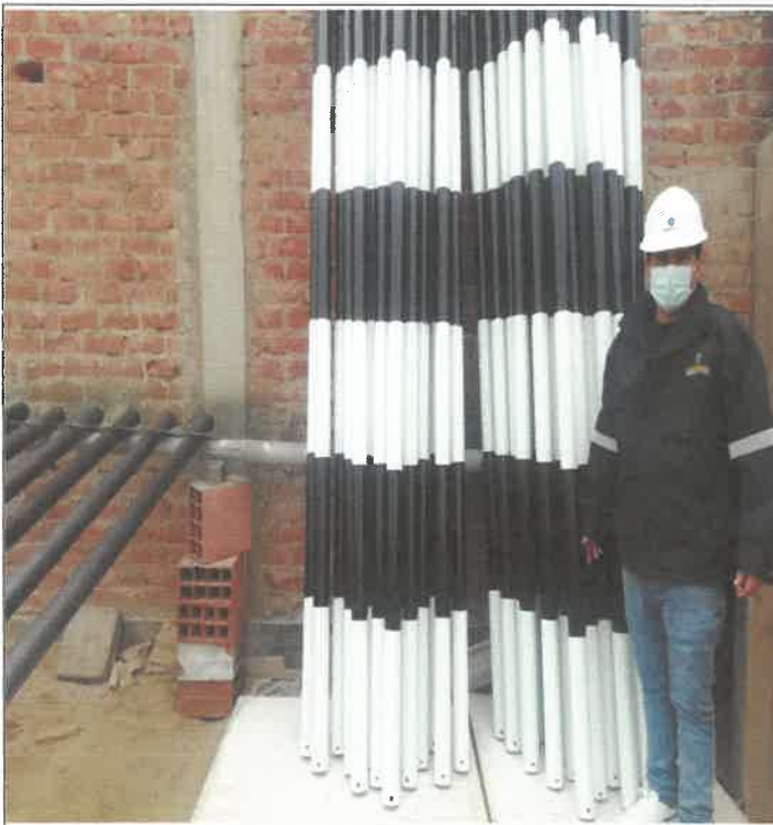
Verificación de la realización de las señales de tránsito en el almacén de producción, para la colocación en la carretera del paquete 13
