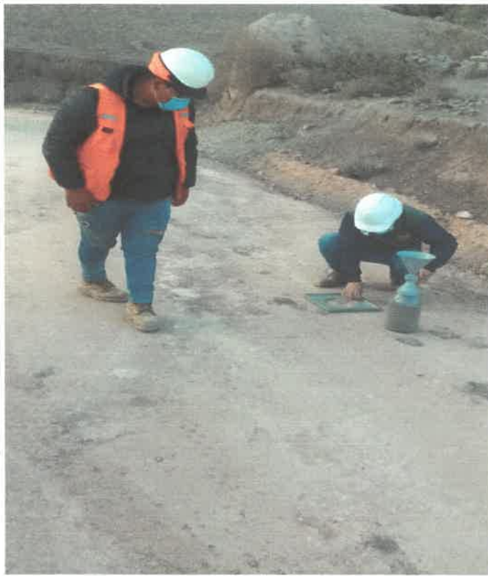
Verificación de la vía, referente al tramo 13, Km 7+000, junto con personal técnico encargado de los estudios de campo 9095589N 812685E
