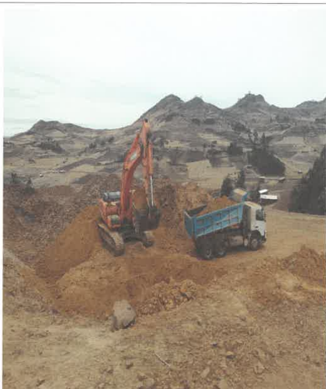
Transporte de material granular desde cantera Km 3+100, para la colocación en plataforma. 9086250N 806478E
