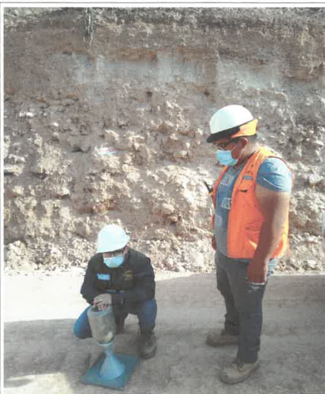
Verificación de la vía, referente al tramo 13, Km 10+500, junto con personal técnico encargado de los estudios de campo 9095589N 812685E
