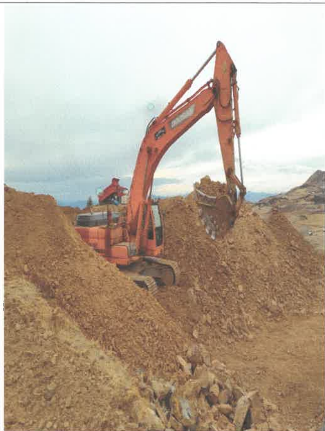
Apilamiento de material granular desde cantera Km 3+100 9086250N 806478E
