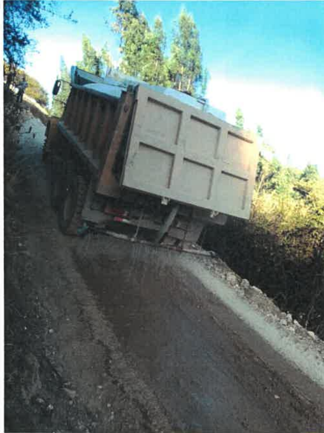
TRANSPORTE DE MATERIAL GRANULAR HASTA 1 KM
