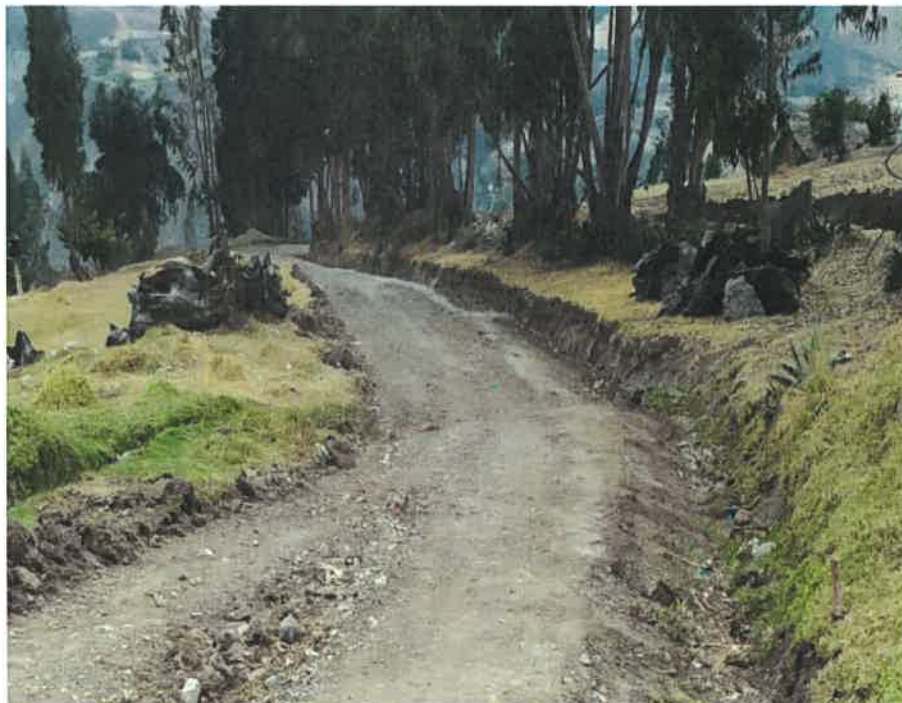
RECONFORMACIÓN DE CUNETAS
