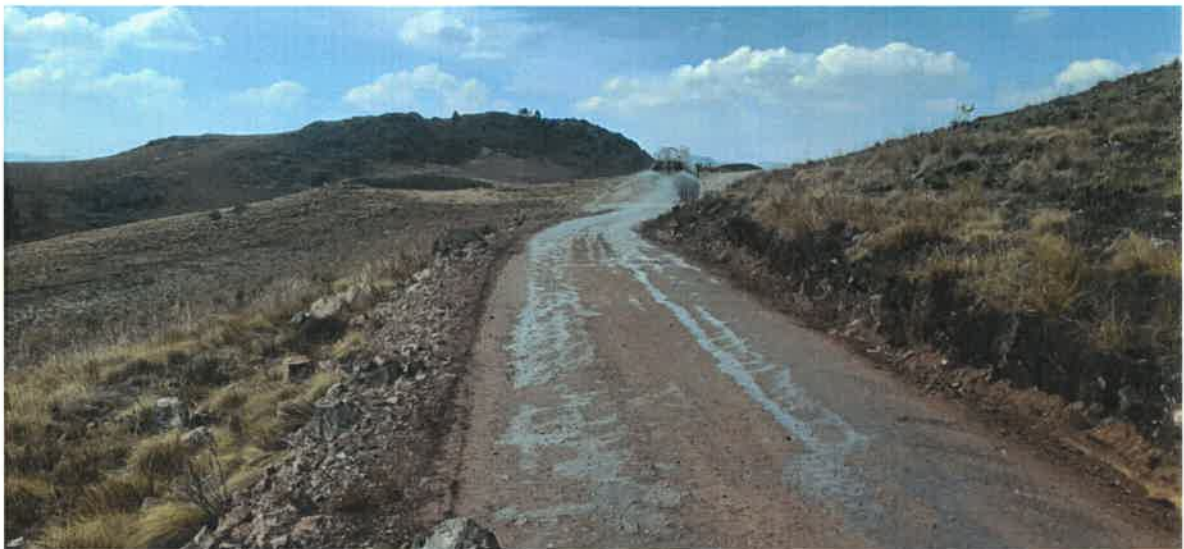
RIEGO DE VIA
