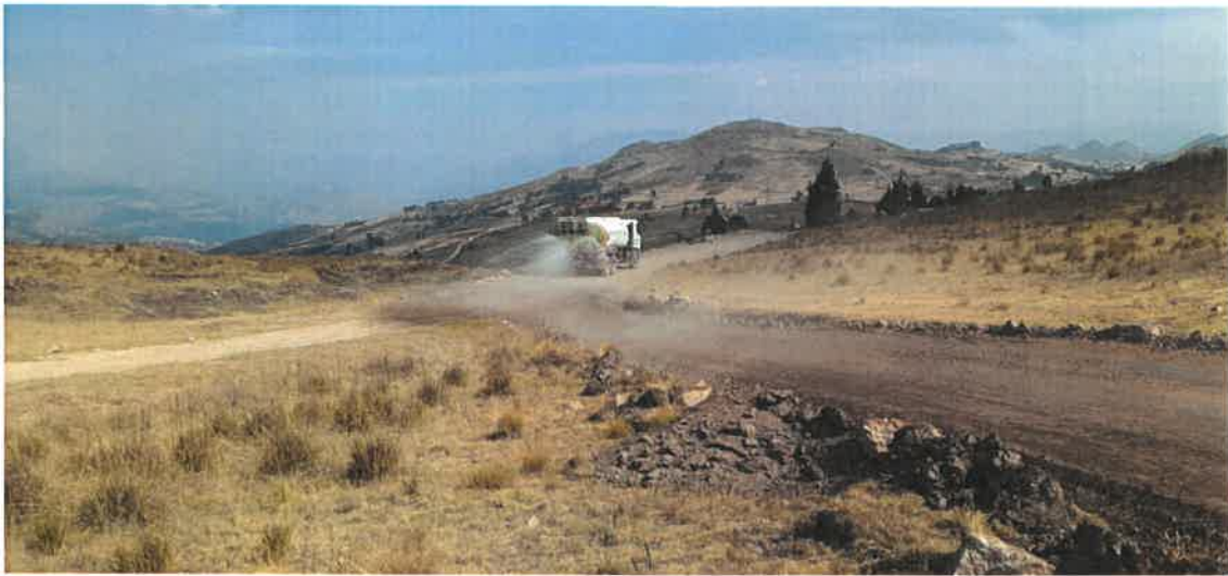
RIEGO DE LA VIA Y LIMPIEZA FINAL
