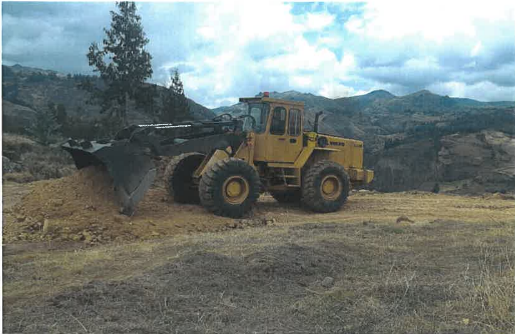
Se observa el trabajo con cargador frontal.
