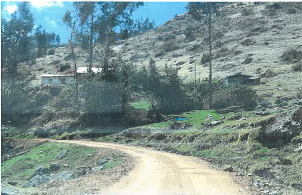
Se observa la conformación de la capa nivelante.
