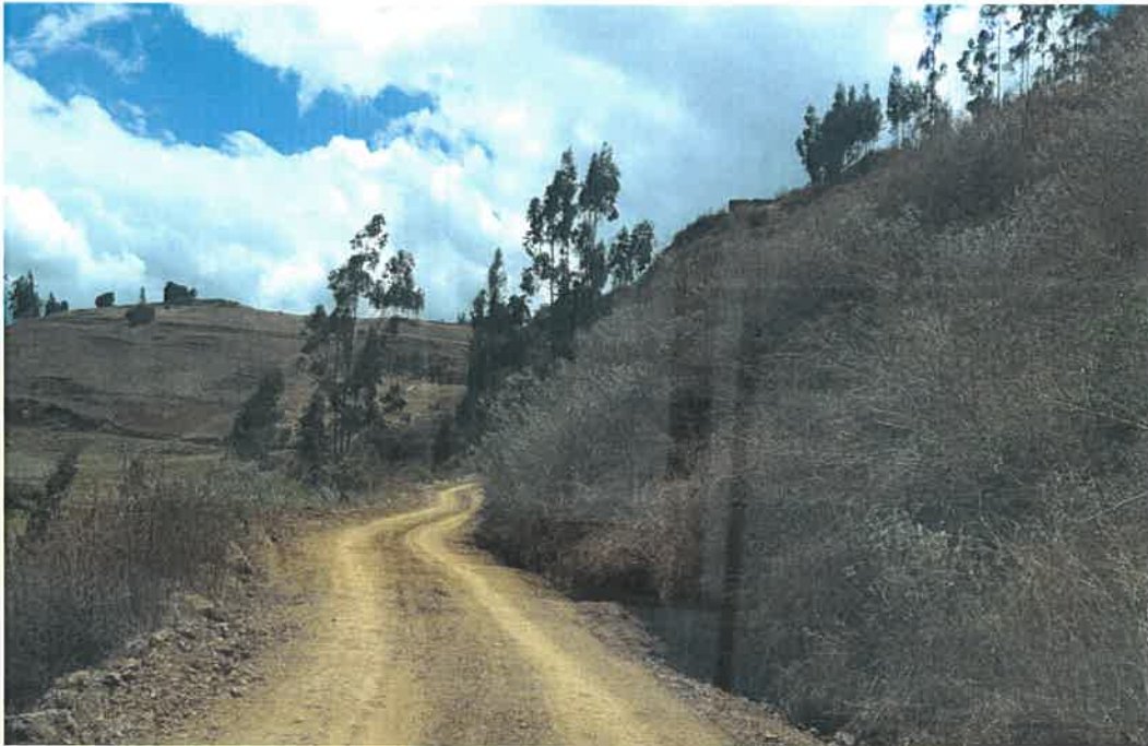
Se observa la conformación del material granular de cantera.
