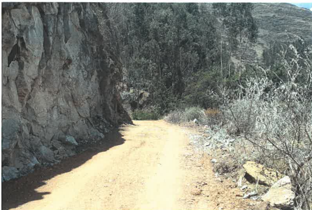
Se observa la conformación del material granular de cantera.
