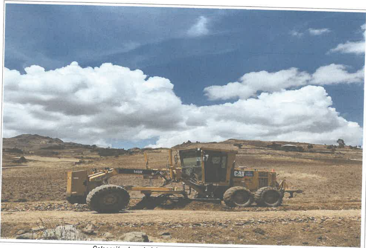
Colocación de material granular de cantera e=0.15m, km 7+700 9074558N 800229E
