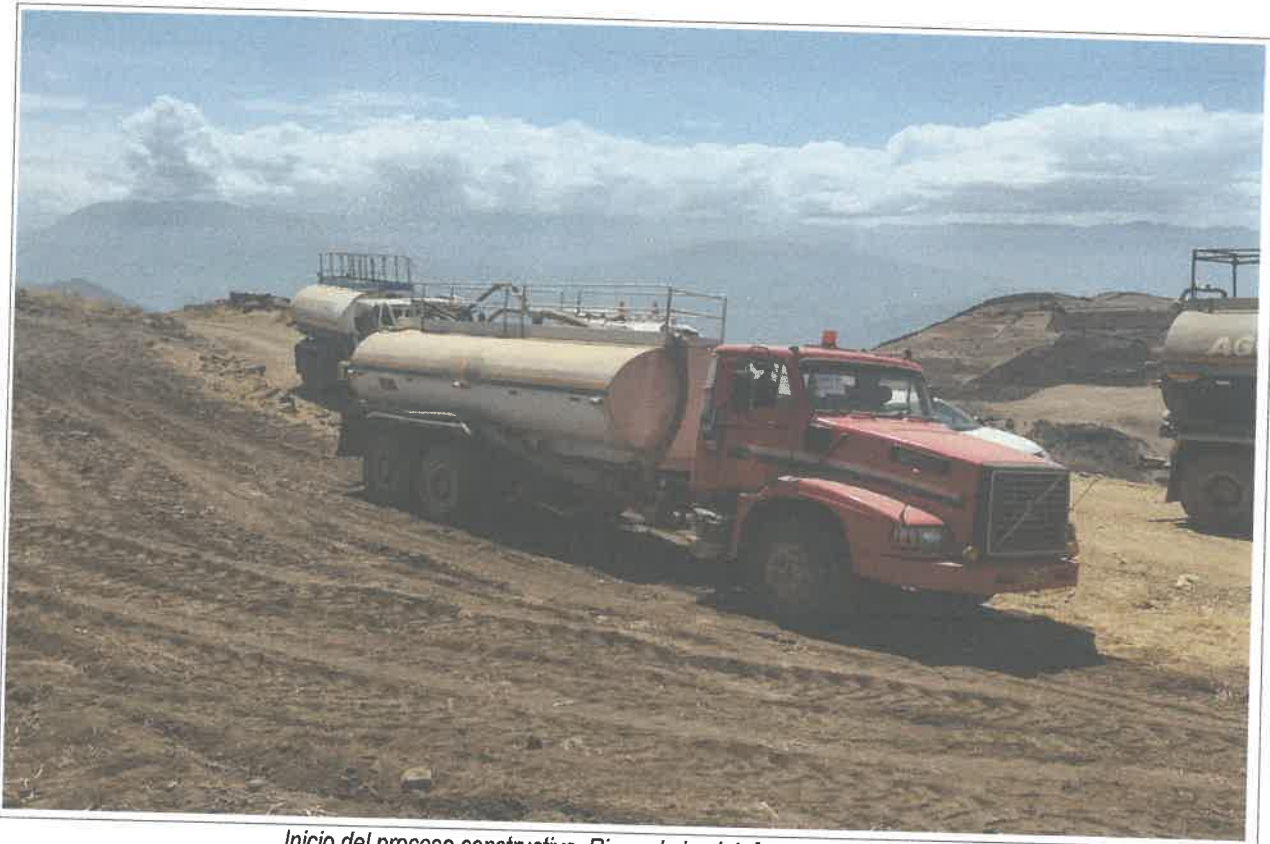
Inicio del proceso constructivo, Riego de la plataforma en el , km 5+750
