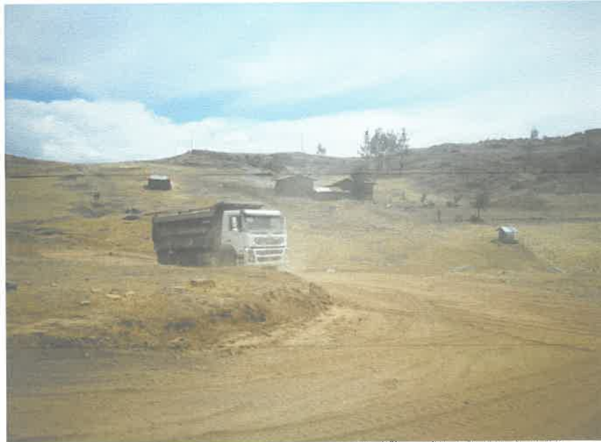
Continúa con el avance de Traslado de Material Granular de Cantera
