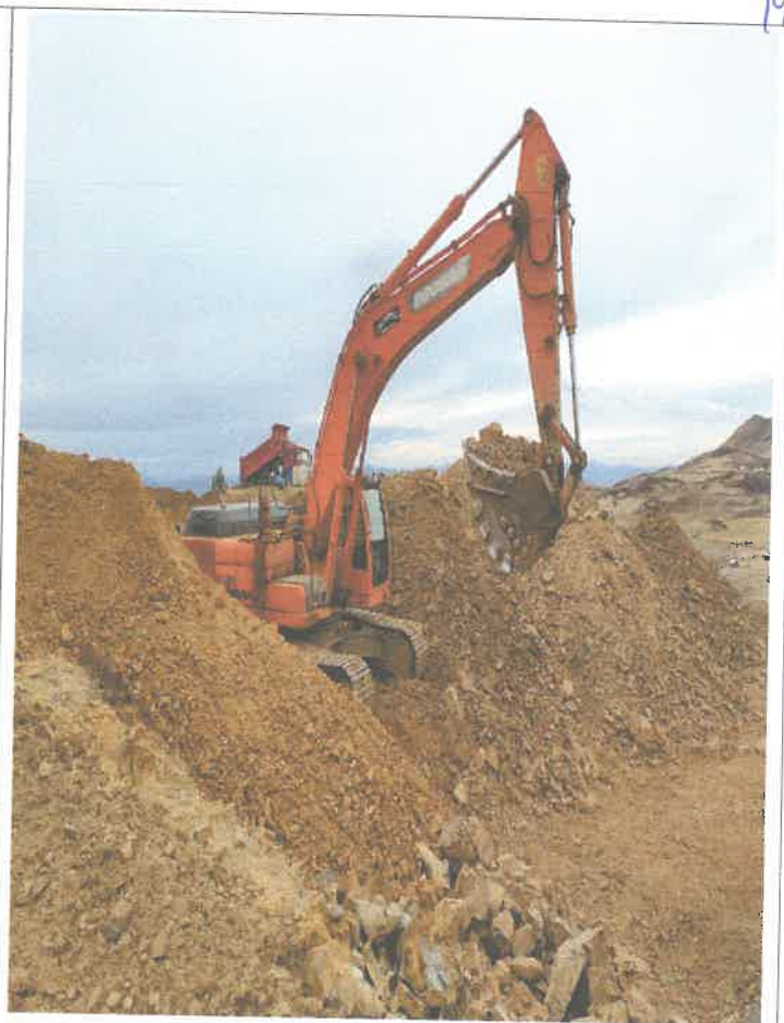
Apilamiento de material granular desde cantera Km 3+100 9086250N 806478E
