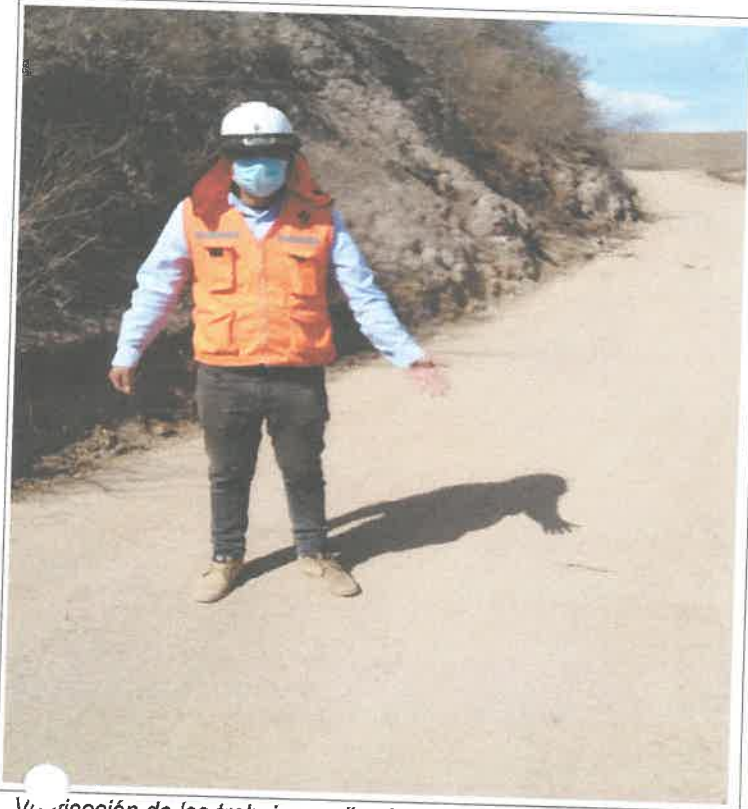
Verificación de los trabajos realizados en la plataforma, km 4+500, en presencia del Asistente de Residente. 9073354N 810528E
