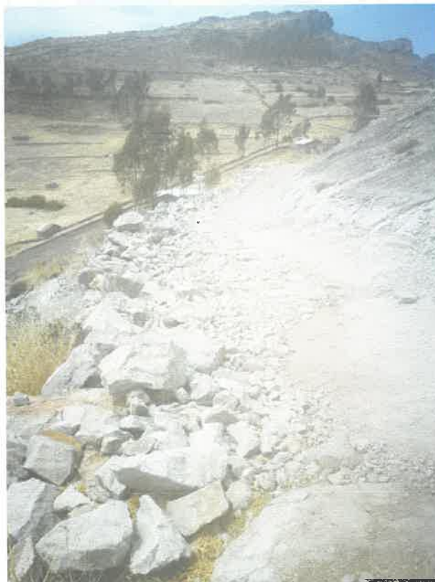
Trabajos de Limpieza para la ejecución de Capa Nivelante
