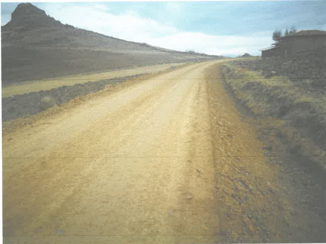
Continúa con el avance de la Partida Traslado de Material Granular de Cantera E=0.15m
