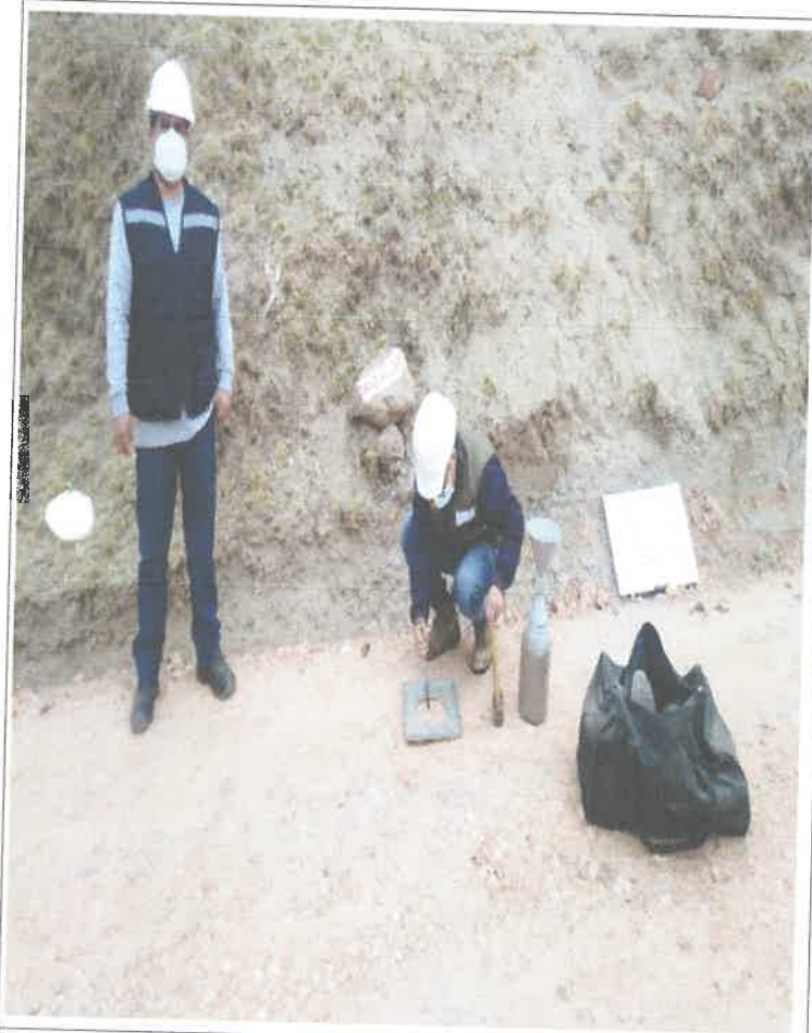
Verificación de la vía, referente al tramo 13, Km 4+100, junto con personal técnico encargado de los estudios de campo, e inspector. 9095624N 811236E
