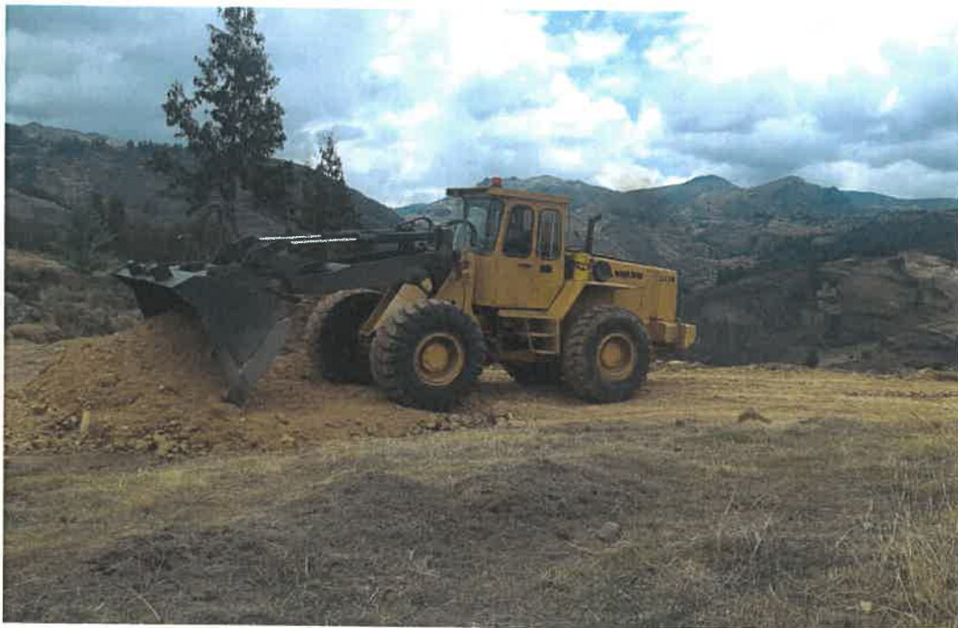
Se observa el trabajo con cargador frontal.
