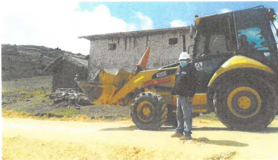
VERIFICANDO COLOCACION DE CAPA NIVELANTE PROG. 9+ 950 SOGOBARA -- SINCAZ
