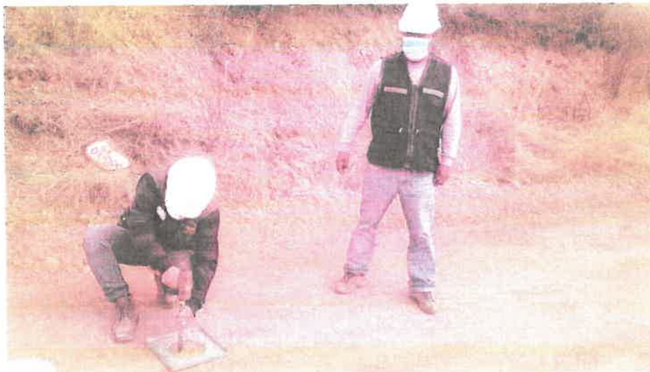
PRUEBA DE DENSIDAD DE CAMPO EN PROG. 2+000
