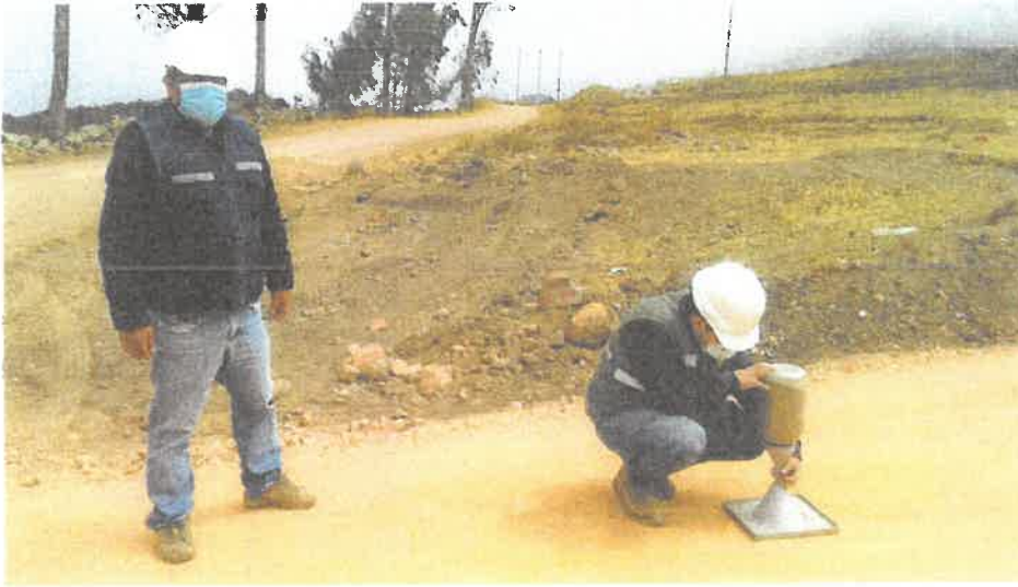
VERIFICANDO PUEBA DE DENCIDAD DE CAMPO PROG. 5+400 INICIO TRAMO SOGOBARA SINCAZ
