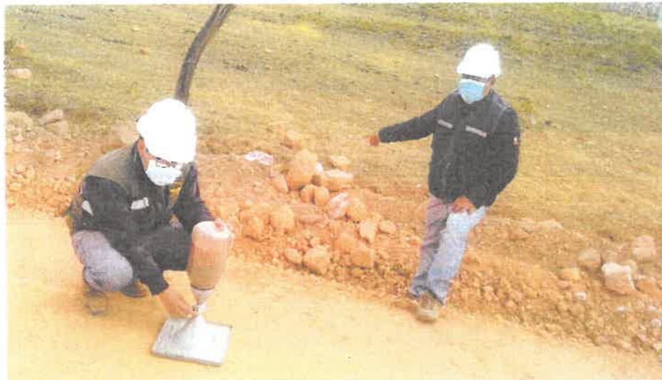
PRUEBA DE DENCIDAD DE CAMPO PROG. 5+900 TRAMO SOSGOBARA – SINCAZ
