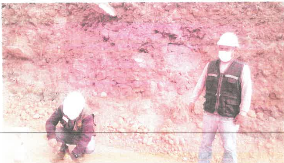
PRUEBA DE DENSIDAD DE CAMPO PROG. 3+000 EN TRAMO DE PUCHAYPAMPA - SOGOBARA
