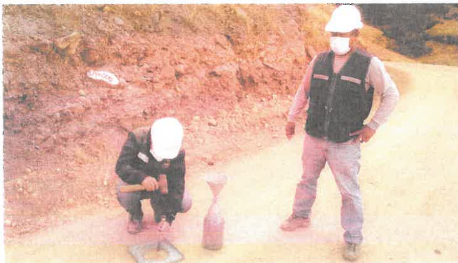
PRUEBA DE DENSIDAD DE CAMPO EN PROG. 4+000
