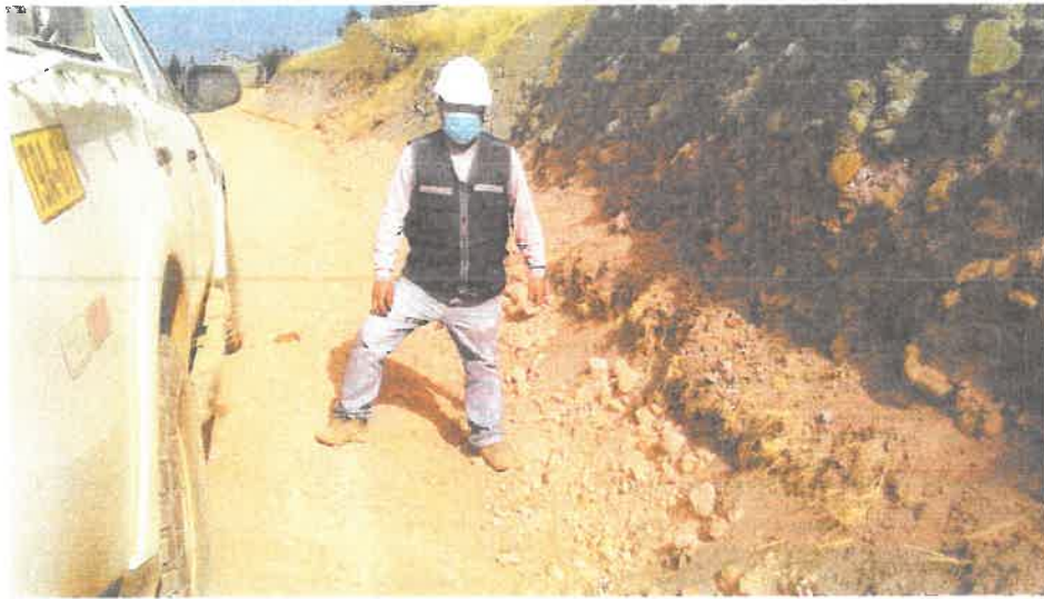
VERIFICANDO LA RECONFORMACION DE CUNETAS EN TRAMO PUCHAYPAMPA – SOGOBARA
