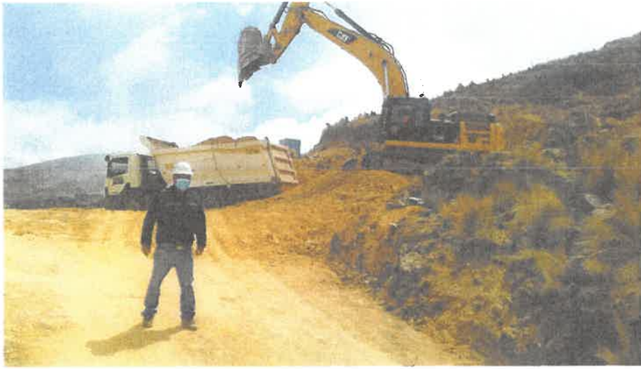
VERIFICANDO TRANSPORTE DE MATERIAL DE AFIRMADO PARA CAPA NIVELANTE
