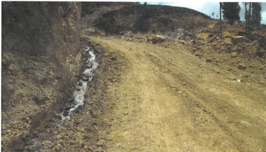
CAPA NIVELANTE KM 1+000
