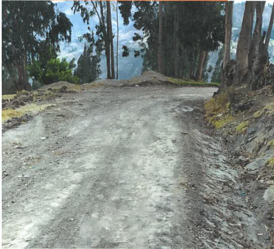
RECONFORMACIÓN DE CUNETAS KM 0+140
