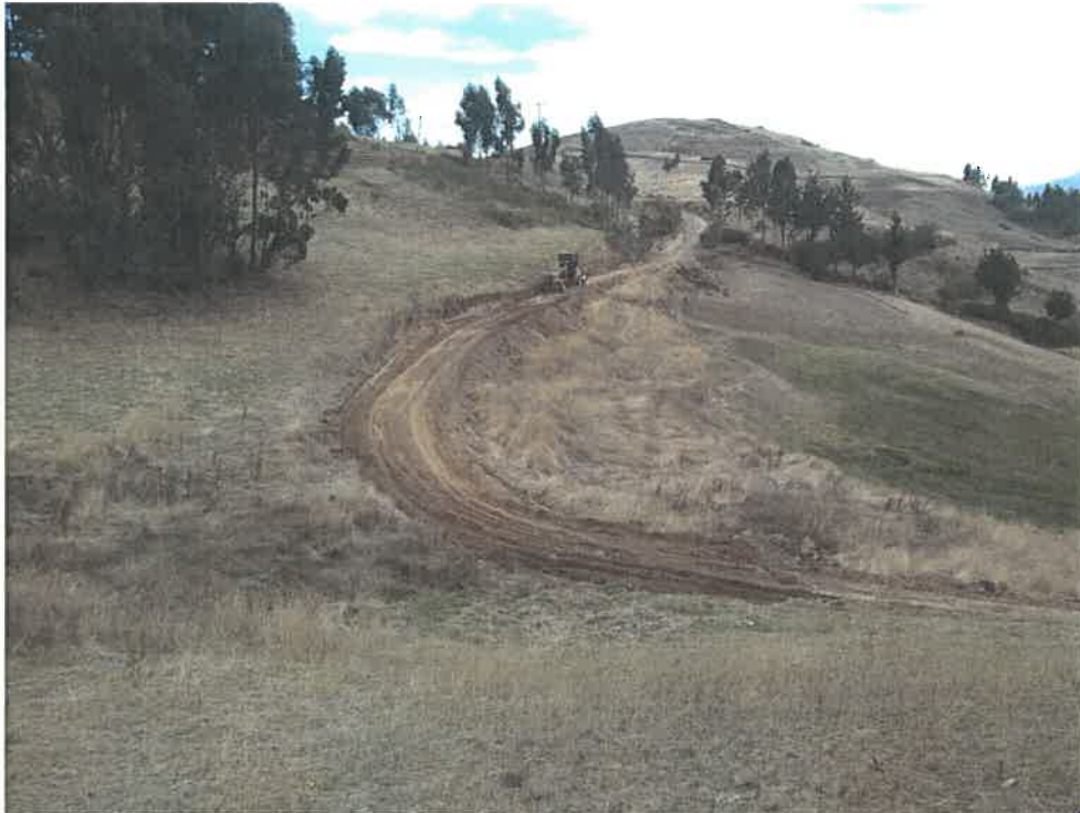
RECONFORMACIÓN DE CUNETAS Y CAPA NIVELANTE KM 3+000
