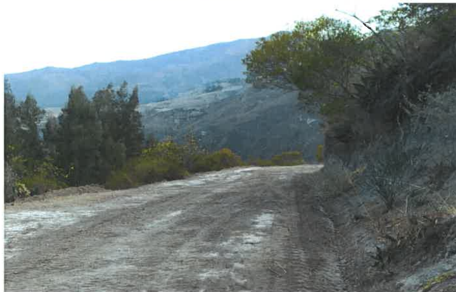
RECONFORMACIÓN DE CUNETAS KM 2+000
