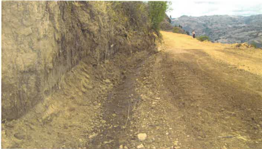
RECONFORMACIÓN DE CUNETAS KM 0+500
