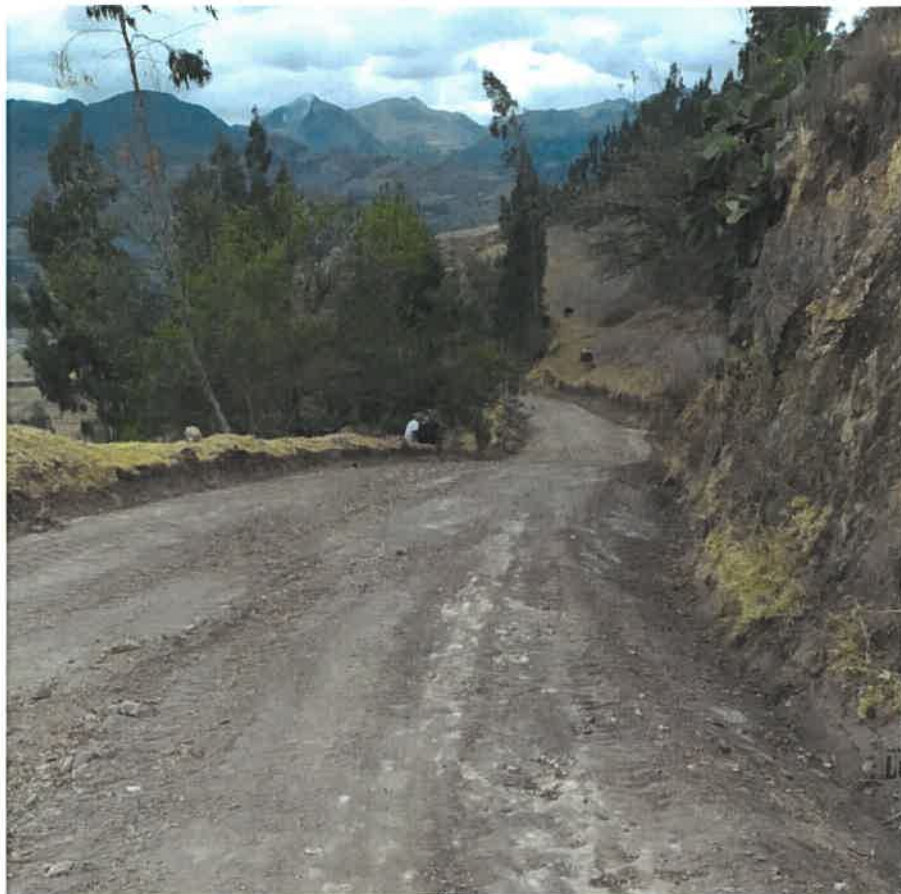
RECONFORMACIÓN DE CUNETAS KM 0+660
