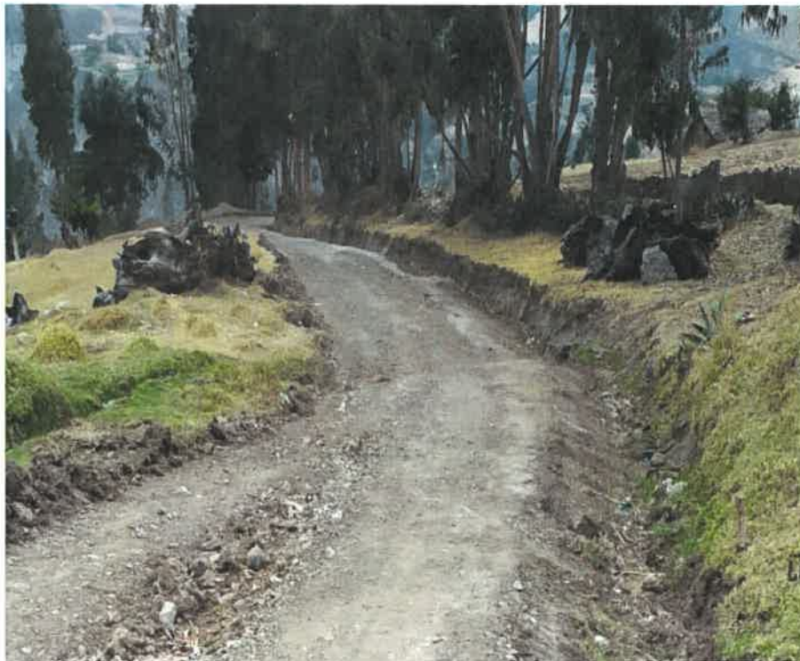
RECONFORMACIÓN DE CUNETAS KM 0+060
