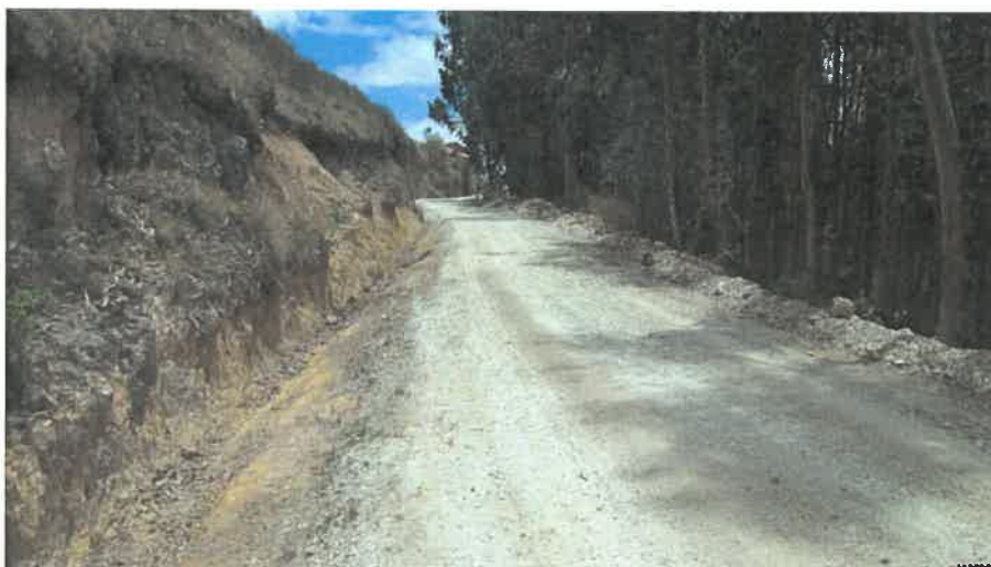
CAPA NIVELANTE KM 2+400
