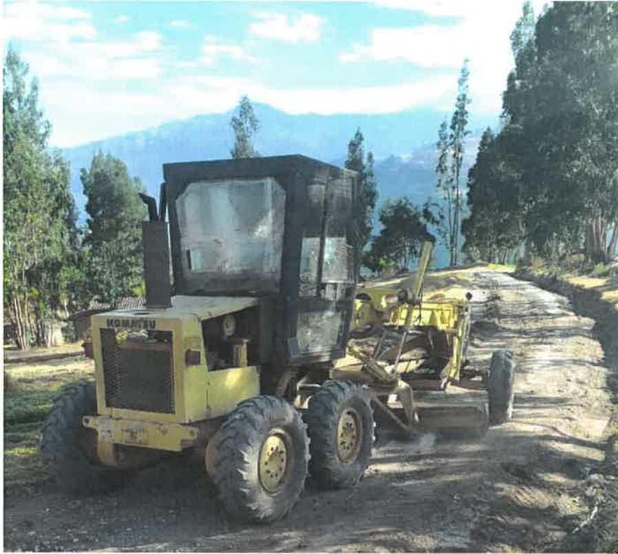
RECONFORMACIÓN DE CUNETAS
