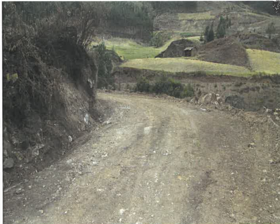
CAPA NIVELANTE KM 0+100
