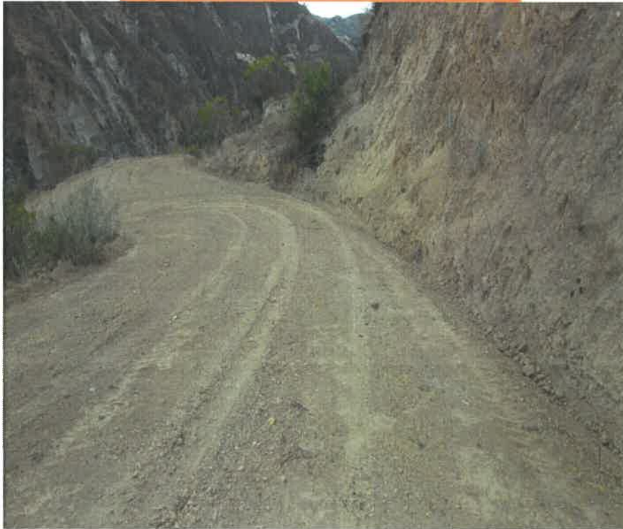
RECONFORMACIÓN DE CUNETAS Y CAPA NIVELANTE KM 4+100
