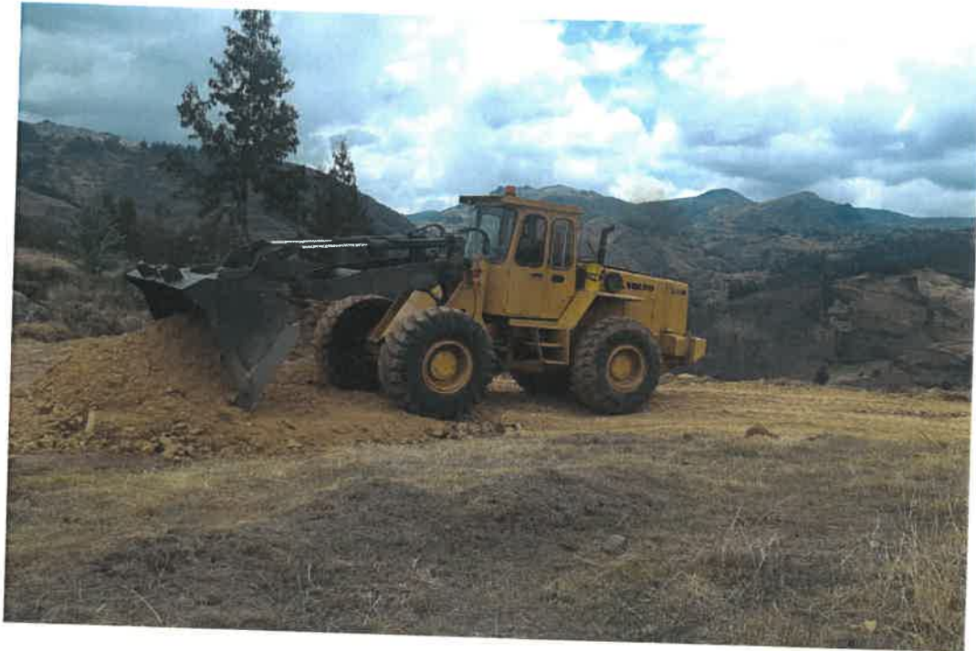
Se observa el trabajo con cargador frontal.
