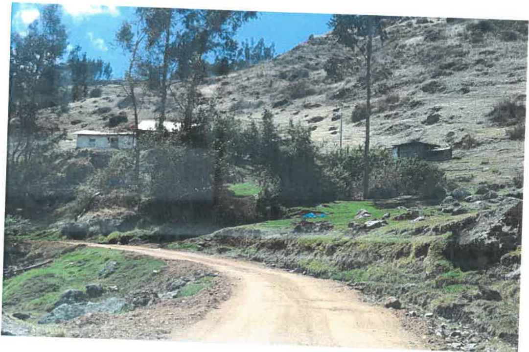
Se observa la conformación de la capa nivelante.
