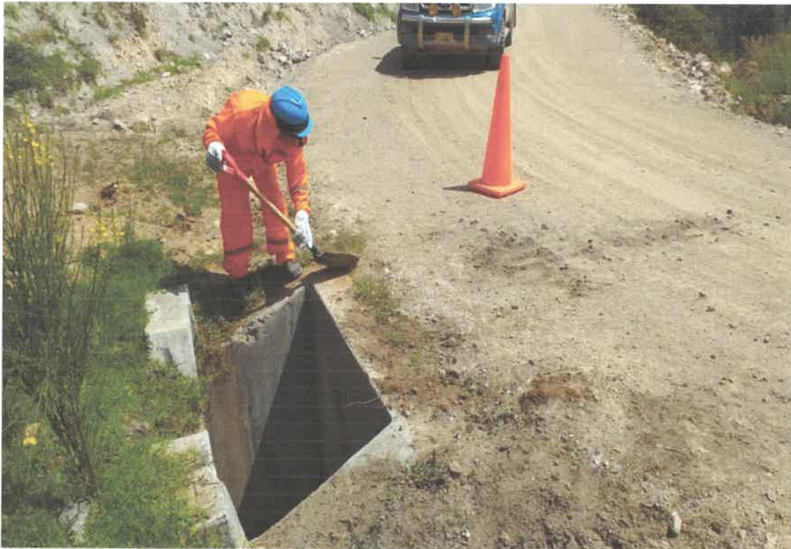
FOTO N° 11: Limpieza de alcantarilla
