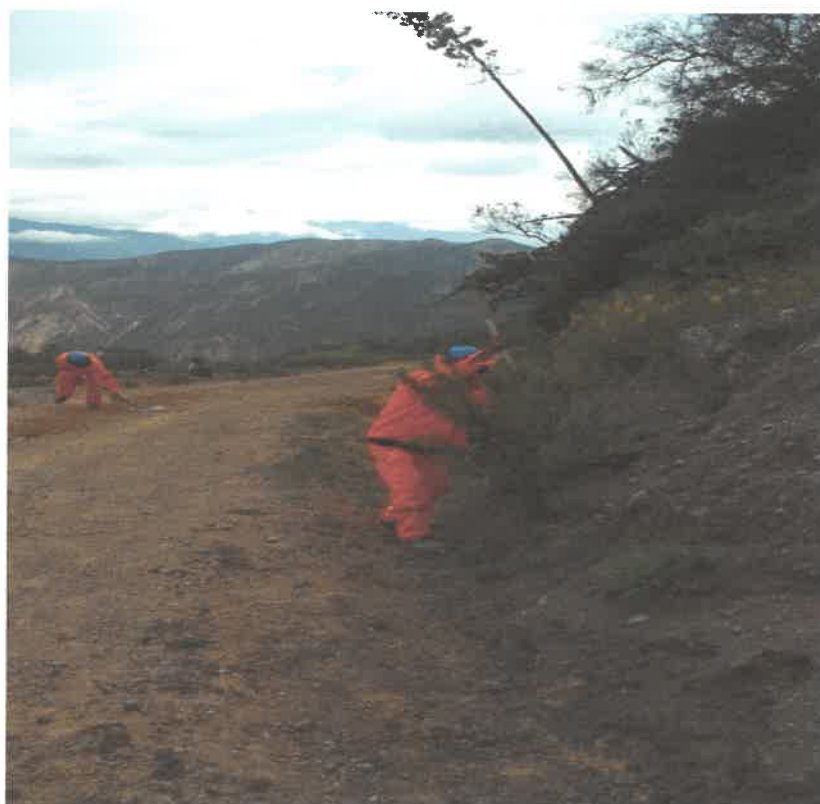
FOTO N° 6: Roce y limpieza
