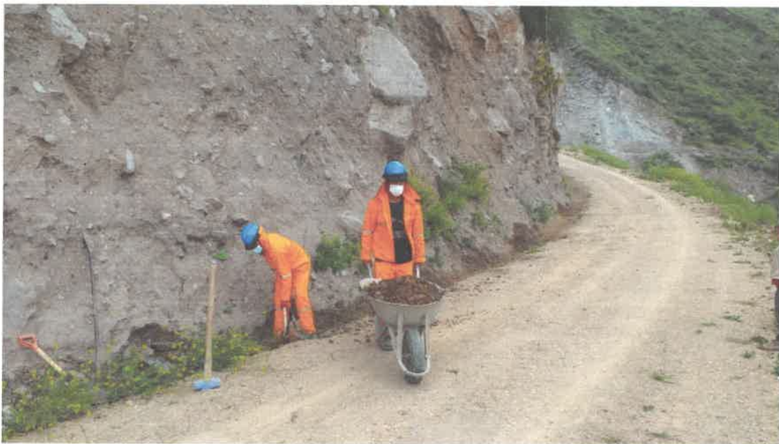
FOTO N° 2: Roca y limpieza
