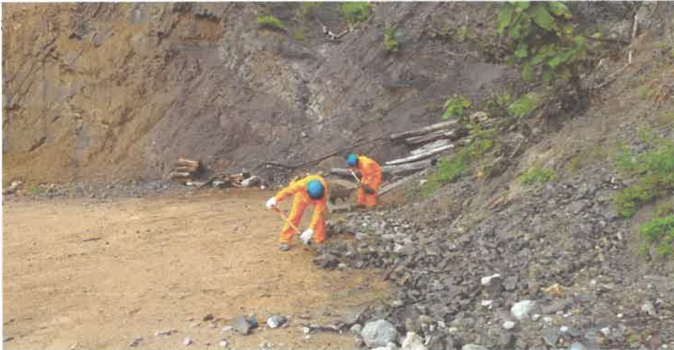
FOTO N° 8: Remoción de derrumbes
