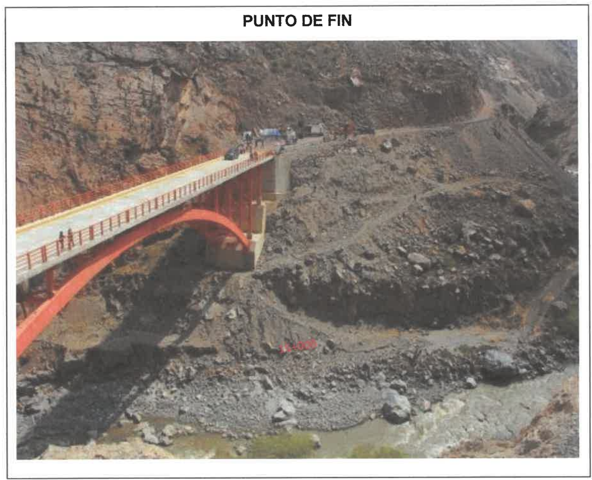
Foto N°02: PROGRESIVA 58+000 PUENTE HUANDA
