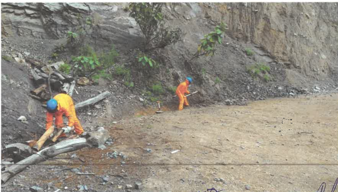
FOTO N° 9: Remoción de derrumbes
