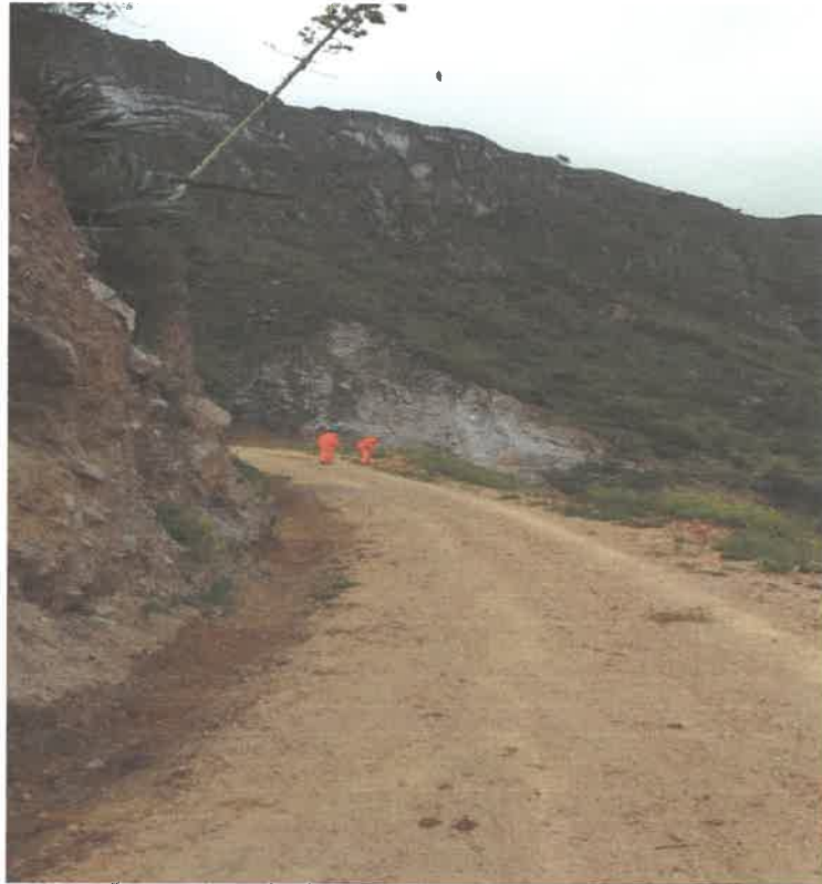
FOTO N°1: Limpieza de cunetas
