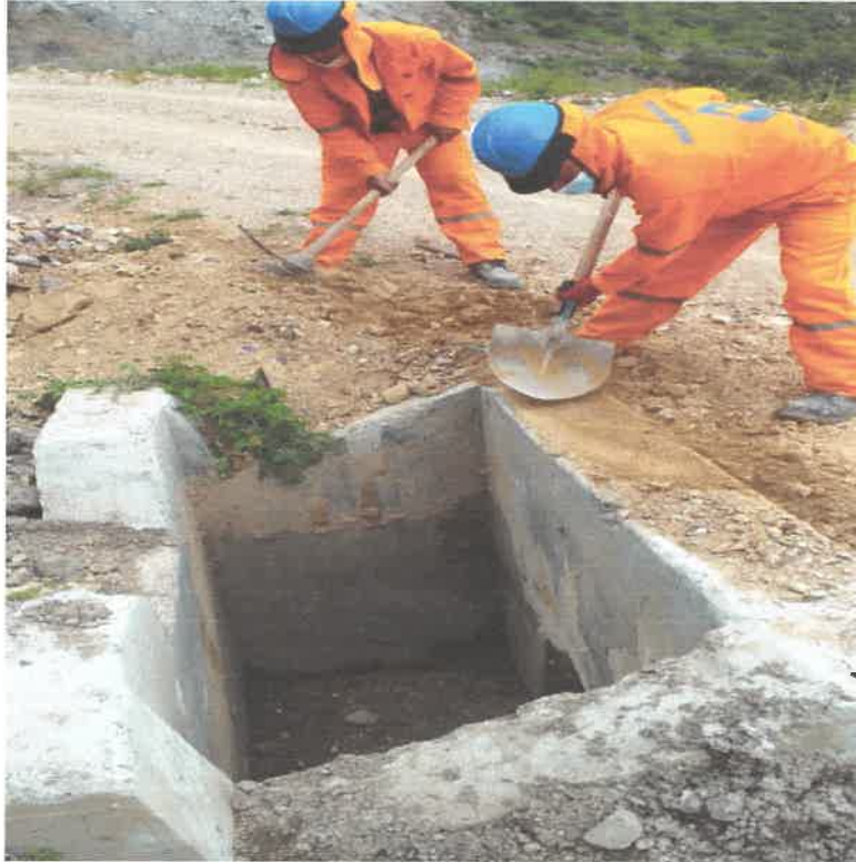
FOTO N° 3: Limpieza de alantarilla
