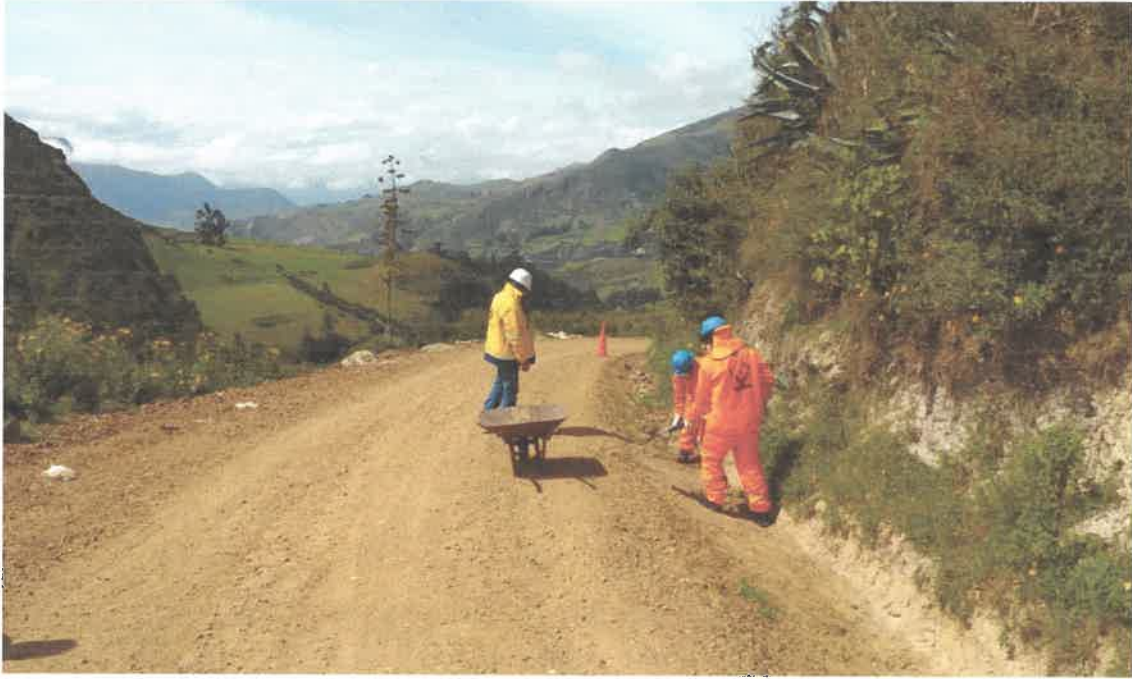
FOTO N°10: Limpieza de cunetas
