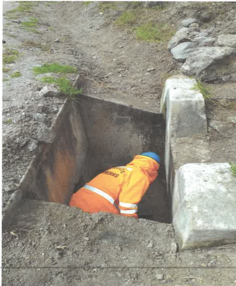
FOTO N° 4: Limpieza de alcantarilla
