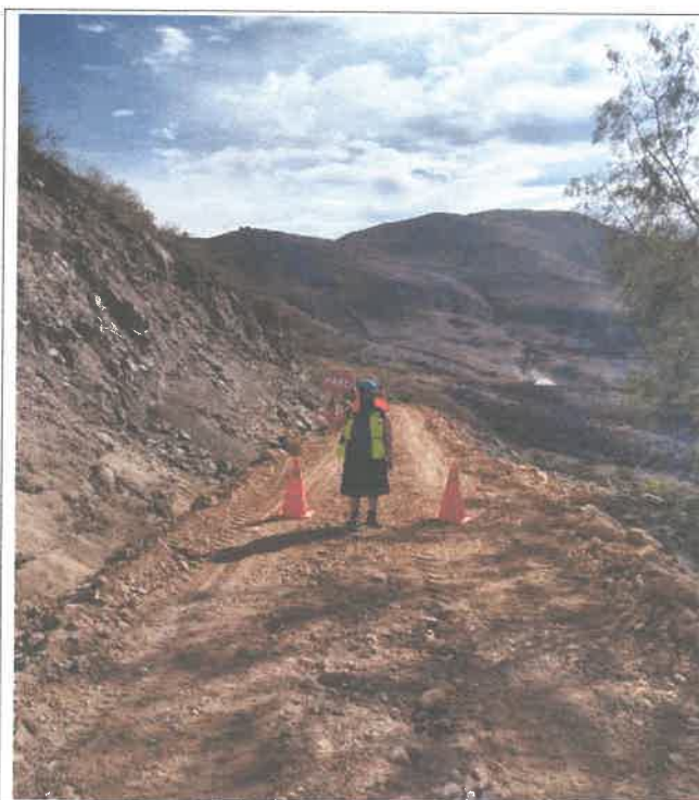
Vigía restringiendo el paso de vehículos, utilizando mascarillas, para protección del polvo.
