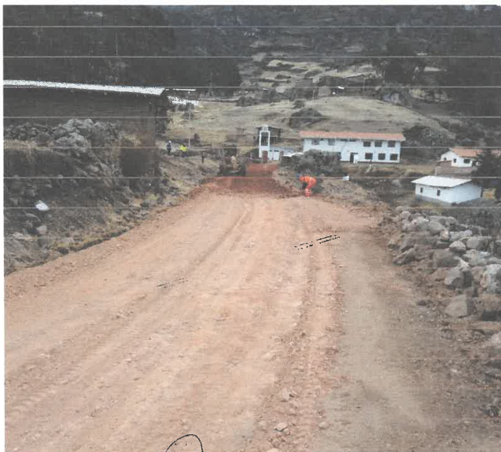
Inspección de extendido de material granular e = 15 \text{ cm} .
