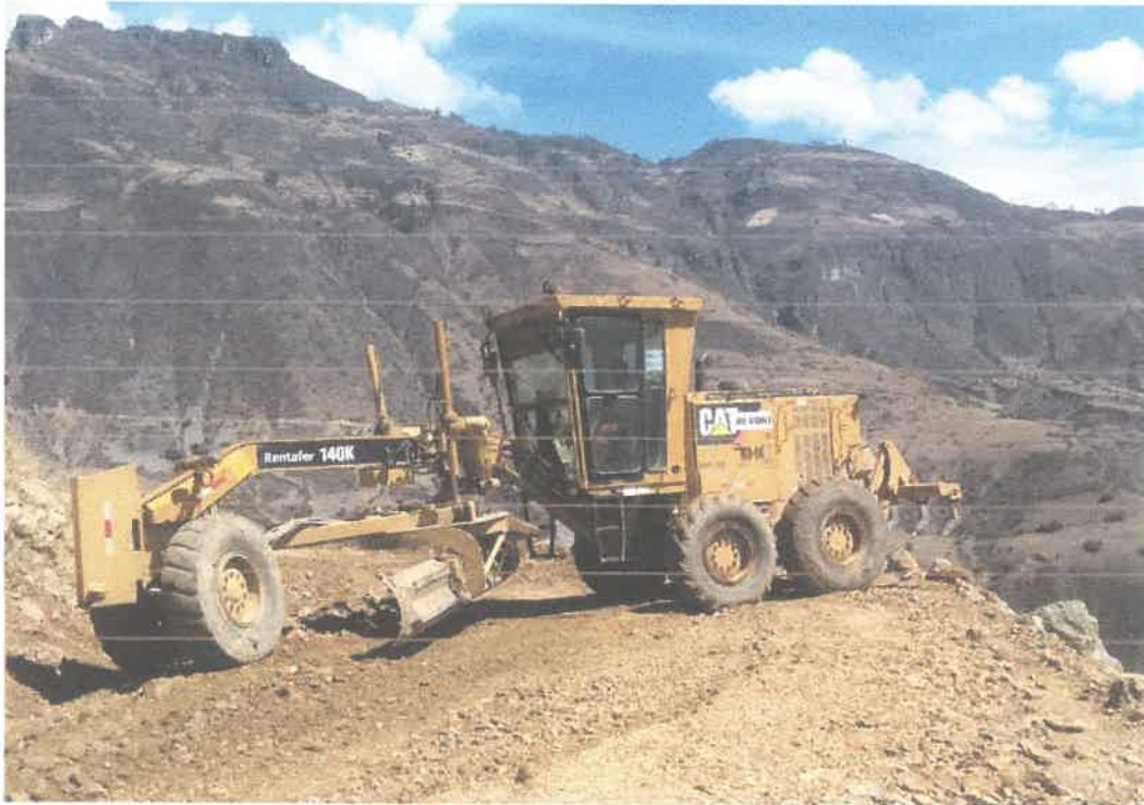
Inspección de los trabajos realizados por motoniveladora
