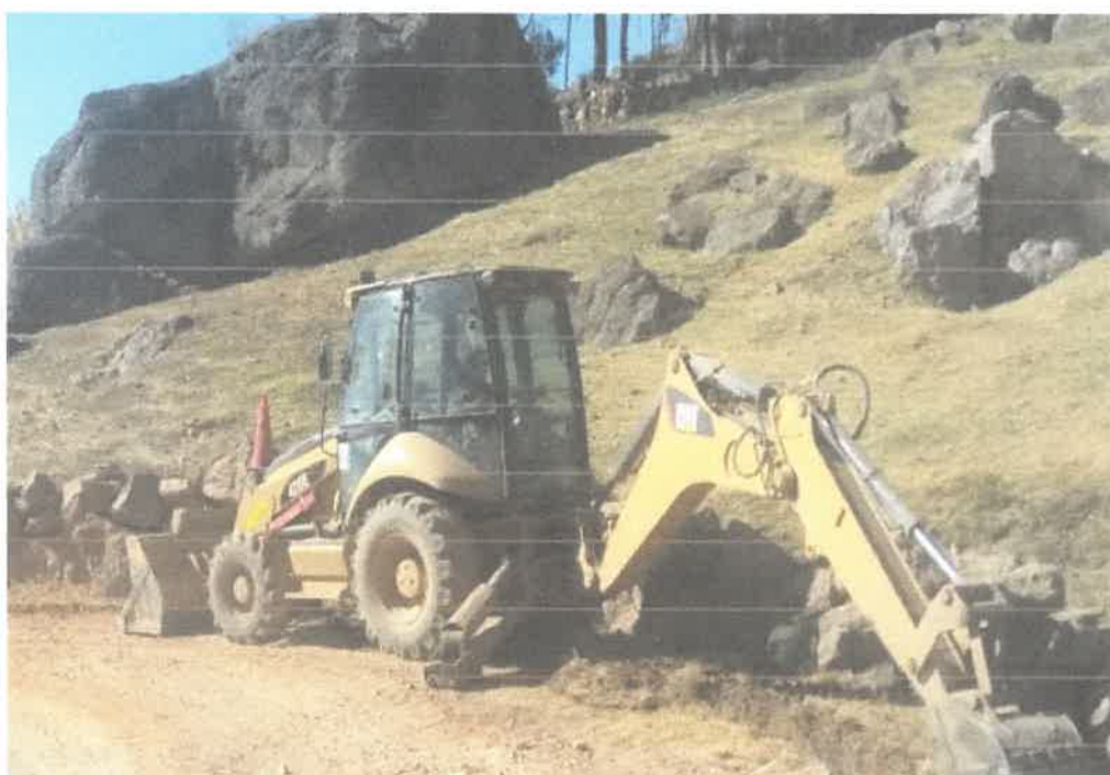
Limpieza de alcantarilla con retroexcavadora
