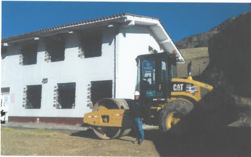
VERIFICANDO MOVILIZACION DE EQUIPOS (RODILLO LISO) AL LUGAR DE INICIO DEL SERVICIO
