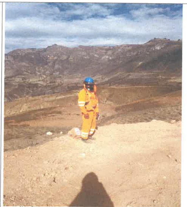
Maestro de obra inspeccionando los trabajos Debidamente uniformado con sus EPPs
