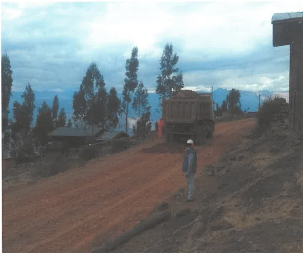
Inspección de los trabajos de transporte de material granular
