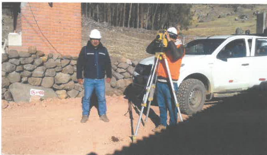
TRABAJO DE TRAZO Y REPLANTEO CON EQUIPO TOPOGRAFICO LOCLAIDAD DE PICHYAPAMPA
