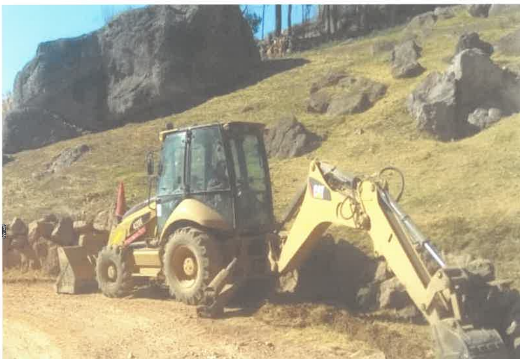
Limpieza de alcantarilla con retroexcavadora
