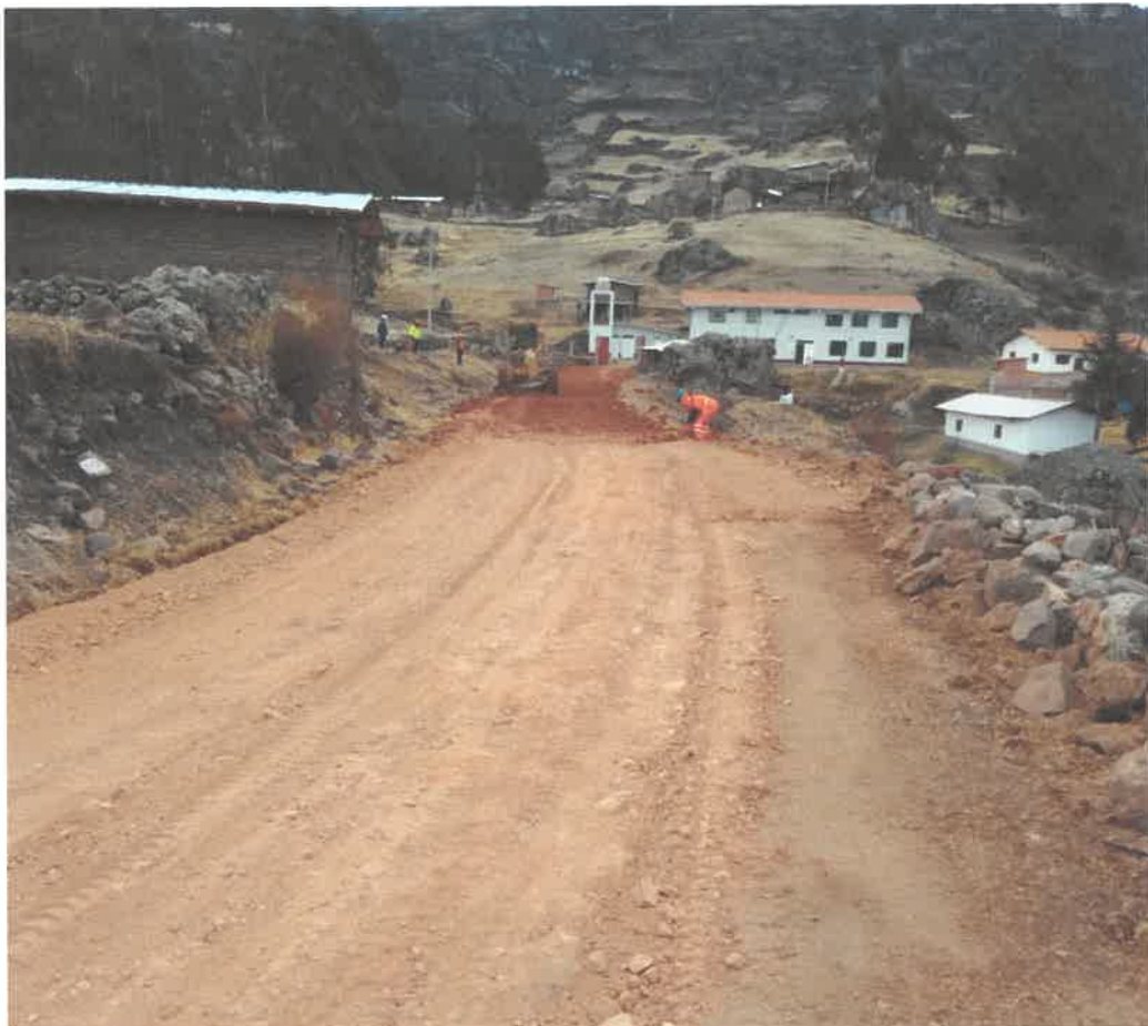
Inspección de extendido de material granular e = 15 cm.
