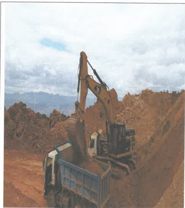
Extracción de material granular, 9081030N 807831E
