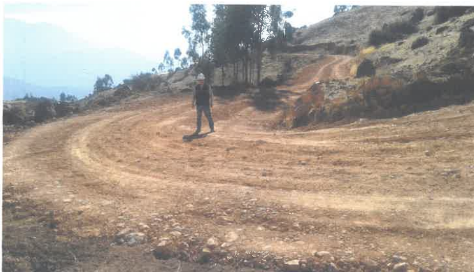
VERIFICANDO COLOCACION DE AFRIMADO EN CAMINO VECINAL PICHAYPAMPA
