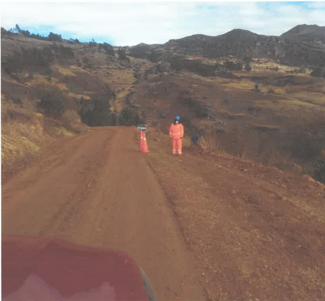
Inspección de los trabajos de seguridad y restricción de la vía.
