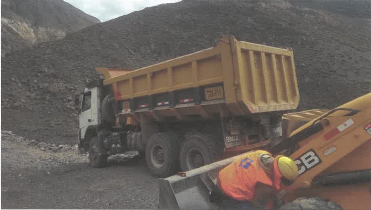
Inspección de los trabajos de extracción de material de cantera
