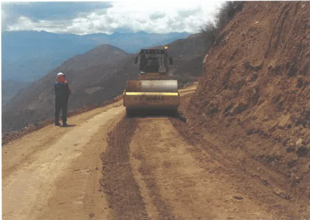
Inspección de los trabajos de colocación y compactado de material de cantera
