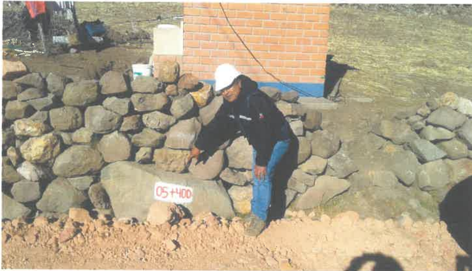
VERIFICANDO INICIO DE COLOCACION DE MATERIAL GRANULAR (AFIRMADO)
