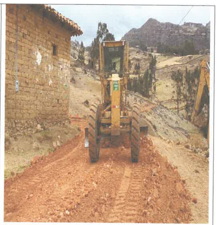
Colocación de material granular de cantera=0.15m ,9082146N 809784E
