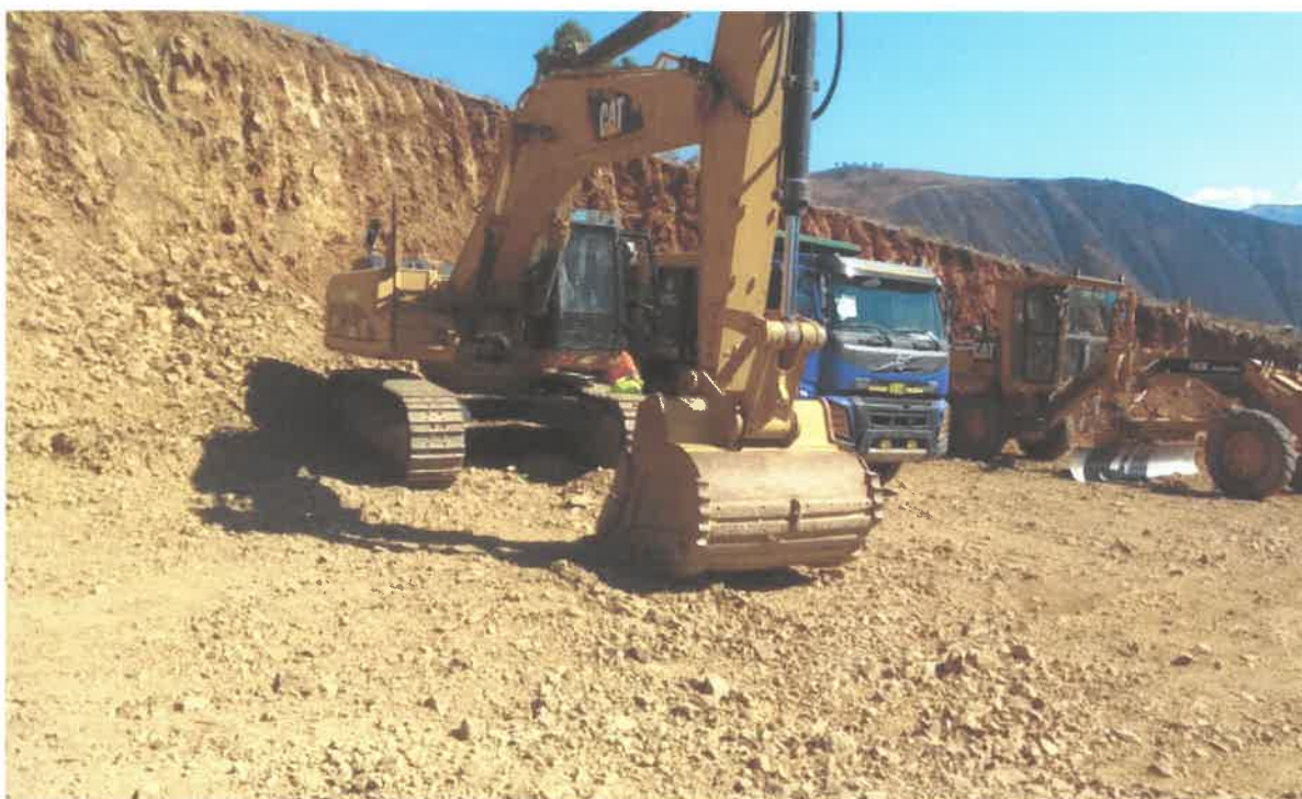
Inspección de los trabajos de extracción de material de cantera
