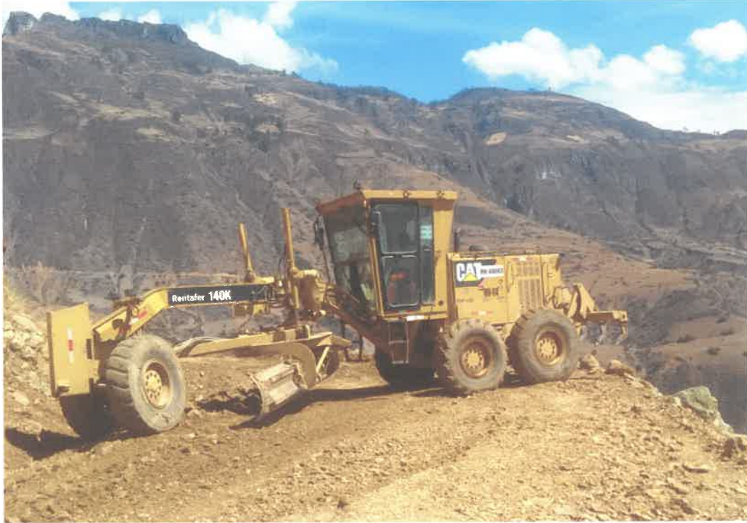
Inspección de los trabajos realizados por motoniveladora
