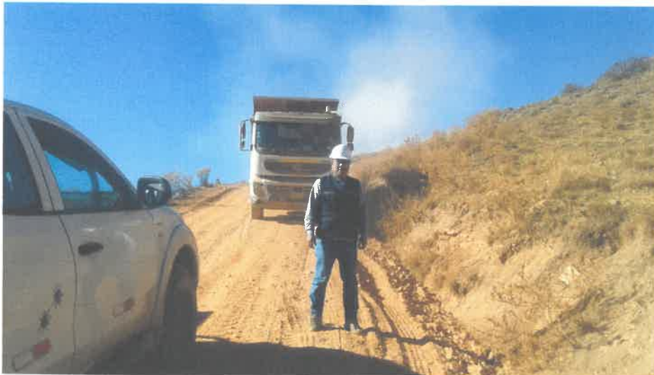
VERIFICANDO TRASPORTE DE MATERIAL GRANULAR PARA COLOCACION DE CAPA
