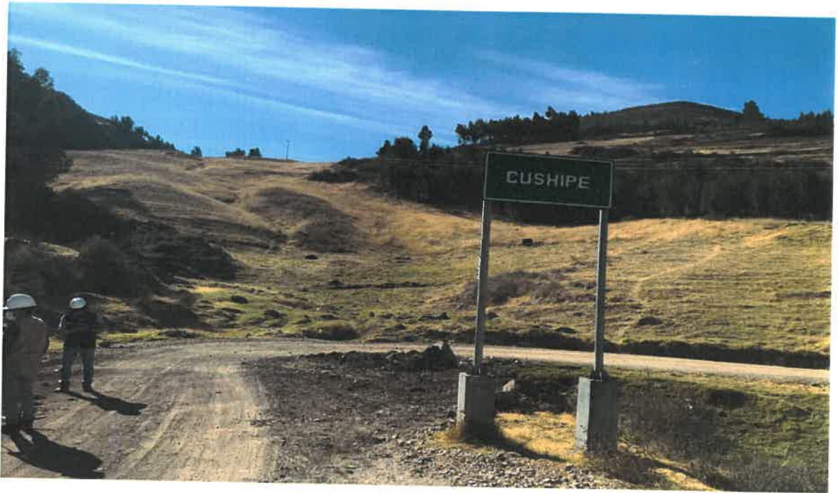
Se observa el trabajo de trazo y replanteo en el inicio del tramo prog 00+000. CUSHIPE - ARGALLAMA - EMP. PE-3N (LA CRUZ).
