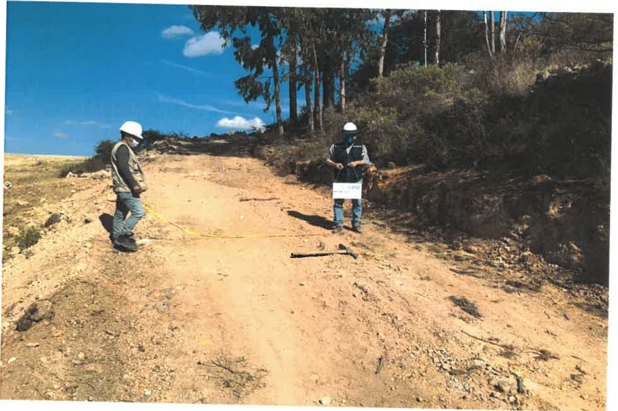
Se observa el trabajo de trazo y replanteo en el inicio del tramo prog 01+250. CUSHIPE - ARGALLAMA - EMP. PE-3N (LA CRUZ)
