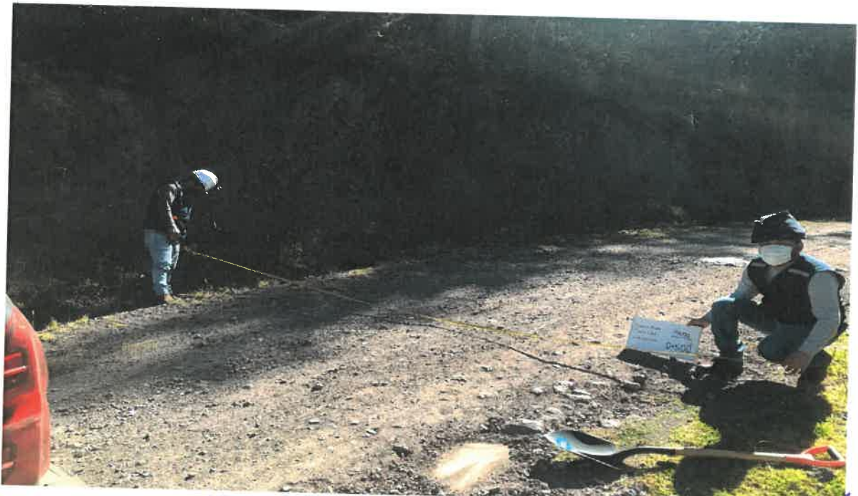
Se observa el trabajo de trazo y replanteo en el inicio del tramo prog 00+500. En SANTA ROSA - SANTA CRUZ DE CHUCA - LLATURPAMBA
