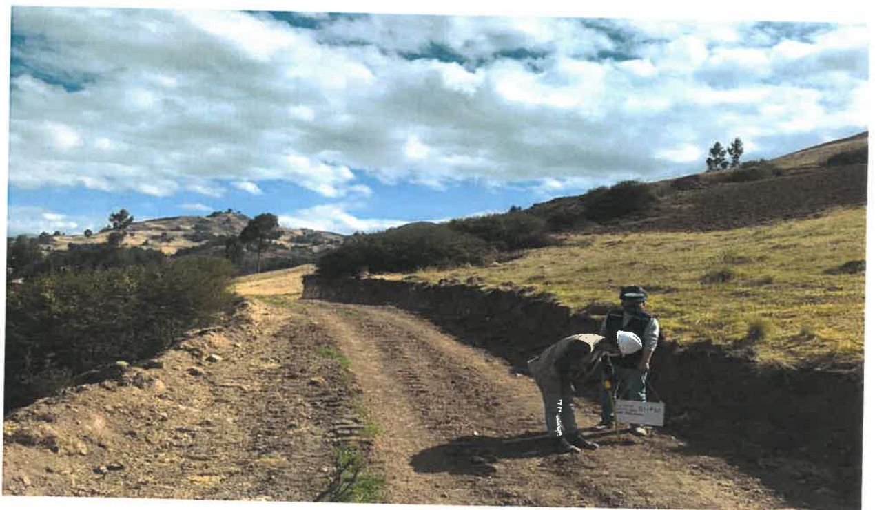
Se observa el trabajo de trazo y replanteo en el inicio del tramo prog 01+750. CUSHIPE - ARGALLAMA - EMP. PE-3N (LA CRUZ)
