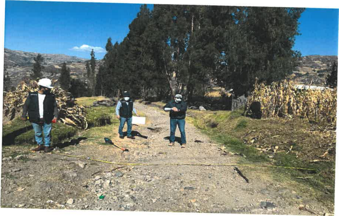
Se observa el trabajo de trazo y replanteo en el inicio del tramo prog 00+000. En SANTA ROSA - SANTA CRUZ DE CHUCA - LLATURPAMBA
