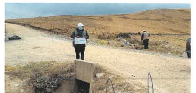
Foto N° S8: Vista de señalización (Desvío al Caserio Las Pajillas y Distrito de Quiruvilca) Km 21+010.
