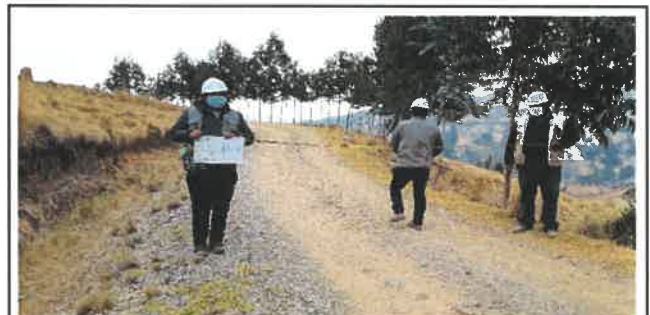
Foto N° Top76: Vista del ancho de la superficie de rodadura en el Km 18+750.
