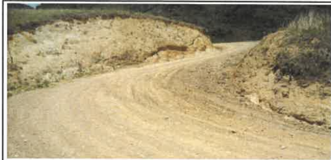
Foto N° Top113: Vista del ancho de la superficie de rodadura en el Km 28+000.
