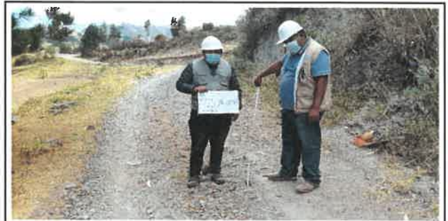
Foto N° VEP66: Vista del espesor del pavimento existente en el Km 16+250.
