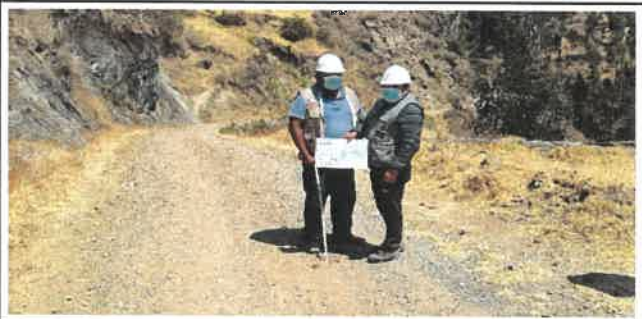
Foto N° VEP51: Vista del espesor del pavimento existente en el Km 12+500.
