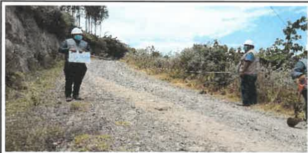
Foto N° Top69: Vista del ancho de la superficie de rodadura en el Km 17+000.
