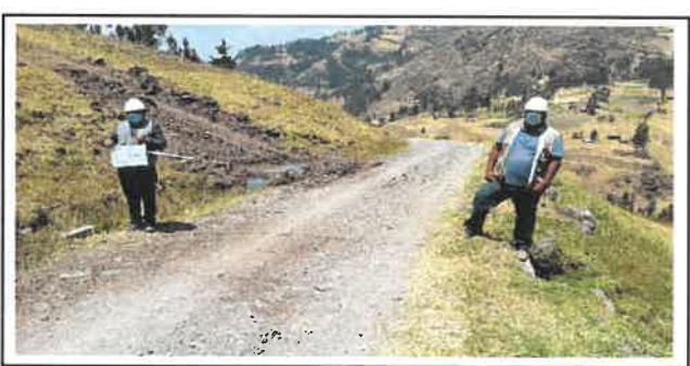
Foto N° OD38: Vista de alcantarilla en el Km 15+150.
