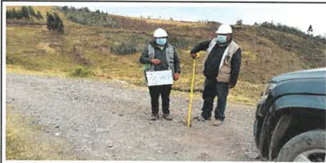
Foto N° VEP73: Vista del espesor del pavimento existente en el Km 18+000.
