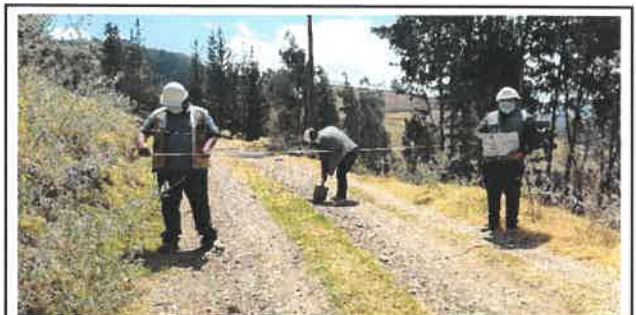
Foto N° Top52: Vista del ancho de la superficie de rodadura en el Km 12+750.
