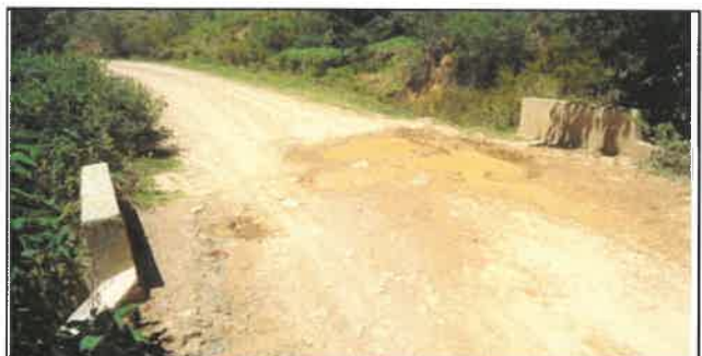
Foto N° OD78: Vista de alcantarilla en el Km 25+550.
