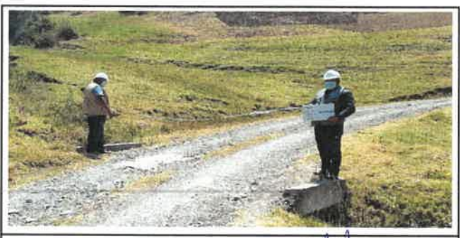
Foto N° OD31: Vista de alcantarilla en el Km 14+400.
