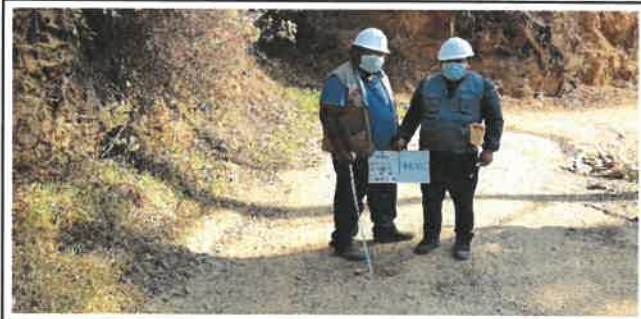
Foto N° VEP17: Vista del espesor del pavimento existente en el Km 04+000.
