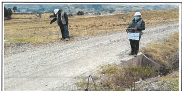
Foto N° OD64: Vista de alcantarilla en el Km 19+900.
