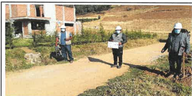
Foto N° OD3: Vista de Bajada de Agua en el Km 01+800.
