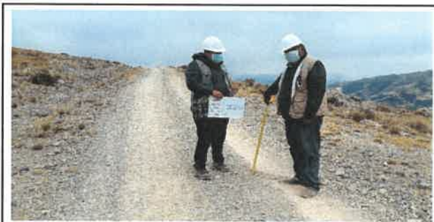
Foto N° VEP86: Vista del espesor del pavimento existente en el Km 21+250.
