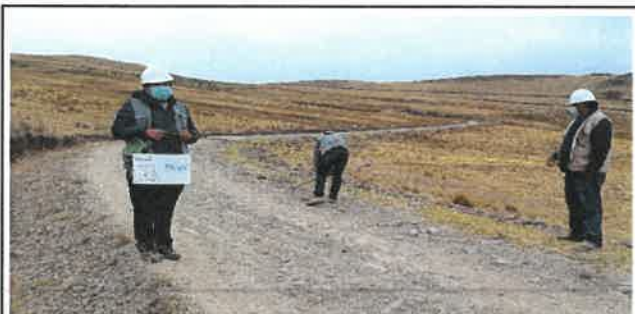
Foto N° Top79: Vista del ancho de la superficie de rodadura en el Km 19+500.
