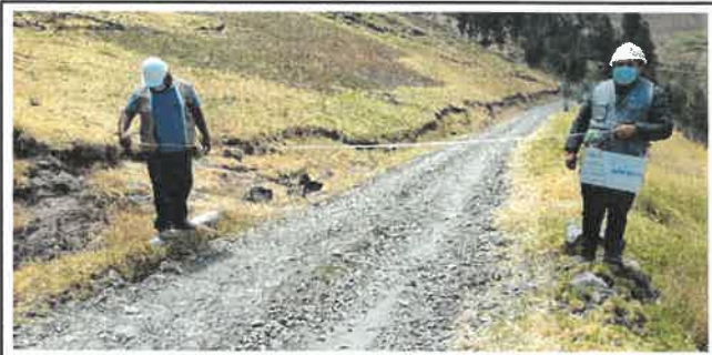
Foto N° OD41: Vista de Bajada de Agua en el Km 15+430.
