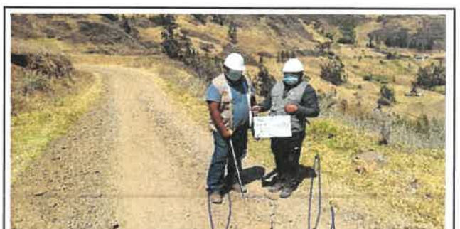
Foto N° VEP40: Vista del espesor del pavimento existente en el Km 09+750.
