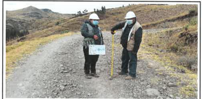
Foto N° VEP74: Vista del espesor del pavimento existente en el Km 18+250.
