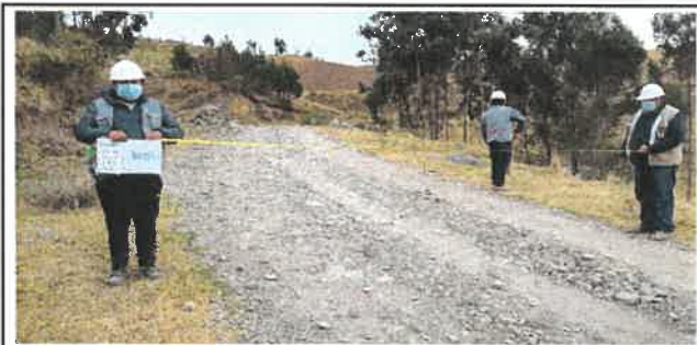
Foto N° Top75: Vista del ancho de la superficie de rodadura en el Km 18+500.
