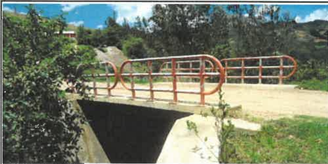
Foto N° OA11: Vista del Puente Definitivo en el Km 26+780.
