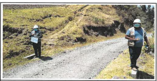
Foto N° OD37: Vista de alcantarilla en el Km 15+080.
