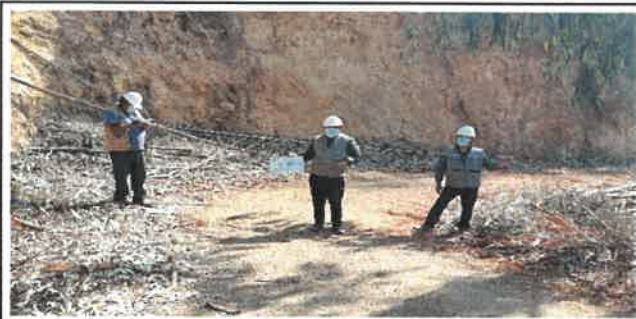
Foto N° OD9: Vista de Baden en el Km 4+650.
