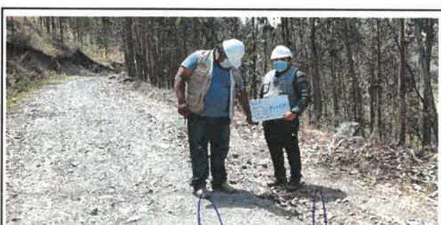
Foto N° VEP64: Vista del espesor del pavimento existente en el Km 15+750.
