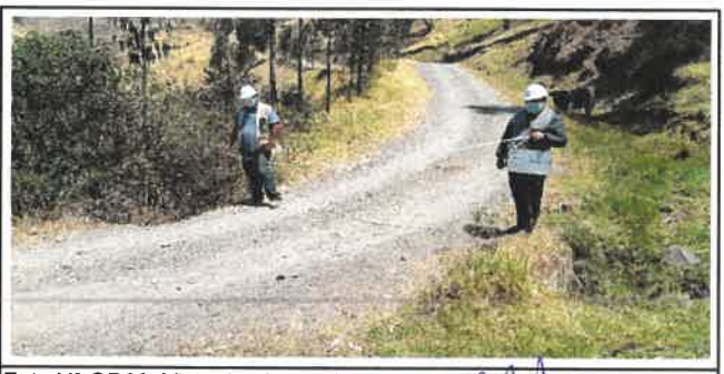
Foto N° OD39: Vista de alcantarilla en el Km 15+180.
