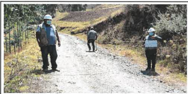
Foto N° Top61: Vista del ancho de la superficie de rodadura en el Km 15+000.
