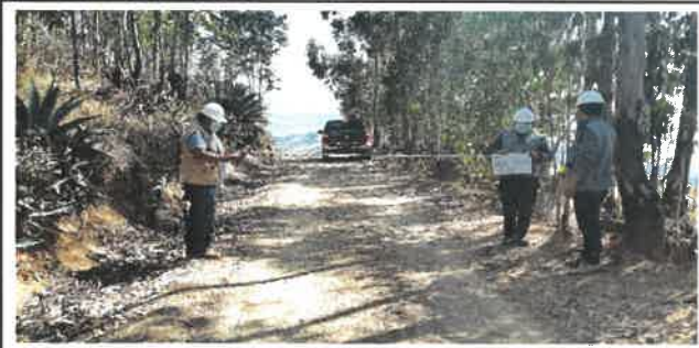
Foto N° Top35: Vista del ancho de la superficie de rodadura en el Km 08+500.
