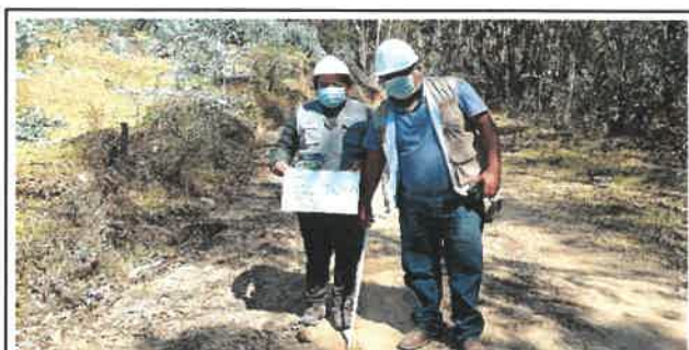
Foto N° VEP30: Vista del espesor del pavimento existente en el Km 07+250.
