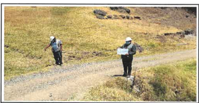
Foto N° OD29: Vista de alcantarilla en el Km 13+600.
