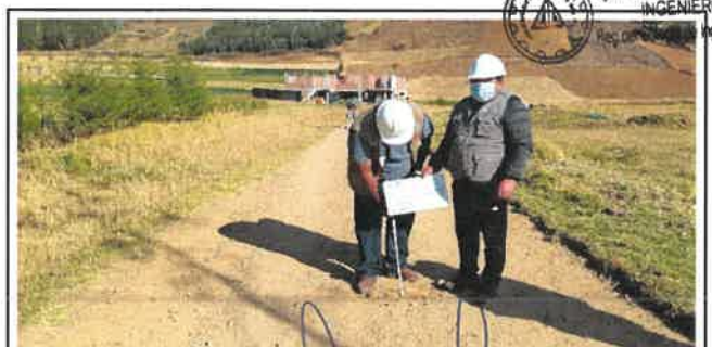
Foto N° VEP8: Vista del espesor del pavimento existente en el Km 01+750.
