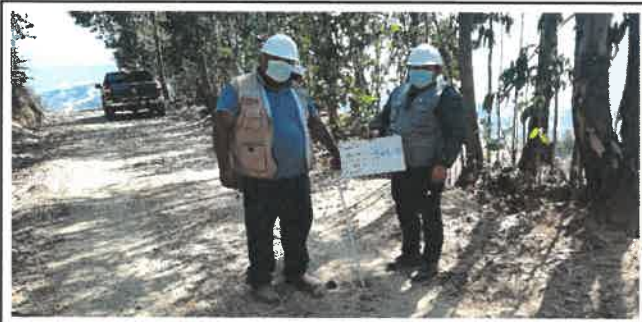
Foto N° VEP35: Vista del espesor del pavimento existente en el Km 08+500.
