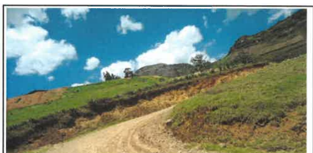
Foto N° Top110: Vista del ancho de la superficie de rodadura en el Km 27+250.
