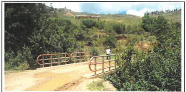
Foto N° OA12: Vista del Puente Definitivo en el Km 27+660.
