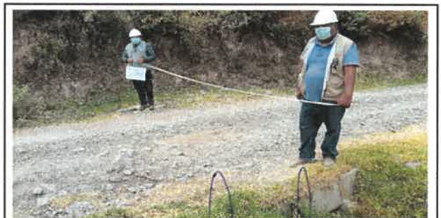
Foto N° OD48: Vista de alcantarilla en el Km 16+730.
