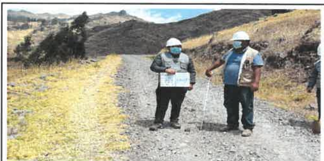
Foto N° VEP59: Vista del espesor del pavimento existente en el Km 14+500.
