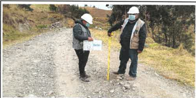
Foto N° VEP75: Vista del espesor del pavimento existente en el Km 18+500.
