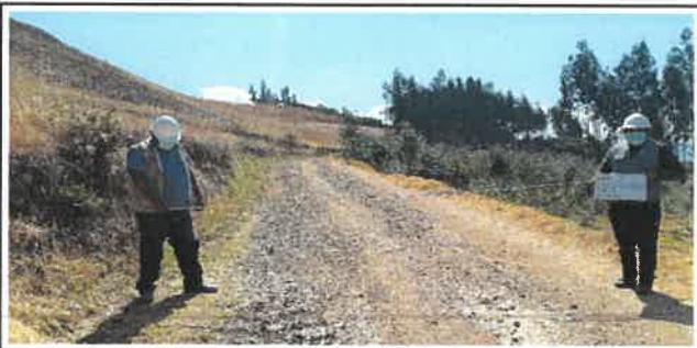
Foto N° Top31: Vista del ancho de la superficie de rodadura en el Km 07+500.
