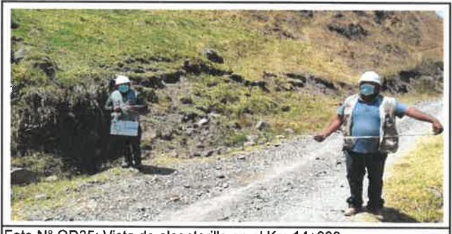
Foto N° OD35: Vista de alcantarilla en el Km 14+830.
