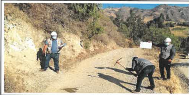
Foto N° Top1: Vista del ancho de la superficie de rodadura en el Km 00+000.
