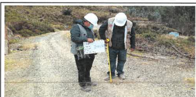
Foto N° VEP95: Vista del espesor del pavimento existente en el Km 23+500.
