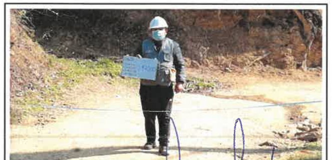
Foto N° DSR16: Se aprecia falla por erosión dañando al pavimento (Km 03+750 hasta Km 04+000.)
