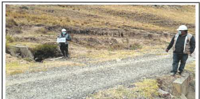
Foto N° OD70: Vista de alcantarilla en el Km 23+270.
