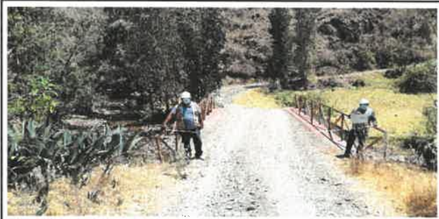
Foto N° OA9: Vista del Puente Definitivo en el Km 13+830.
