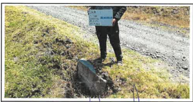
Foto N° OD32: Vista de alcantarilla en el Km 14+550.
