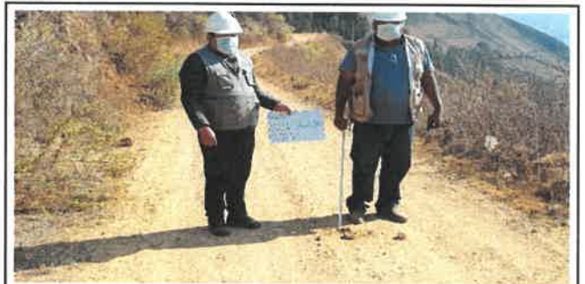
Foto N° VEP18: Vista del espesor del pavimento existente en el Km 04+250.
