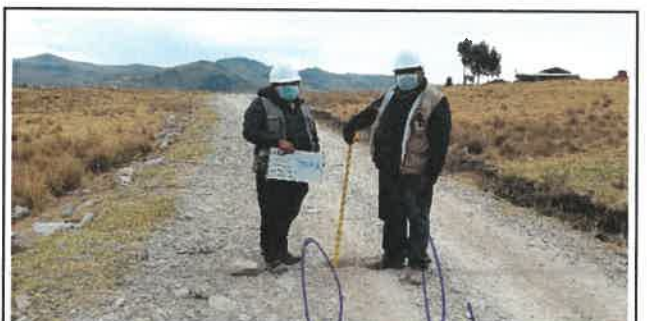
Foto N° VEP80: Vista del espesor del pavimento existente en el Km 19+750.
