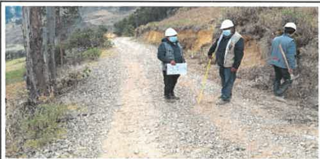
Foto N° VEP99: Vista del espesor del pavimento existente en el Km 24+500.
