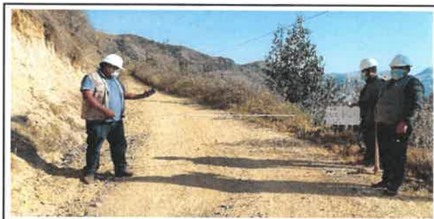
Foto N° Top10: Vista del ancho de la superficie de rodadura en el Km 02+250.
