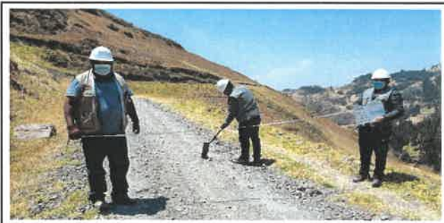
Foto N° Top59: Vista del ancho de la superficie de rodadura en el Km 14+500.
