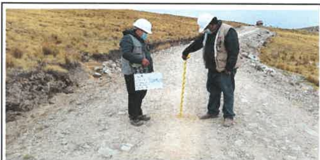
Foto N° VEP83: Vista del espesor del pavimento existente en el Km 20+500.
