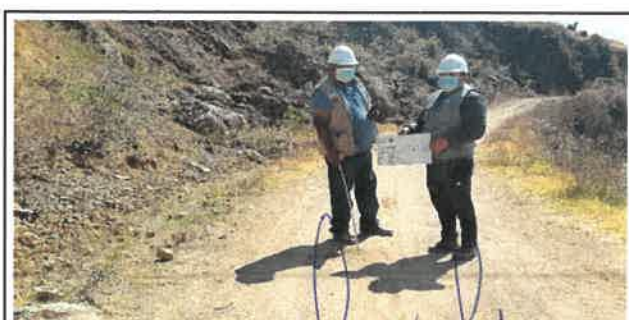
Foto N° VEP32: Vista del espesor del pavimento existente en el Km 07+750.
