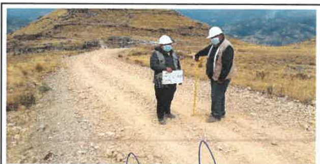
Foto N° VEP88: Vista del espesor del pavimento existente en el Km 21+750.
