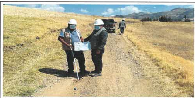
Foto N° VEP37: Vista del espesor del pavimento existente en el Km 09+000.
