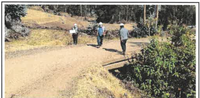
Foto N° OA4: Vista del Pontón Estructural Artesanal el Km 6+900.
