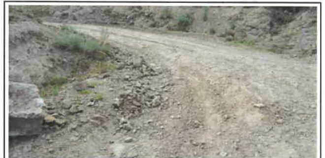
Foto N° VEP116: Vista del espesor del pavimento existente en el Km 27+600.
