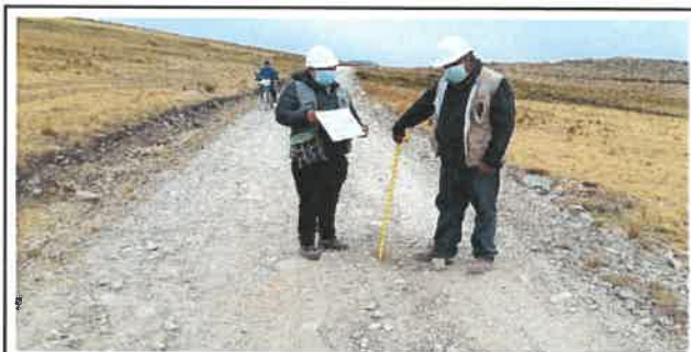
Foto N° VEP84: Vista del espesor del pavimento existente en el Km 20+750.
