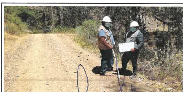
Foto N° VEP48: Vista del espesor del pavimento existente en el Km 11+750.
