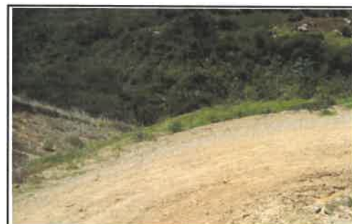
Foto N° Top116: Vista del ancho de la superficie de rodadura en el Km 28+600.
