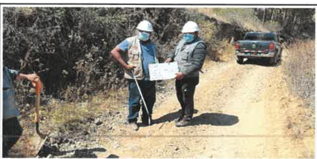
Foto N° VEP39: Vista del espesor del pavimento existente en el Km 09+500.
