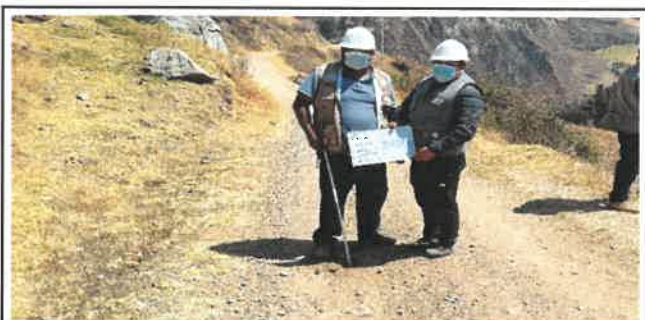
Foto N° VEP45: Vista del espesor del pavimento existente en el Km 11+000.
