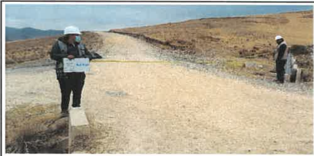
Foto N° OD65: Vista de alcantarilla en el Km 21+010.
