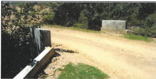
Foto N° OD77: Vista de alcantarilla en el Km 25+470.
