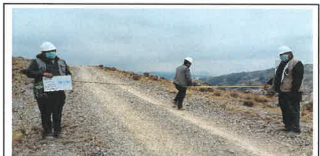
Foto N° Top86: Vista del ancho de la superficie de rodadura en el Km 21+250.
