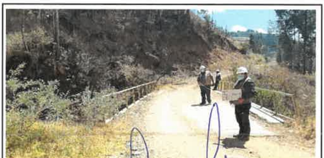
Foto N° OA8: Vista del Puente Definitivo en el Km 12+700.
