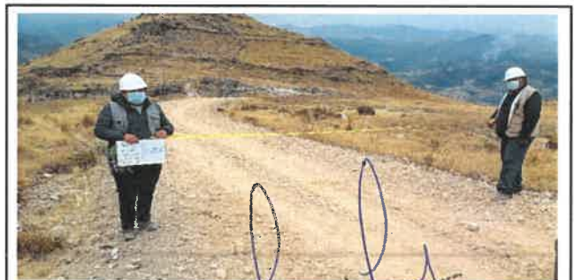
Foto N° Top88: Vista del ancho de la superficie de rodadura en el Km 21+750.
