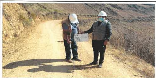
Foto N° VEP21: Vista del espesor del pavimento existente en el Km 05+000.
