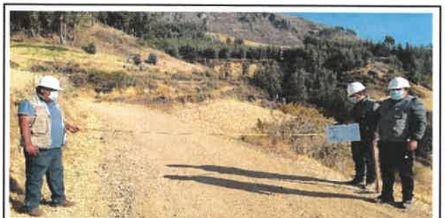
Foto N° Top4: Vista del ancho de la superficie de rodadura en el Km 00+750.
