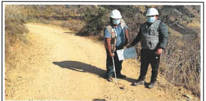
Foto N° VEP12: Vista del espesor del pavimento existente en el Km 02+750.
