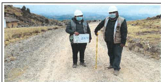
Foto N° VEP90: Vista del espesor del pavimento existente en el Km 22+250.
