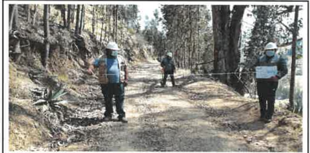
Foto N° Top50: Vista del ancho de la superficie de rodadura en el Km 12+250.
