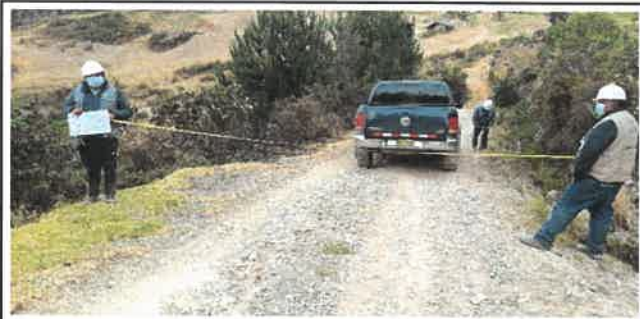
Foto N° O73: Vista de Bajada de Agua en el Km 23+900.
