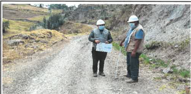
Foto N° VEP67: Vista del espesor del pavimento existente en el Km 16+500.
