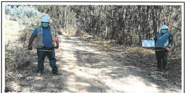
Foto N° Top30: Vista del ancho de la superficie de rodadura en el Km 07+250.
