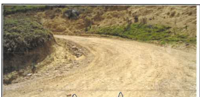
Foto N° Top112: Vista del ancho de la superficie de rodadura en el Km 27+750.
