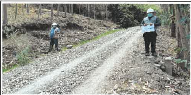
Foto N° OD45: Vista de alcantarilla en el Km 16+020.
