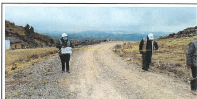
Foto N° Top90: Vista del ancho de la superficie de rodadura en el Km 22+250.
