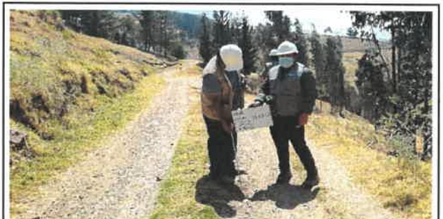
Foto N° VEP52: Vista del espesor del pavimento existente en el Km 12+750.
