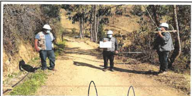
Foto N° Top16: Vista del ancho de la superficie de rodadura en el Km 03+750.
