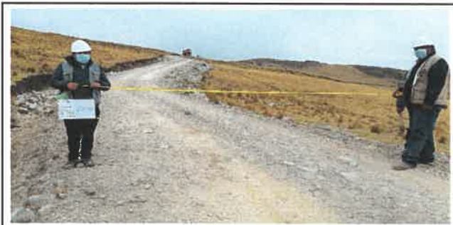
Foto N° Top83: Vista del ancho de la superficie de rodadura en el Km 20+500.
