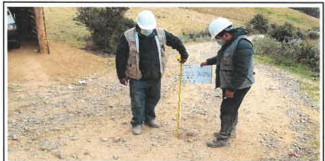
Foto N° VEP100: Vista del espesor del pavimento existente en el Km 24+750.
