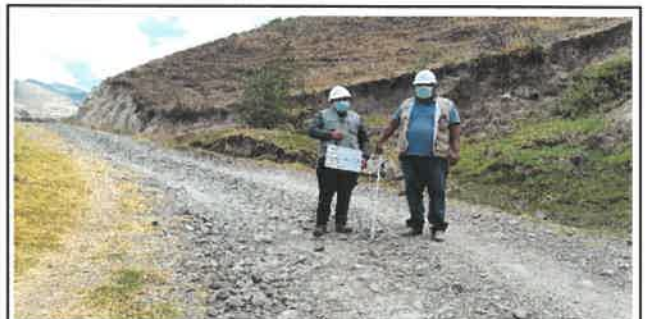
Foto N° VEP68: Vista del espesor del pavimento existente en el Km 16+750.
