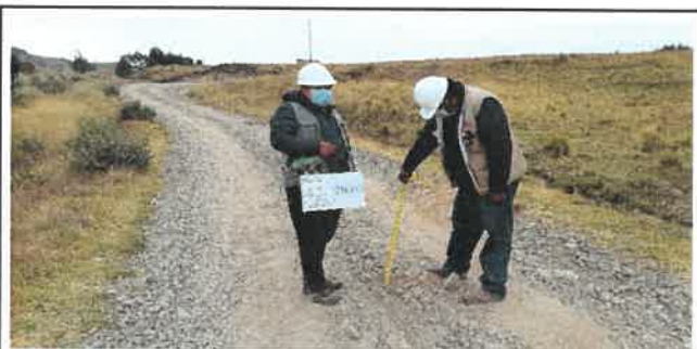
Foto N° VEP77: Vista del espesor del pavimento existente en el Km 19+000.
