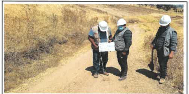
Foto N° VEP36: Vista del espesor del pavimento existente en el Km 08+750.
