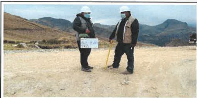
Foto N° VEP85: Vista del espesor del pavimento existente en el Km 21+000.
