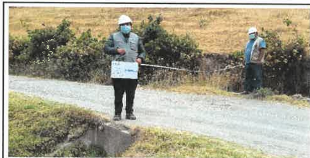
Foto N° OD50: Vista de alcantarilla en el Km 17+170.
