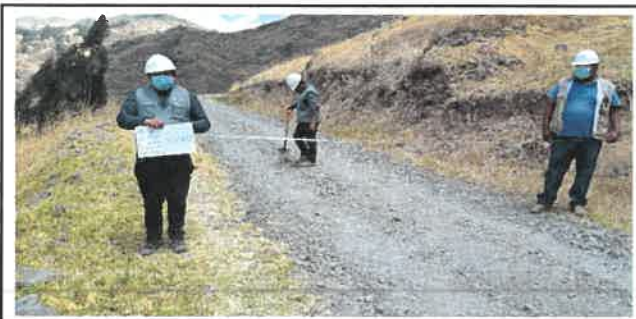
Foto N° Top63: Vista del ancho de la superficie de rodadura en el Km 15+500.
