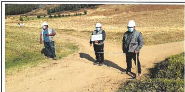
Foto N° OD4: Vista de Bajada de Agua en el Km 1+850.
