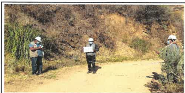
Foto N° OD6: Vista dealcantarilla en el Km 3+520.
