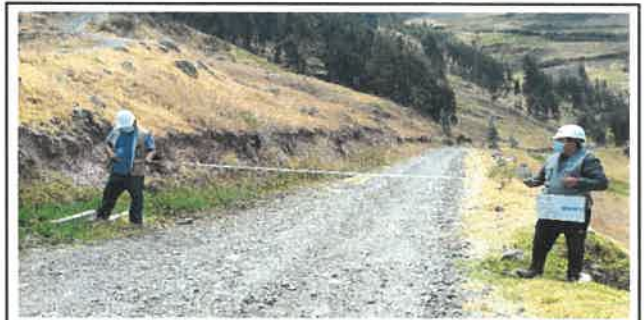
Foto N° OD42: Vista de alcantarilla en el Km 15+550.
