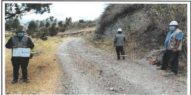
Foto N° Top66: Vista del ancho de la superficie de rodadura en el Km 16+250.
