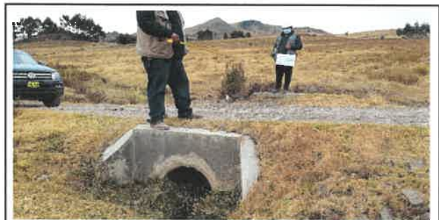
Foto N° OD60: Vista de alcantarilla en el Km 19+170.
