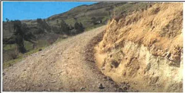
Foto N° VEP113: Vista del espesor del pavimento existente en el Km 28+000.
