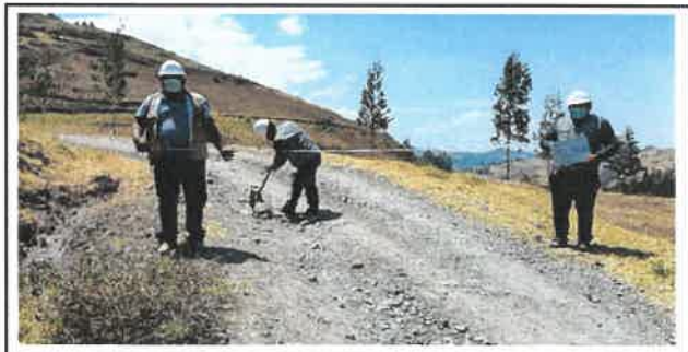
Foto N° Top58: Vista del ancho de la superficie de rodadura en el Km 14+250.
