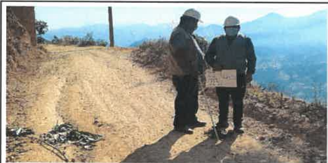
Foto N° VEP19: Vista del espesor del pavimento existente en el Km 04+500.
