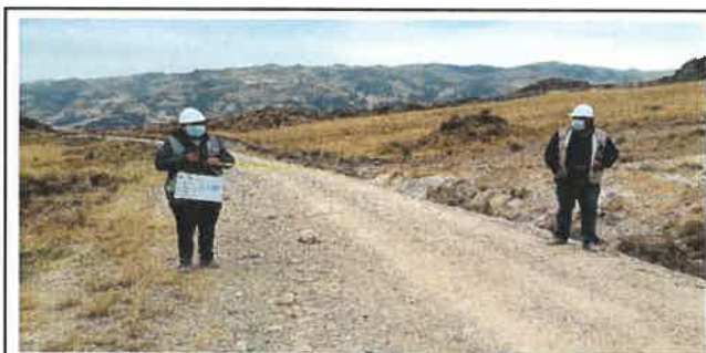
Foto N° Top89: Vista del ancho de la superficie de rodadura en el Km 22+000.
