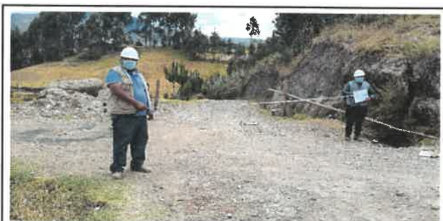
Foto N° OD51: Vista de alcantarilla en el Km 17+300.
