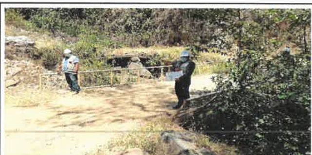
Foto N° OA7: Vista del Puente Definitivo en el Km 11+800.
