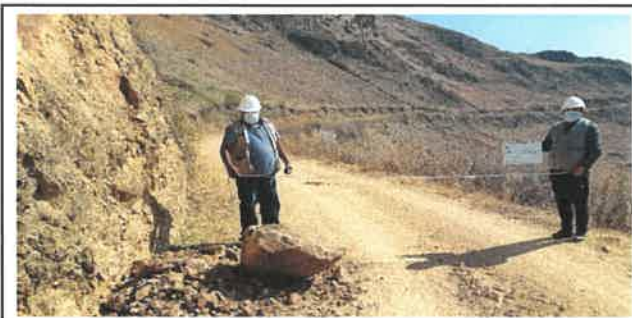
Foto N° Top21: Vista del ancho de la superficie de rodadura en el Km 05+000.
