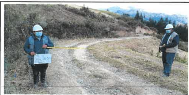
Foto N° Top103: Vista del ancho de la superficie de rodadura en el Km 25+500.
