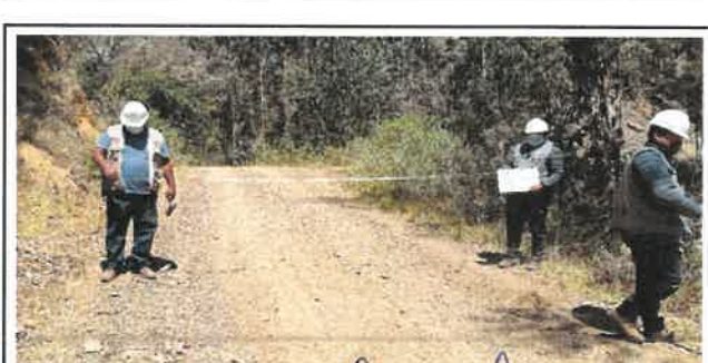
Foto N° Top48: Vista del ancho de la superficie de rodadura en el Km 11+750.
