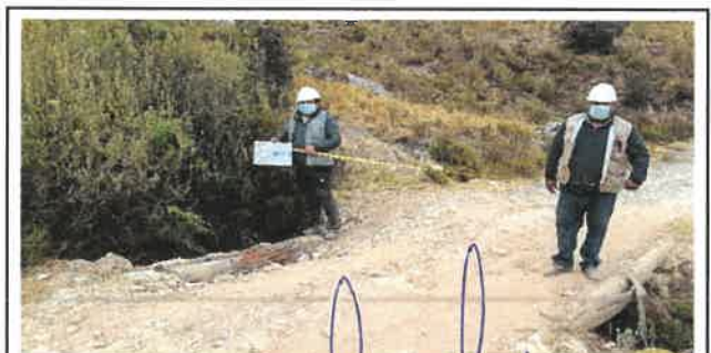
Foto N° OD72: Vista de alcantarilla en el Km 23+530.
