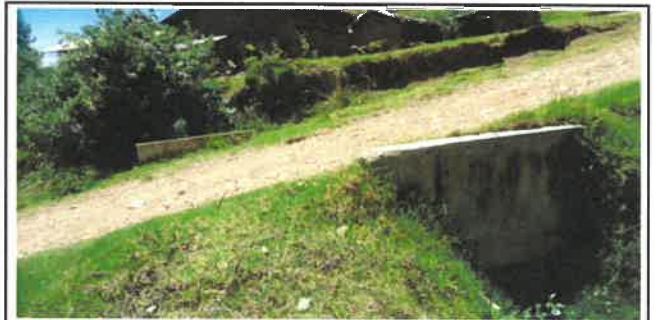
Foto N° OD82: Vista de alcantarilla en el Km 27+880.
