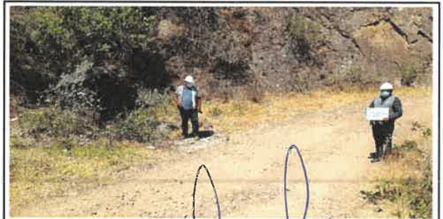
Foto N° OD16: Vista del Baden en el Km 10+300.
