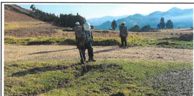
Foto N° OD8: Vista de alcantarilla en el Km 4+010.
