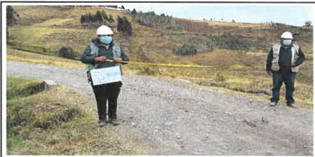
Foto N° Top73: Vista del ancho de la superficie de rodadura en el Km 18+000.
