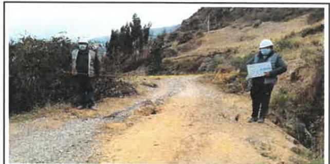
Foto N° OD74: Vista de alcantarilla en el Km 24+050.
