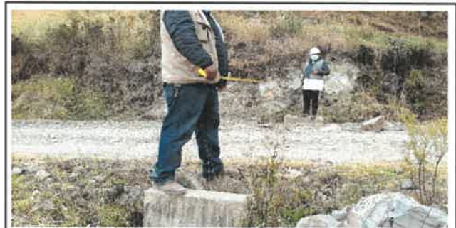
Foto N° OD58: Vista de alcantarilla en el Km 18+520.
