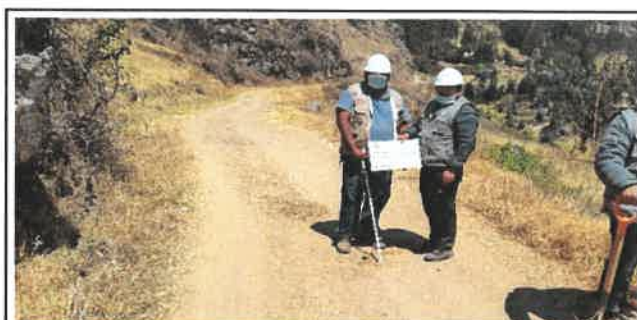
Foto N° VEP46: Vista del espesor del pavimento existente en el Km 11+250.
