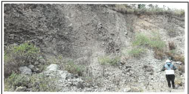
Foto N° CFA2: Vista de cantera Km 16+620
