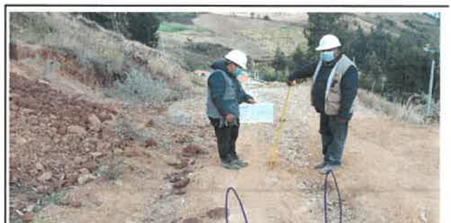
Foto N° VEP104: Vista del espesor del pavimento existente en el Km 25+750.
