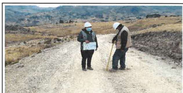
Foto N° VEP92: Vista del espesor del pavimento existente en el Km 22+750.
