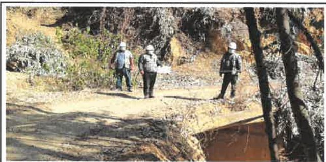
Foto N° OA3: Vista del Pontón Estructural Artesanal en el Km 04+600.
