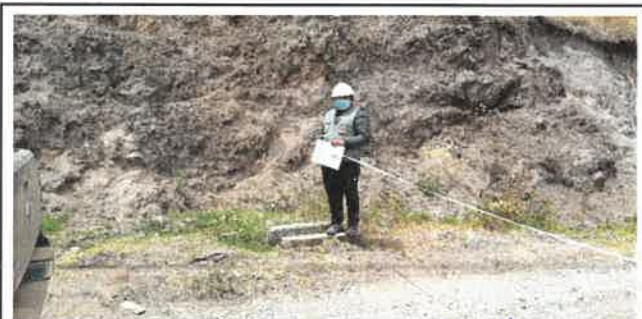
Foto N° OD47: Vista de alcantarilla en el Km 16+580.
