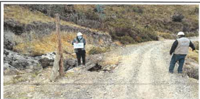
Foto N° OD71: Vista de Bajada de Agua en el Km 23+510.
