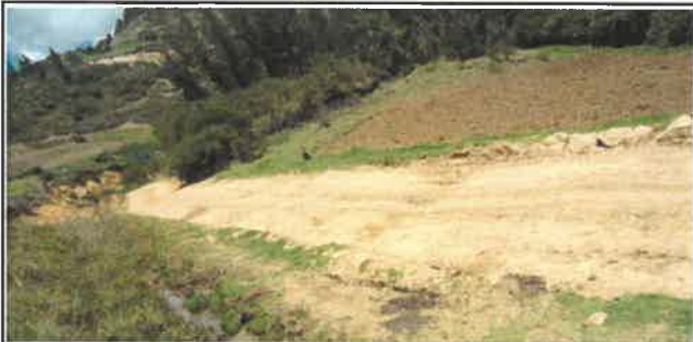
Foto N° Top105: Vista del ancho de la superficie de rodadura en el Km 26+000.
