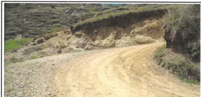
Foto N° Top115: Vista del ancho de la superficie de rodadura en el Km 28+500.
