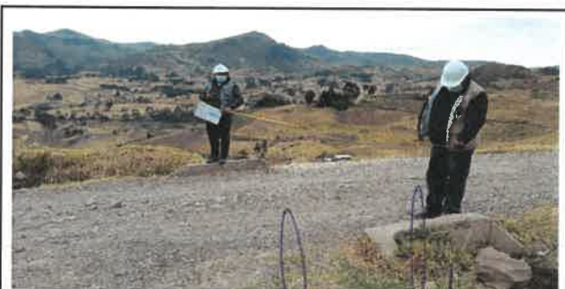
Foto N° OD56: Vista de alcantarilla en el Km 18+080.
