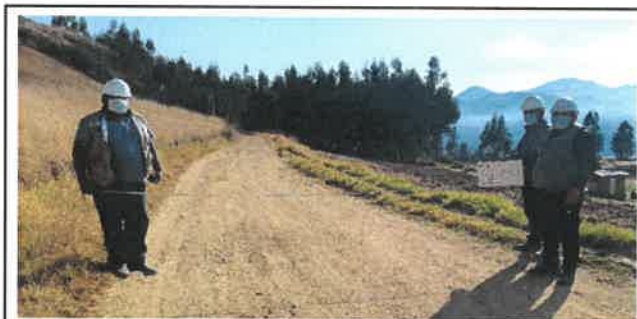
Foto N° Top9: Vista del ancho de la superficie de rodadura en el Km 02+000.
