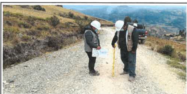
Foto N° VEP93: Vista del espesor del pavimento existente en el Km 23+000.
