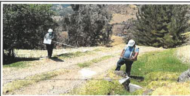
Foto N° OD23: Vista de alcantarilla en el Km 12+900.
