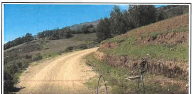
Foto N° OD80: Vista de alcantarilla en el Km 26+570.
