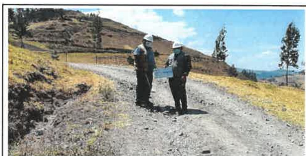
Foto N° VEP58: Vista del espesor del pavimento existente en el Km 14+250.
