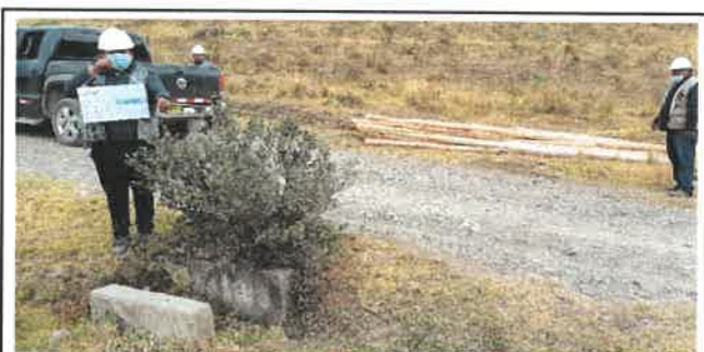
Foto N° OD53: Vista de alcantarilla en el Km 17+650.
