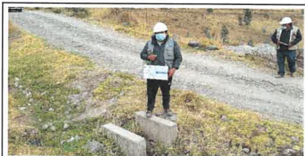
Foto N° OD52: Vista de alcantarilla en el Km 17+530.
