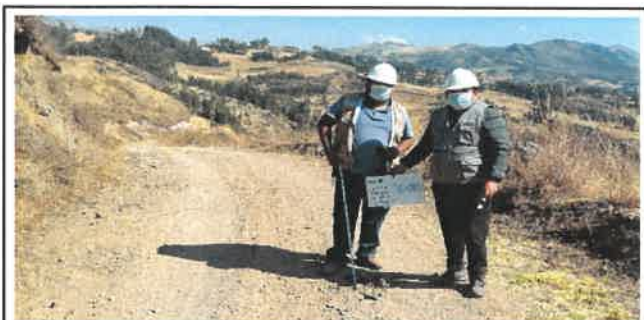
Foto N° VEP25: Vista del espesor del pavimento existente en el Km 06+000.
