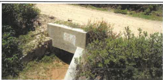
Foto N° OD79: Vista de alcantarilla en el Km 25+870.
