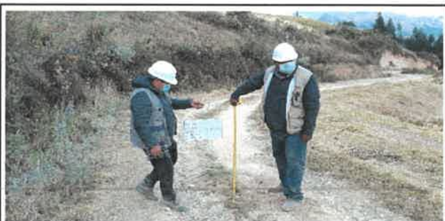
Foto N° VEP103: Vista del espesor del pavimento existente en el Km 25+500.
