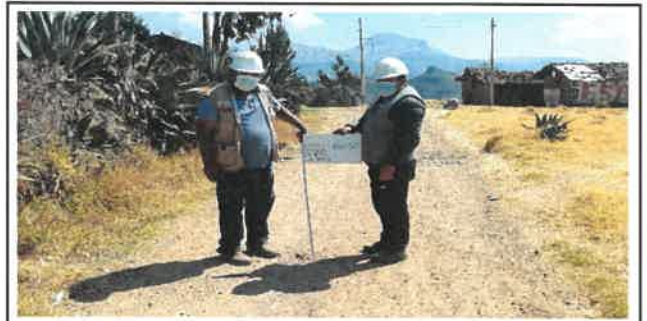
Foto N° VEP34: Vista del espesor del pavimento existente en el Km 08+250.
