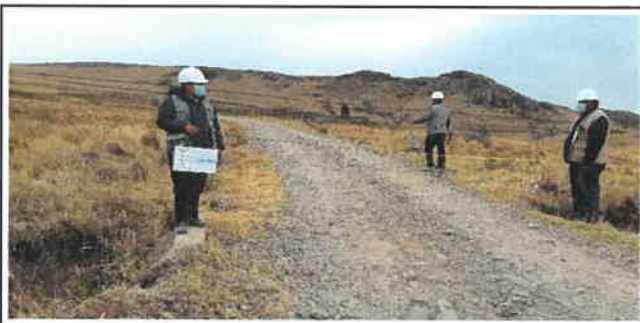
Foto N° OD61: Vista de alcantarilla en el Km 19+240.
