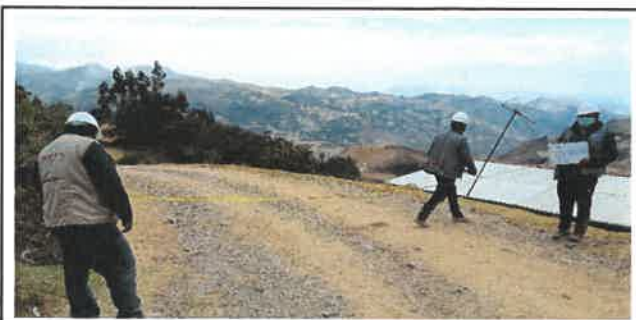
Foto N° Top101: Vista del ancho de la superficie de rodadura en el Km 25+000.
