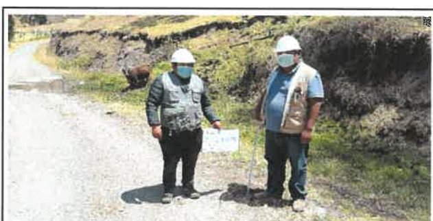
Foto N° VEP62: Vista del espesor del pavimento existente en el Km 15+250.
