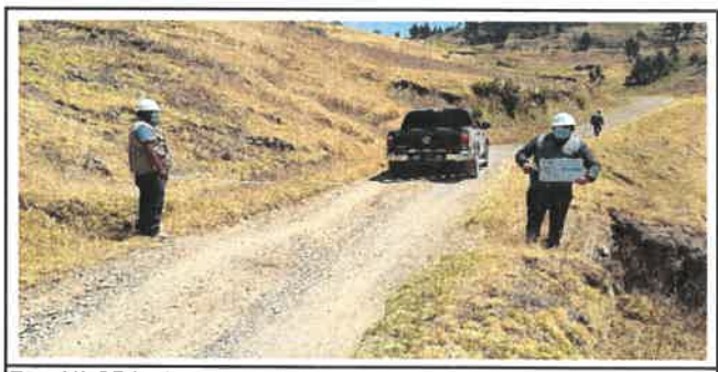
Foto N° OD25: Vista de alcantarilla en el Km 13+200.
