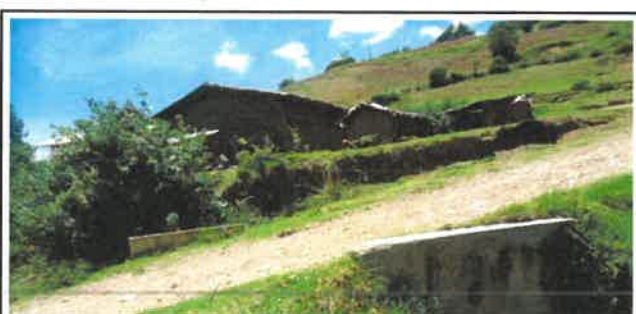
Foto N° Top111: Vista del ancho de la superficie de rodadura en el Km 27+500.
