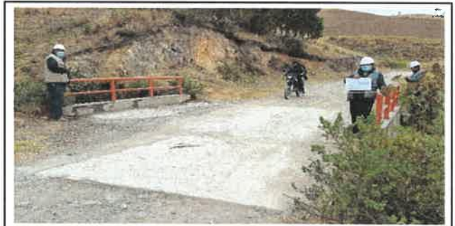
Foto N° OA10: Vista del Puente Definitivo en el Km 18+540.
