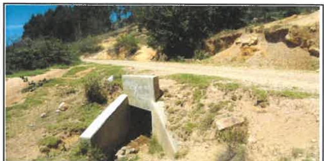
Foto N° OD76: Vista de alcantarilla en el Km 25+330.
