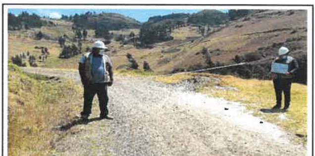
Foto N° Top54: Vista del ancho de la superficie de rodadura en el Km 13+250.
