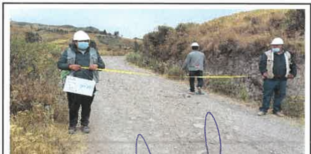
Foto N° Top72: Vista del ancho de la superficie de rodadura en el Km 17+750.
