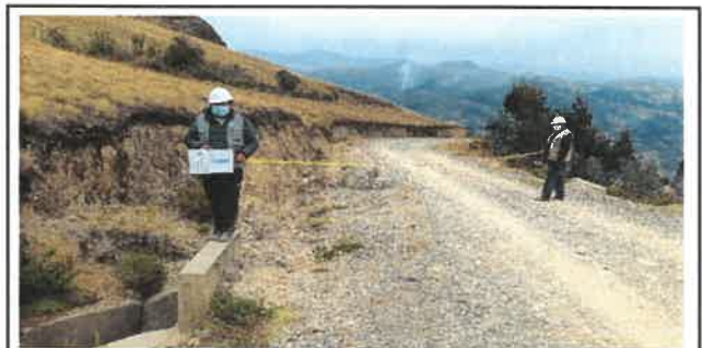
Foto N° OD68: Vista de alcantarilla en el Km 23+050.
