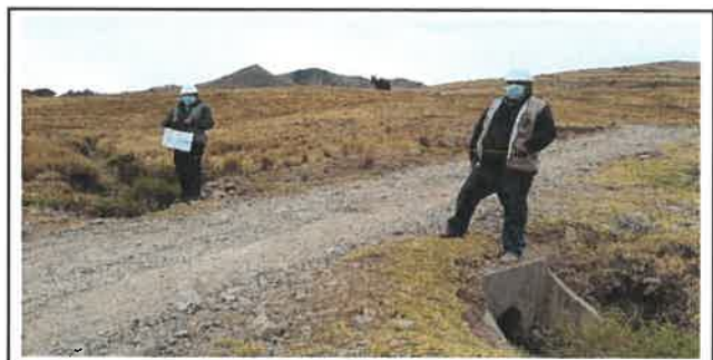
Foto N° OD62: Vista de alcantarilla en el Km 19+380.
