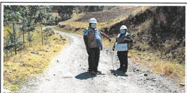
Foto N° VEP61: Vista del espesor del pavimento existente en el Km 15+000.
