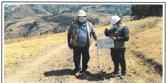
Foto N° VEP38: Vista del espesor del pavimento existente en el Km 09+250.
