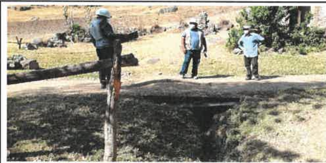
Foto N° OD11: Vista alcantarilla en el Km 7+000.
