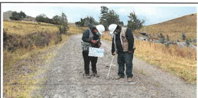
Foto N° VEP71: Vista del espesor del pavimento existente en el Km 17+500.
