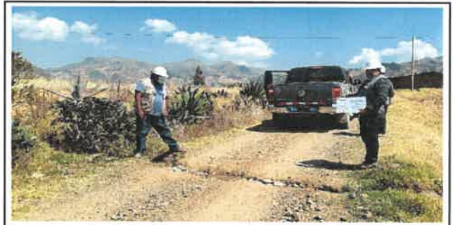
Foto N° OD14: Vista de Bajada de Agua en el Km 9+150.
