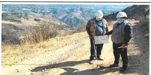
Foto N° VEP23: Vista del espesor del pavimento existente en el Km 05+500.
