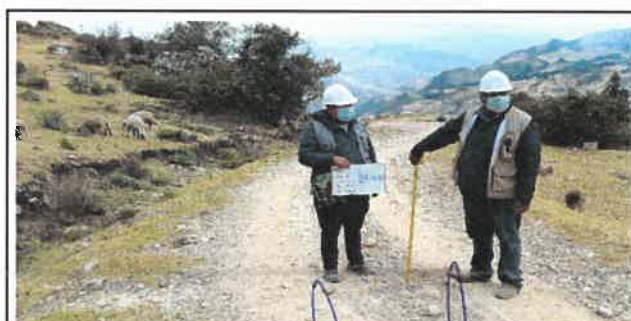
Foto N° VEP96: Vista del espesor del pavimento existente en el Km 23+750.
