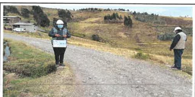
Foto N° OD55: Vista de alcantarilla en el Km 18+010.
