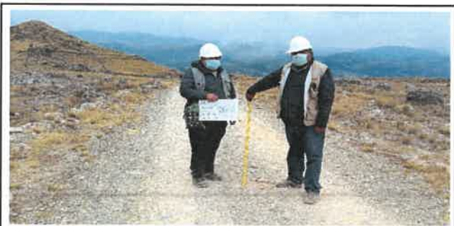
Foto N° VEP87: Vista del espesor del pavimento existente en el Km 21+500.
