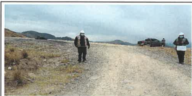
Foto N° Top85: Vista del ancho de la superficie de rodadura en el Km 21+000.
