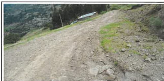
Foto N° VEP107: Vista del espesor del pavimento existente en el Km 26+500.
