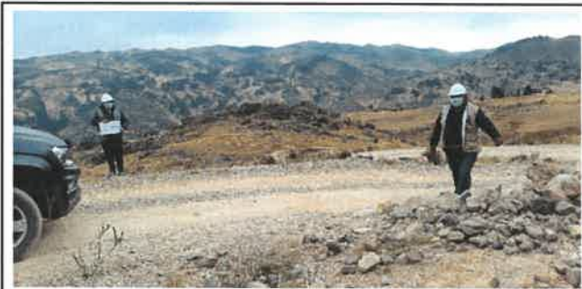
Foto N° OD67: Vista de alcantarilla en el Km 22+800.
