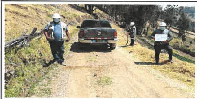
Foto N° Top49: Vista del ancho de la superficie de rodadura en el Km 12+000.
