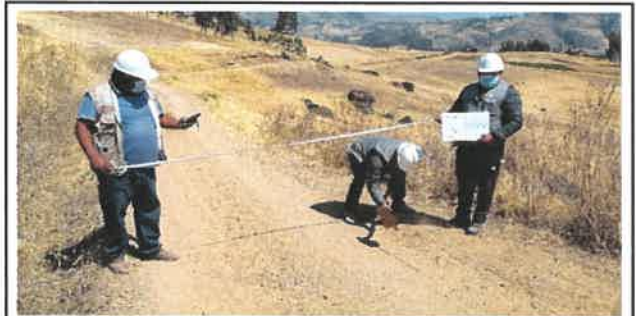
Foto N° Top36: Vista del ancho de la superficie de rodadura en el Km 08+750.
