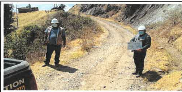
Foto N° OD21: Vista de Bajada de Agua en el Km 12+550.
