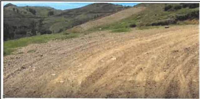
Foto N° VEP115: Vista del espesor del pavimento existente en el Km 27+500.
