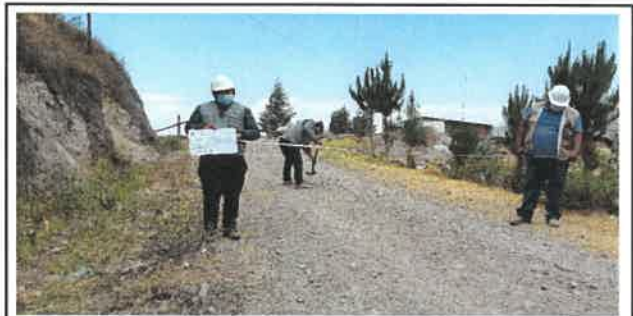
Foto N° Top70: Vista del ancho de la superficie de rodadura en el Km 17+250.
