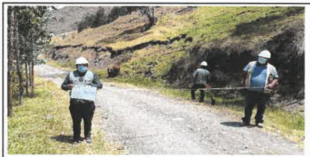
Foto N° Top62: Vista del ancho de la superficie de rodadura en el Km 15+250.
