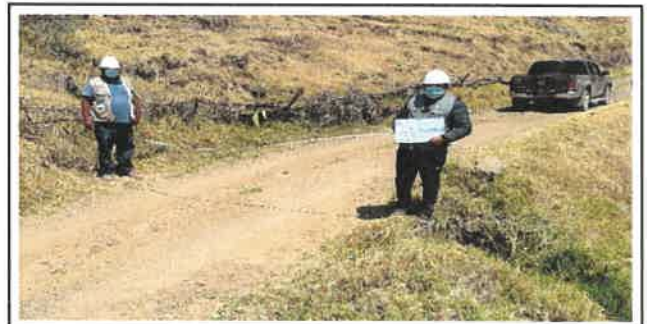
Foto N° OD18: Vista de alcantarilla en el Km 11+980.
