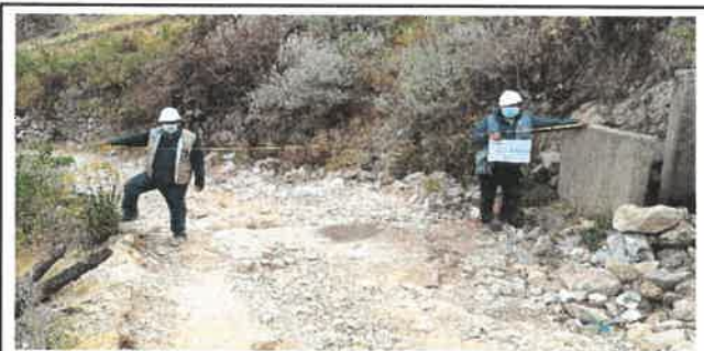
Foto N° OD75: Vista de alcantarilla en el Km 24+140.
