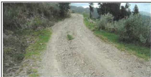
Foto N° VEP106: Vista del espesor del pavimento existente en el Km 26+250.
