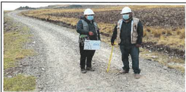
Foto N° VEP81: Vista del espesor del pavimento existente en el Km 20+000.
