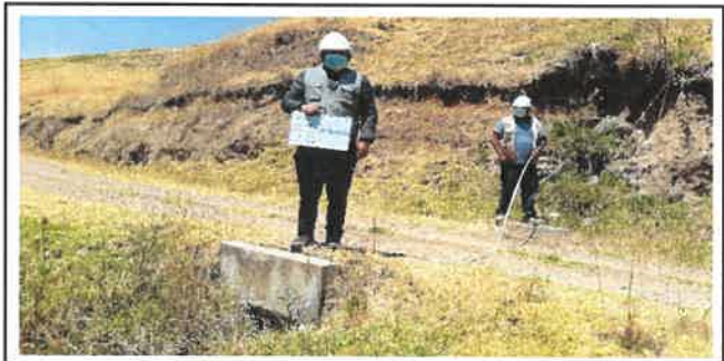
Foto N° OD27: Vista de alcantarilla en el Km 13+350.
