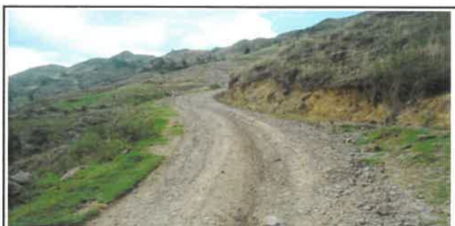
Foto N° VEP109: Vista del espesor del pavimento existente en el Km 27+000.
