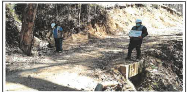
Foto N° OD20: Vista de alcantarilla en el Km 12+150.
