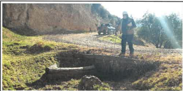
Foto N° OAO1: Vista de Puente Provisional en el Km 0+350.
