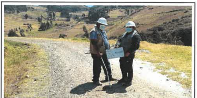
Foto N° VEP54: Vista del espesor del pavimento existente en el Km 13+250.
