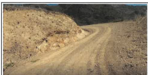
Foto N° VEP110: Vista del espesor del pavimento existente en el Km 27+250.
