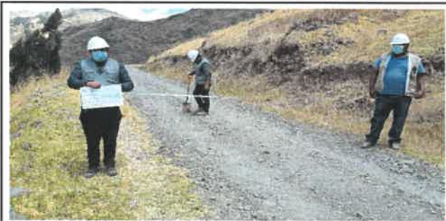
Foto N° Top67: Vista del ancho de la superficie de rodadura en el Km 16+500.
