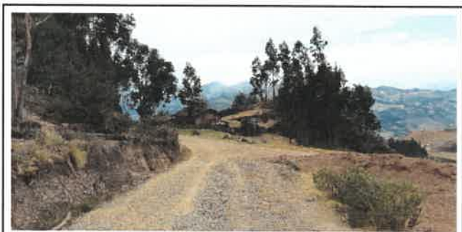
Foto N° S9: Vista de señalizacion (Desvio al Caserio de Kaunape , Las Pajillas y Distrito de Quiruvilca) Km 25+100.
