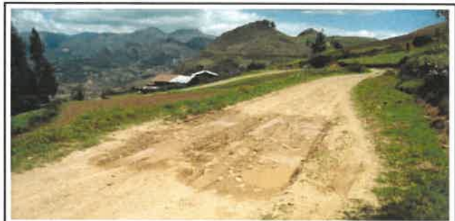
Foto N° Top106: Vista del ancho de la superficie de rodadura en el Km 26+250.
