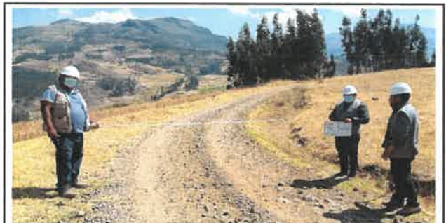
Foto N° Top38: Vista del ancho de la superficie de rodadura en el Km 09+250.
