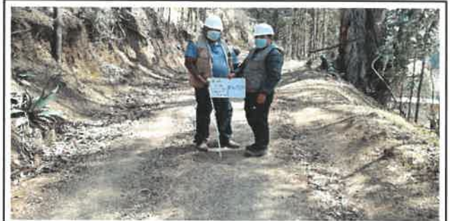
Foto N° VEP50: Vista del espesor del pavimento existente en el Km 12+250.
