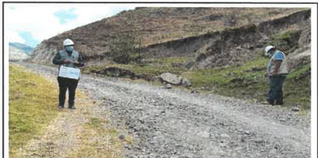
Foto N° Top68: Vista del ancho de la superficie de rodadura en el Km 16+750.
