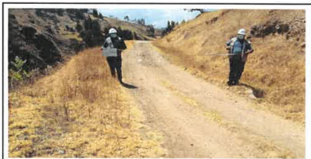
Foto N° OD28: Vista de alcantarilla en el Km 13+430.
