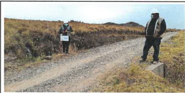
Foto N° OD59: Vista de alcantarilla en el Km 19+090.
