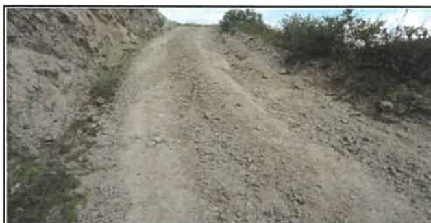
Foto N° VEP108: Vista del espesor del pavimento existente en el Km 26+750.
