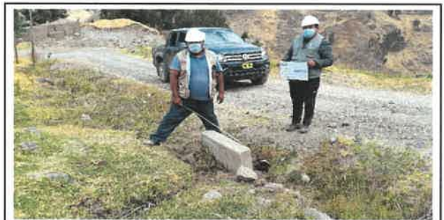
Foto N° OD46: Vista de alcantarilla en el Km 16+350.
