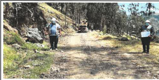
Foto N° OD19: Vista de alcantarilla en el Km 12+080.
