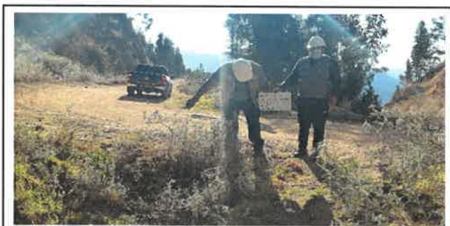
Foto N° OD1: Vista de alcantarilla en el Km 1+030.
