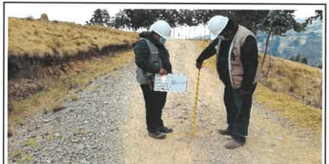
Foto N° VEP76: Vista del espesor del pavimento existente en el Km 18+750.
