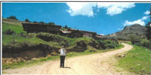
Foto N° Top107: Vista del ancho de la superficie de rodadura en el Km 26+500.
