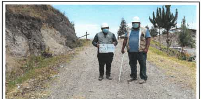
Foto N° VEP70: Vista del espesor del pavimento existente en el Km 17+250.
