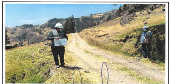
Foto N° OD24: Vista de alcantarilla en el Km 13+150.
