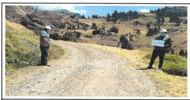
Foto N° OD26: Vista de alcantarilla en el Km 13+260.
