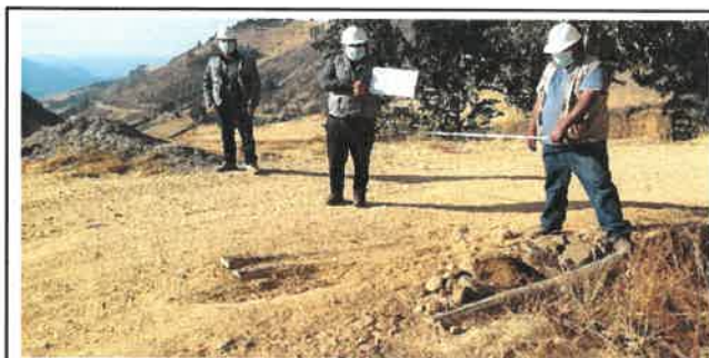
Foto N° OD2: Vista dealcantarilla en el Km 01+200.
