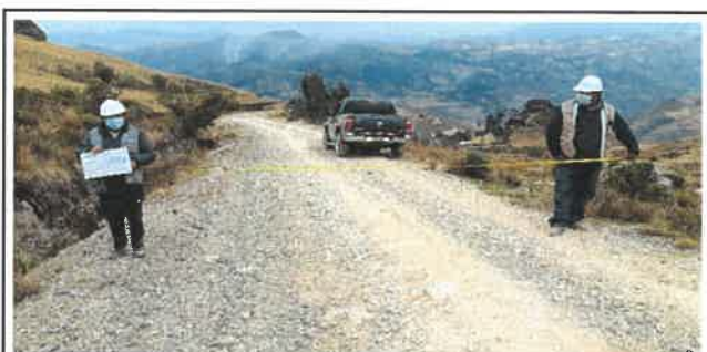
Foto N° Top93: Vista del ancho de la superficie de rodadura en el Km 23+000.
