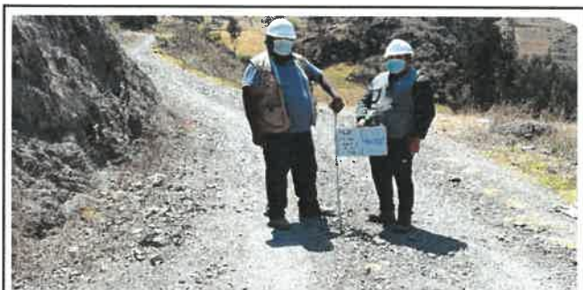
Foto N° VEP57: Vista del espesor del pavimento existente en el Km 14+000.
