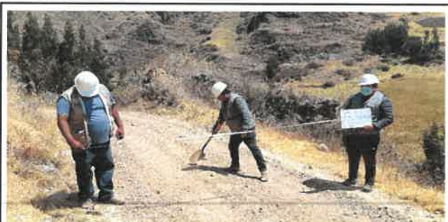
Foto N° Top55: Vista del ancho de la superficie de rodadura en el Km 13+500.
