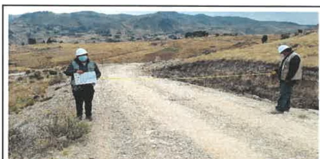
Foto N° Top92: Vista del ancho de la superficie de rodadura en el Km 22+750.
