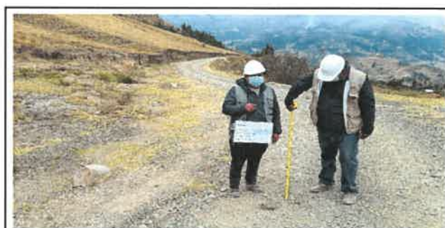
Foto N° VEP94: Vista del espesor del pavimento existente en el Km 23+250.
