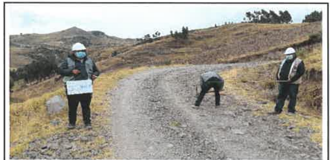
Foto N° Top74: Vista del ancho de la superficie de rodadura en el Km 18+250.
