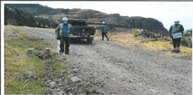
Foto N° OD43: Vista de alcantarilla en el Km 15+600.
