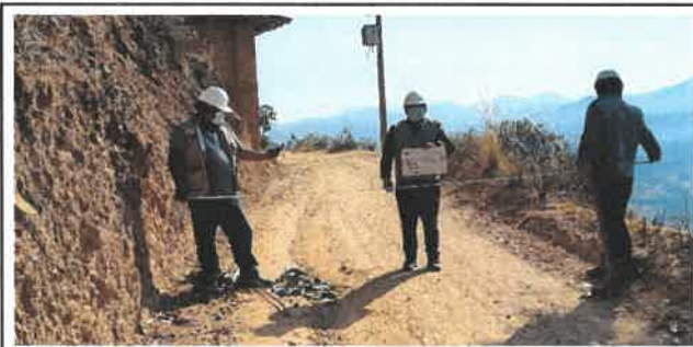
Foto N° Top19: Vista del ancho de la superficie de rodadura en el Km 04+500.
