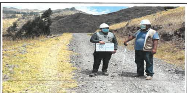
Foto N° VEP63: Vista del espesor del pavimento existente en el Km 15+500.
