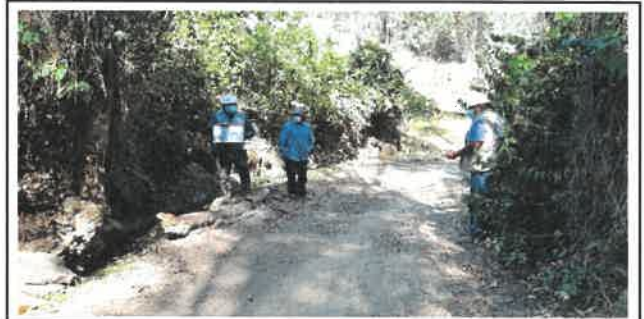
Foto N° OD12: Vista de alcantarilla en el Km 7+050.
