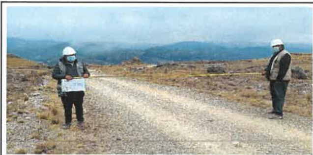
Foto N° Top87: Vista del ancho de la superficie de rodadura en el Km 21+500.
