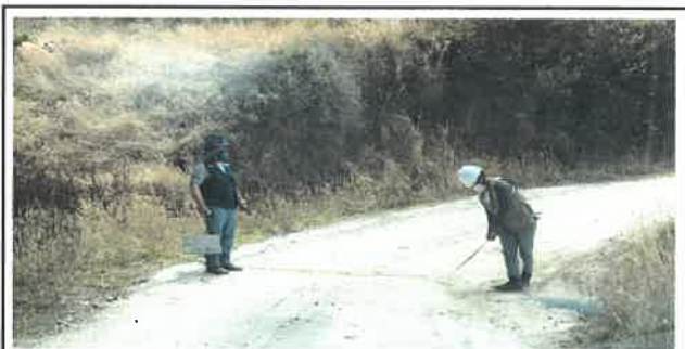
Foto N° OD14: Vista dealcantarilla en el Km 10+260
