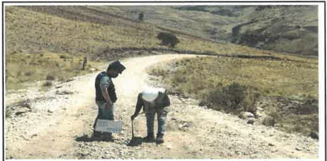
Foto N° VEP2: Vista del espesor del pavimento existente en el Km 00+250.
