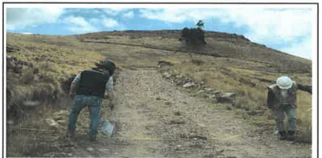
Foto N° Top14: Vista del ancho de la superficie de rodadura en el Km 03+250.
