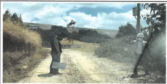
Foto N° Top41: Vista del ancho de la superficie de rodadura en el Km 10+000.
