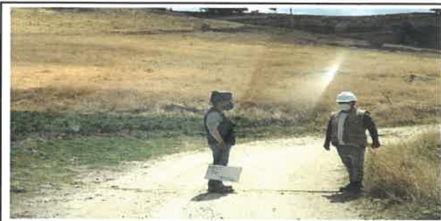
Foto N° Top37: Vista del ancho de la superficie de rodadura en el Km 09+000.
