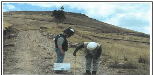
Foto N° VEP14: Vista del espesor del pavimento existente en el Km 03+250.
