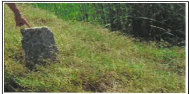
Foto N° S2: Vista de señalización Km 04+000.
