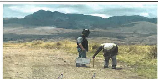
Foto N° VEP15: Vista del espesor del pavimento existente en el Km 03+500.
