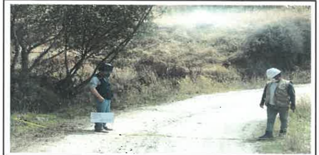
Foto N° Top42: Vista del ancho de la superficie de rodadura en el Km 10+250.
