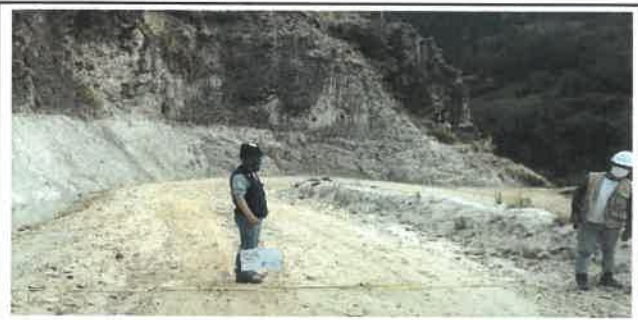
Foto N° Top45: Vista del ancho de la superficie de rodadura en el Km 11+000.
