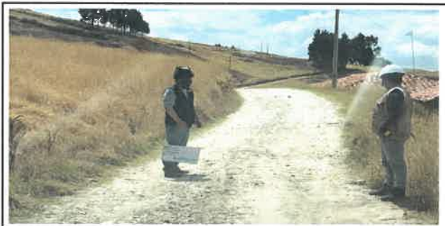
Foto N° OD12: Vista alcantarilla en el Km 09+080
