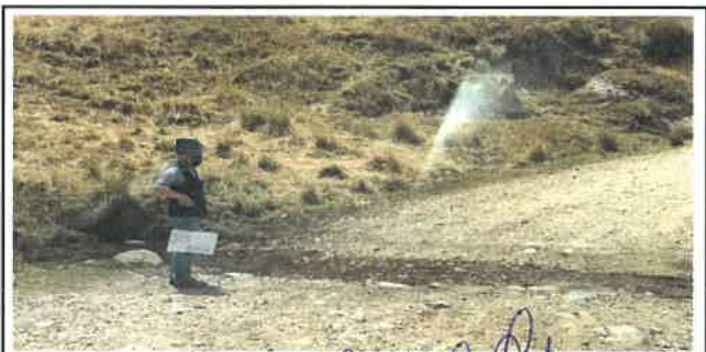
Foto N° OD8: Vista de alcantarilla en el Km 05+530.
