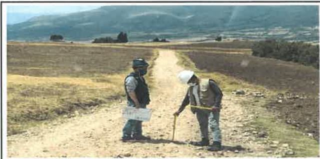
Foto N° VEP27: Vista del espesor del pavimento existente en el Km 06+500.
