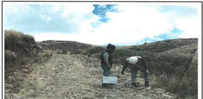
Foto N° VEP10: Vista del espesor del pavimento existente en el Km 02+250.
