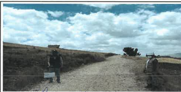
Foto N° OD7: Vista alcantarilla en el Km 05+015
