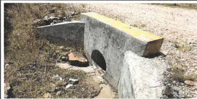
Foto N° OD3: Vista alcantarilla en el Km 01+250.
