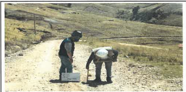
Foto N° VEP3: Vista del espesor del pavimento existente en el Km 00+500.
