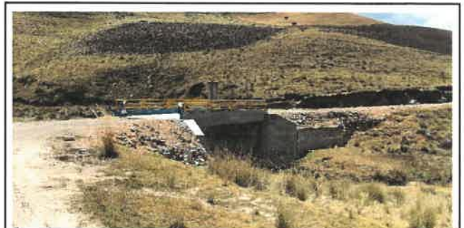
Foto N° OD2: Vista dealcantarilla en el Km 01+300.
