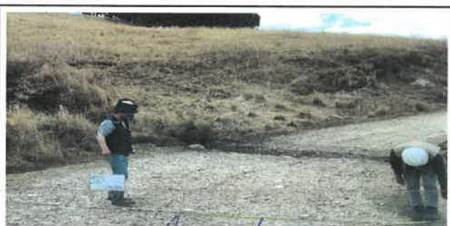
Foto N° Top23: Vista del ancho de la superficie de rodadura en el Km 05+500.
