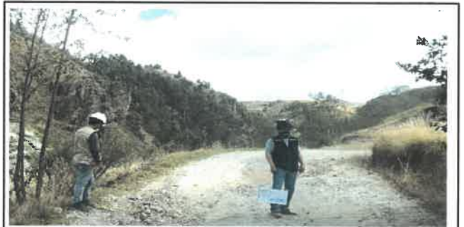
Foto N° Top46: Vista del ancho de la superficie de rodadura en el Km 11+250.
