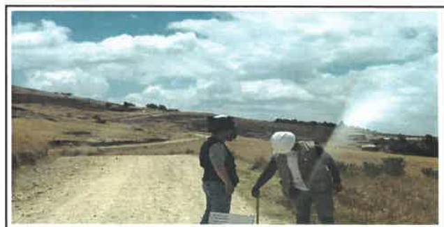
Foto N° VEP34: Vista del espesor del pavimento existente en el Km 08+250.
