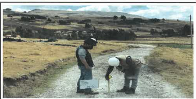
Foto N° VEP33: Vista del espesor del pavimento existente en el Km 08+000.
