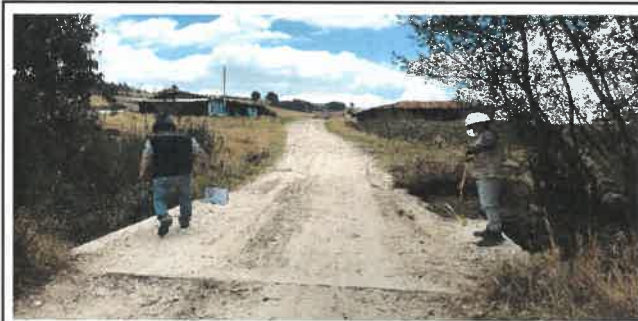
Foto N° OD3: Vista alcantarilla en el Km 08+490.
