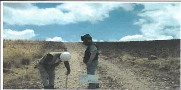
Foto N° VEP11: Vista del espesor del pavimento existente en el Km 02+500.
