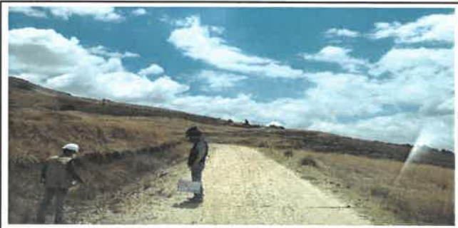
Foto N° Top25: Vista del ancho de la superficie de rodadura en el Km 06+000.
