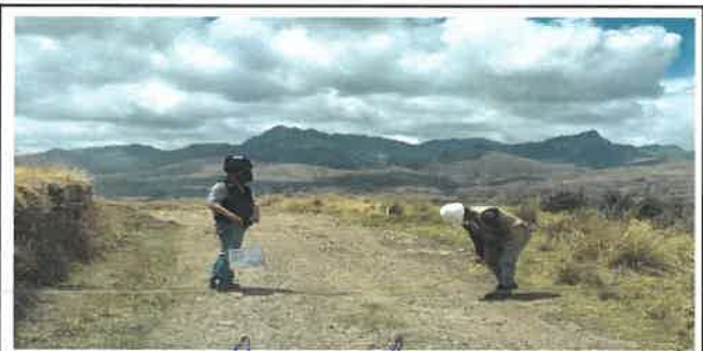
Foto N° Top15: Vista del ancho de la superficie de rodadura en el Km 03+500.
