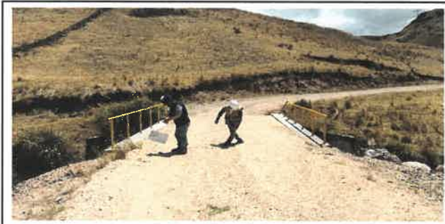
Foto N° OD1: Vista de alcantarilla en el Km 01+080.
