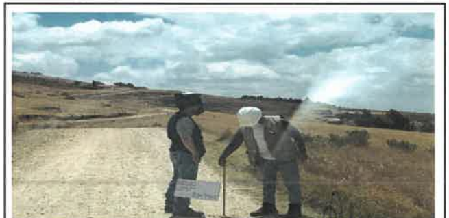
Foto N° VEP24: Vista del espesor del pavimento existente en el Km 05+750.
