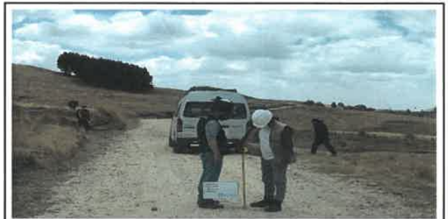
Foto N° VEP22: Vista del espesor del pavimento existente en el Km 05+250.
