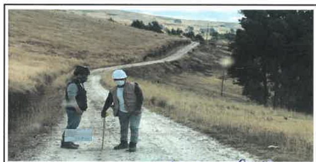
Foto N° VEP40: Vista del espesor del pavimento existente en el Km 09+750.
