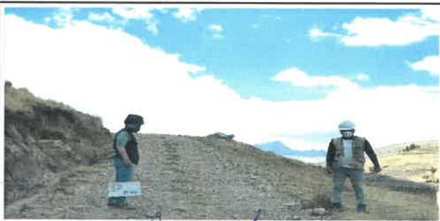
Foto N° Top7: Vista del ancho de la superficie de rodadura en el Km 01+500.
