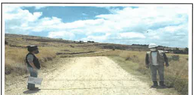
Foto N° Top24: Vista del ancho de la superficie de rodadura en el Km 05+750.
