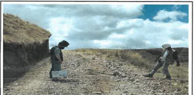
Foto N° Top8: Vista del ancho de la superficie de rodadura en el Km 01+750.
