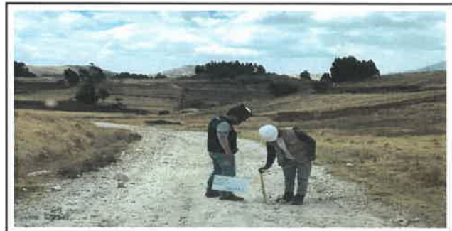
Foto N° VEP36: Vista del espesor del pavimento existente en el Km 08+750.
