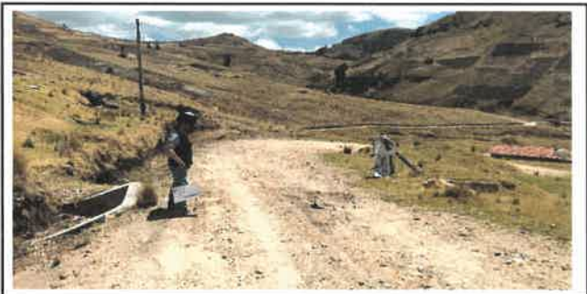
Foto N° OD2: Vista dealcantarilla en el Km 00+650
