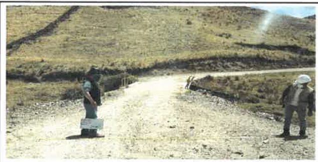
Foto N° Top5: Vista del ancho de la superficie de rodadura en el Km 01+000.
