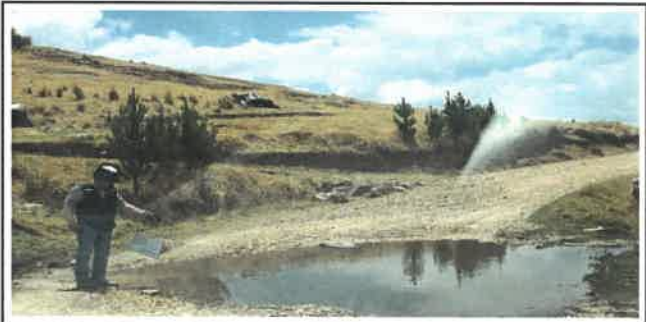
Foto N° OD9: Vista de badén en el Km 05+800
