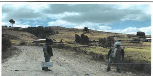
Foto N° Top47: Vista del ancho de la superficie de rodadura en el Km 11+500.
