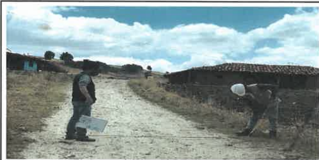
Foto N° Top35: Vista del ancho de la superficie de rodadura en el Km 08+500.
