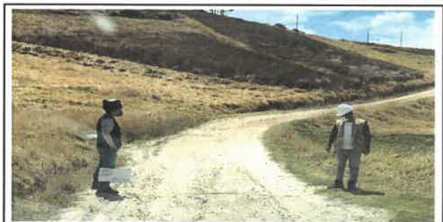
Foto N° Top38: Vista del ancho de la superficie de rodadura en el Km 09+250.
