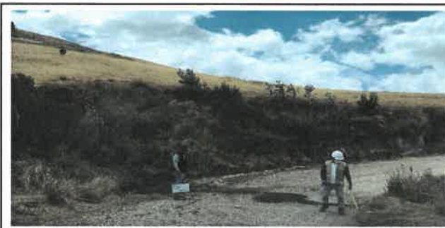
Foto N° OD5: Vista de alcantarilla en el Km 04+020.
