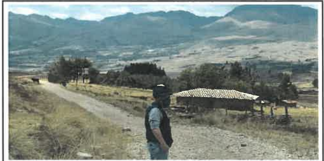
Foto N° DSR26: Se aprecia falla por erosión dañando al pavimento (Km 06+250 hasta Km 06+500.)
