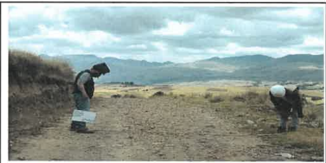
Foto N° Top13: Vista del ancho de la superficie de rodadura en el Km 03+000.
