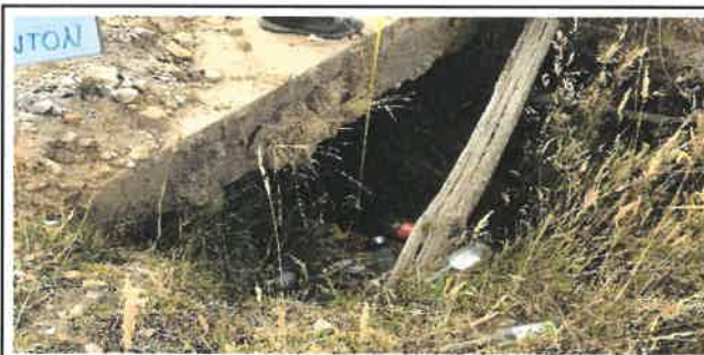
Foto N° OD5: Vista de alcantarilla en el Km 11+790.
