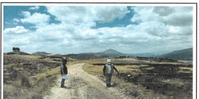
Foto N° Top32: Vista del ancho de la superficie de rodadura en el Km 07+750.
