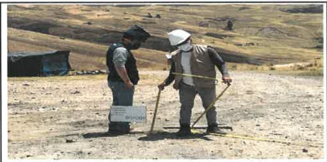
Foto N° VEP1: Vista del espesor del pavimento existente en el Km 00+000.
