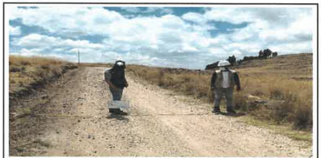
Foto N° Top18: Vista del ancho de la superficie de rodadura en el Km 04+250.
