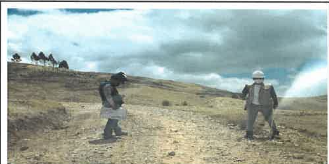
Foto N° Top27: Vista del ancho de la superficie de rodadura en el Km 06+500.
