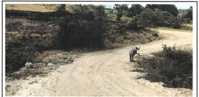
Foto N° OD4: Vista de alcantarilla en el Km 11+150.
