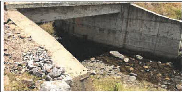
Foto N° CFA1: Vista de fuente de agua en el Km 01+080.
