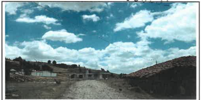
Foto N° CFA2: Vista de lugar de campamento y patio de maquinaria en el Km 08+500.
