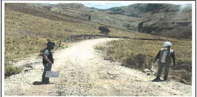
Foto N° Top2: Vista del ancho de la superficie de rodadura en el Km 00+250.
