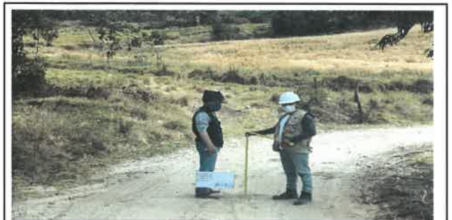
Foto N° VEP44: Vista del espesor del pavimento existente en el Km 10+750.
