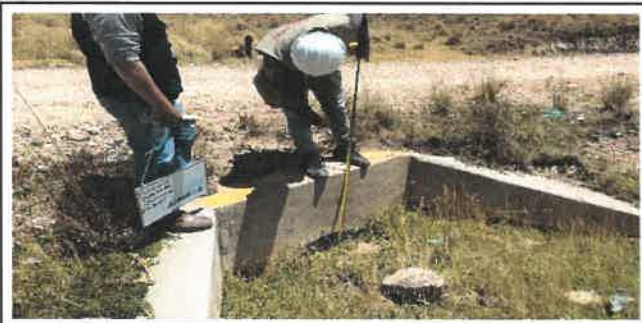
Foto N° OD1: Vista de alcantarilla en el Km 00+275.
