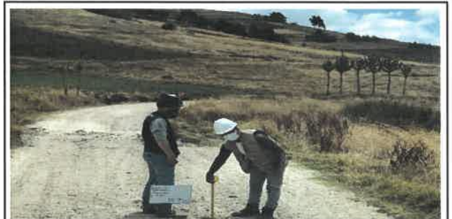
Foto N° VEP20: Vista del espesor del pavimento existente en el Km 04+750.
