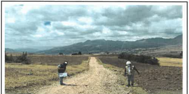
Foto N° Top28: Vista del ancho de la superficie de rodadura en el Km 06+750.
