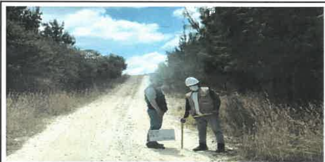
Foto N° VEP43: Vista del espesor del pavimento existente en el Km 10+500.
