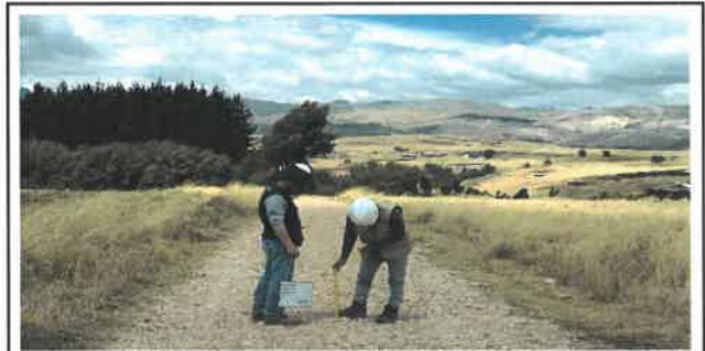
Foto N° VEP28: Vista del espesor del pavimento existente en el Km 06+750.
