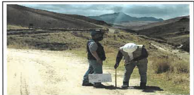
Foto N° VEP6: Vista del espesor del pavimento existente en el Km 01+250.
