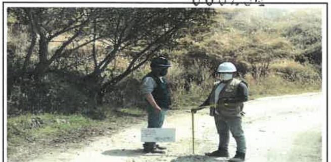
Foto N° VEP42: Vista del espesor del pavimento existente en el Km 10+250.
