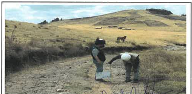
Foto N° VEP16: Vista del espesor del pavimento existente en el Km 03+750.
