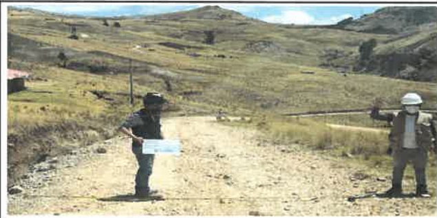
Foto N° Top3: Vista del ancho de la superficie de rodadura en el Km 00+500.
