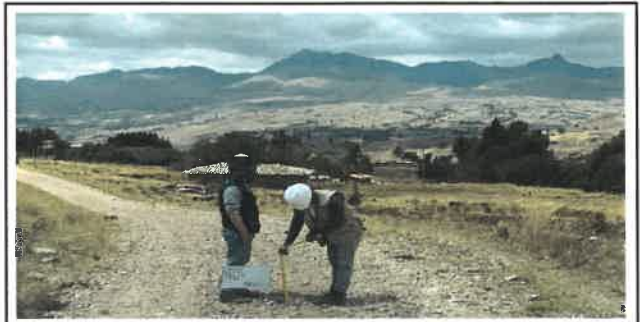
Foto N° VEP26: Vista del espesor del pavimento existente en el Km 06+250.
