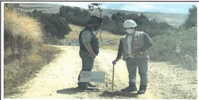
Foto N° VEP41: Vista del espesor del pavimento existente en el Km 10+000.
