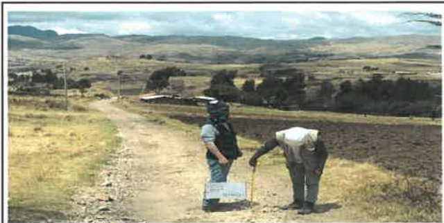
Foto N° VEP29: Vista del espesor del pavimento existente en el Km 07+000.
