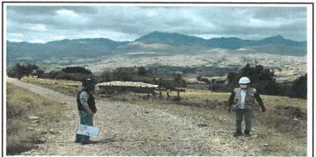
Foto N° Top26: Vista del ancho de la superficie de rodadura en el Km 06+250.
