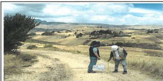
Foto N° VEP31: Vista del espesor del pavimento existente en el Km 07+500.
