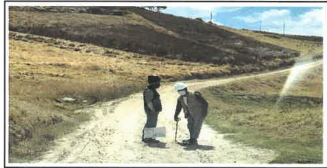
Foto N° VEP38: Vista del espesor del pavimento existente en el Km 09+250.
