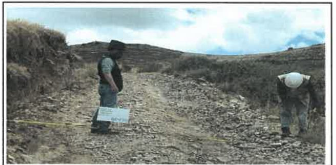
Foto N° Top10: Vista del ancho de la superficie de rodadura en el Km 02+250.
