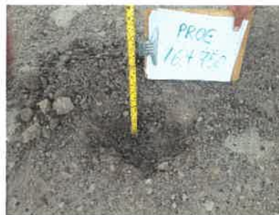
Foto 68: KM 16+750 Midiendo el espesor de afirmado existente (0.09 m.)
