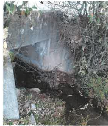
Foto 19: KM 12+200, Vista de salida de alcantarilla con forestación nativa.
