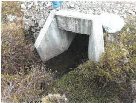
Foto 26: KM 15+020, Vista de Ingreso de alcantarilla obstruida por piedras
