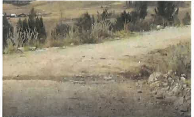
Foto 76: KM 4+700, Cruce de agua
