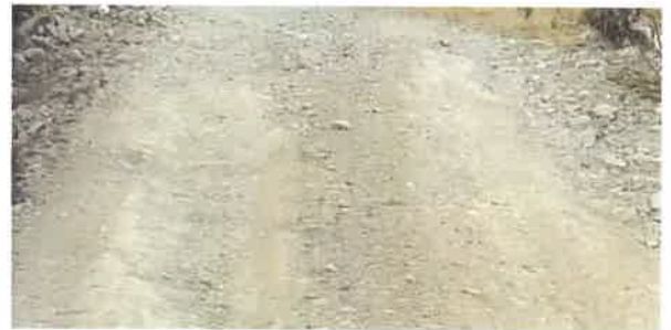
Foto 244: KM 15+200, Ahuellamiento en ambos lados de la calzada y Bacheo
