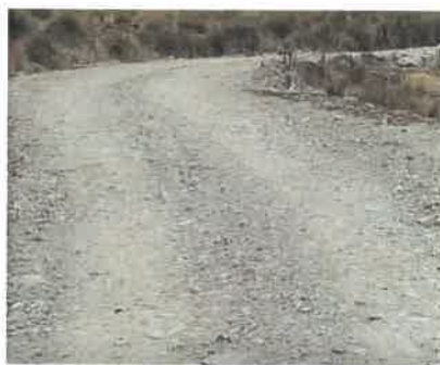
Foto 259: KM 16+150, Bacheo en ambos lados de la calzada
