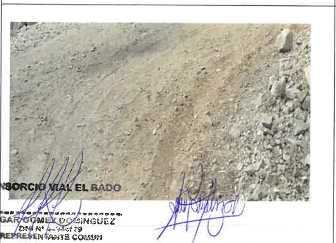
Foto 167: KM 10+400, Ahuellamiento y Erosión en toda la calzada
