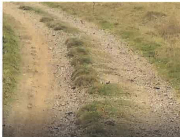
Foto 08: KM 0+450, Ahuellamiento lado izquierdo y encalaminado
