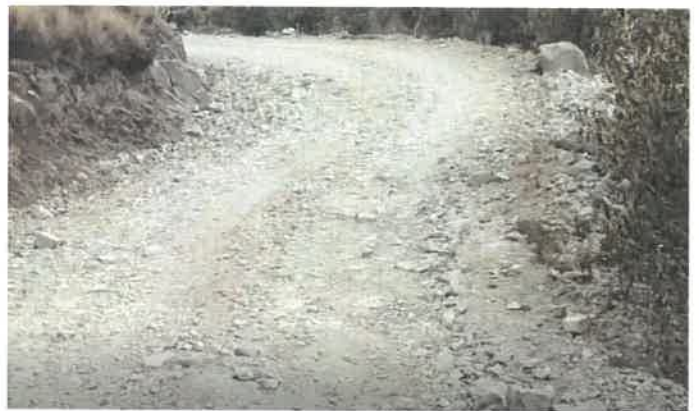
Foto 196: KM 12+200, Erosión en ambos lados de la calzada
