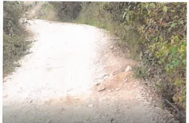
Foto 144: KM 8+950, Cruce de agua
