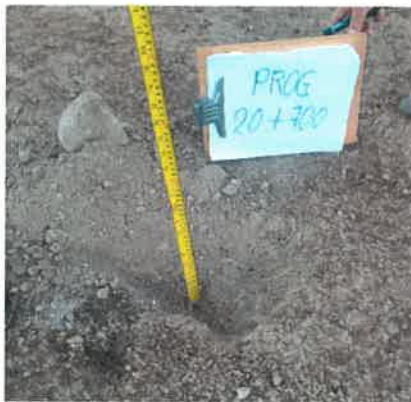
Foto 83: KM 20+700 Midiendo el espesor de afirmado existente (0.16 m.)
