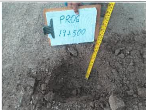
Foto 79: KM 19+500 Midiendo el espesor de afirmado existente (0.14 m.)
