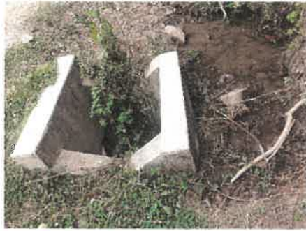
Foto 10: KM 6+380, Vista de Ingreso de alcantarilla obstruida por forestación nativa y deteriorada.
