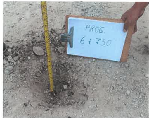
Foto 28: KM 6+750, Midiendo el espesor de afirmado existente (0.10 m.)
