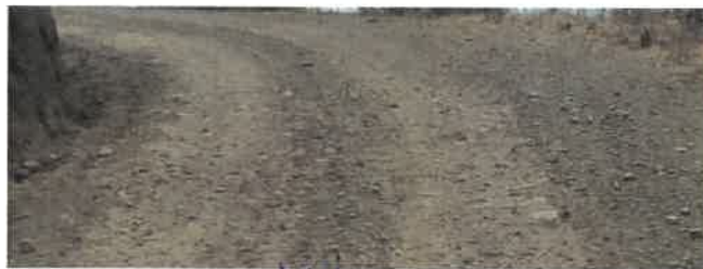
Foto 173: KM 10+800, Erosión al lado izquierdo de la calzada
