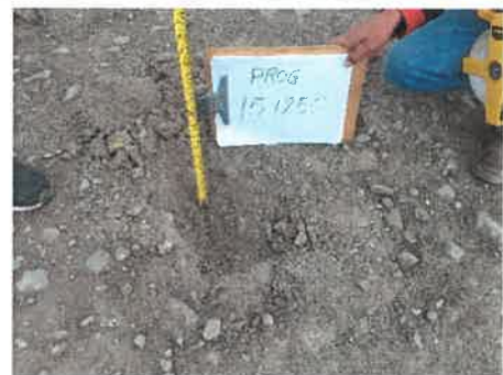
Foto 62: KM 15+250 Midiendo el espesor de afirmado existente (0.12 m.)
