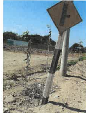
Foto 02: KM 2+380, señal en mal estado, requiere reparación.
