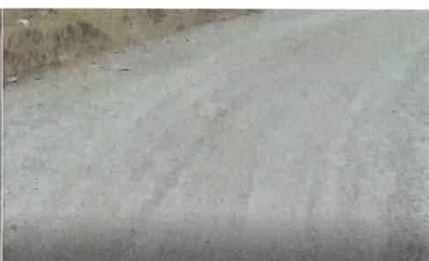
Foto 114: KM 7+100, Erosión en el lado izquierdo de la calzada
