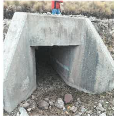
Foto 25: KM 14+930, Vista de salida de alcantarilla
