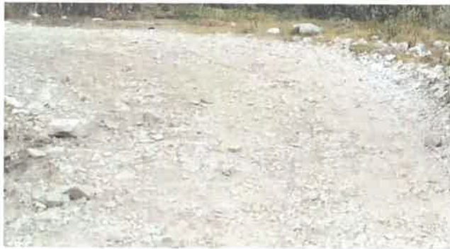
Foto 219: KM 13+600, Erosión en ambos lados de la calzada
