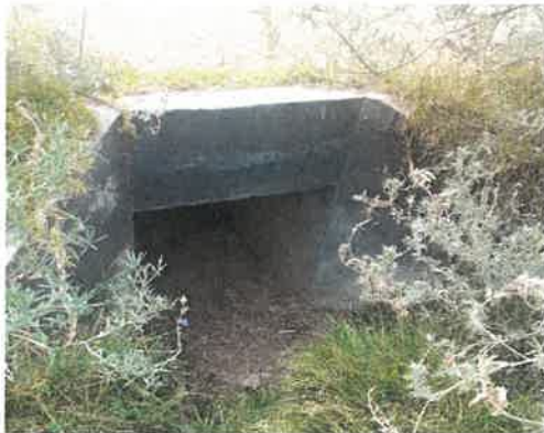
Foto 3: KM 1+480, Vista de Ingreso de alcantarilla obstruida por forestación nativa
