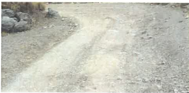
Foto 191: KM 11+900, Bacheo en el lado izquierdo y Erosión a la derecha
