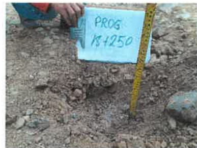
Foto 74: KM 18+250 Midiendo el espesor de afirmado existente (0.10 m.)
