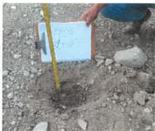
Foto 49: KM 12+000 Midiendo el espesor de afirmado existente (0.10 m.)
