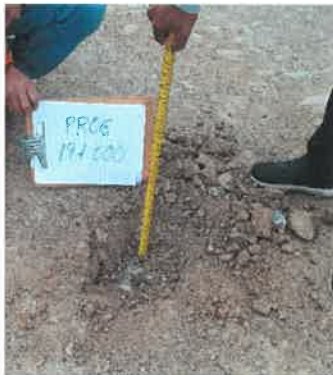
Foto 77: KM 19+000 Midiendo el espesor de afirmado existente (0.16 m.)
