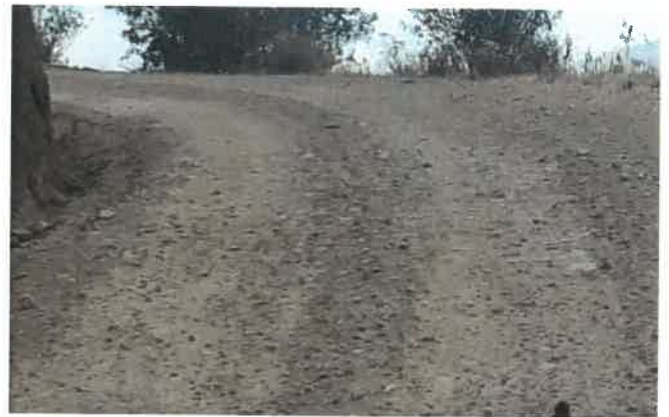
Foto 210: KM 13+050, Ahuellamiento en ambos lados de la calzada
