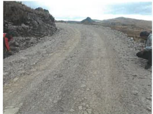
Foto 074: 18+000 Vista toma de información en campo, detallando el ancho de plataforma.
