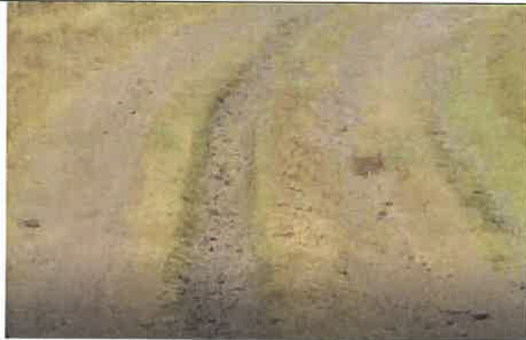
Foto 01: KM 0+050 Ahuellamiento ambos lados en la calzada, poca presencia de afirmado
