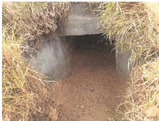
Foto 6: KM 3+500, Vista de salida de alcantarilla obstruida por forestación nativa y deteriorada.
