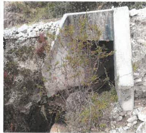
Foto 20: KM 12+740, Vista de salida de alcantarilla.
