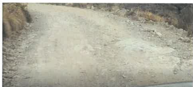
Foto 193: KM 12+050, Erosión en el lado derecho de la calzada
