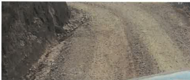
Foto 175: KM 10+900, Ahuellamiento en ambos lados de la calzada
