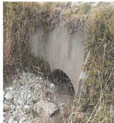
Foto 8: KM 3+580, Vista de salida de alcantarilla obstruida por forestación nativa y deteriorada.
