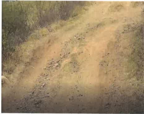
Foto 01: KM 0+050 Ahuellamiento ambos lados en la calzada, poca presencia de afirmado
