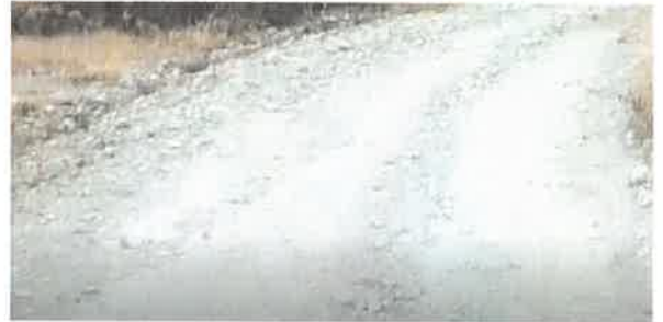
Foto 220: KM 13+700, Erosión en ambos lados de la calzada
