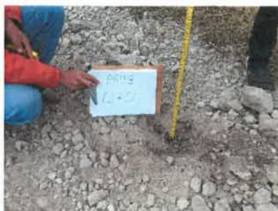
Foto 55: KM 13+500 Midiendo el espesor de afirmado existente (0.12 m.)
