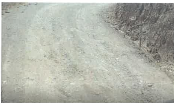
Foto 197: KM 12+300, Erosión en ambos lados de la calzada
