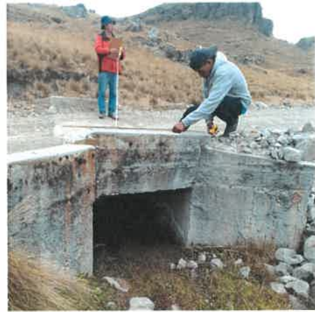
Foto 31: 18+700 Vista de salida de alcantarilla.
