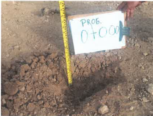
Foto 01: KM 0+000, Midiendo el espesor de afirmado existente (0.08m.)
