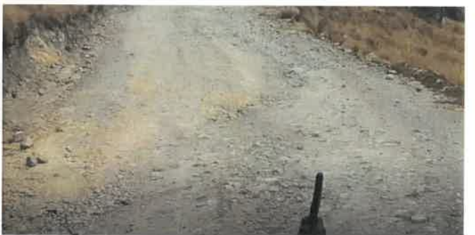
Foto 198: KM 12+350, Ahuellamiento en ambos lados de la calzada
