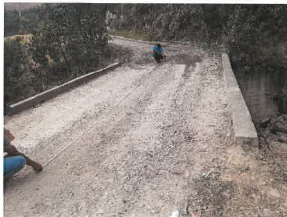
Foto 17: KM 9+950 Vista de loza de puente.
