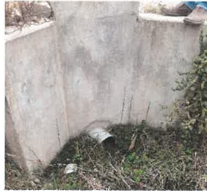
Foto 10: KM 6+380, Vista de salida de alcantarilla obstruida por forestación nativa y deteriorada.
