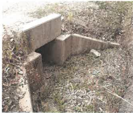
Foto 10: KM 6+380, Vista de Ingreso de alcantarilla obstruida por forestación nativa y deteriorada.
