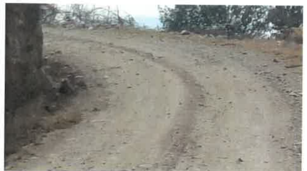
Foto 210: KM 13+050, Ahuellamiento en ambos lados de la calzada
