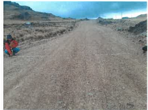
Foto 082: KM 20+000 Vista toma de información en campo, detallando el ancho de plataforma..
