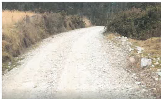
Foto 129: KM 8+050, Ahuellamiento en ambos lados de la calzada
