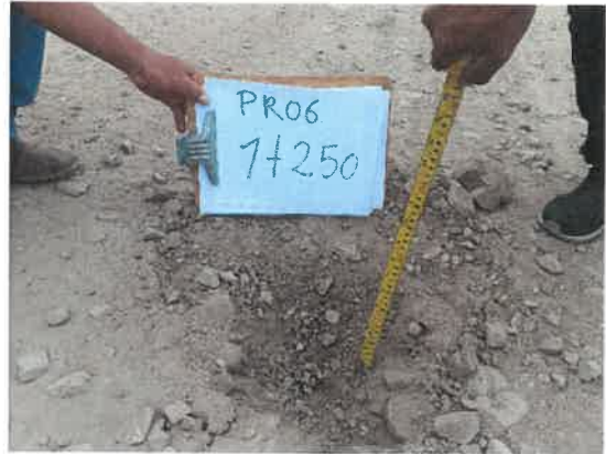
Foto 06: KM 1+250, Midiendo el espesor de afirmado existente (0.10 m.)
