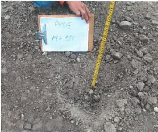
Foto 59: KM 14+500 Midiendo el espesor de afirmado existente (0.10 m.)
