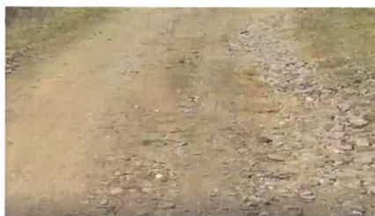
Foto 10: KM 0+600, Encalaminado en el lado izquierdo de la calzada en donde queda poco afirmado
