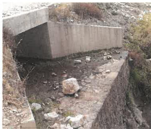
Foto 8: KM 3+580, Vista de salida de alcantarilla obstruida por forestación nativa y deteriorada.
