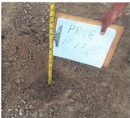
Foto 63: KM 15+500, Midiendo el espesor de afirmado existente (0.10 m.)
