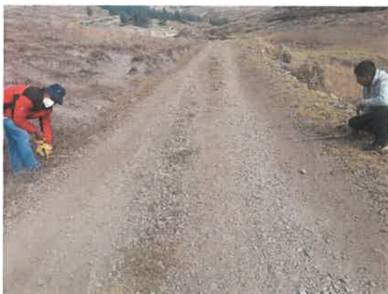
Foto 007: KM 1+250, midiendo el ancho de plataforma.
