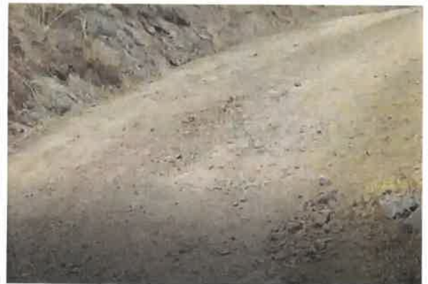
Foto 30: KM 1+850, Ahuellamiento en ambos lados de la calzada
