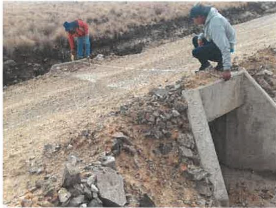
Foto 28: KM 16+200, Vista de Ingreso de alcantarilla obstruida por piedras y medición de su ancho.
