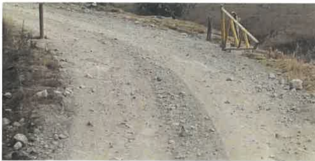
Foto 181: KM 11+300, Erosión en medio de la calzada
