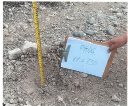
Foto 48: KM 11+750, Midiendo el espesor de afirmado existente (0.12m.)
