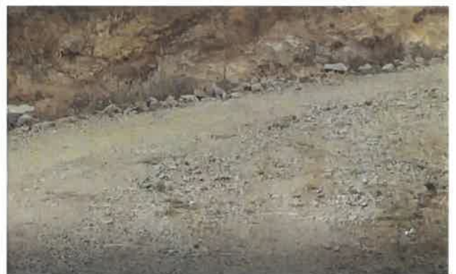
Foto 120: KM 7+450, Erosión en medio de la calzada
