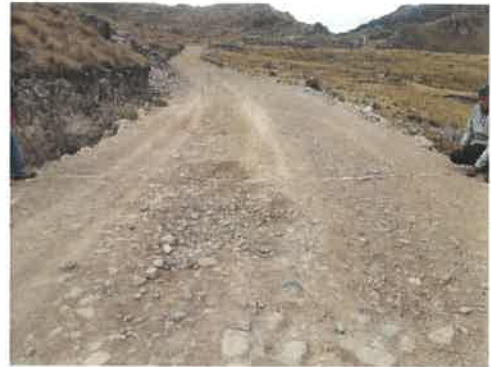
Foto 072: KM 17+500, Vista toma de información en campo, detallando el ancho de plataforma.
