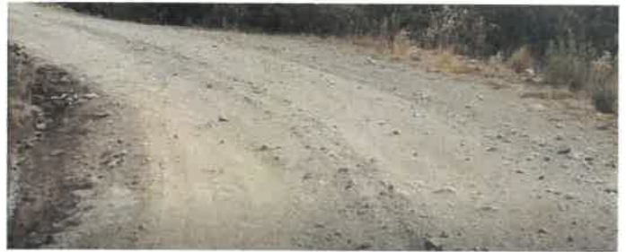
Foto 170: KM 10+600, Ahuellamiento y Erosión en toda la calzada
