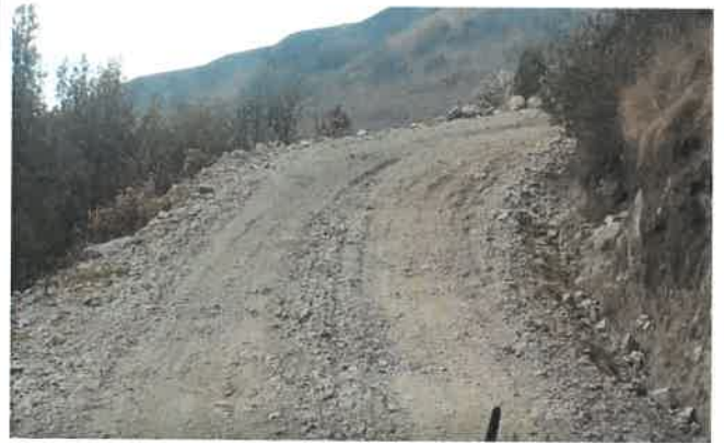
Foto 162: KM 10+100, Erosión en ambos lados de la calzada
