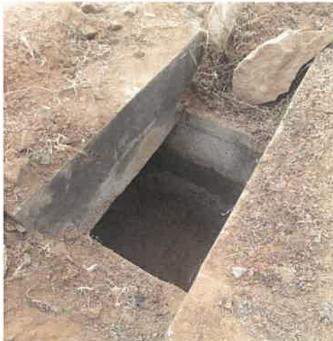
Foto 5: KM 3+100 Vista de Ingreso de alcantarilla obstruida por forestación nativa
