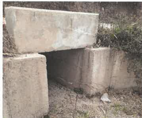
Foto 11: KM 6+395, Vista de salida de alcantarilla obstruida por forestación nativa y deteriorada.
