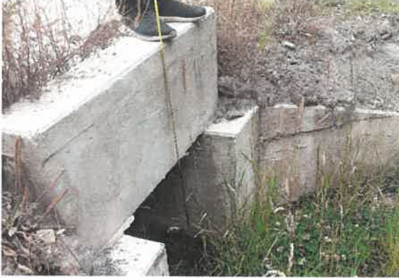
Foto 12 KM 6+740, Vista de Ingreso de alca tarilla obstruida por forestación nativa y deteriorada.
