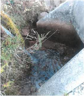
Foto 19: 12+200 Vista de Ingreso de alcantarilla.
