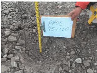
Foto 61: KM 15+000 Midiendo el espesor de afirmado existente (0.12 m.)
