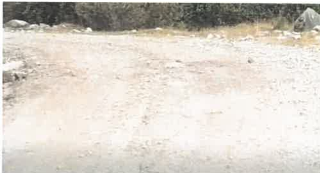
Foto 203: KM 12+600, Bacheo y ahuellamiento en la calzada
