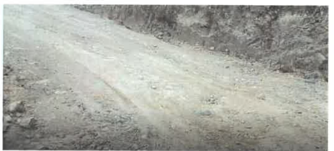
Foto 196: KM 12+200, Erosión en ambos lados de la calzada
