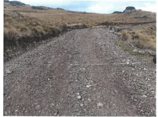
Foto 062: KM 15+000 Vista toma de información en campo, detallando el ancho de plataforma.
