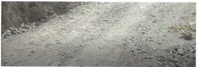
Foto 168: KM 10+450, Ahuellamiento en ambos lados de la calzada
