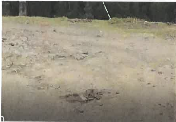
Foto 27: KM 1+650, Bacheo y Erosión en la calzada
