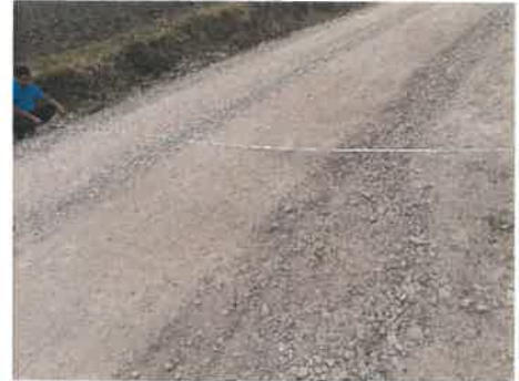
Foto 026: KM 6+000, Vista de perdida de material en plataforma.
