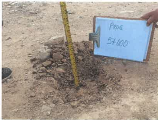
Foto 21: KM 5+000, Midiendo el espesor de afirmado existente (0.07 m.)
