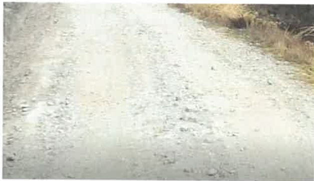
Foto 213: KM 13+200, Bacheo al lado izquierdo de la calzada
