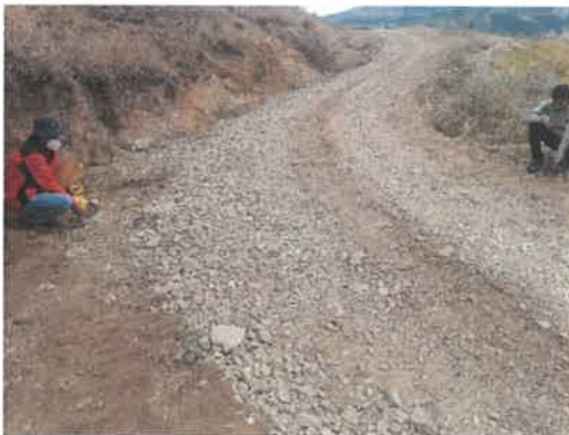
Foto 013: KM 2+750 realizando medidas de ancho de plataforma, con presencia de ahuellamiento.
