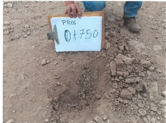
Foto 04: KM 0+750, Midiendo el espesor de afirmado existente (0.12 m.)
