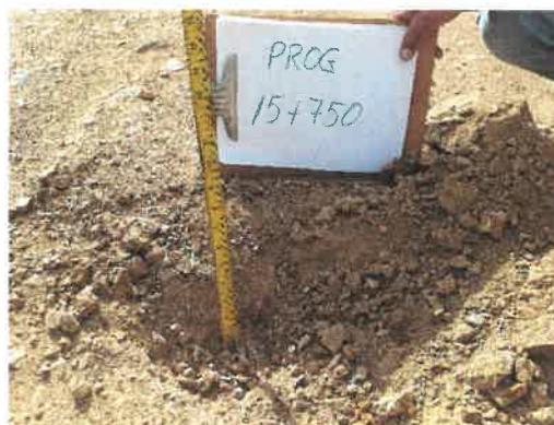
Foto 64: KM 15+750, Midiendo el espesor de afirmado existente (0.12 m.)
