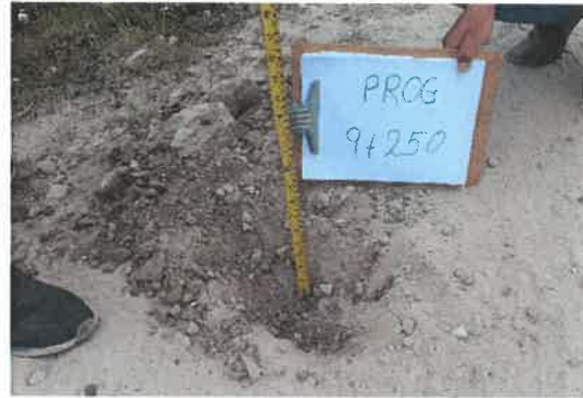
Foto 38 KM 9+250 Midiendo el espesor de afirmado existente (0.20 m.)
