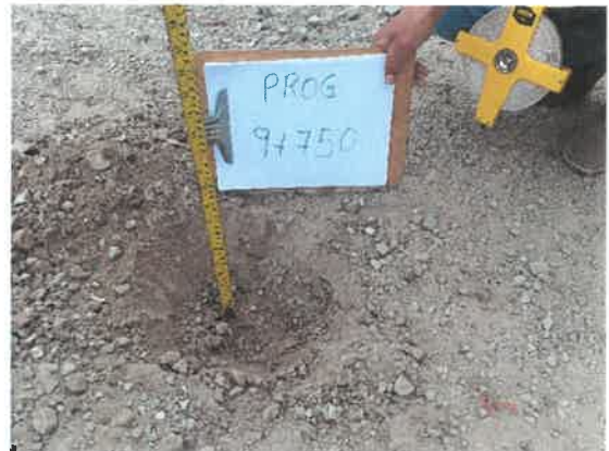
Foto 40: 9+750 Midiendo el espesor de afirmado existente (0.13 m.)
