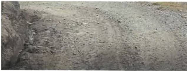
Foto 169: KM 10+550, Ahuellamiento en ambos lados de la calzada
