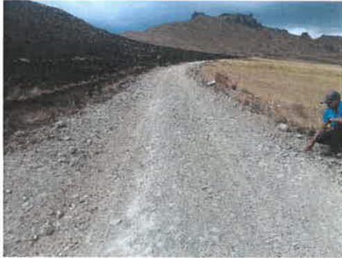
Foto 057: KM 13+750 Vista toma de información en campo, detallando el ancho de plataforma.
