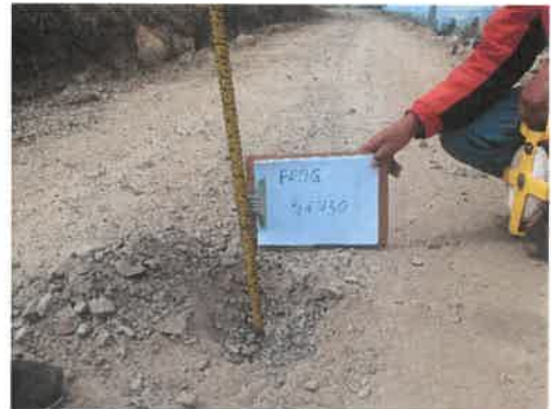
Foto 20: KM 4+750, Midiendo el espesor de afirmado existente (0.12 m.)
