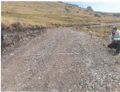
Foto 059: KM 14+250 Vista toma de información en campo, detallando el ancho de plataforma.
