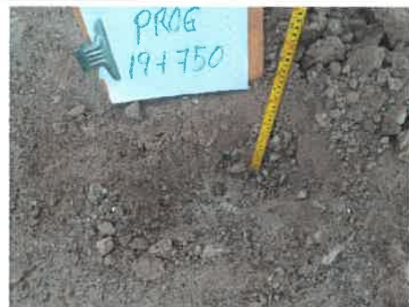
Foto 80: KM 19+750 Midiendo el espesor de afirmado existente (0.12 m.)
