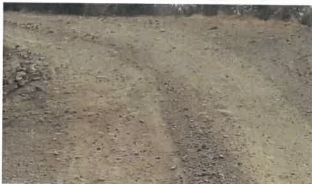
Foto 209: KM 12+950, Erosión en ambos lados de la calzada
