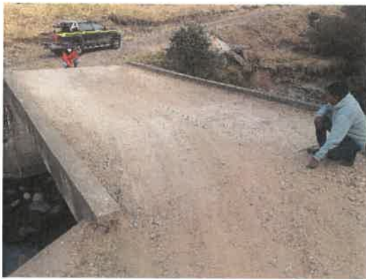
Foto 01: KM 0+070, Midiendo el ancho del puente
