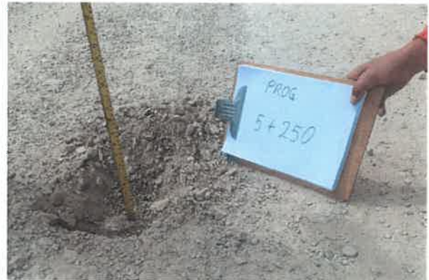
Foto 22: KM 5+250, Midiendo el espesor de afirmado existente (0.09 m.)
