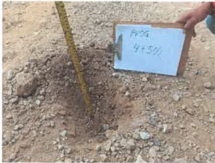
Foto 19: KM 4+500, Midiendo el espesor de afirmado existente (0.09 m.)
