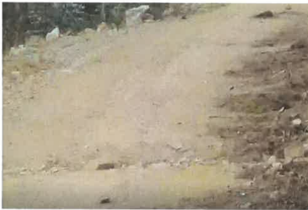
Foto 77: KM 4+800, Cruce de agua
