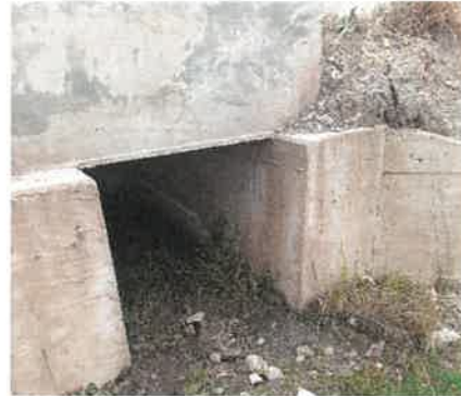
Foto 11: KM 6+395, Vista de salida de alcantarilla obstruida por forestación nativa y deteriorada.
