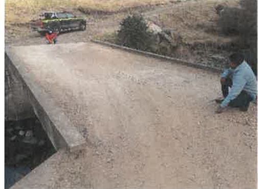
Foto 2: KM 0+070, Midiendo el ancho del puente.
