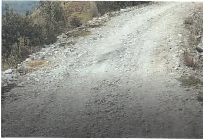
Foto 189: KM 11+800, Bacheo en ambos lados de la calzada
