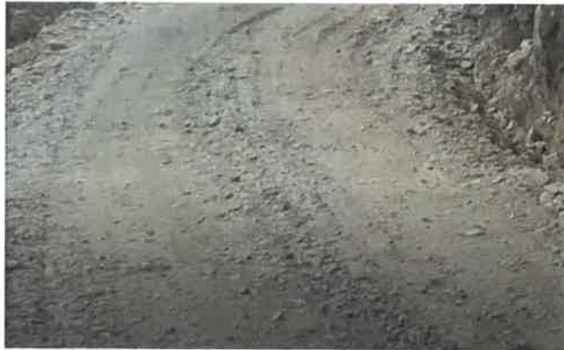
Foto 165: KM 10+300, Ahuellamiento en toda la calzada
