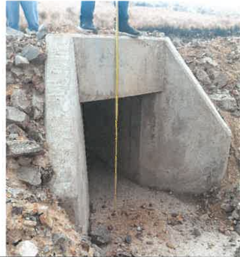
Foto 28: KM 16+200 Vista de salida de alcantarilla.
