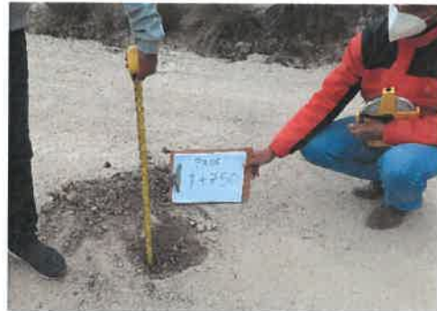
Foto 08: KM 1+750, Midiendo el espesor de afirmado existente (0.08 m.)
