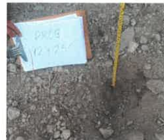
Foto 50: KM 12+250 Midiendo el espesor de afirmado existente (0.10 m.)
