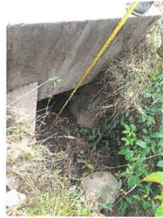
Foto 14: KM 8+400, Vista de salida de alcantarilla obstruida por forestación nativa.
