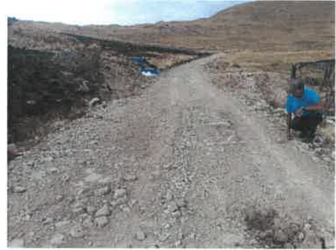
Foto 058: KM 14+000 Vista toma de información en campo, detallando el ancho de plataforma.
