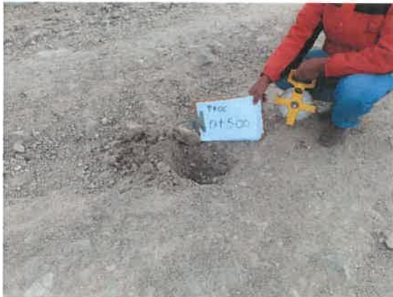
Foto 03: KM 0+500, Midiendo el espesor de afirmado existente (0.12 m.)
