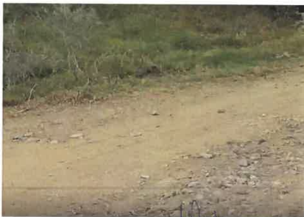
Foto 37: KM 2+300, Erosión en lado derecho de la calzada
