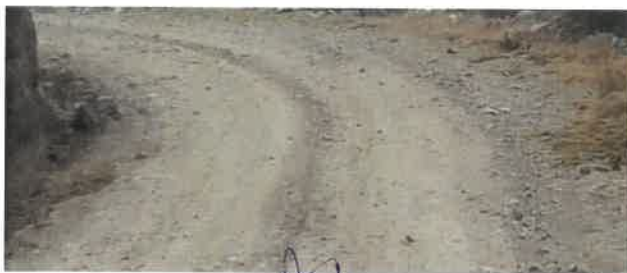
Foto 179: KM 11+150, Ahuellamiento en ambos lados de la calzada
