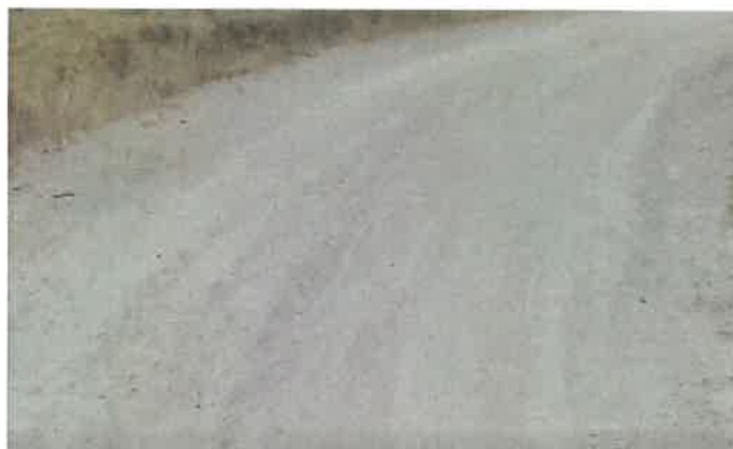
Foto 101: KM 6+300, Ahuellamiento al lado derecho de la calzada
