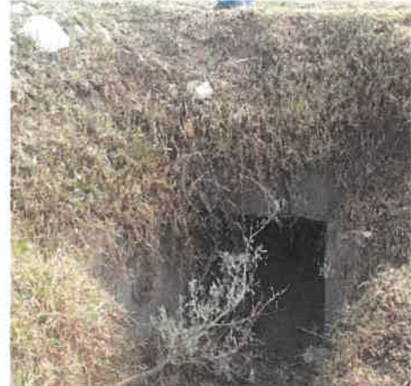
Foto 3 KM 1+480 Vista de salida de alcantarilla obstruida por forestación nativa y deteriorada.
