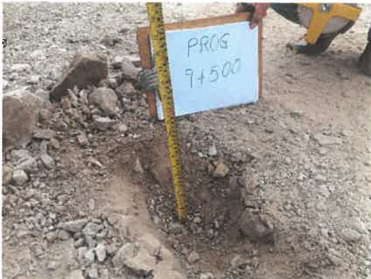
Foto 39: 9+500, Midiendo el espesor de afirmado existente (0.18 m.)
