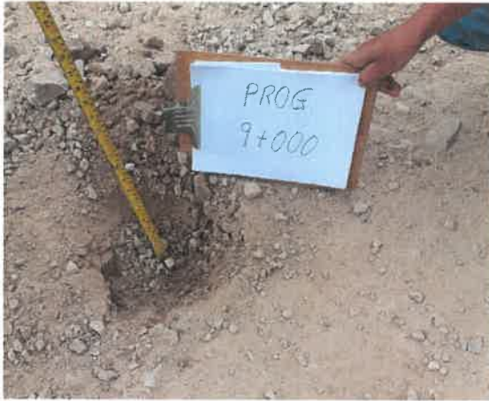
Foto 37: KM 9+000, Midiendo el espesor de afirmado existente (0.10 m.)
