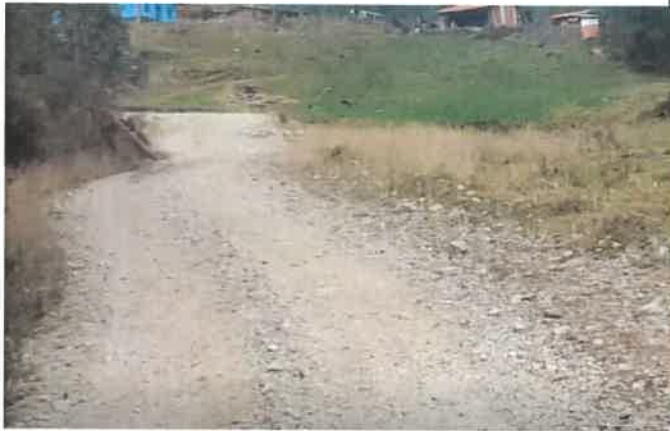
Foto 147: KM 9+150, Ahuellamiento en ambos lados de la calzada
