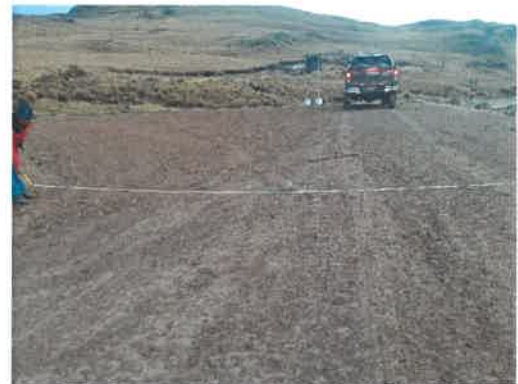
Foto 084: KM 20+700, Vista toma de información en campo, detallando el ancho de plataforma.
