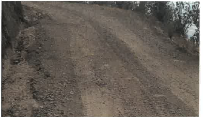
Foto 174: KM 10+850, Erosión al lado izquierdo de la calzada y Bacheo
