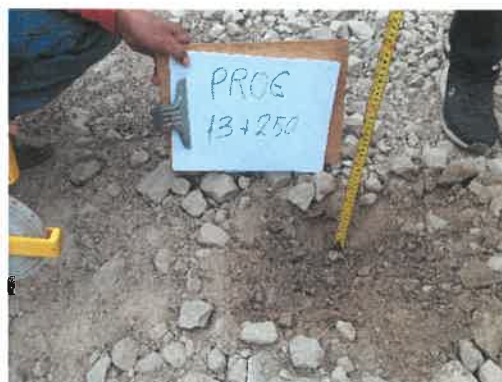
Foto 54: KM 13+250, Midiendo el espesor de afirmado existente (0.12m.)
