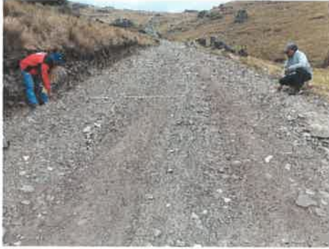
Foto 061: KM 14+750, Vista toma de información en campo, detallando el ancho de plataforma.
