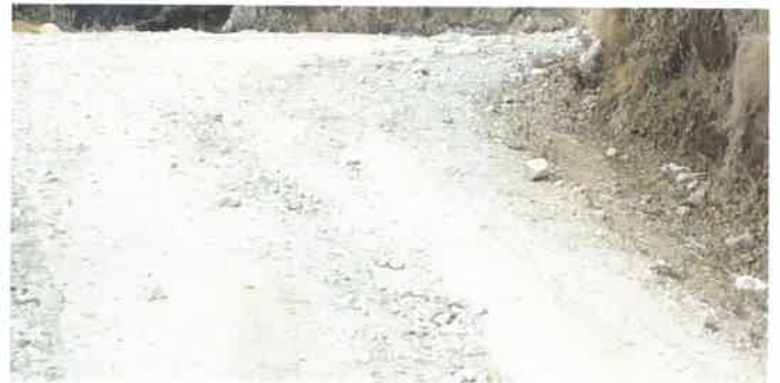
Foto 188: KM 11+700, Bacheo en ambos lados de la calzada
