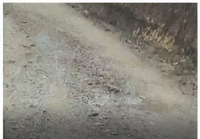
Foto 120: KM 7+450, Erosión en medio de la calzada
