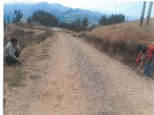
Foto 020: KM 4+500 Midiendo el ancho de plataforma.
