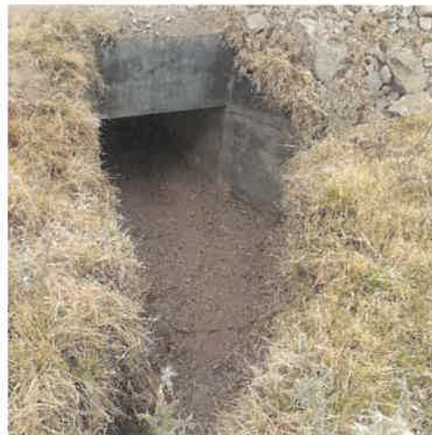
Foto 5: KM 3+100, Vista de salida de alcantarilla con forestación nativa y deteriorada.
