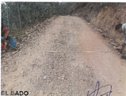
Foto 019: KM 4+250 Midiendo el ancho de plataforma.
