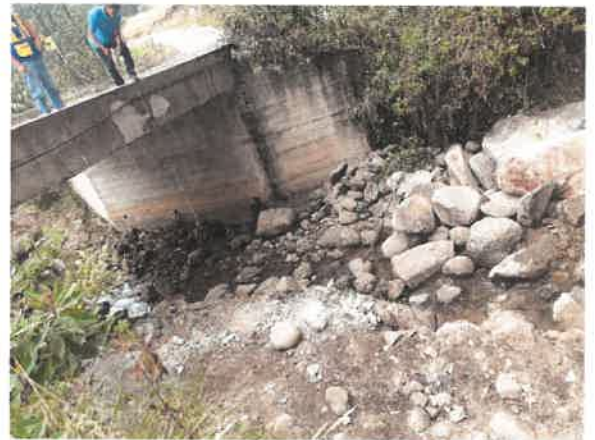
Foto 17: KM 9+950, Vista lateral del puente.
