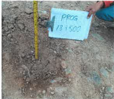
Foto 75: KM 18+500, Midiendo el espesor de afirmado existente (0.20 m.)
