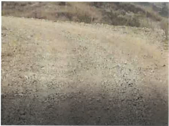
Foto 44: KM 2+700, Encalaminado en ambos lados de la calzada
