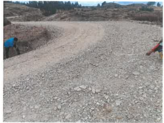
Foto 026: KM 6+000, Vista de perdida de material en plataforma.
