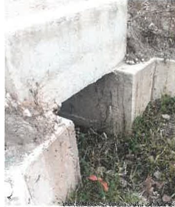
Foto 13: KM 6+840 Vista de salida de alcantarilla obstruida por forestación nativa y deteriorada.
