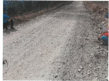
Foto 024: KM 5+500 Vista toma de información e campo, detallando el ancho de plataforma.
