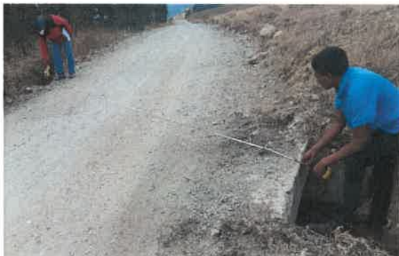
Foto 7: KM 5+570 Vista de Ingreso de alcantarilla con forestación nativa
