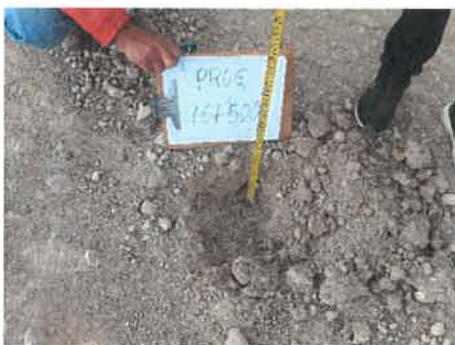
Foto 67: KM 16+500 Midiendo el espesor de afirmado existente (0.14 m.)
