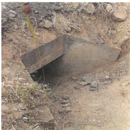
Foto 6: KM 3+500 Vista de Ingreso de alcantarilla obstruida por forestación nativa
