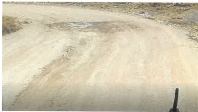
Foto 201: KM 12+500, Bacheo en ambos lados de la calzada
