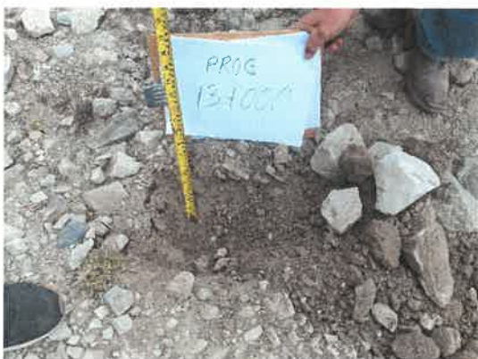
Foto 53: KM 13+000, Midiendo el espesor de afirmado existente (0.13 m.)
