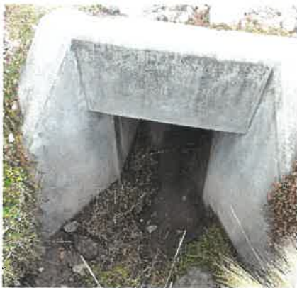
Foto 26: KM 15+020, Vista de Ingreso de alcantarilla obstruida por piedras
