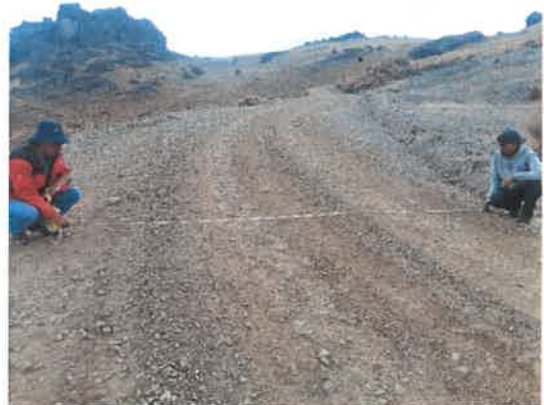
Foto 064: KM 15+500, Vista toma de información en campo, detallando el ancho de plataforma.
