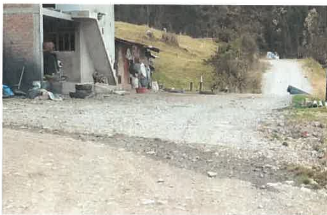
Foto 151: KM 9+400, Cruce de agua
