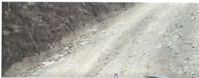
Foto 171: KM 10+650, Erosión al lado izquierdo de la calzada
