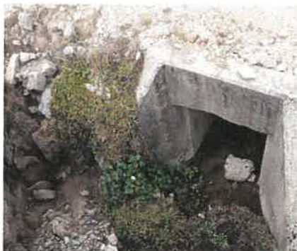
Foto 20: KM 12+740 Vista de Ingreso de alcantarilla obstruida por forestación nativa
