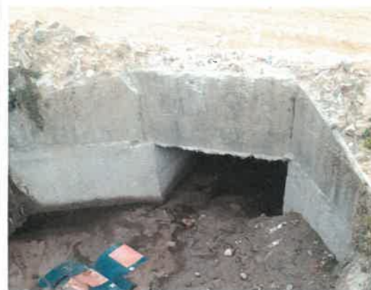
Foto 30: KM 17+950 Vista de salida de alcantarilla.
