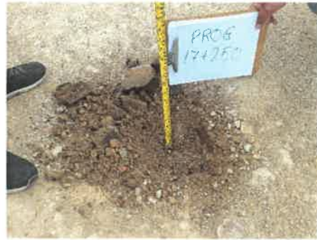
Foto 70: KM 17+250, Midiendo el espesor de afirmado existente (0.12 m.)
