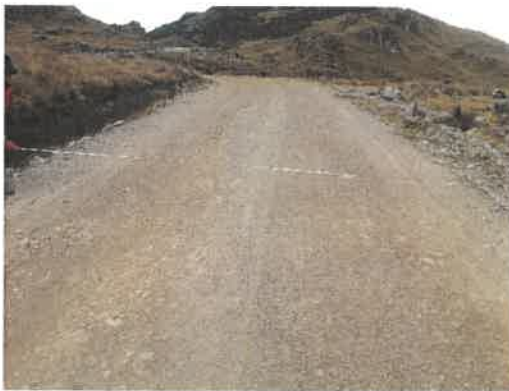
Foto 073: KM 17+750, Vista toma de información en campo, detallando el ancho de plataforma.
