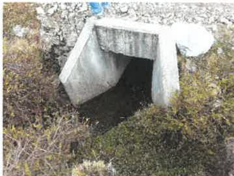
Foto 28: KM 16+200, Vista de Ingreso de alcantarilla obstruida por piedras y medición de su ancho.
