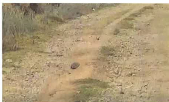
Foto 08: KM 0+450, Ahuellamiento lado izquierdo y encalaminado
