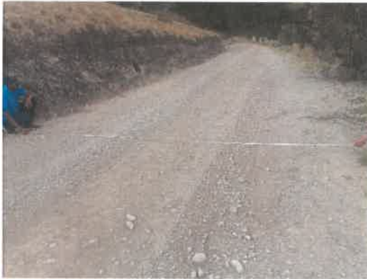
Foto 047: KM 11+250, Vista toma de información en campo, detallando el ancho de plataforma.
