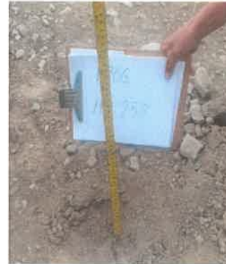
Foto 46: KM 11+250, Midiendo el espesor de afirmado existente (0.10m.)
