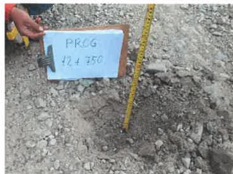
Foto 52: KM 12+750, Midiendo el espesor de afirmado existente (0.15 m.)
