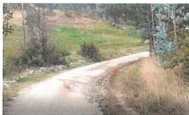
Foto 131: KM 8+150, Ahuellamiento en ambos lados de la calzada y Bacheo
