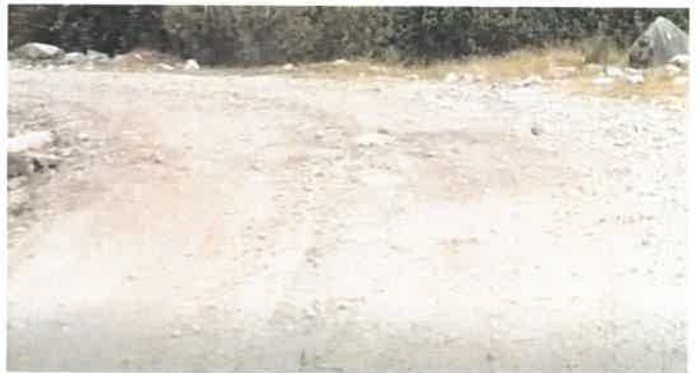
Foto 202: KM 12+550, Ahuellamiento al lado izquierdo de la calzada
