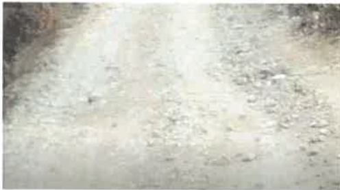
Foto 221: KM 13+800, Ahuellamiento al lado derecho de la calzada
