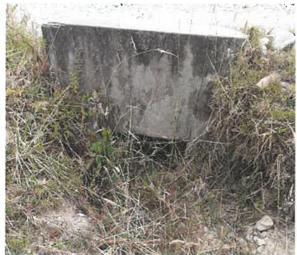
Foto 14: KM 8+400, Vista de salida de alcantarilla obstruida por forestación nativa.
