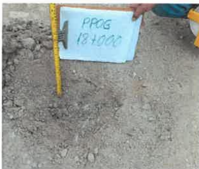
Foto 73: KM 18+000 Midiendo el espesor de afirmado existente (0.12 m.)
