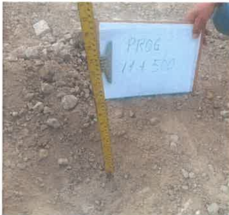
Foto 47: KM 11+500, Midiendo el espesor de afirmado existente (0.14 m.)
