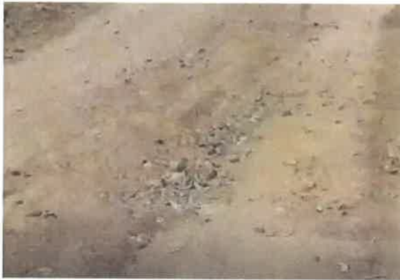
Foto 13: KM 0+800, Ahuellamiento en ambos lados de la calzada
