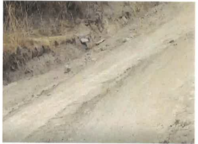
Foto 30: KM 1+850, Ahuellamiento en ambos lados de la calzada
