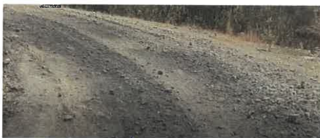
Foto 167: KM 10+400, Ahuellamiento y Erosión en toda la calzada
