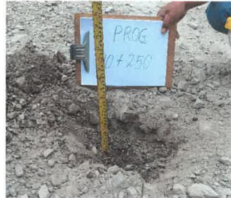
Foto 42: KM 10+250, Midiendo el espesor de afirmado existente (0.12 m.)
