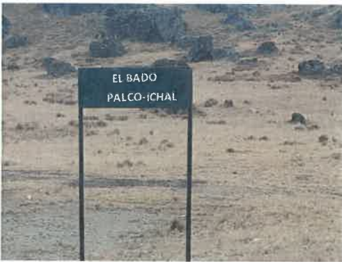
Foto 3: KM 5+050, señal en mal estado, requiere reparación.
