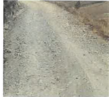
Foto 244: KM 15+200, Ahuellamiento en ambos lados de la calzada y Bacheo
