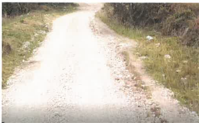
Foto 132: KM 8+200, Ahuellamiento en ambos lados de la calzada y Erosión
