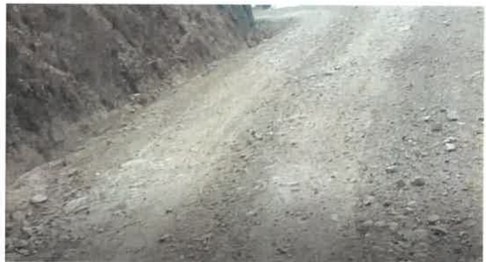
Foto 172: KM 10+700, Ahuellamiento al lado izquierdo de la calzada
