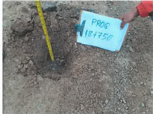
Foto 76: KM 18+750, Midiendo el espesor de afirmado existente (0.14 m.)
