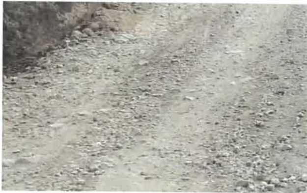
Foto 207: KM 12+850, Bacheo y ahuellamiento en la calzada
