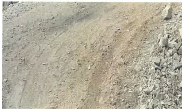
Foto 165: KM 10+300, Ahuellamiento en toda la calzada
