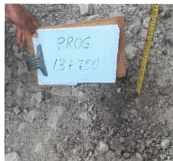
Foto 56: KM 13+750 Midiendo el espesor de afirmado existente (0.10 m.)
