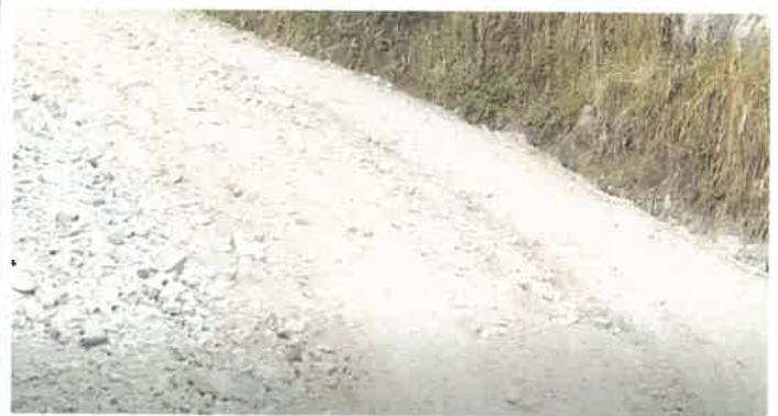
Foto 162: KM 10+100, Erosión en ambos lados de la calzada
