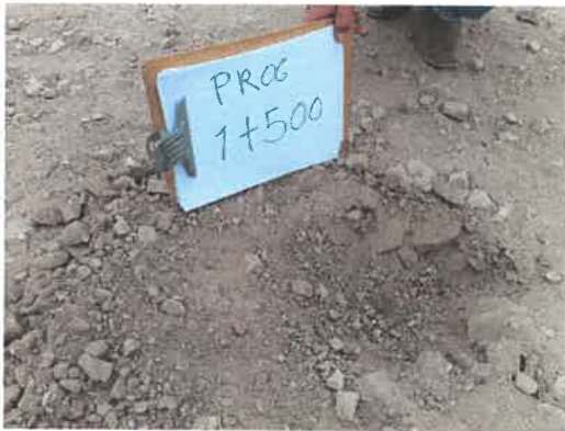
Foto 07: KM 1+500, Midiendo el espesor de afirmado existente (0.08 m.)
