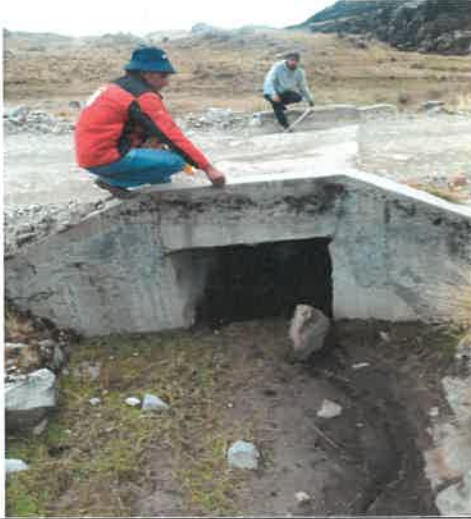
Foto 31: 18+700 Vista de Ingreso de alcantarilla.
