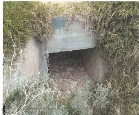
Foto 3 KM 1+480 Vista de salida de alcantarilla obstruida por forestación nativa y deteriorada.
