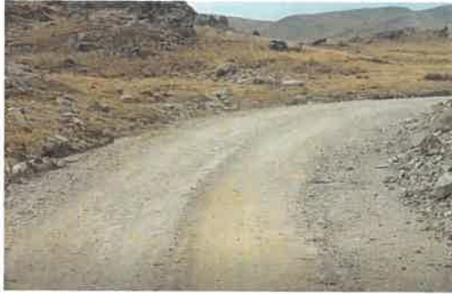
Foto 321: KM 20+050, Erosión en ambos lados de la calzada
