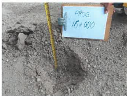
Foto 65: KM 16+000 Midiendo el espesor de afirmado existente (0.11 m.)
