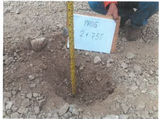
Foto 12: KM 2+750, Midiendo el espesor de afirmado existente (0.18 m.)
