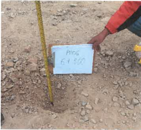
Foto 27: KM 6+500, Midiendo el espesor de afirmado existente (0.10 m.)
