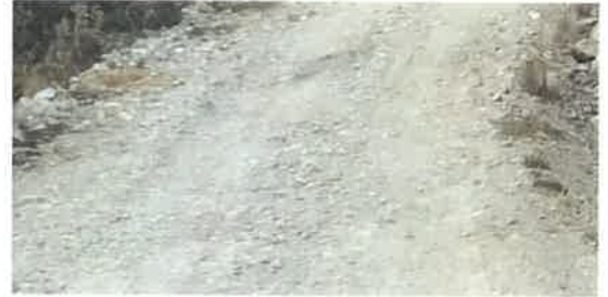
Foto 226: KM 14+100, Ahuellamiento en ambos lados de la calzada
