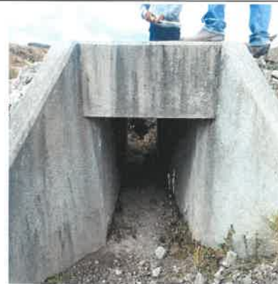
Foto 26: KM 15+020 Vista de salida de alcantarilla.
