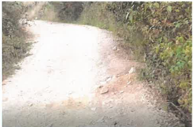
Foto 144: KM 8+950, Cruce de agua
