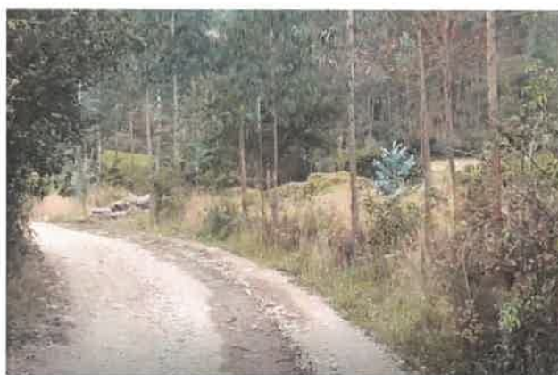
Foto 132: KM 8+200, Ahuellamiento en ambos lados de la calzada y Erosión
