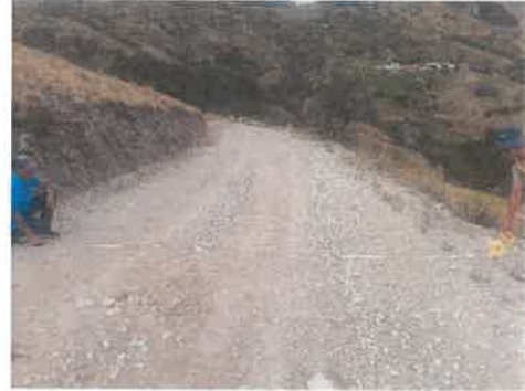
Foto 048: KM 11+500, Vista toma de información en campo, detallando el ancho de plataforma.
