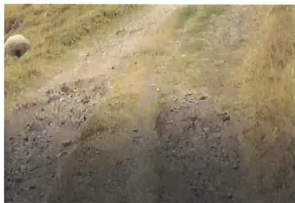
Foto 07: KM 0+400, Bacheo en ambos lados de la calzada
